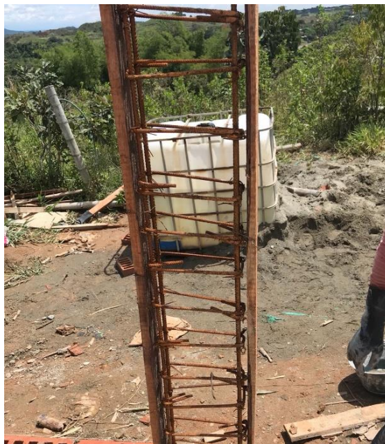
Figura 6: Refuerzo de elementos verticales
