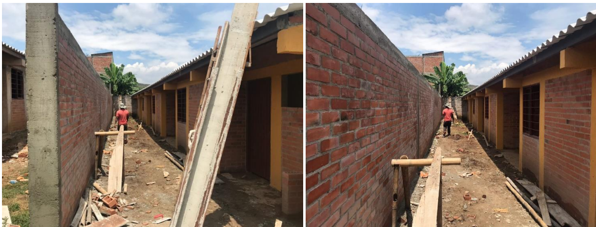
Figura 55 y 56: Muro divisorio construido en su totalidad
