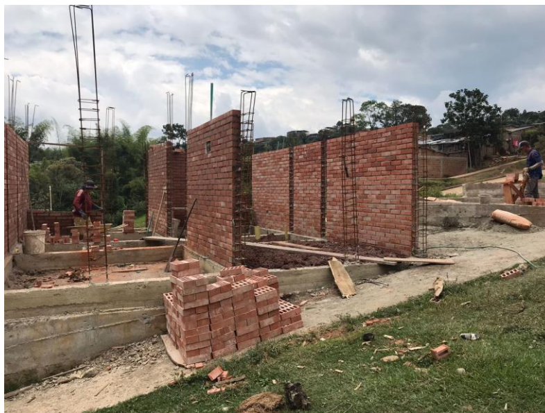
Figura 33: Avance en la construcción de muros
