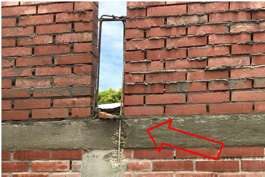
Figura 18: Refuerzos expuestos
