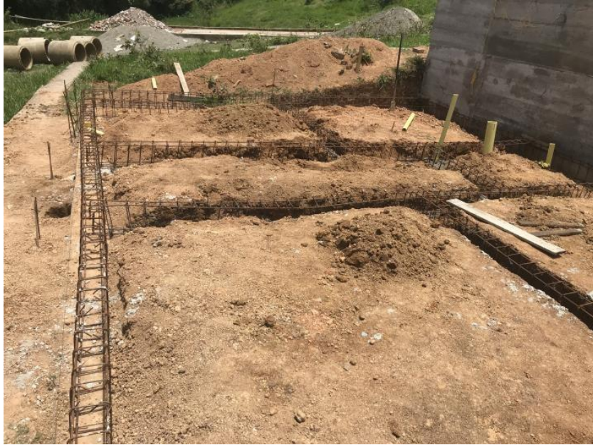
Figura 4: Excavación viga de cimentación
