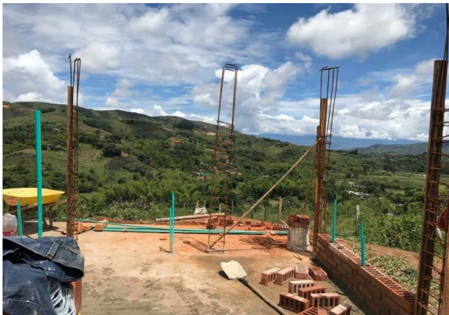
Figura 75: Correcta elaboración de los castillos de acero
