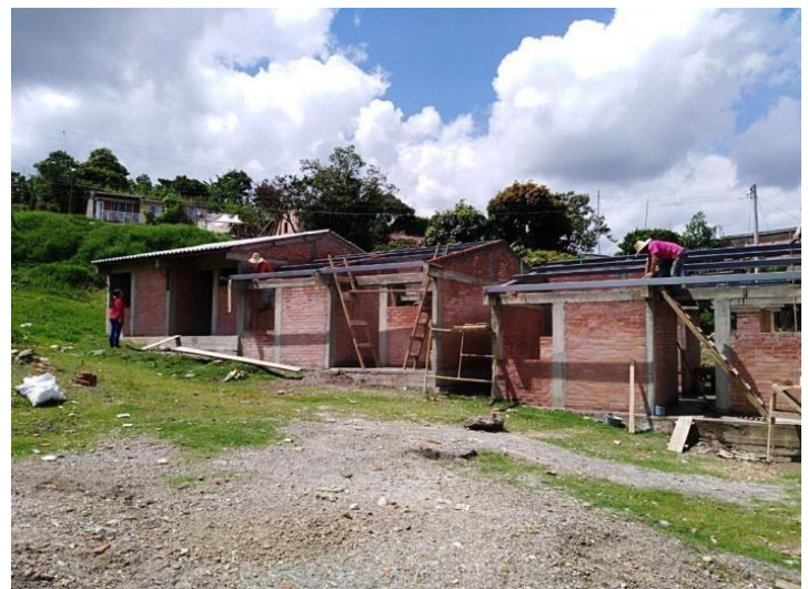
Figura 69 y 70: Instalación de correas metálicas
