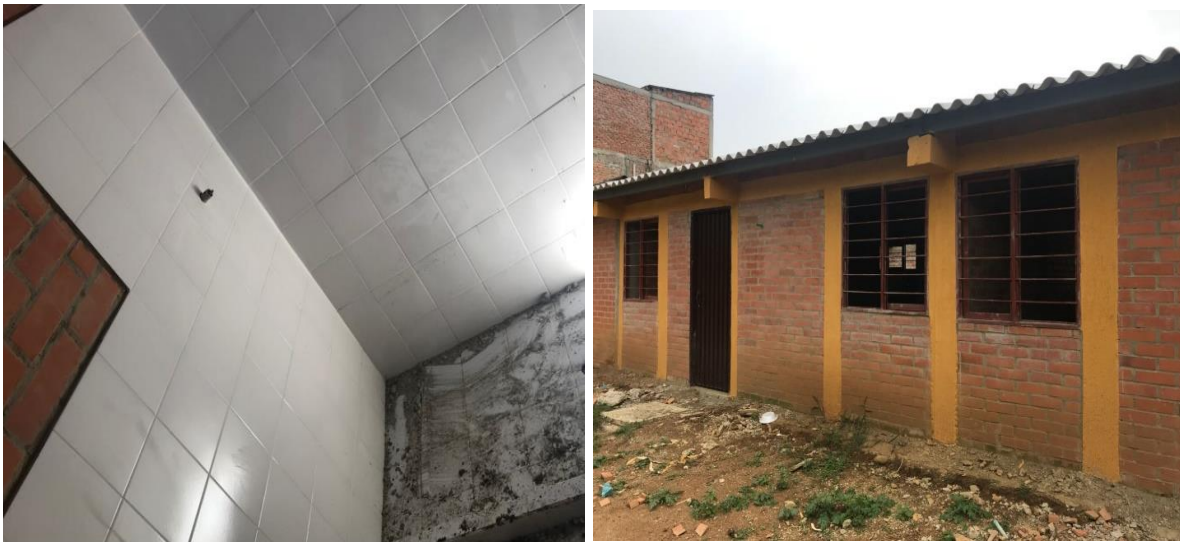
Figura 49: Enchape de baños Figura 50: Vivienda terminada fachada exterior
