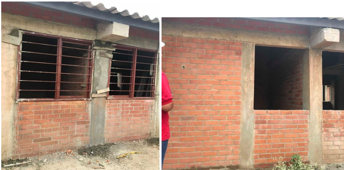
Figura 45 y 46: Reparaciones en la fachada exterior
