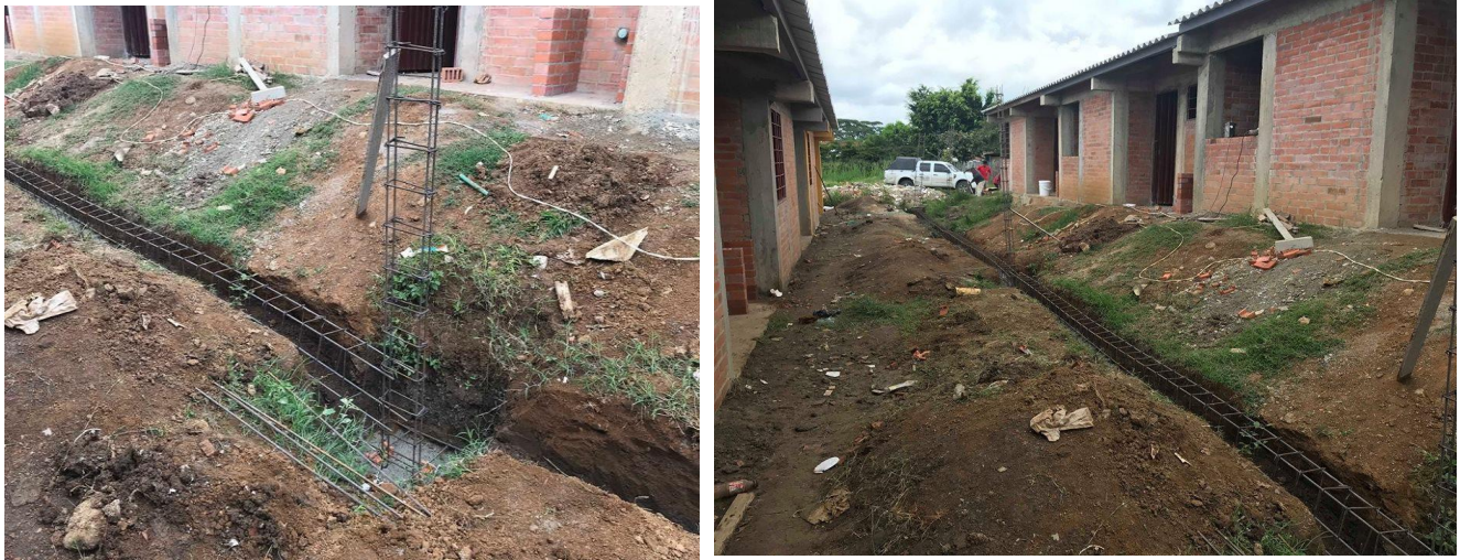
Figura 53y 54: Armado y colocación de castillos de acero
