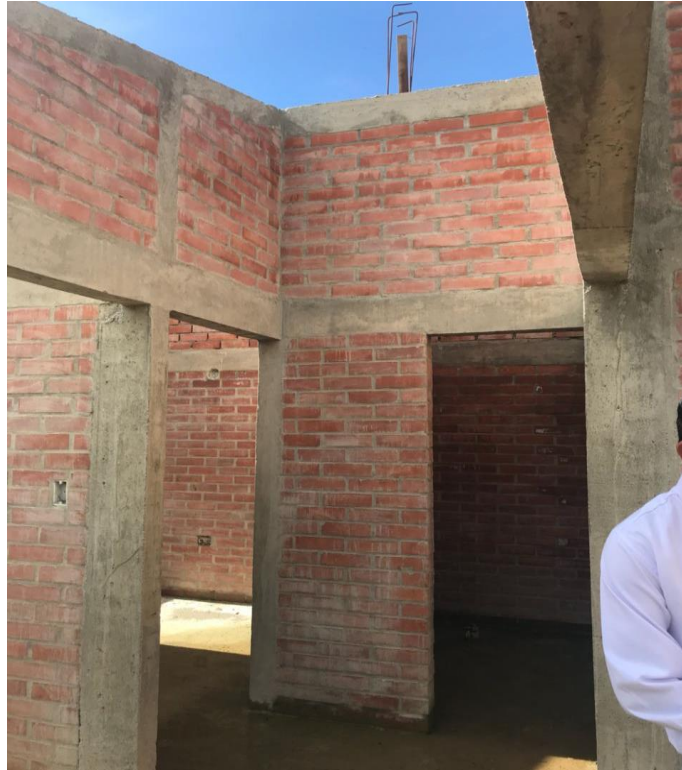
Figura 21: corrección aceros expuestos
