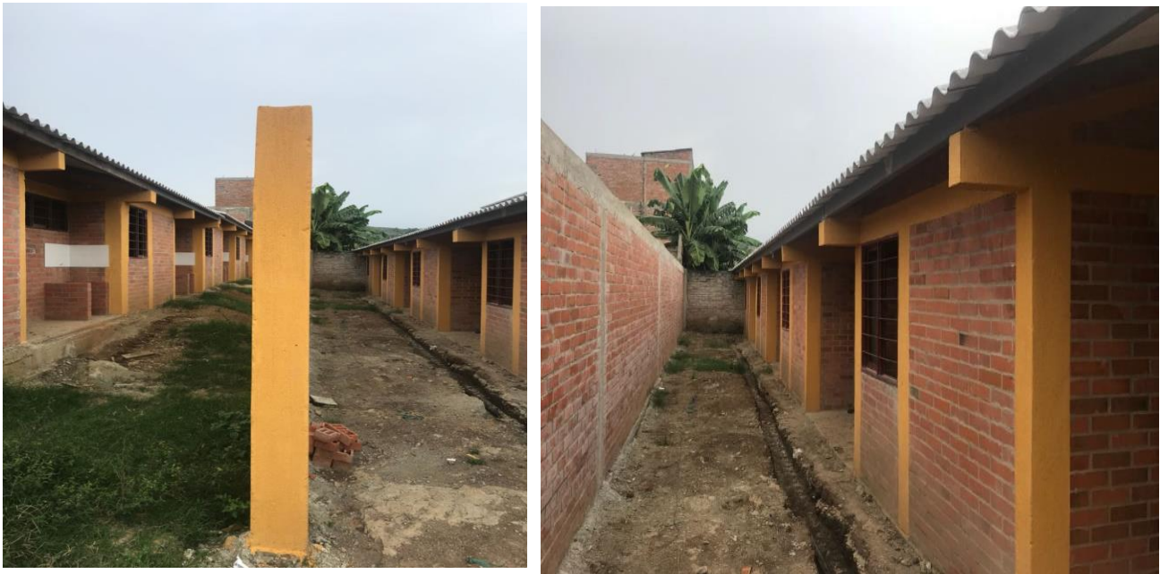
Figura 57y 58: Aplicación de graniplas a viviendas faltantes
