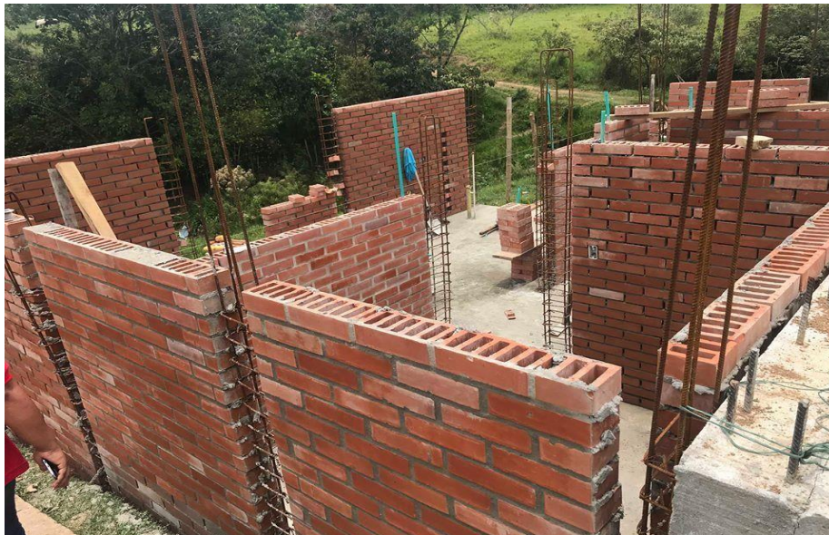
Figura 7: No hay rotación en los ganchos de acero de refuerzo trasversal
