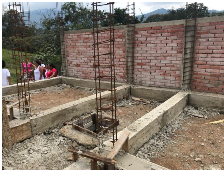
Figura 26: Cimentación de la vivienda
