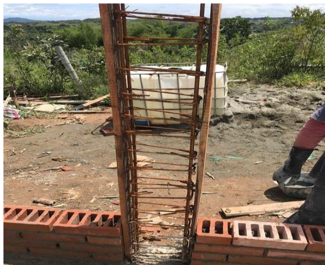
Figura 73: Correcta intervención en el acomodo de castillos de acero en columnas
