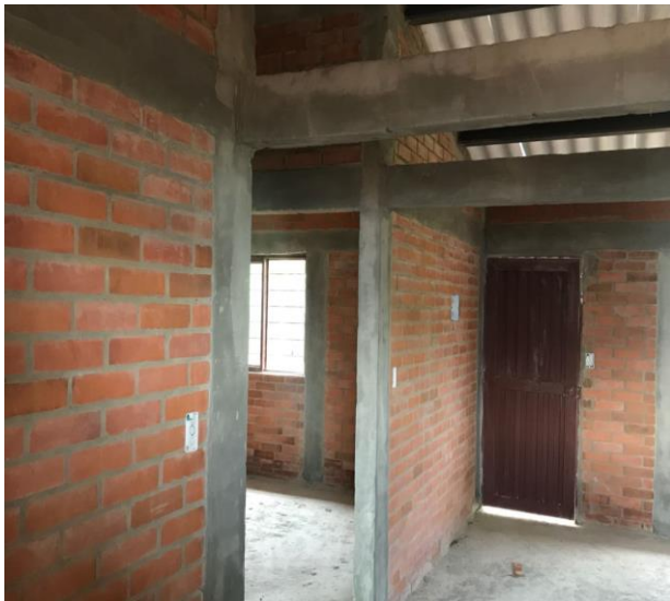
Figura 62: Fachada interior corregida
