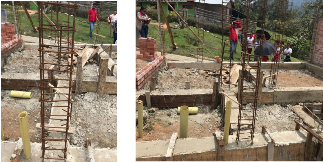
Figura 27 y 28: Correcta intervención en el acomodo de castillos de acero en columnas
