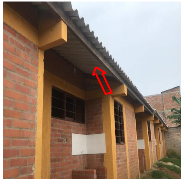
Figura 60 y 61: Perlins exteriores sin anticorrosivo
