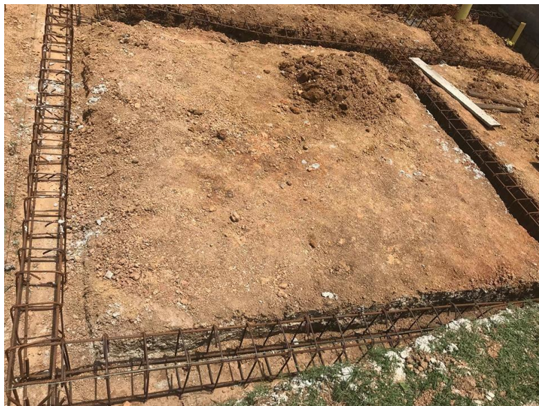
Figura 5: Refuerzo de vigas de cimentación
