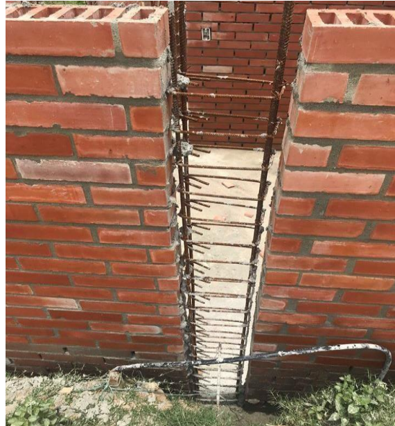
Figura 7: No hay rotación en los ganchos de acero de refuerzo trasversal
