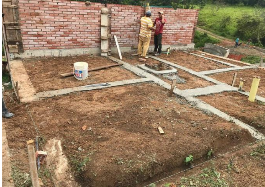
Figura 23: Cimientos en concreto ciclópeo
