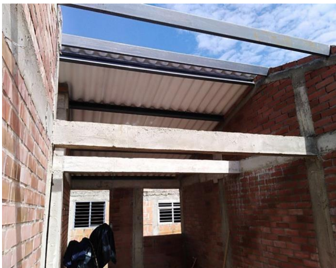
Figura 69 y 70: Instalación de correas metálicas
