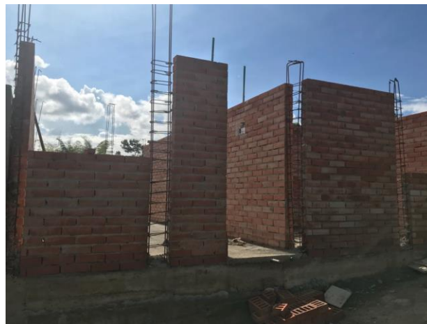
Figura 34 35 y 36: Losa de cimentación fundida y avance progresivo en la colocación de mampostería
