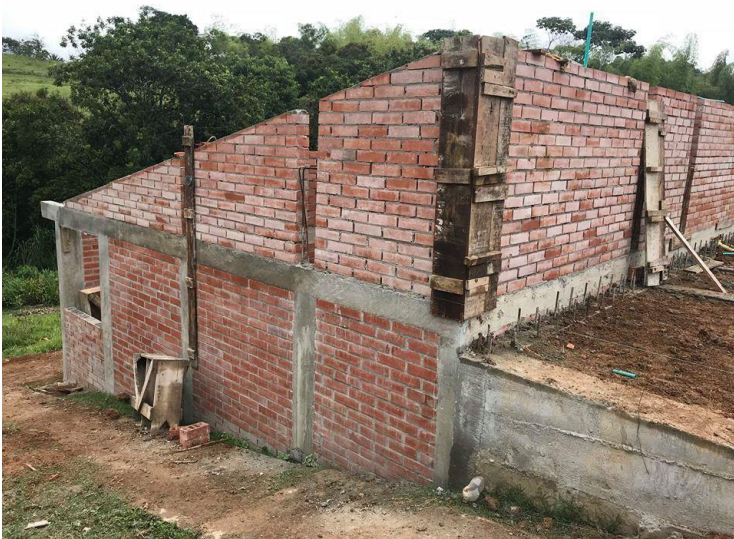
Figura 16 y 17: Encofrado de columnas
