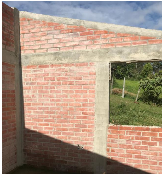
Figura 20: Corrección acabados viga de amarre
