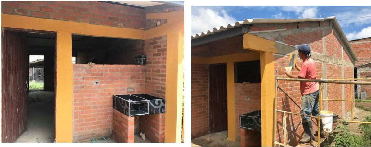
Figura 47 y 48: Fachadas exteriores terminadas - Aplicación de Graniplas
