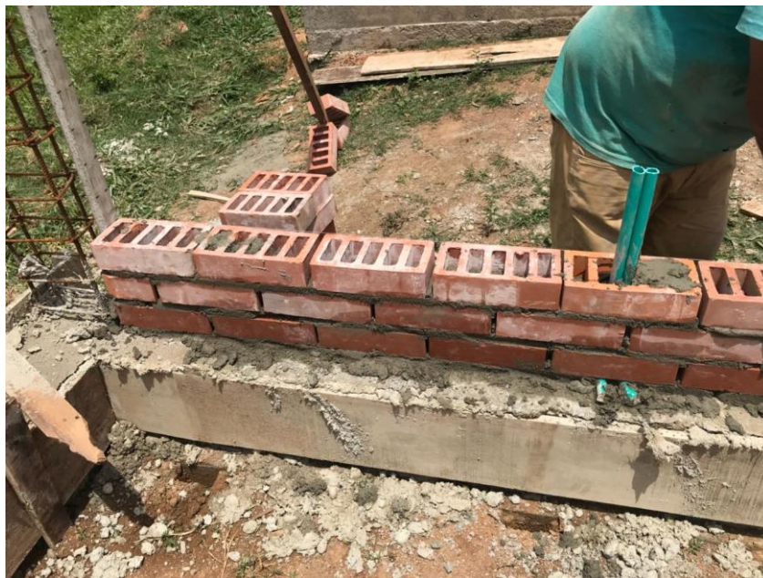
Figura 30: Colocación de mampostería
