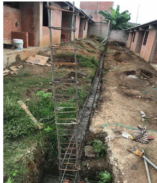
Figura 51 y 52: Cimiento en concreto ciclópeo
