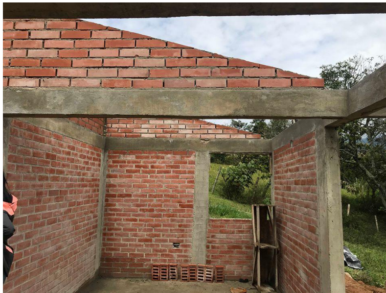
Figura 14: Avance en la fundición de columnas y vigas de amarre
