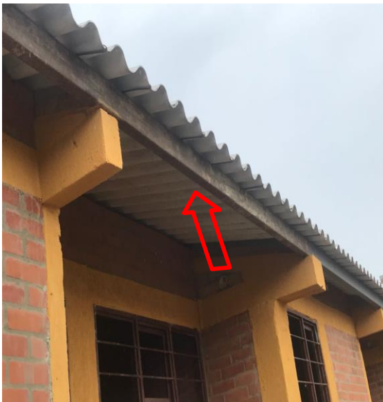
Figura 60 y 61: Perlins exteriores sin anticorrosivo
