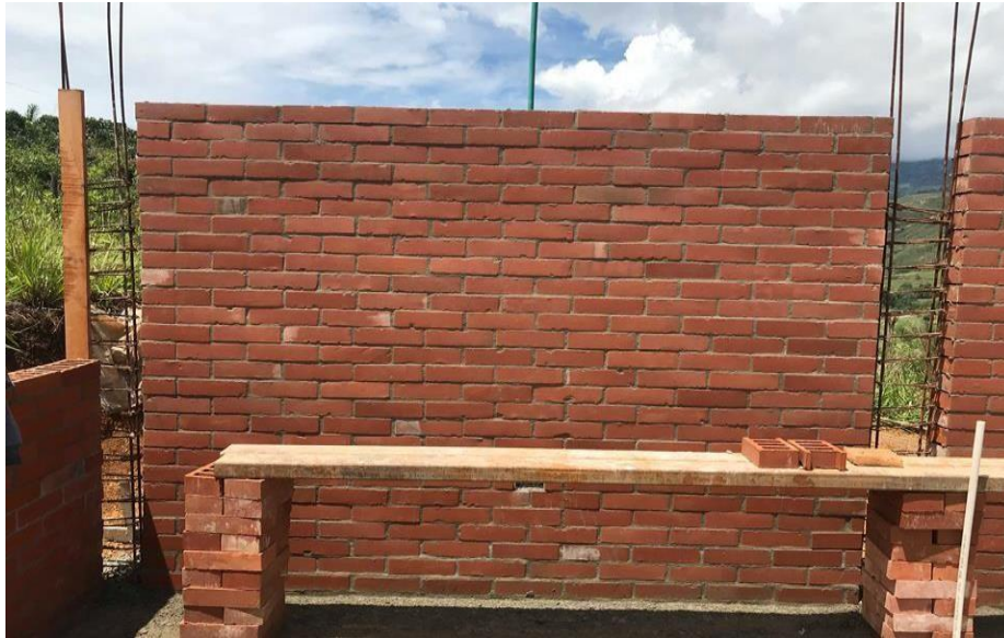
Figura 74: Colocación de mampostería bien aplomada
