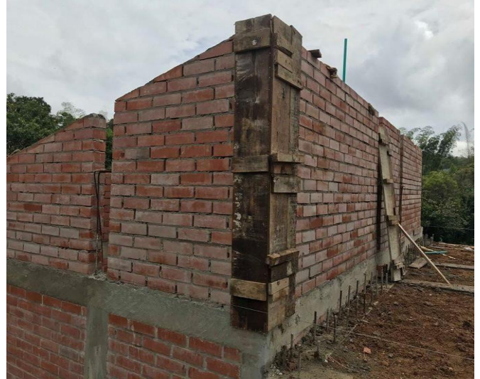
Figura 16 y 17: Encofrado de columnas
