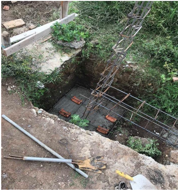
Figura 51 y 52: Cimiento en concreto ciclópeo
