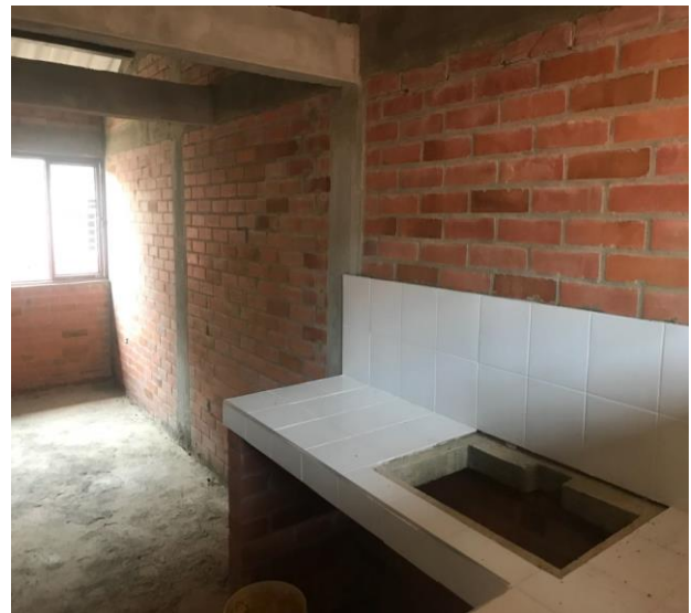
Figura 63: Instalación mesón de cocina
