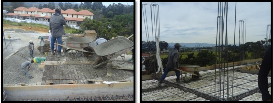
Figura 40. Estructura para subir el concreto a la planta dos.
