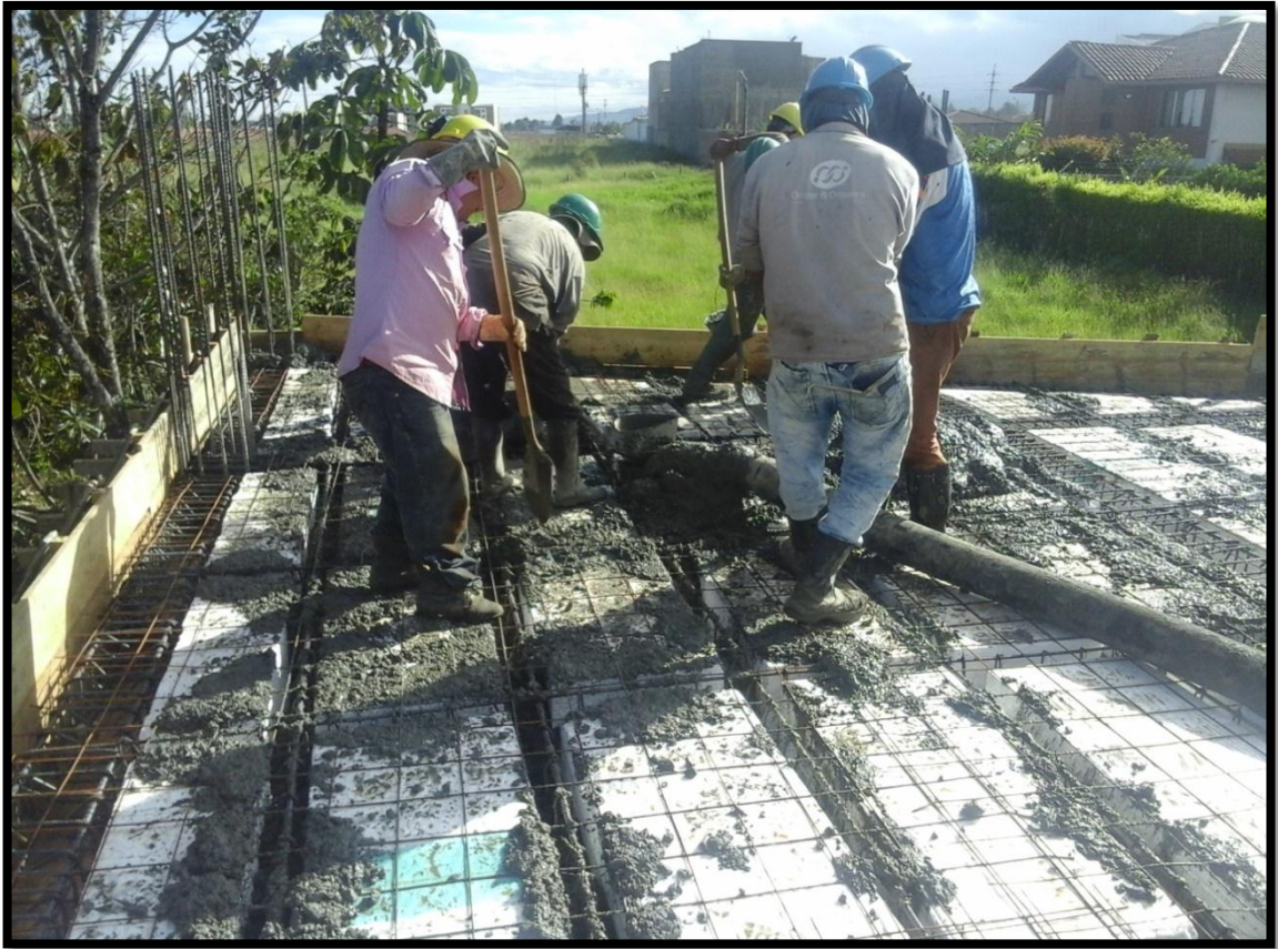
Figura 16. Colocación del concreto premezclado
