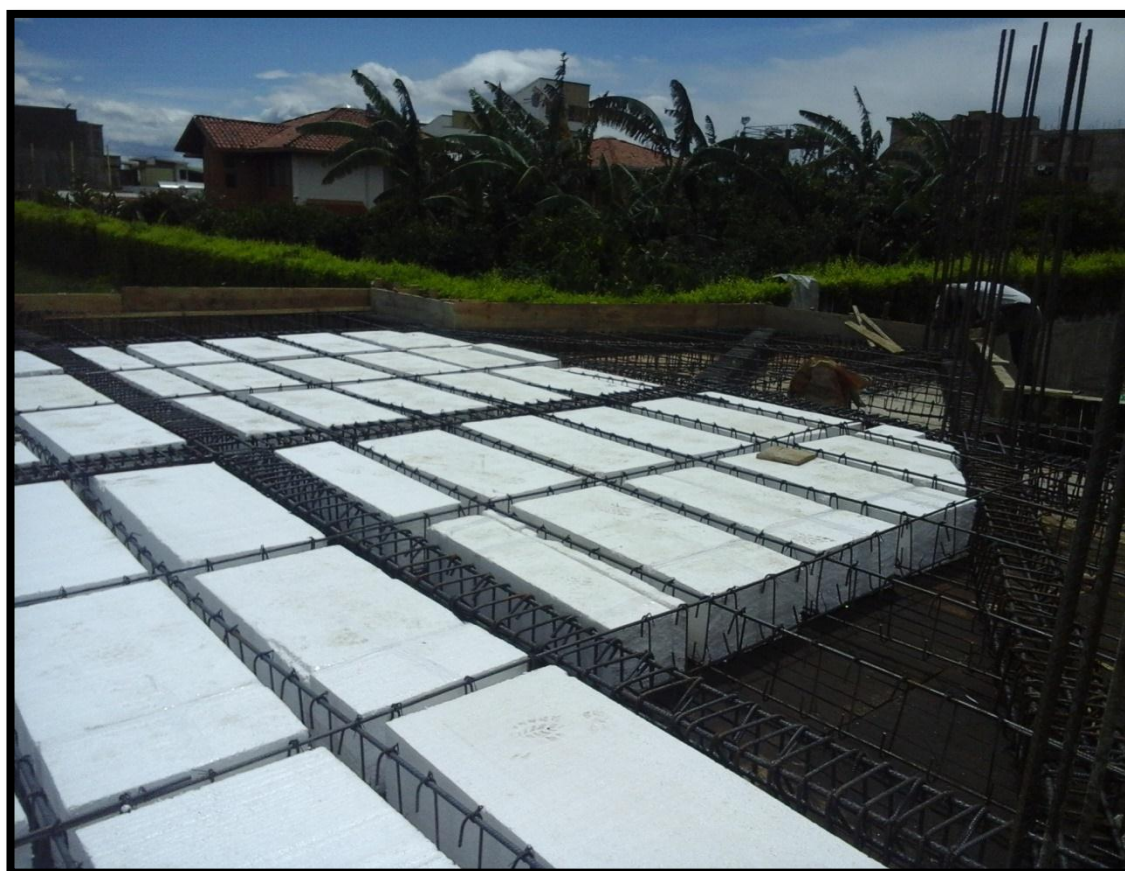
Figura 12. Colocación de los casetones
