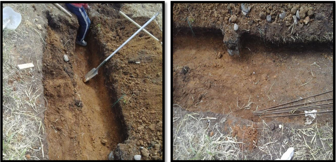
Figura 114. Excavación muro de contención.
