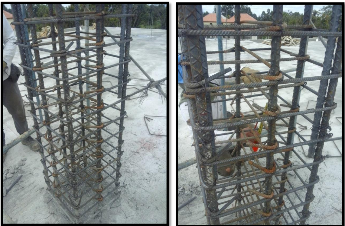
Figura 23. Acero de las columnas y estribos
