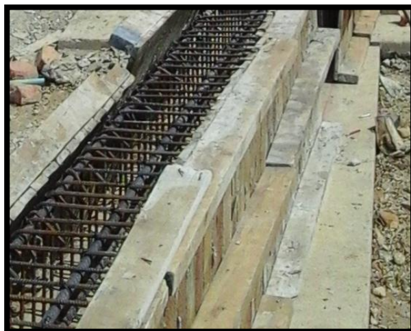
Figura 96. Tacos de madera para asegurar tableros
