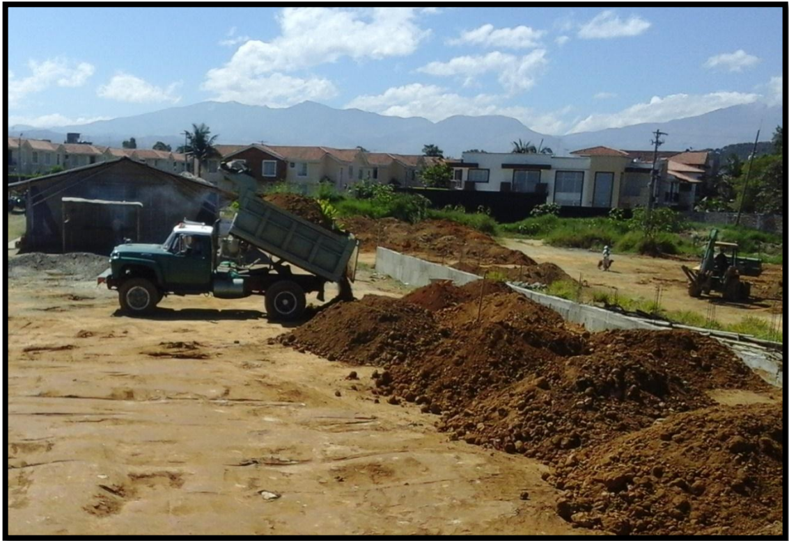
Figura 32. Descargue de material de relleno
