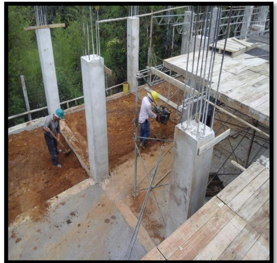
Figura 9. Colocación de tacos metálicos, vigas metálicas, riostras y tableros.
