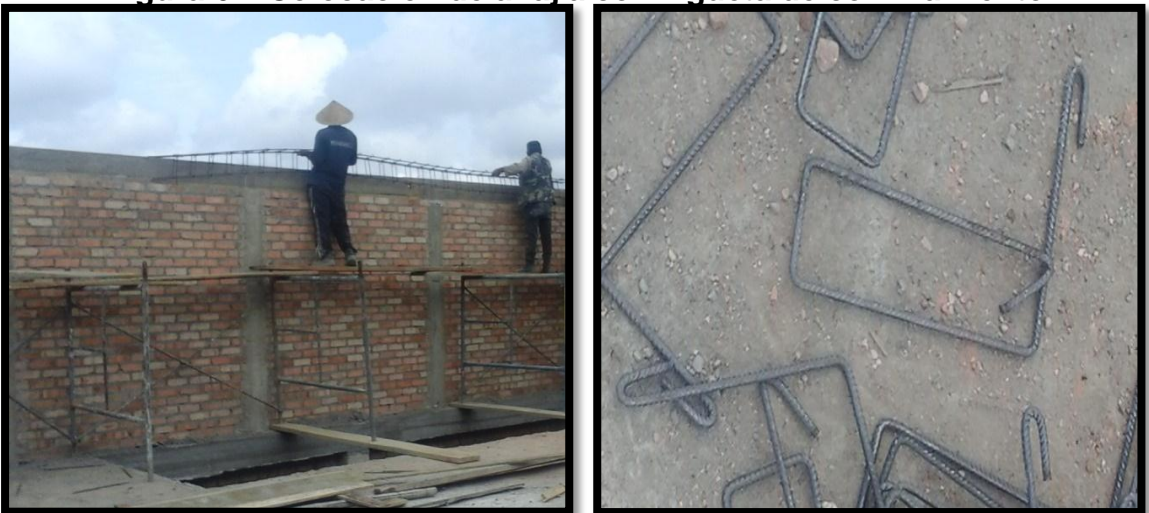
Figura 61. Colocación de alfajía con vigueta de confinamiento
