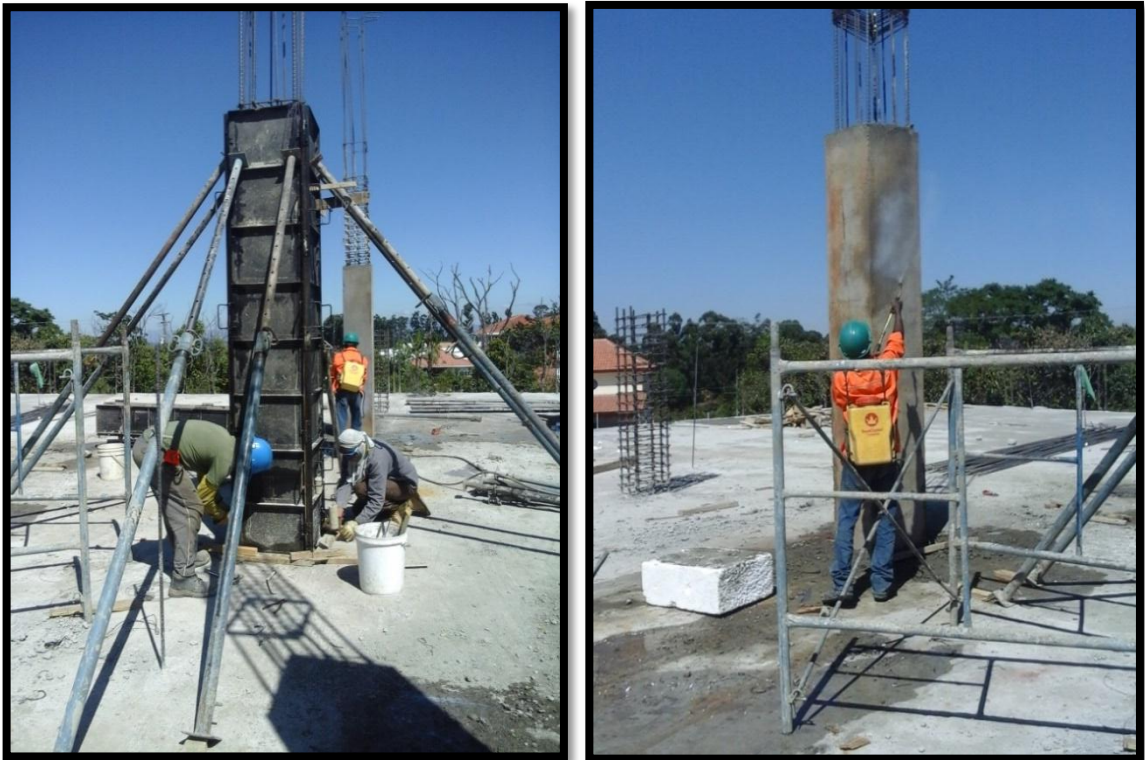
Figura 25. Nivelación de columna y del curado de la columna
