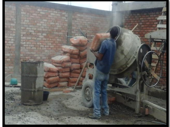
Figura 54. Mezclado de concreto.
