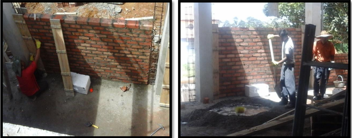
Figura 60. Colocación de columnetas
