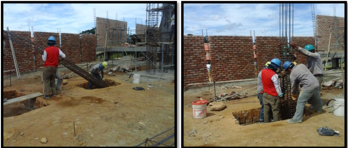
Figura 80. Colocación de la estructura principal.
