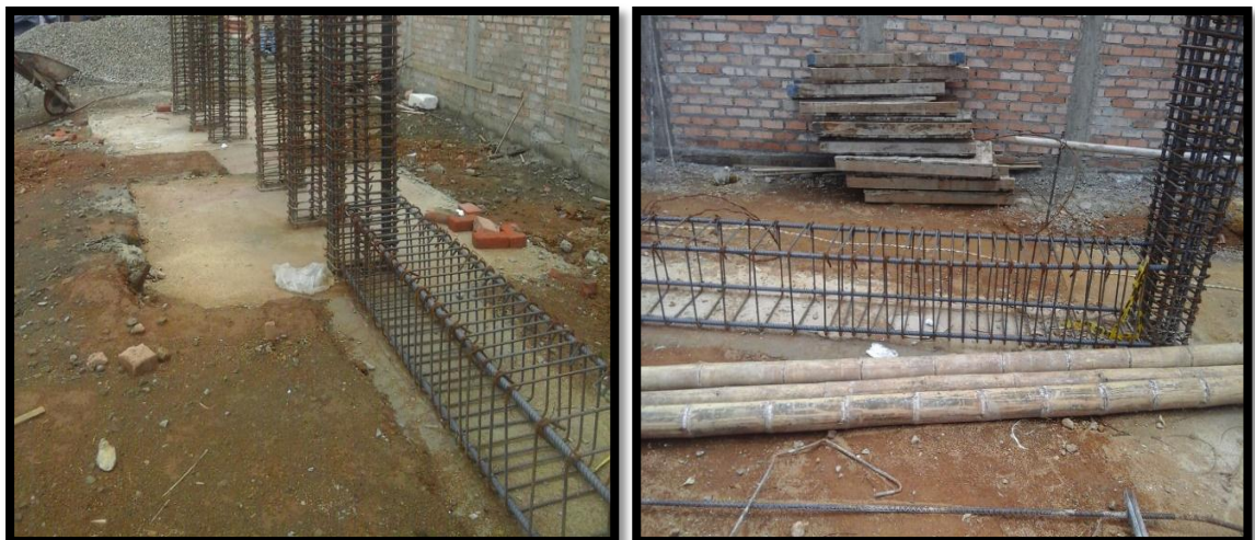
Figura 92. Armadura de viga cimentadora.
