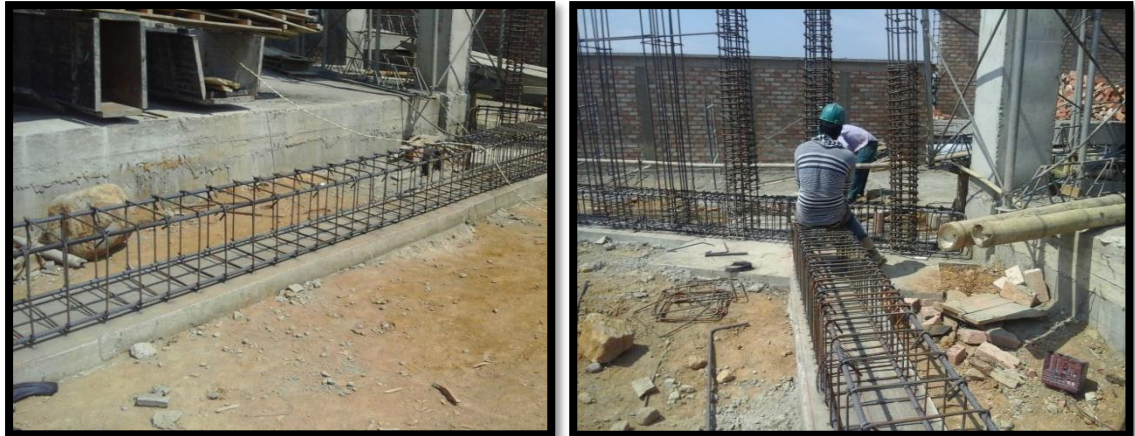
Figura 93. Armadura de viga cimentadora.
