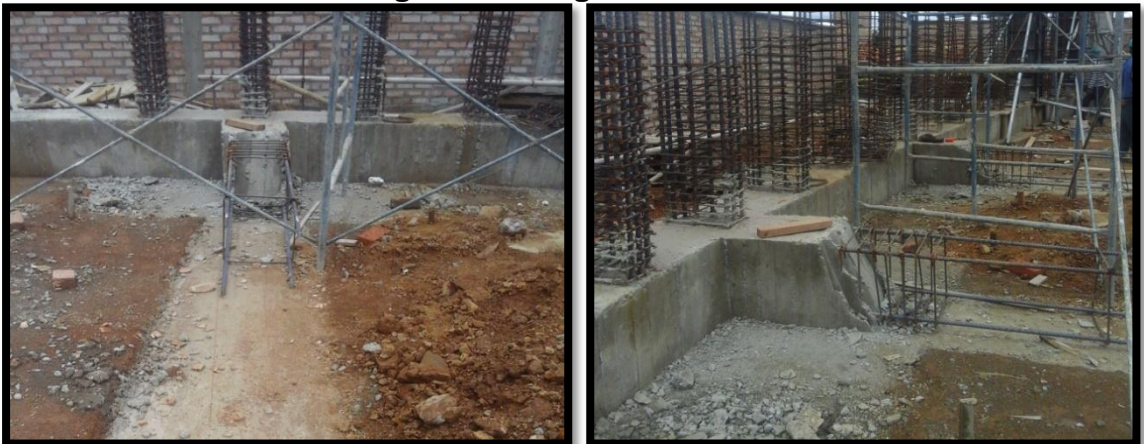
Figura 104. Vigas fundidas.
