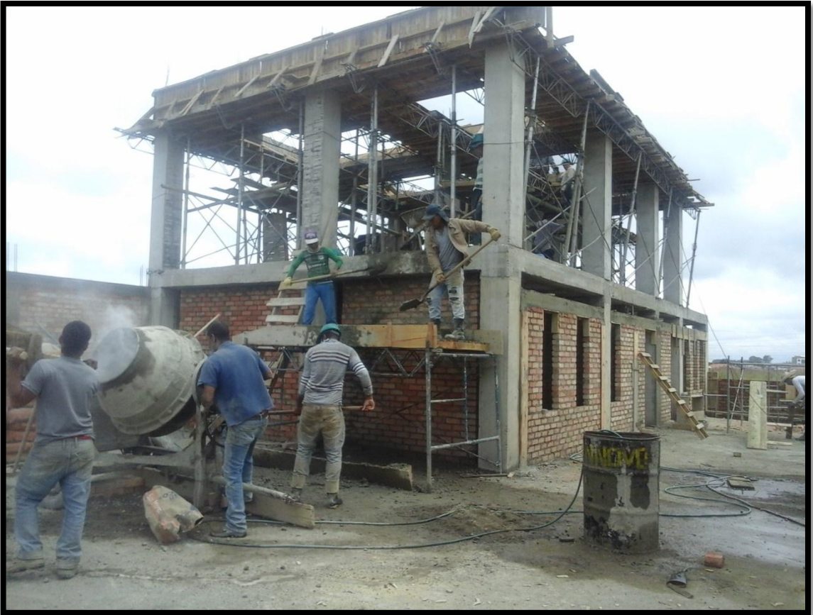
Figura 55. Fundición de viga
