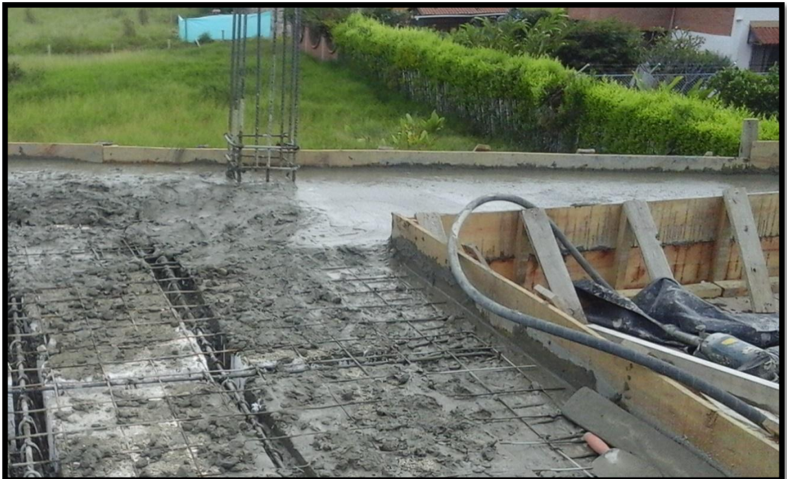
Figura 42. Llenado de concreto luego de tener asegurados los casetones con mezcla
