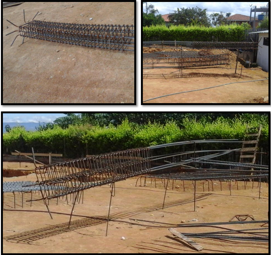
Figura 77. Armado de estructura de columna
