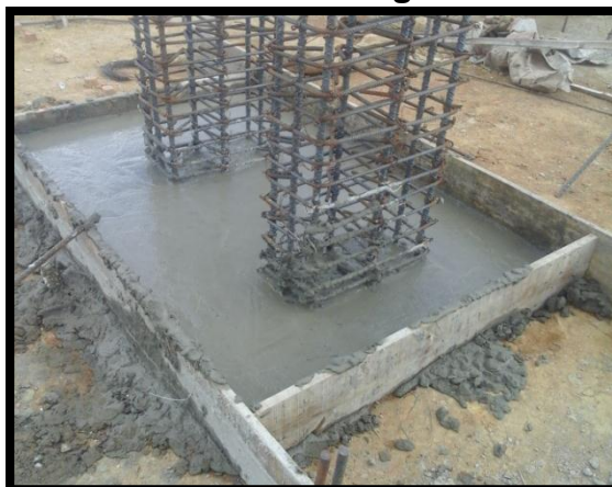
Figura 86. Fundición de zapatas
