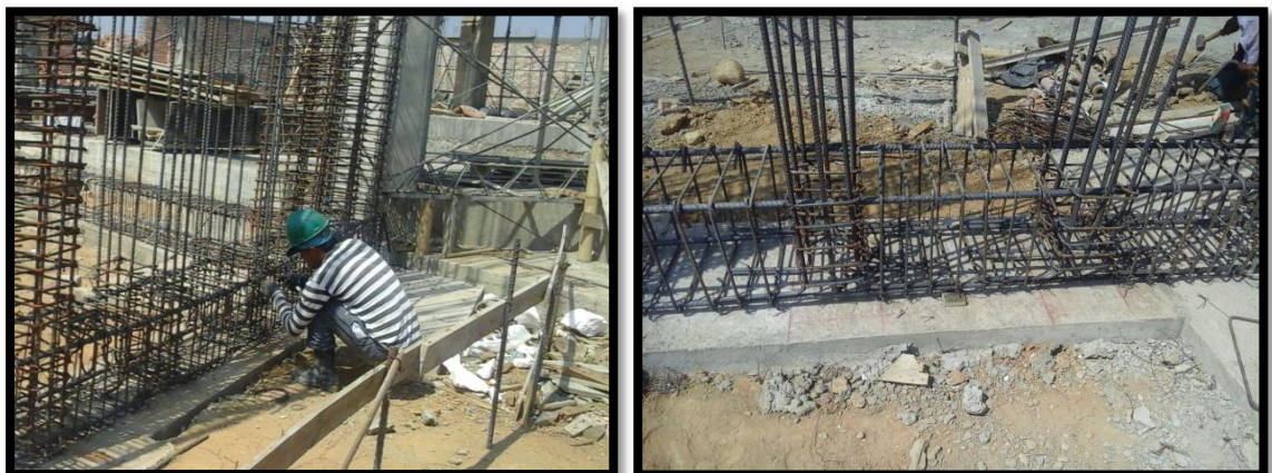
Figura 95. Armadura de columnas sobre solado de limpieza
