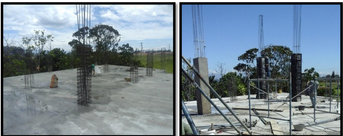
Figura 26. Columnas de la casa cural
