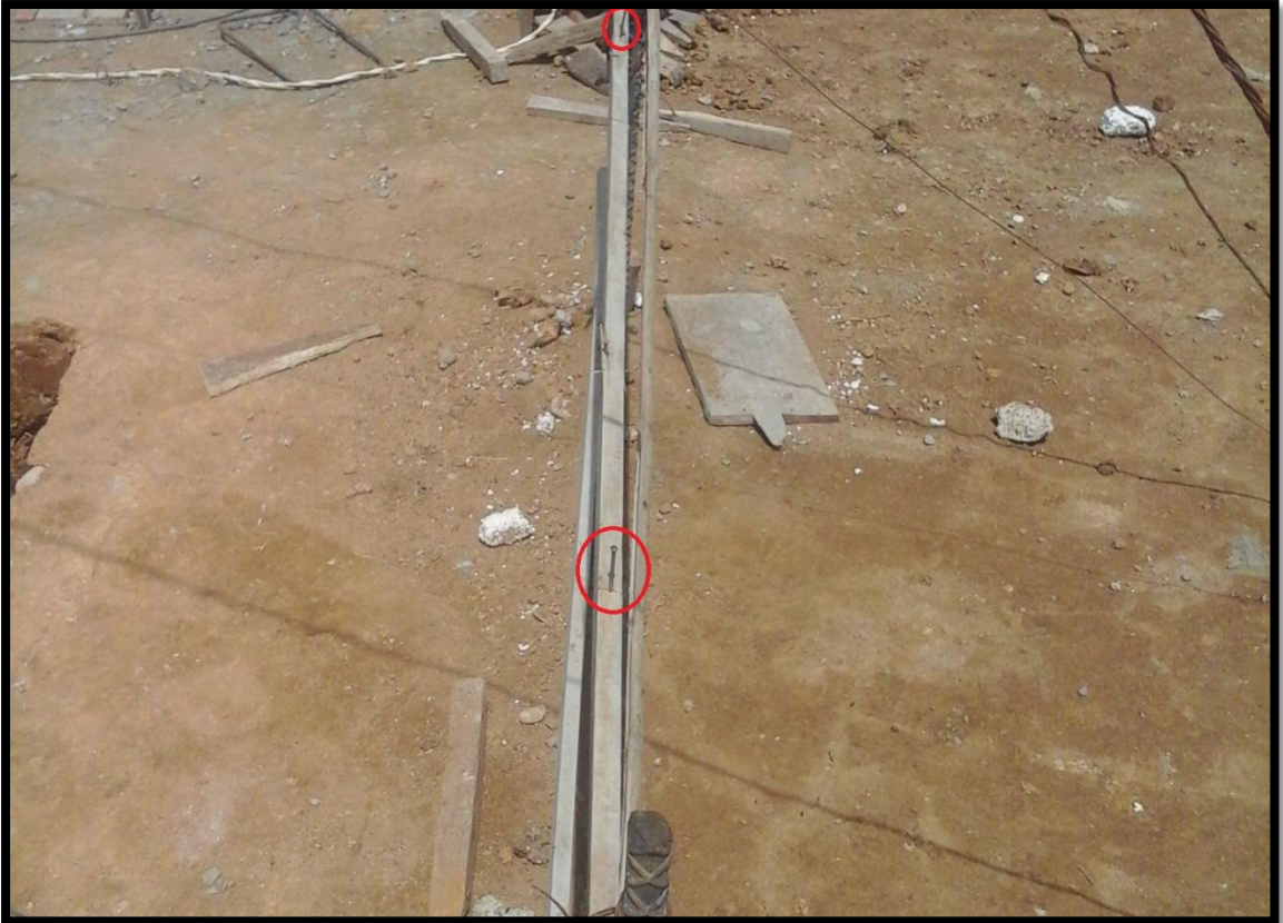
Figura 73. Estructura de apoyo
