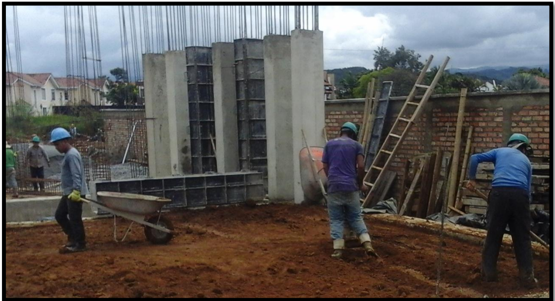
Figura 112. Compactación de suelo interior de iglesia.
