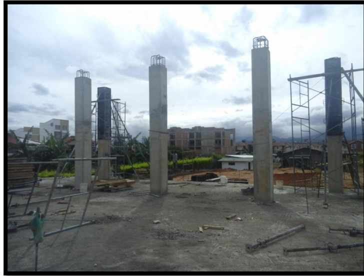
Figura 48. Columnas completas.
