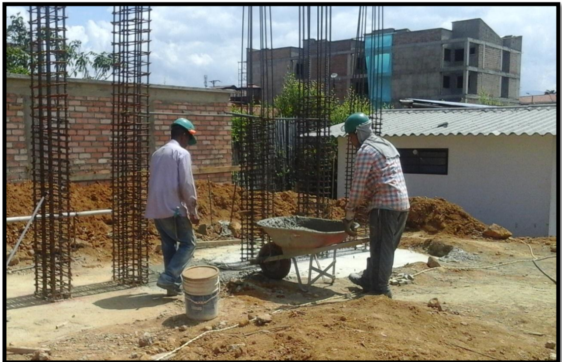
Figura 89. Colocación de solado en medio de las zapatas
