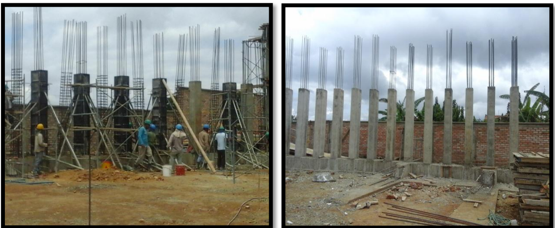
Figura 109. Construcción de columnas
