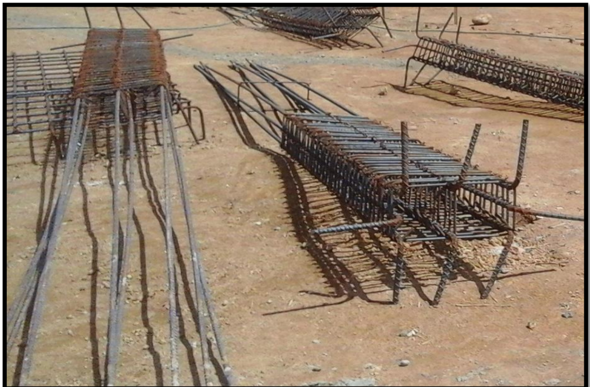
Figura 76. Armadura de refuerzo de columnas
