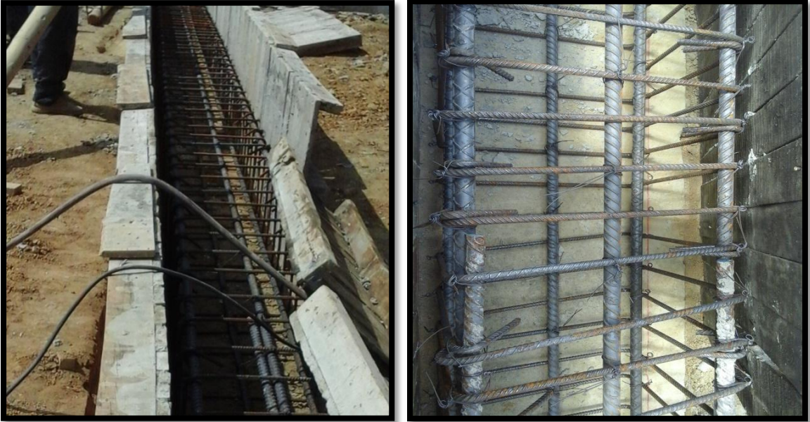
Figura 97. Tableros en viga cimentadora.
