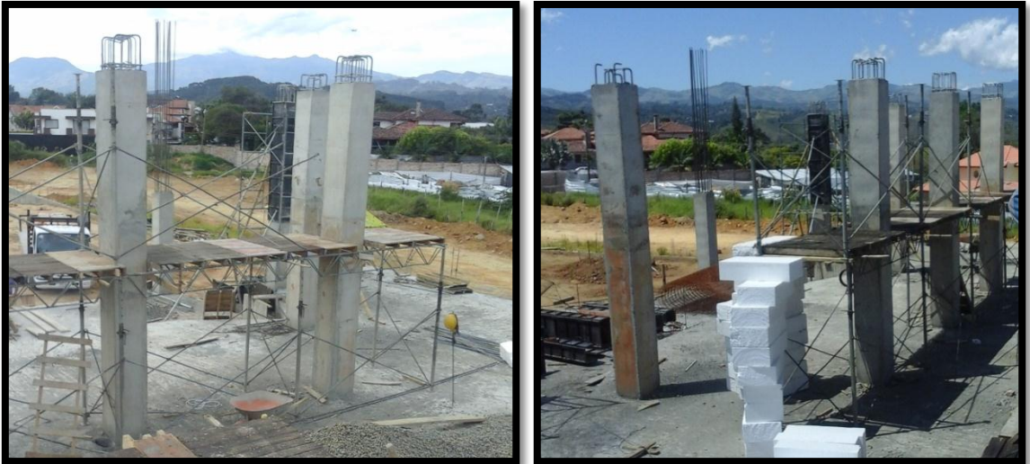
Figura 49. Primeros tableros montados
