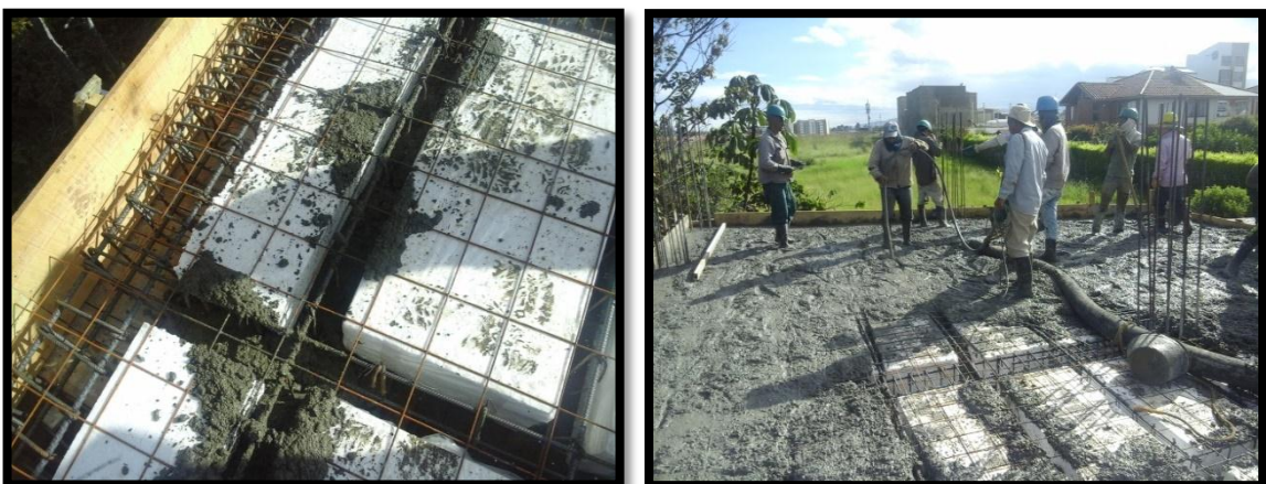
Figura 22. Distribución del concreto y llenado parcial
