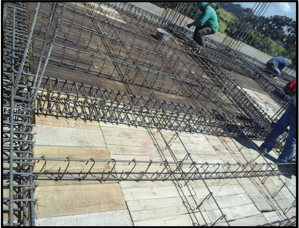
Figura 36. Armadura de la losa completa
