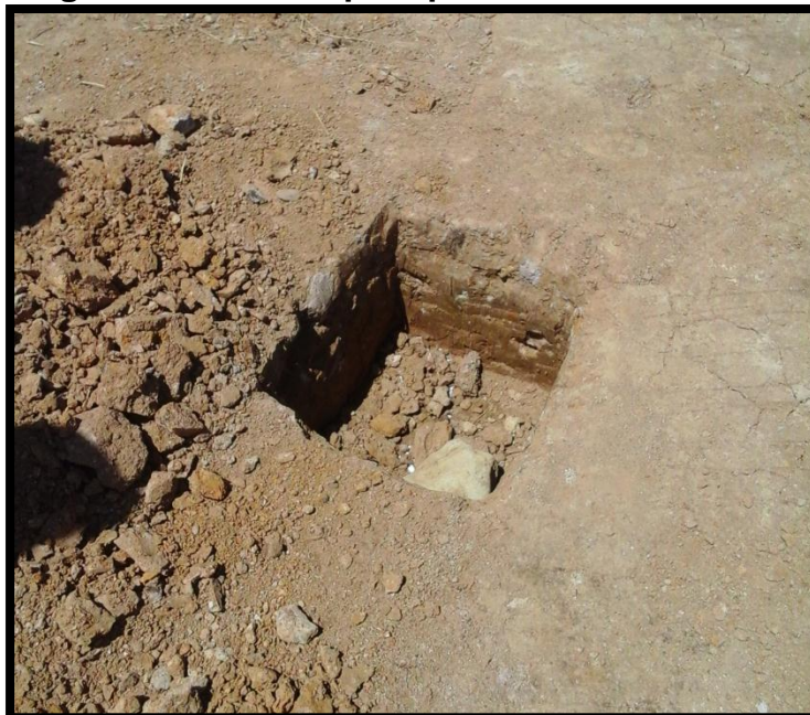
Figura 66. Sondeo para pruebas de resistencia
