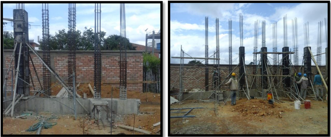
Figura 108. Construcción de columnas
