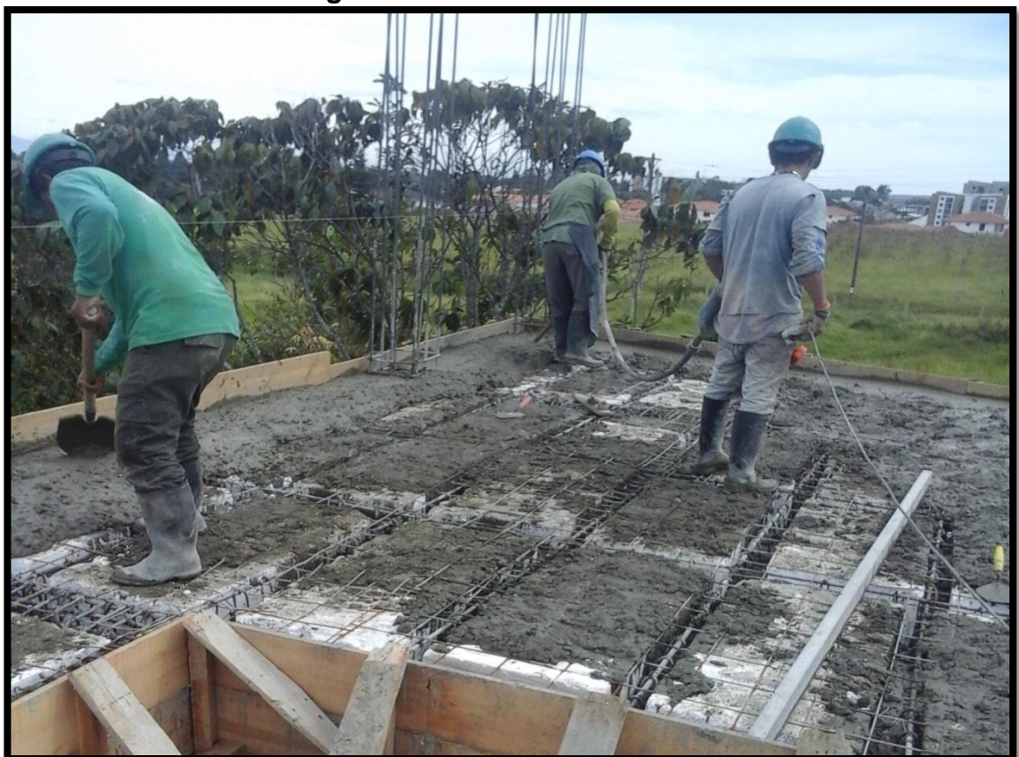
Figura 44. Vibrado de concreto
