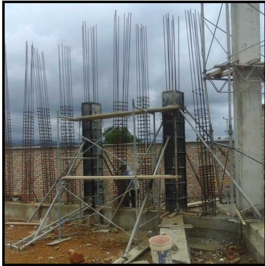
Figura 107. Formaletas de columnas.
