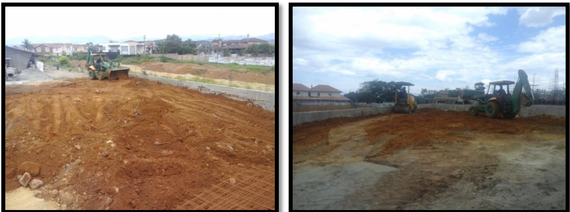
Figura 30. Área de relleno, distribución y compactación de material primera capa
