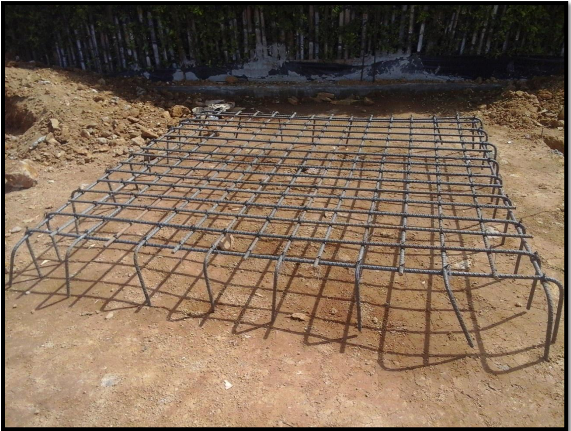
Figura 70. Armadura de la zapata
