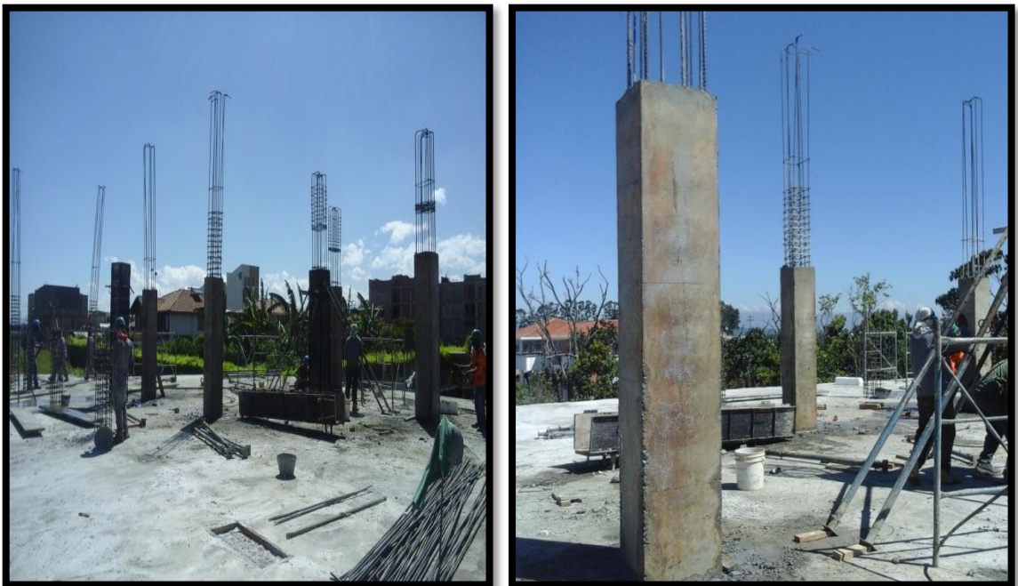
Figura 27. Columnas primera fase
