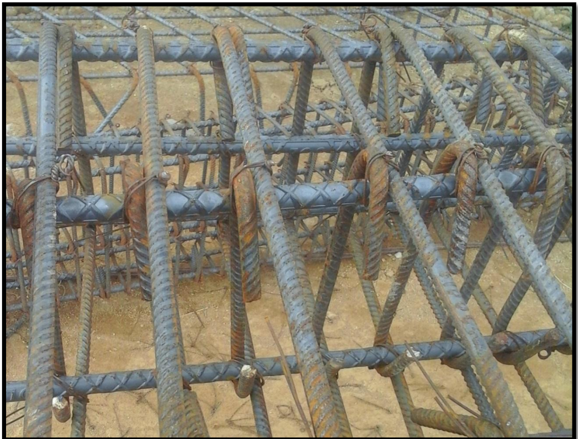
Figura 78. Separaciones de los estribos en la columna
