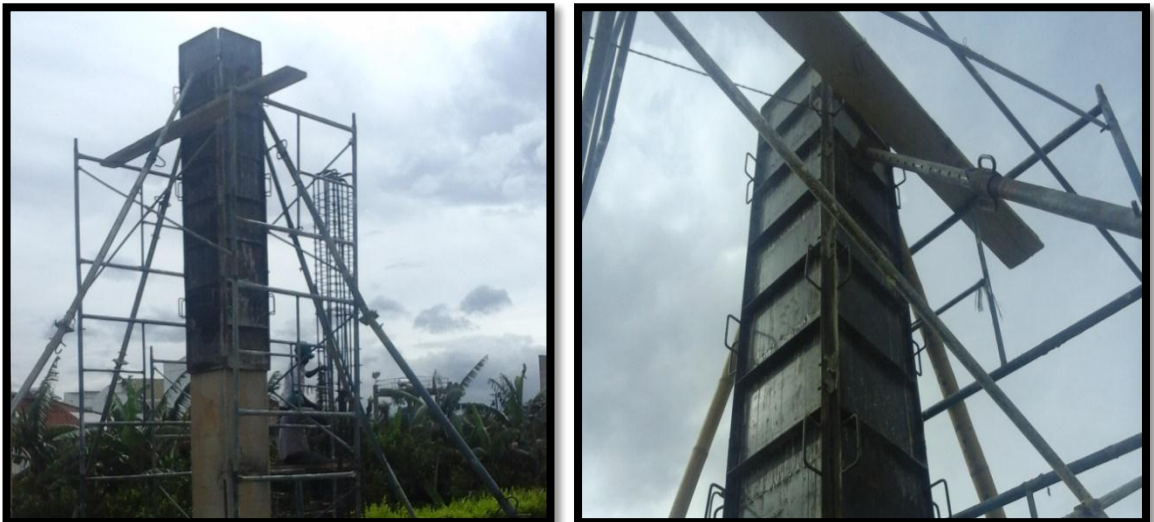
Figura 47. Colocación de la formaleta
