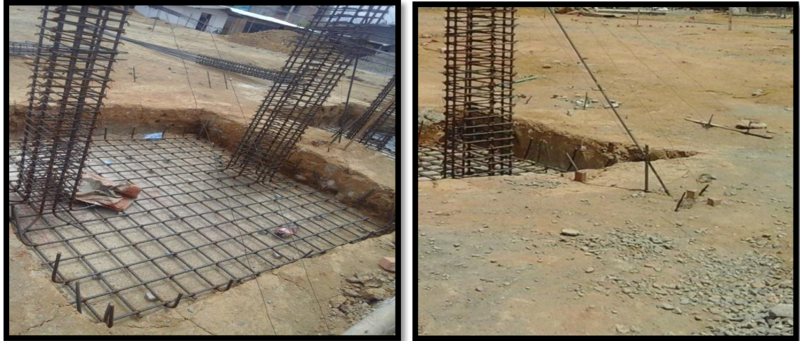
Figura 83. Alambres tensores para el aplomo de las columnas
