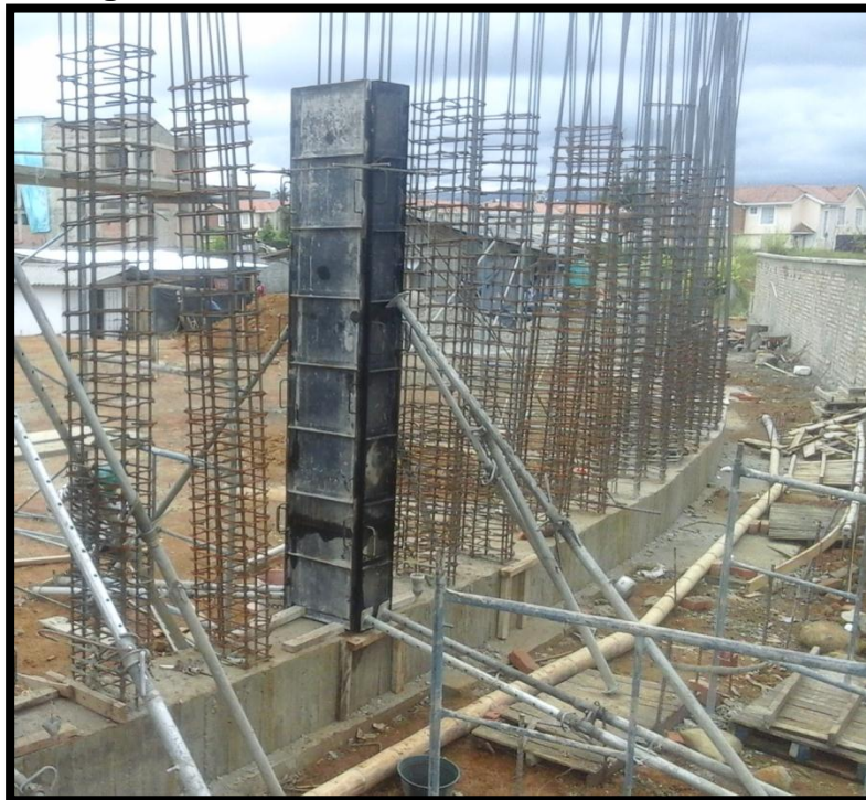
Figura 106. Formaleta metálica de columnas
