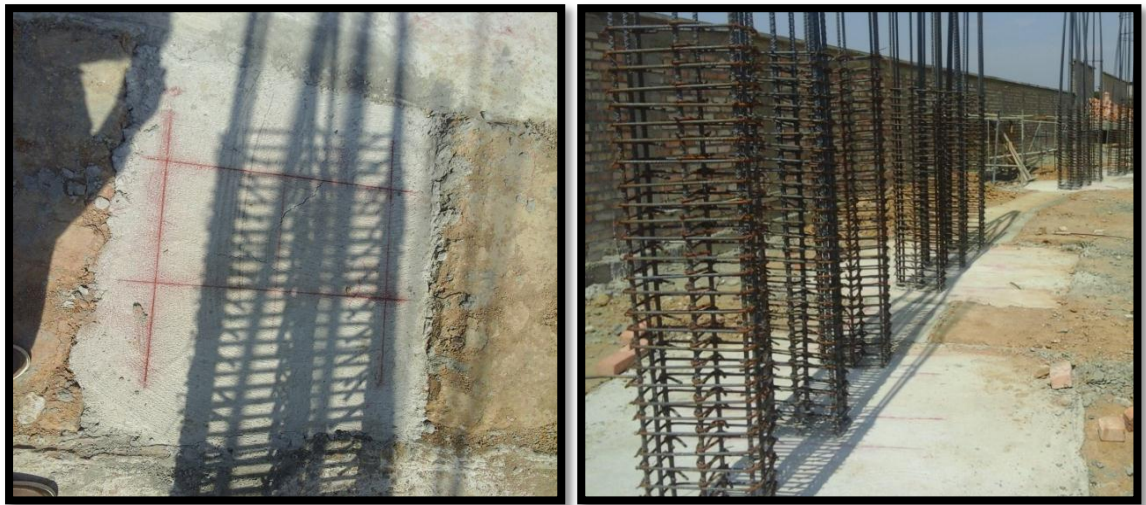
Figura 91. Marcación de columnas.
