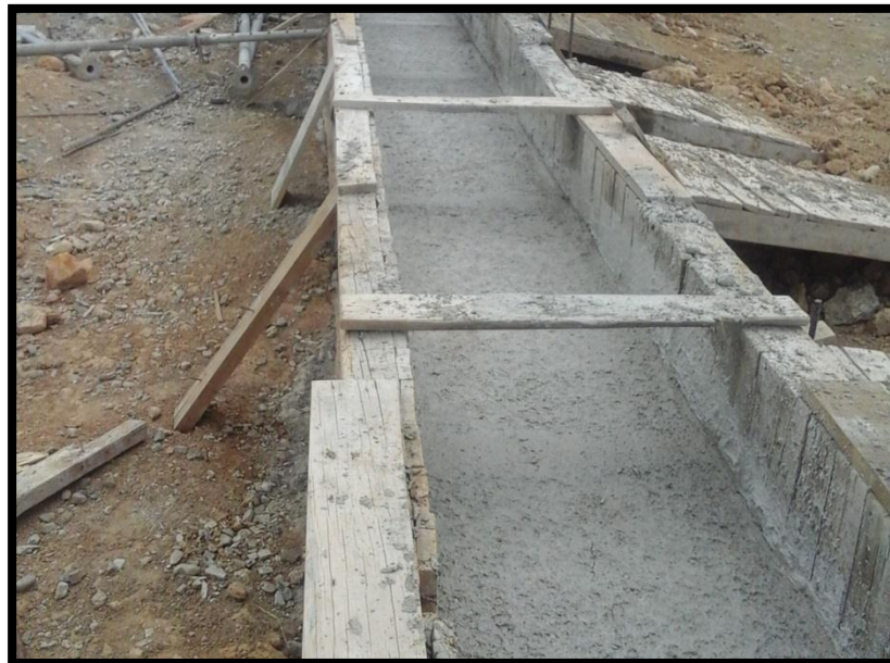
Figura 100. Viga cimentadora.
