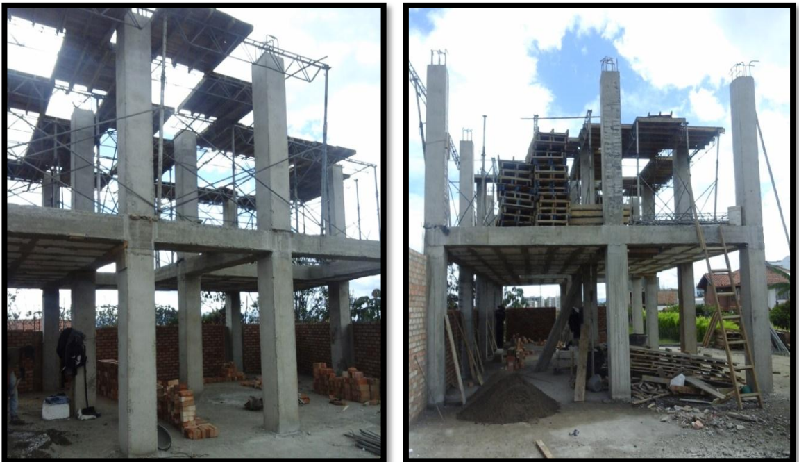
Figura 52. Tableros para viga elevada casa cural
