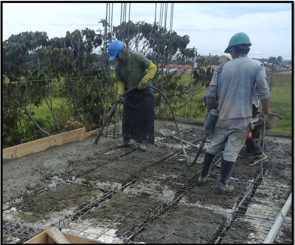
Figura 43. Vibrado del concreto
