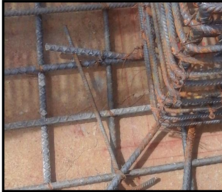
Figura 82. Barra aseguradora
