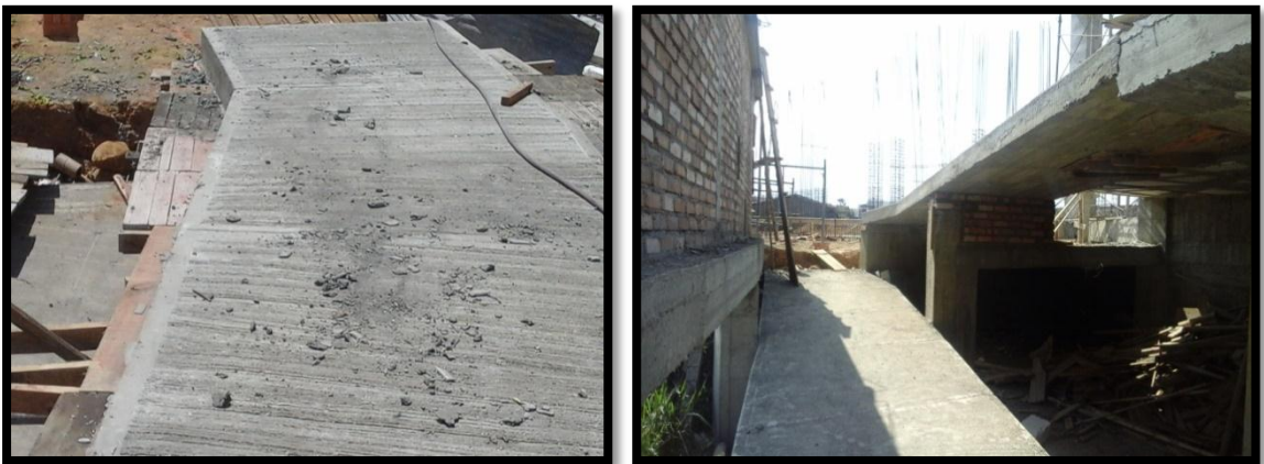
Figura 120. Rampa lateral derecho
