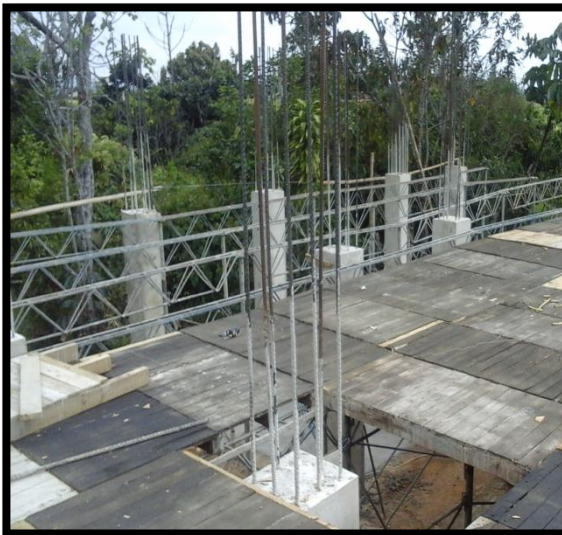
Figura 9. Colocación de tacos metálicos, vigas metálicas, riostras y tableros.
