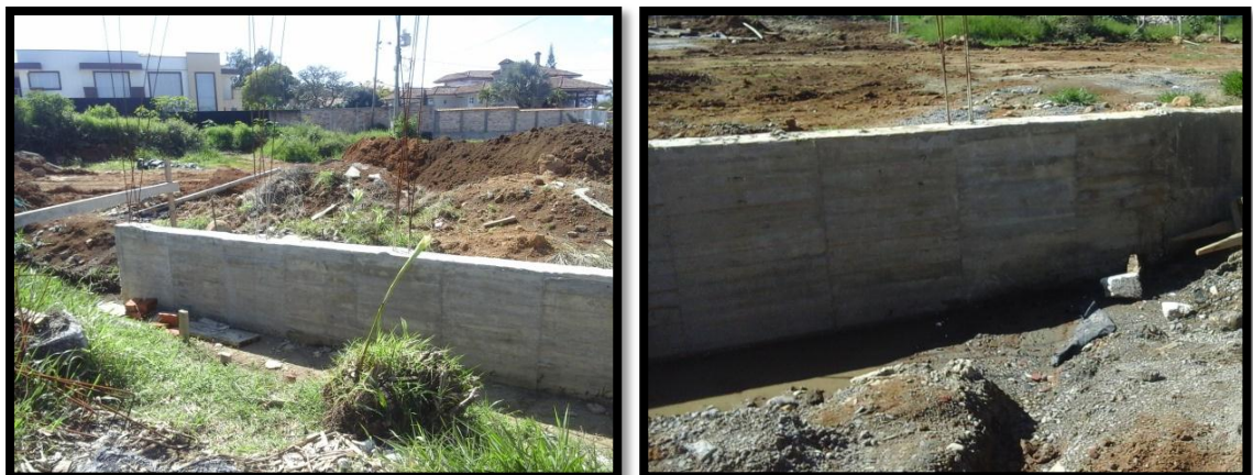
Figura 118. Muro de contención.
