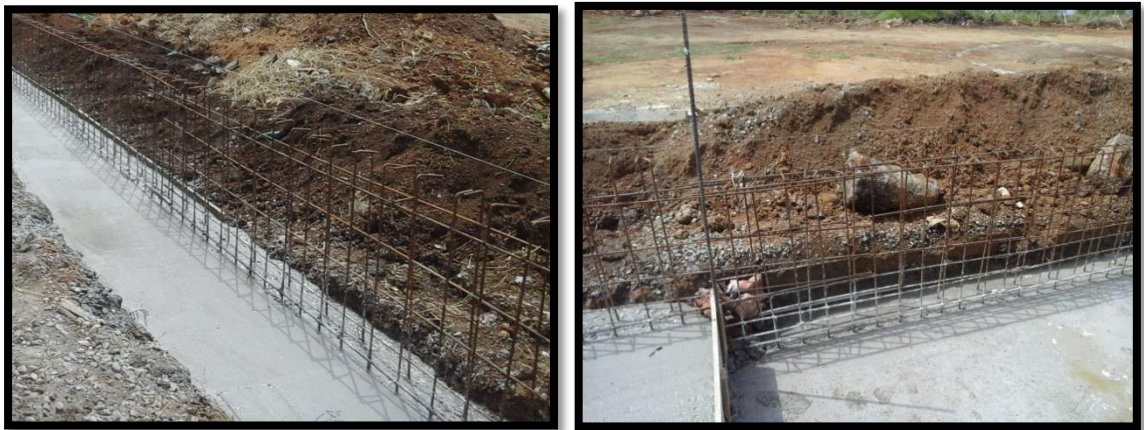
Figura 115. Muro de contención, zapata
