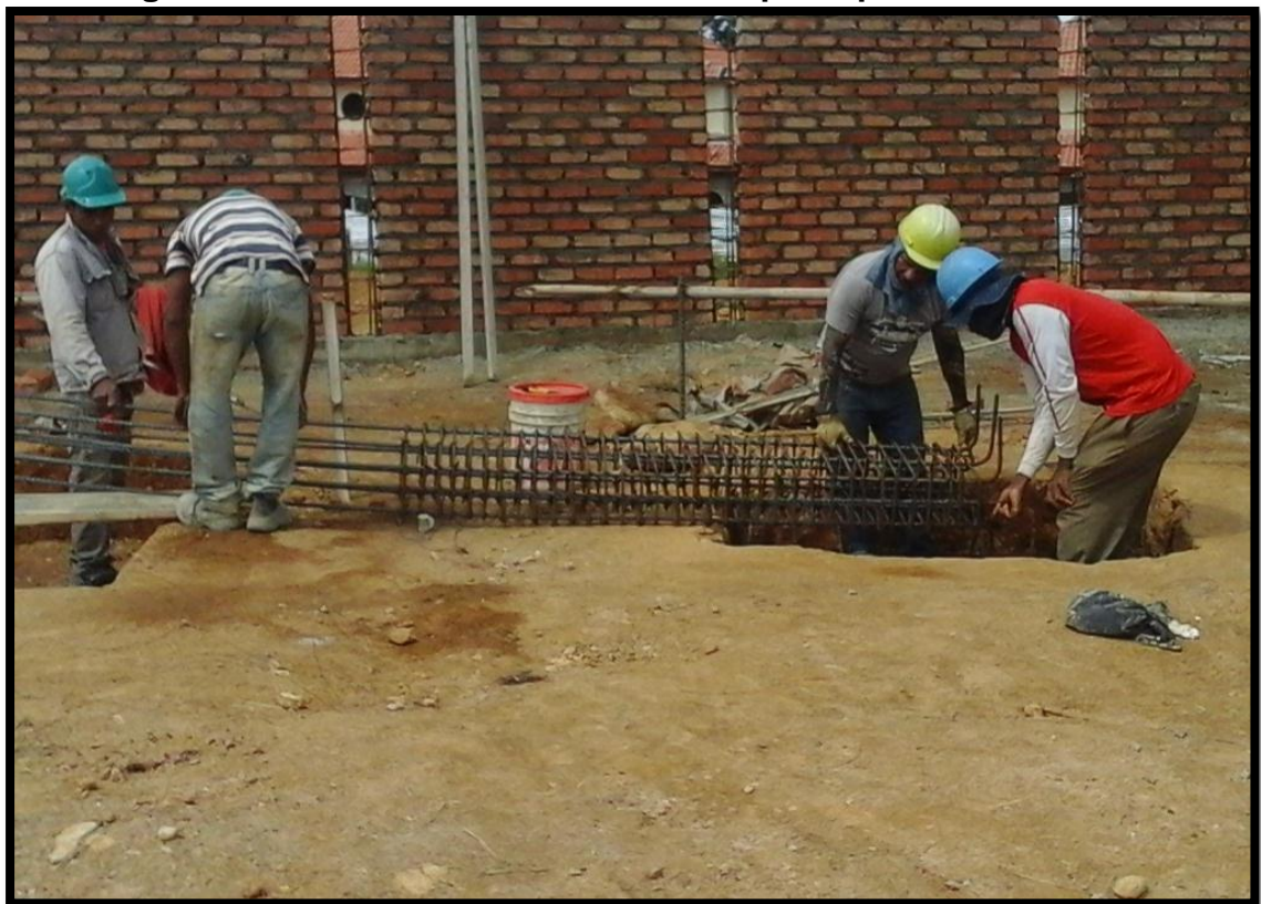
Figura 79. Colocación de la estructura principal de la columna
