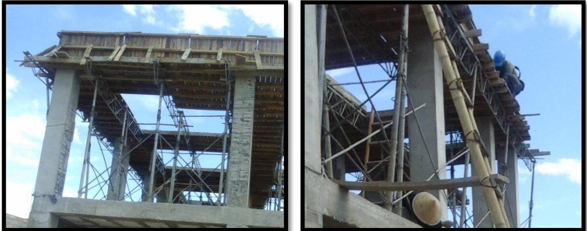
Figura 53. Armado de viga elevada
