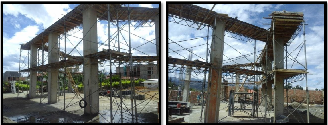
Figura 50. Tableros para viga elevada de cúpula
