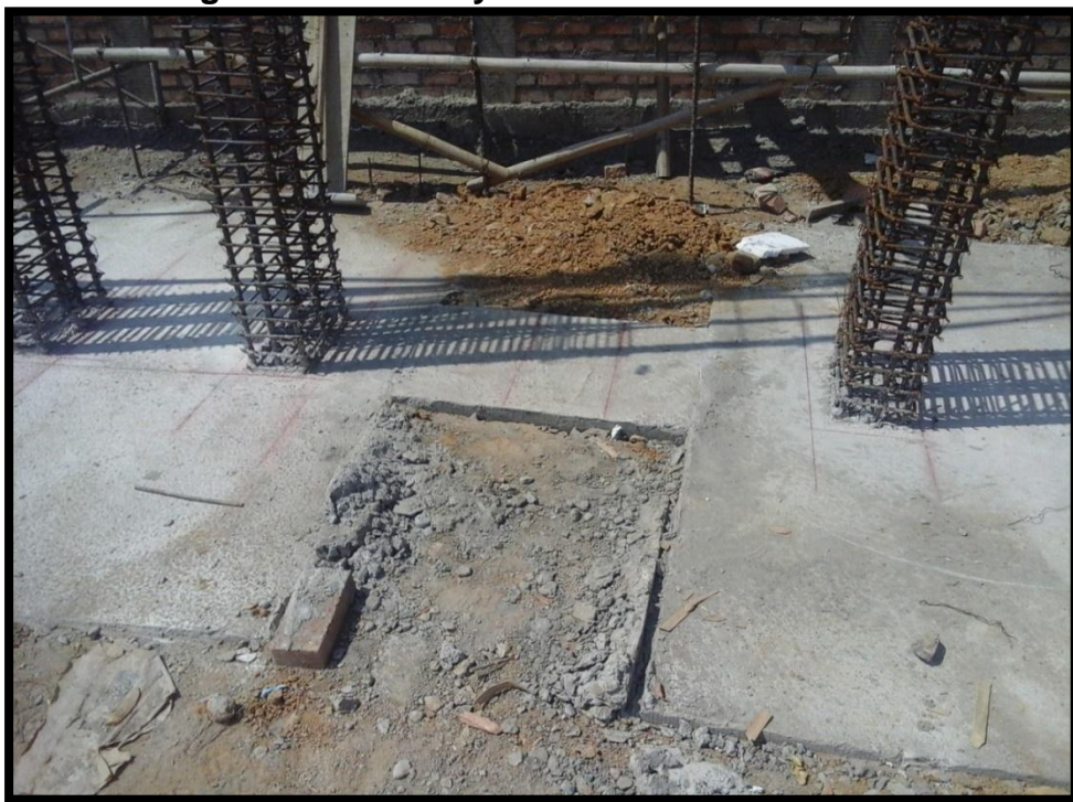
Figura 90. Solado y marcación de columnas
