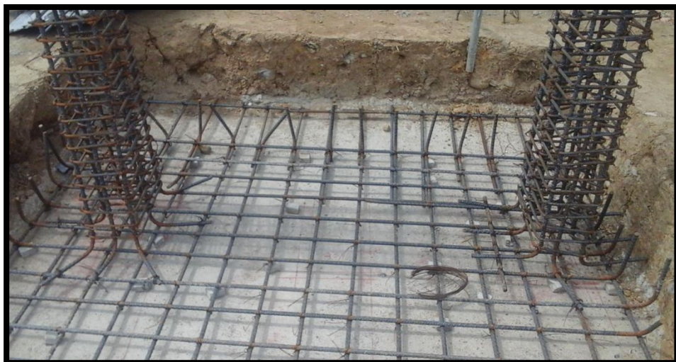
Figura 81. Estructuras ajustadas a la malla de la zapata.
