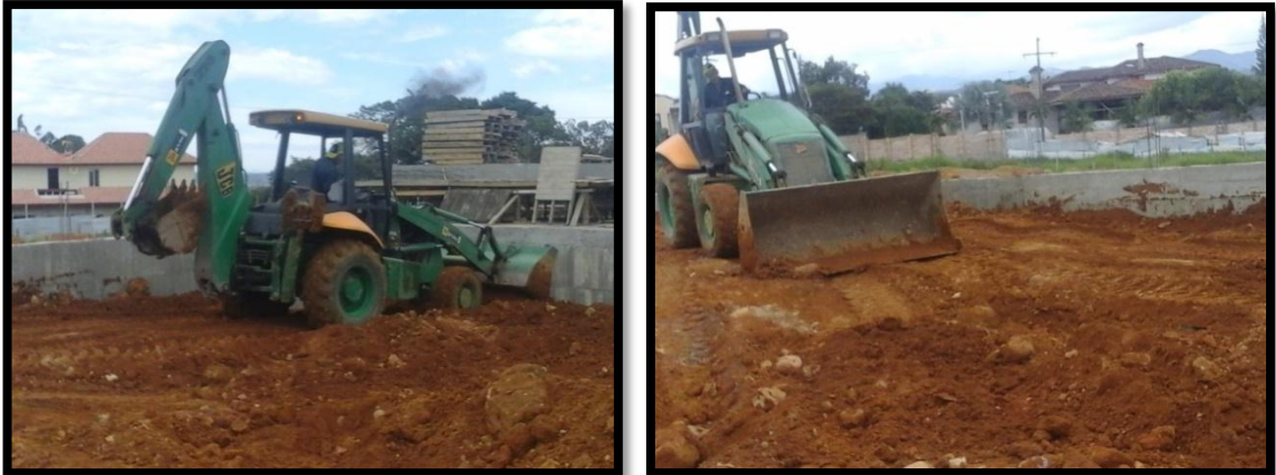
Figura 29. Retroexcavadora y distribución de material
