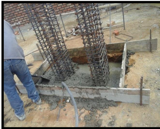
Figura 85. Fundición de zapatas
