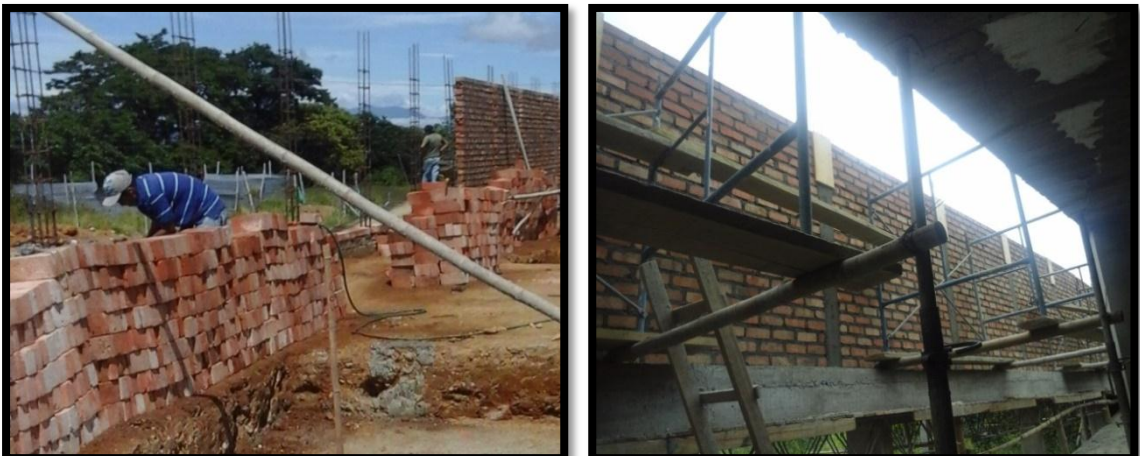
Figura 59. Elaboración de muros.
