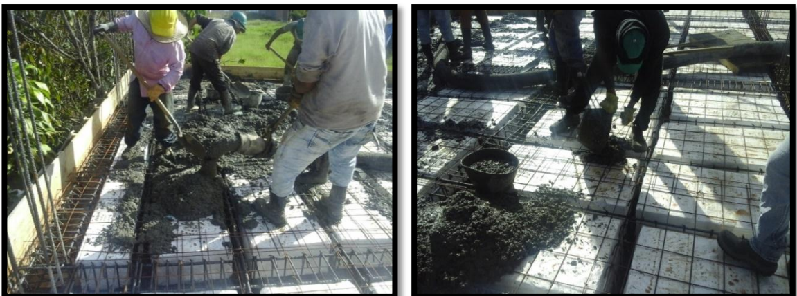
Figura 17. Colocación de concreto y el llenado de los espacios con concreto para evitar la movilidad de los casetones.
