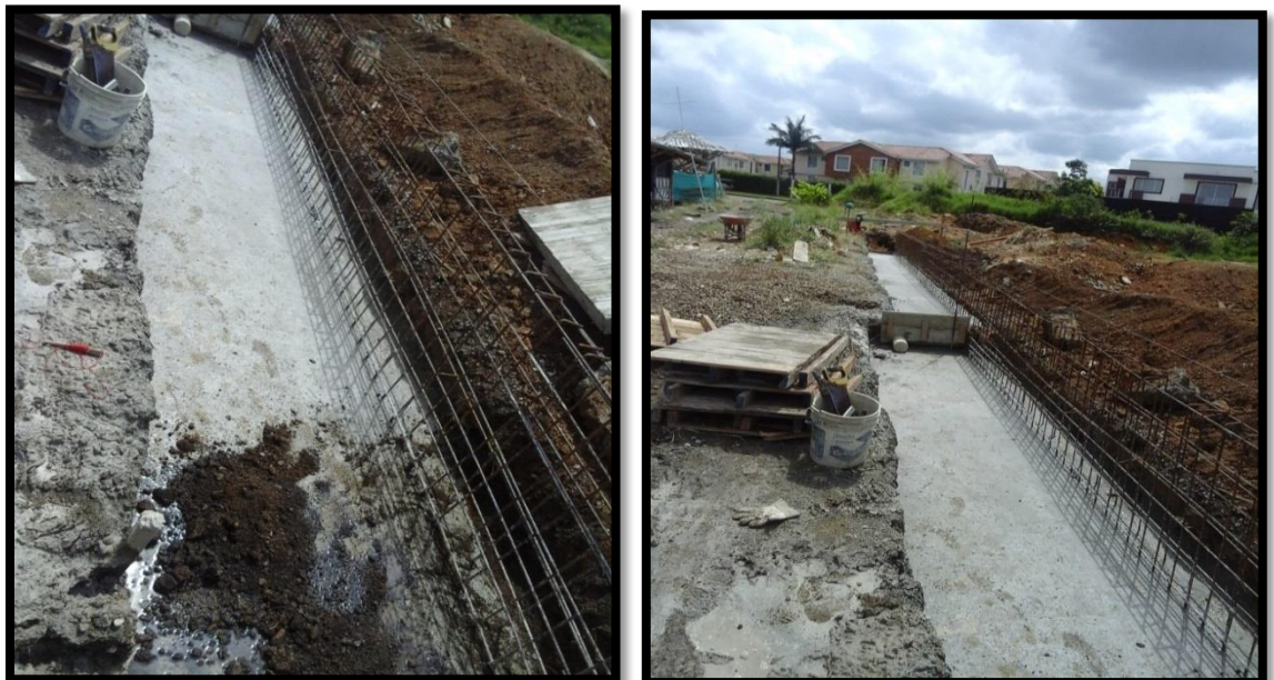
Figura 116. Muro de contención, zapata
