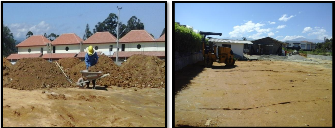
Figura 31. Selección de materiales extraños presentes en el material de relleno
