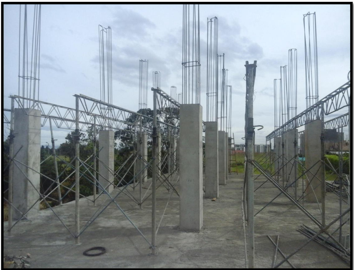
Figura 34. Montaje estructura para losa aligerada nivel 2
