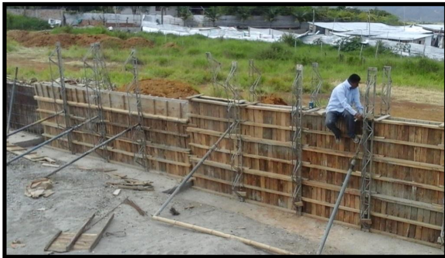
Figura 117. Formaleta de muro de contención.
