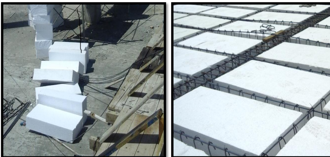
Figura 37. Colocación de los casetones
