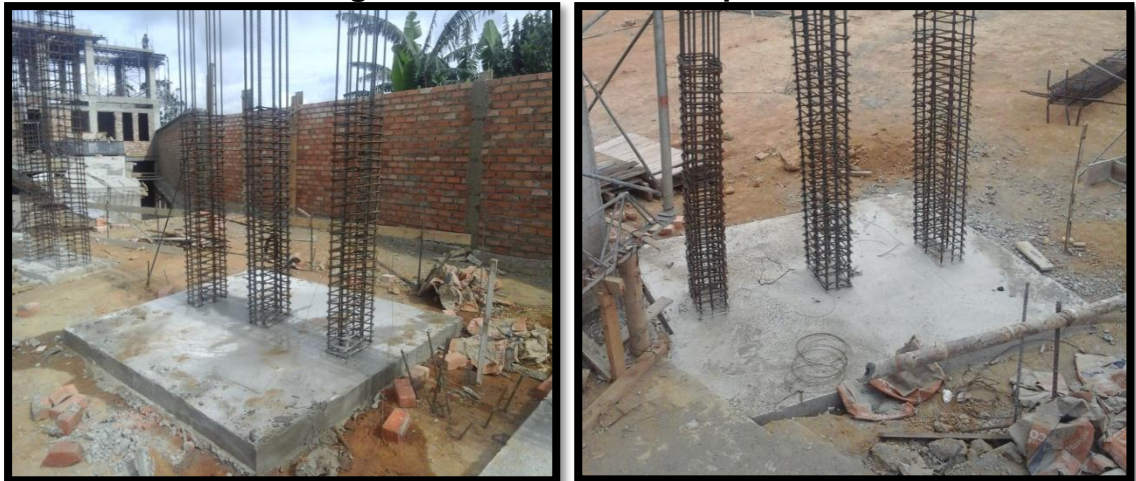
Figura 87. Fundición de zapatas.
