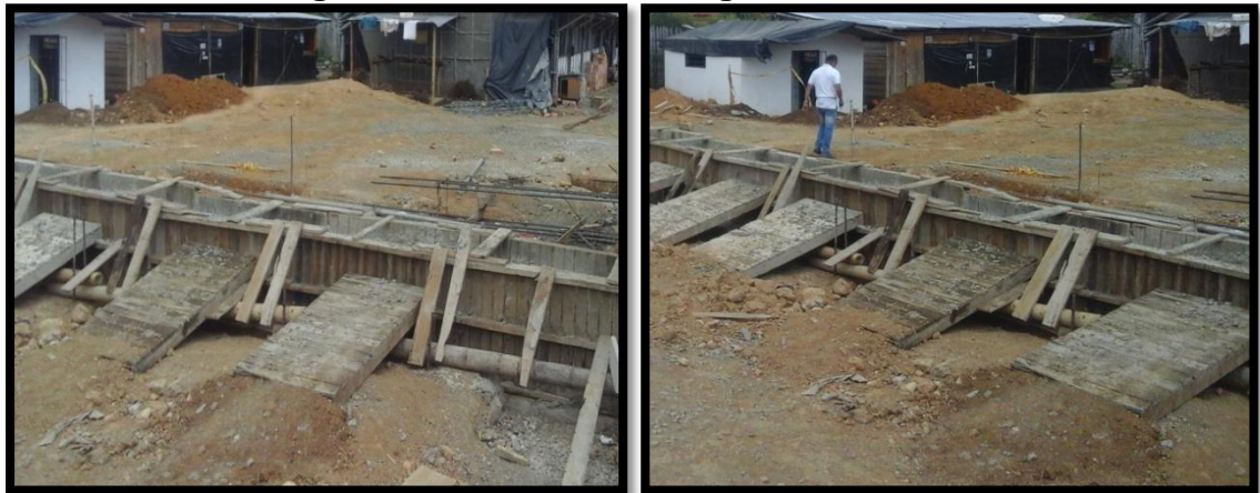
Figura 99. Formaleta de viga cimentadora.
