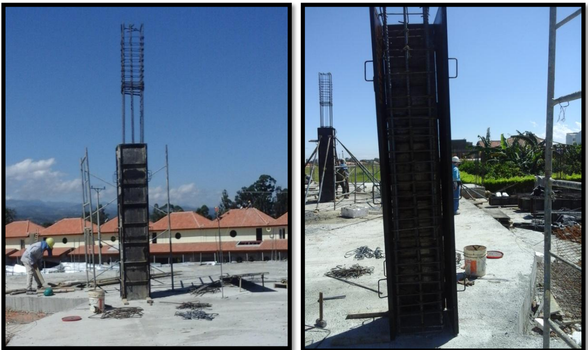
Figura 24. Formaleta de las columnas.
