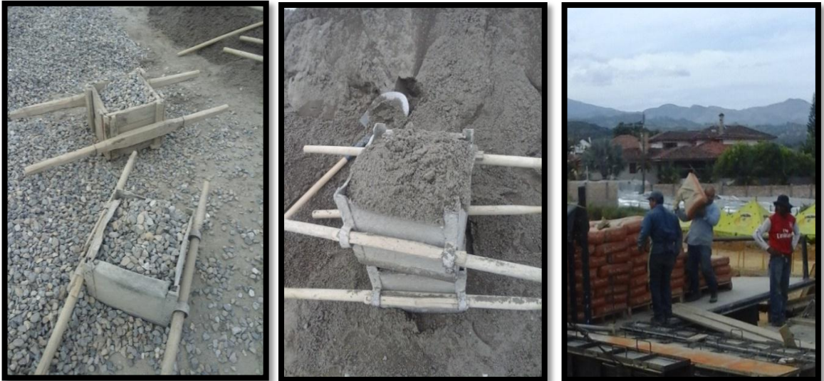
Figura 39. Medidores de cantidades de material para mezcla de concreto
