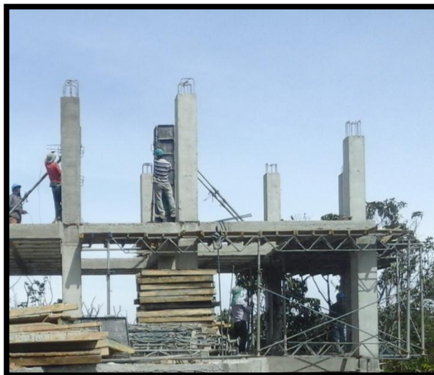
Figura 51. Columnas segundo nivel
