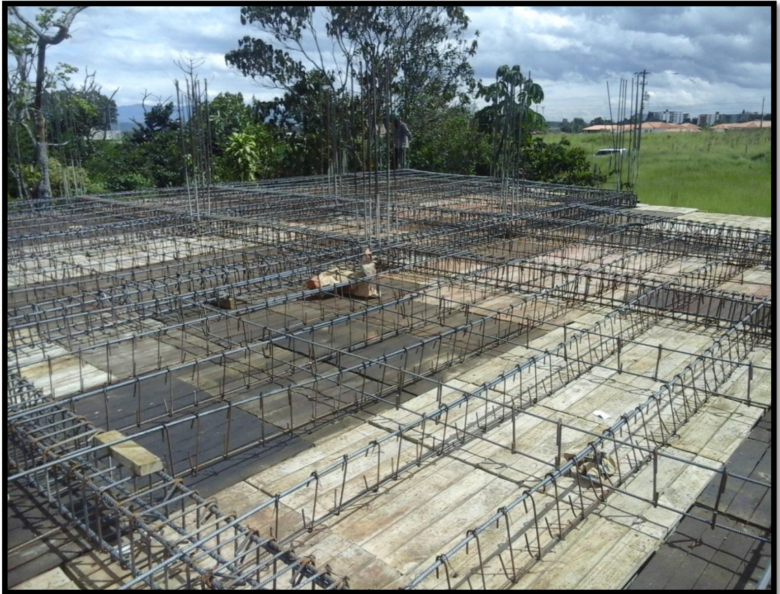
Figura 11. Armadura de la losa completa
