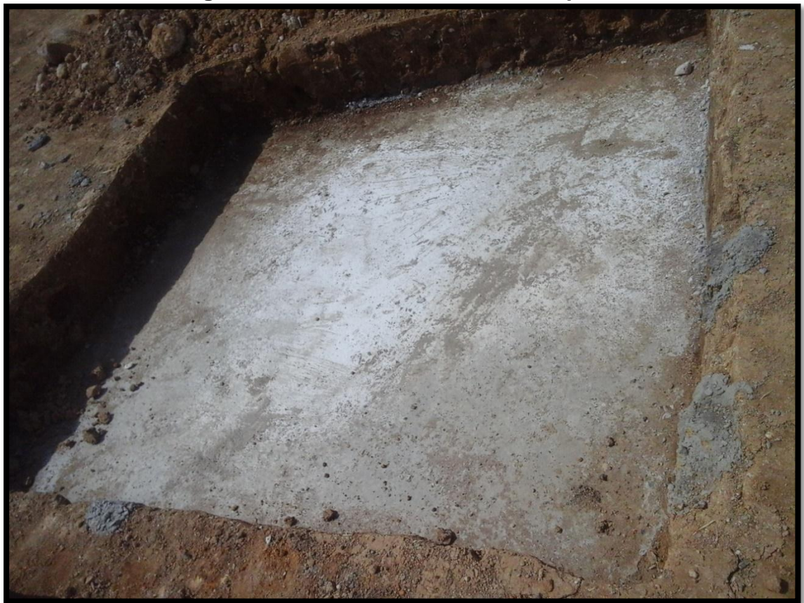
Figura 71. Solado en el ares de la zapata.
