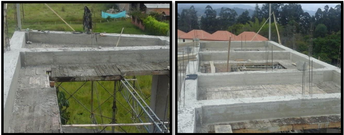
Figura 56. Viga desencofrada 5 días
