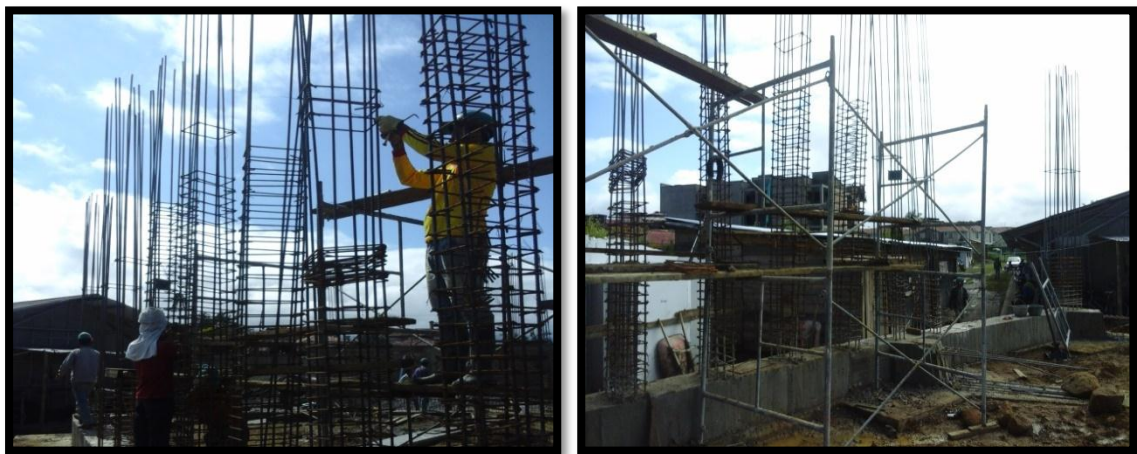
Figura 105. Colocación de estribos. Columnas
