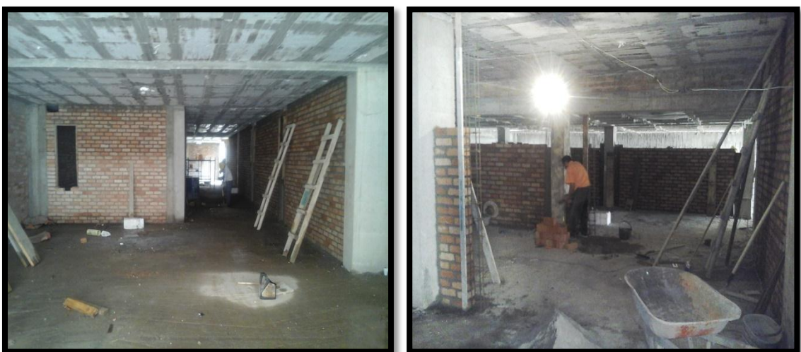
Figura 64. Muros internos zona de osarios
