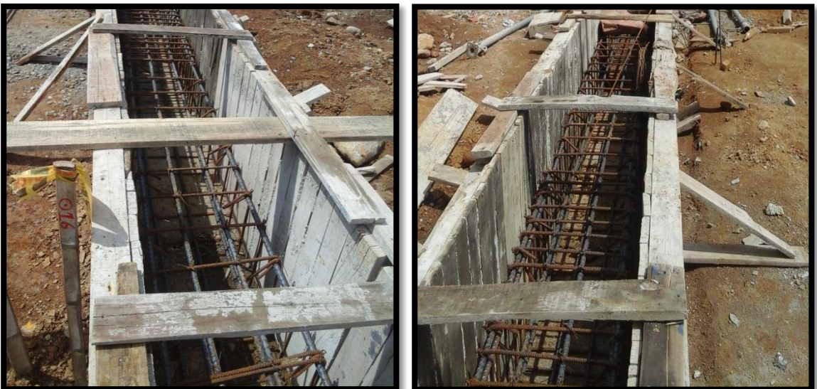
Figura 98. Formaleta de viga cimentadora.
