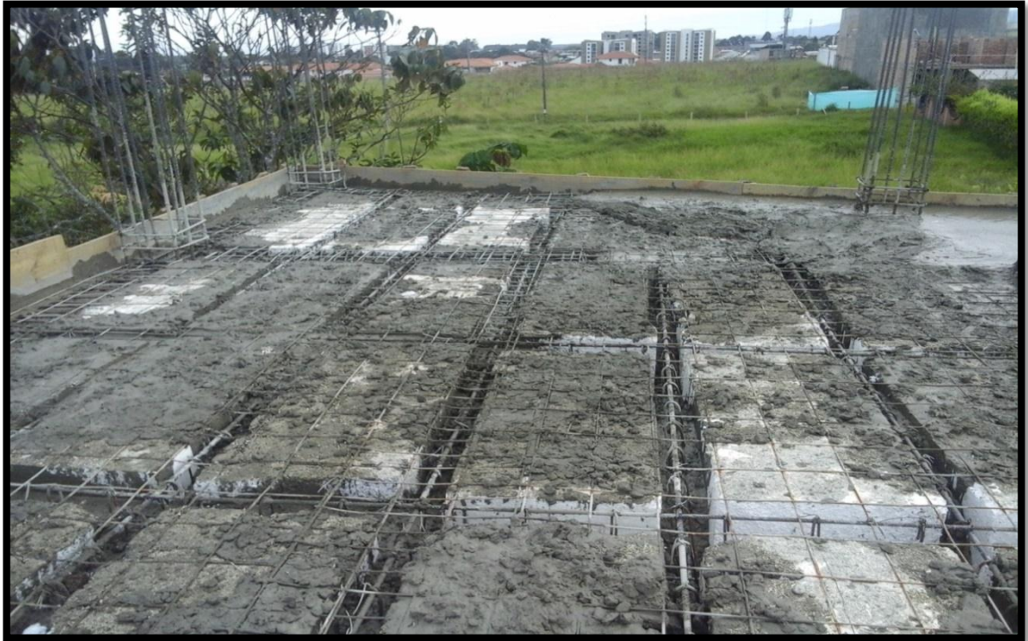
Figura 41. Distribución de concreto en los vacíos donde van los nervios y riostras
