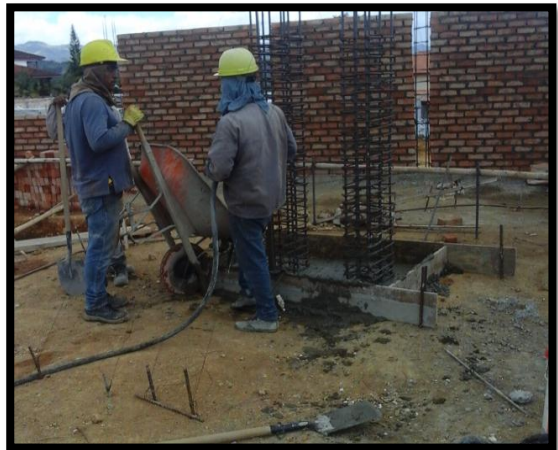
Figura 85. Fundición de zapatas
