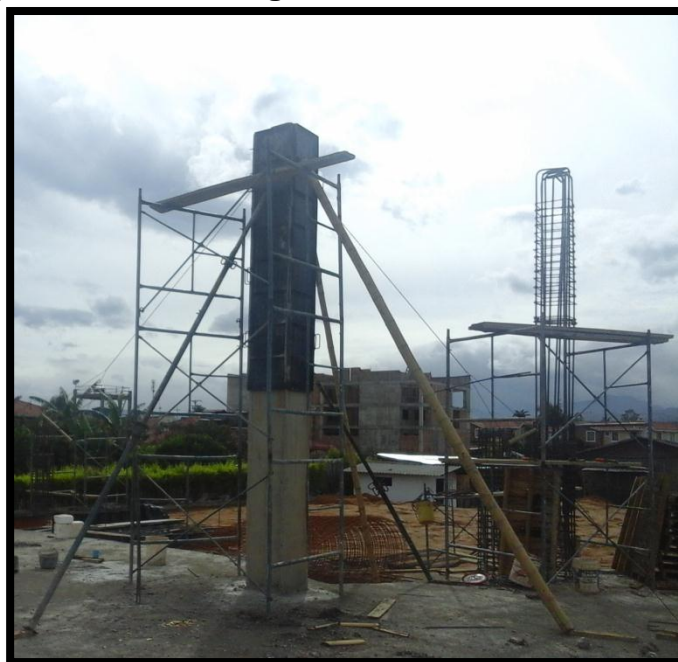
Figura 46. Tacos de guadua en formaleta metálica.
