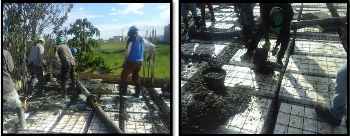
Figura 21. Distribución del concreto
