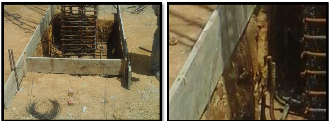
Figura 84. Formaleta superior de la zapata.
