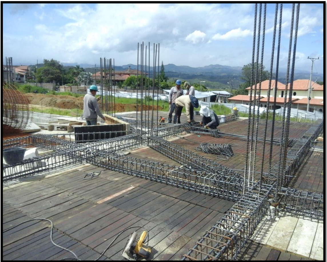
Figura 10. Armadura de vigas amarradas a columnas que vienen de planta Baja con colocación de estribos de diseño a distancias calculadas.
