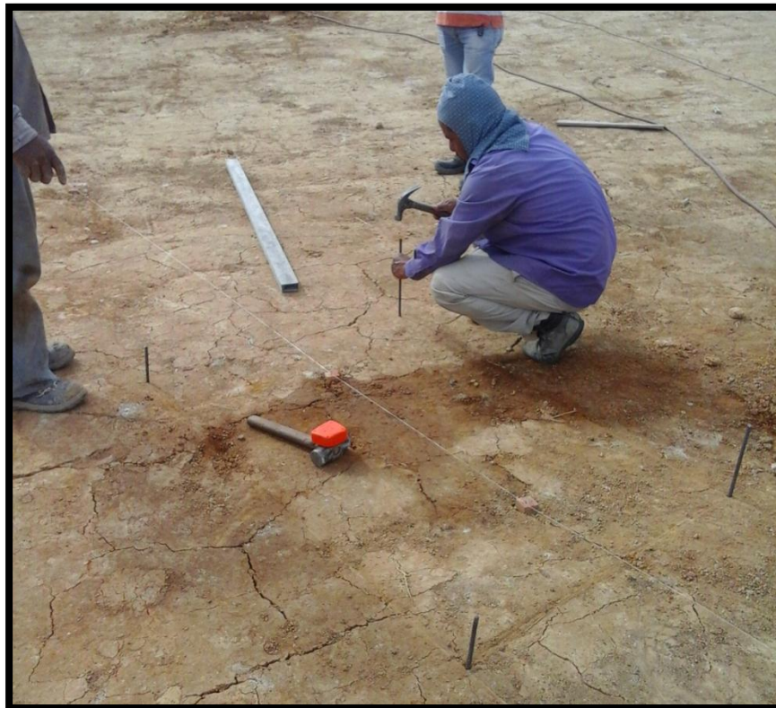
Figura 68. Marcación de la zapata sobre el relleno compacto
