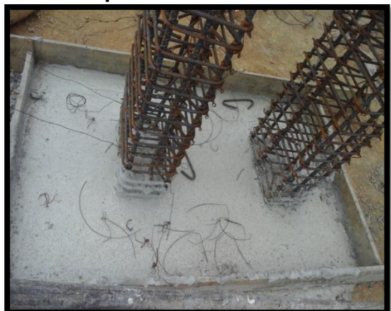
Figura 86. Fundición de zapatas
