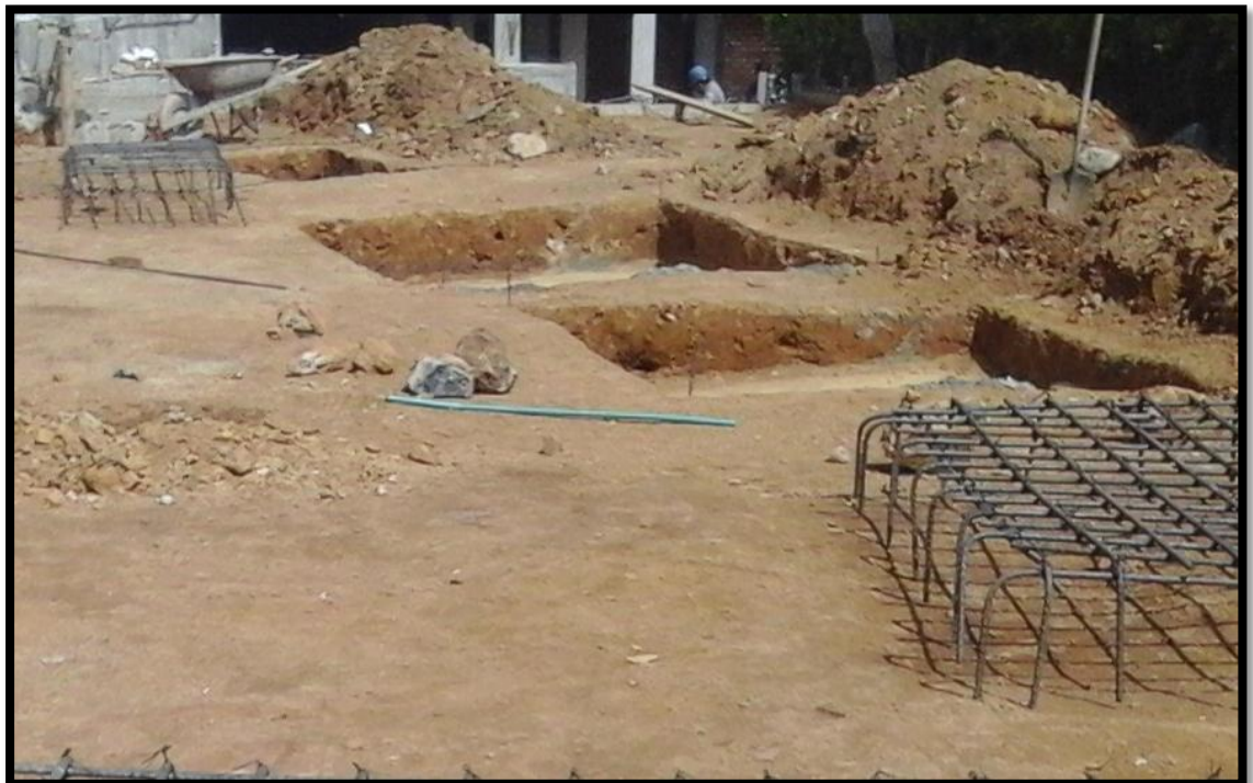
Figura 69. Excavaciones de las áreas de las zapatas
