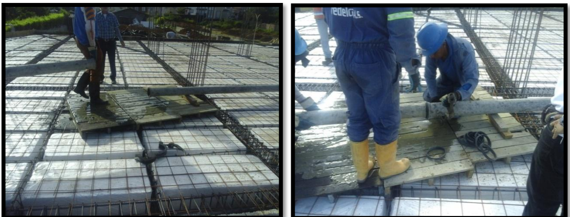
Figura 15. Tubería transportadora de concreto colocación de correas en las uniones de las tuberías por parte del personal de Predelca.
