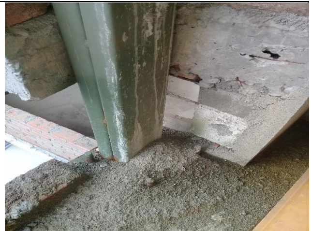
Perfil metálico trabajando como columna embebido en losa de entrepiso
