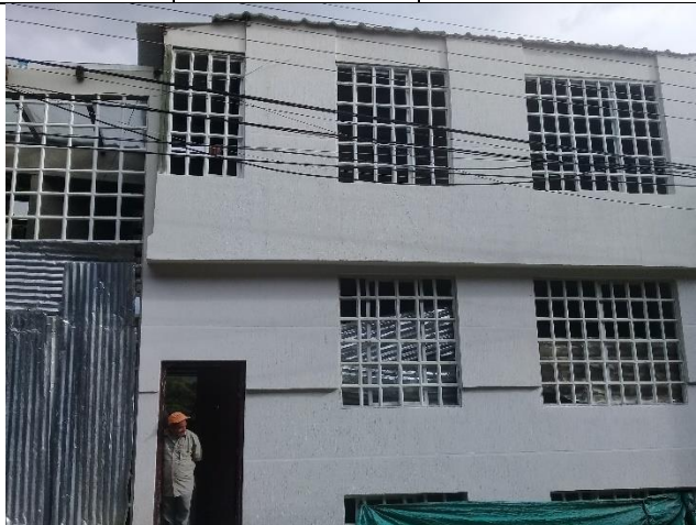
Fachada de la vivienda
