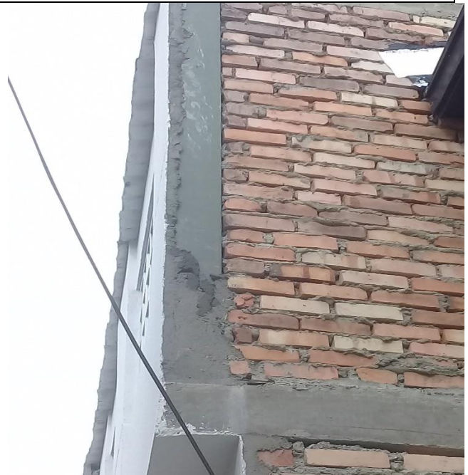
Perfil metálico trabajando como columna del segundo piso recubierto con repello
