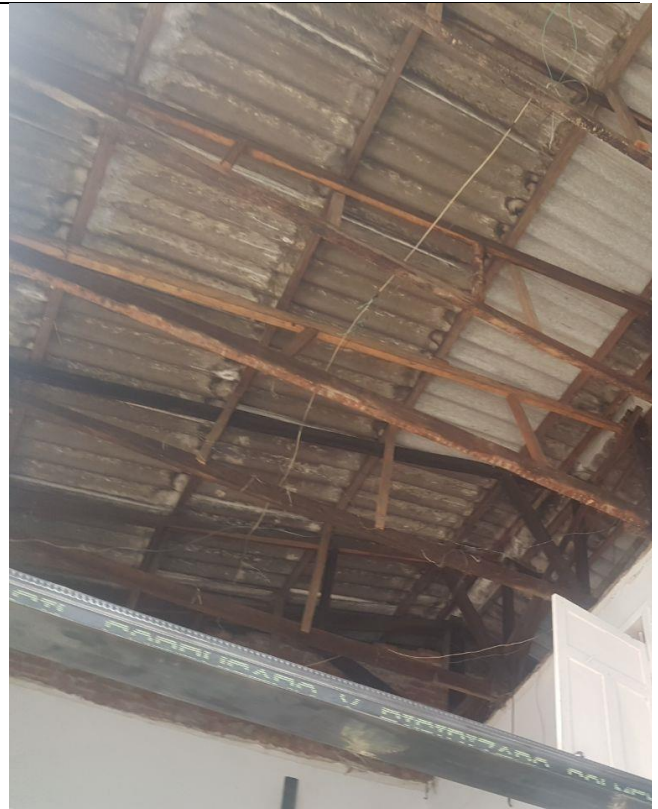
Cambio de cubierta
