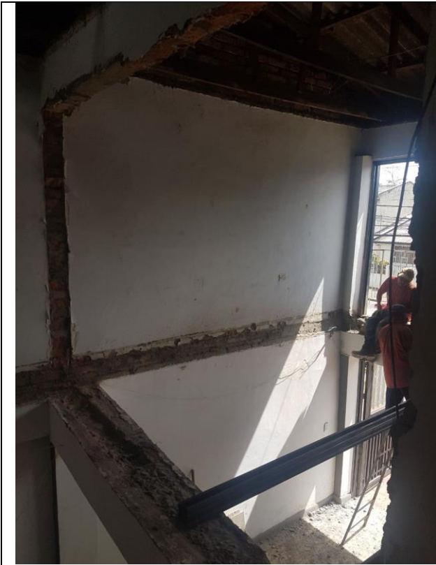
Demolición de losa de entrepiso
