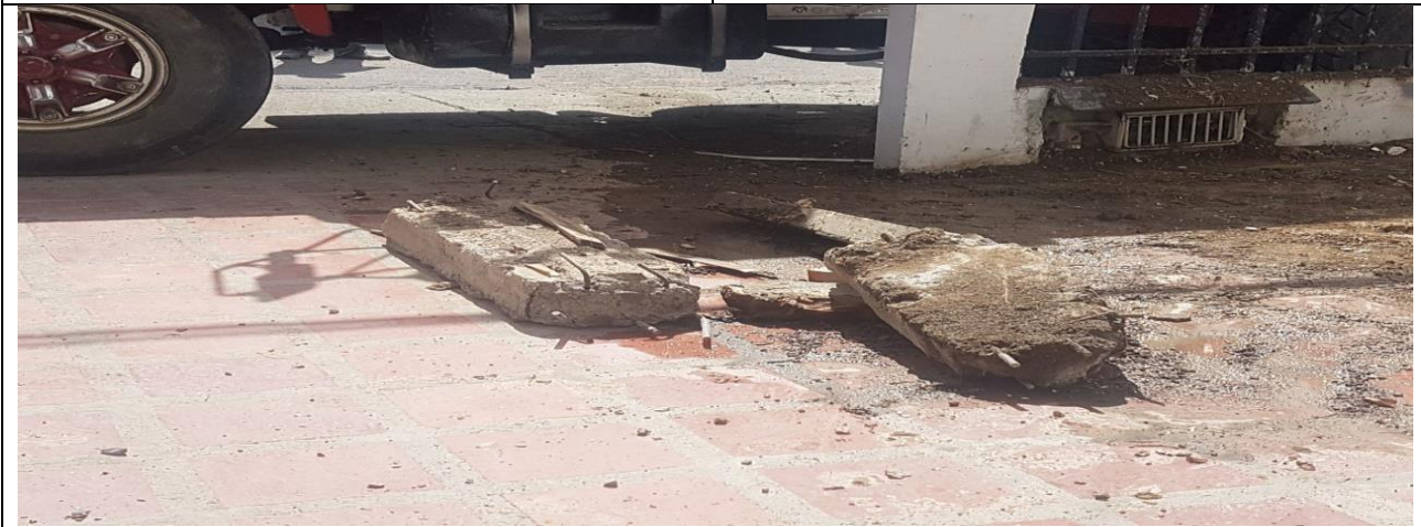
Demolición de una viga estructural
