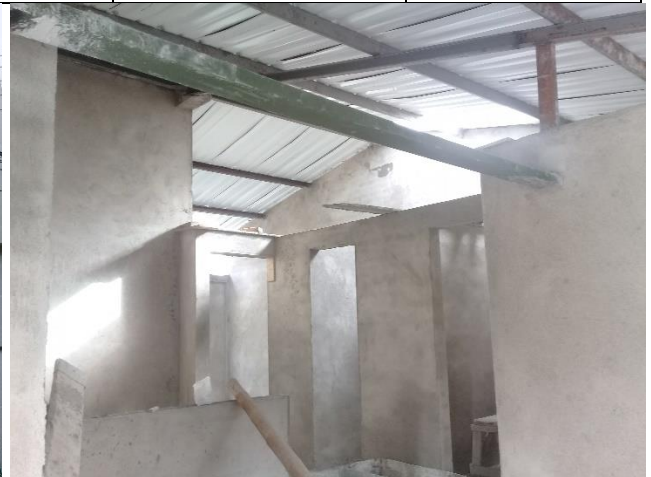
Perfiles metálicos embebidos en muros de concreto trabajando como columnas y vigas
