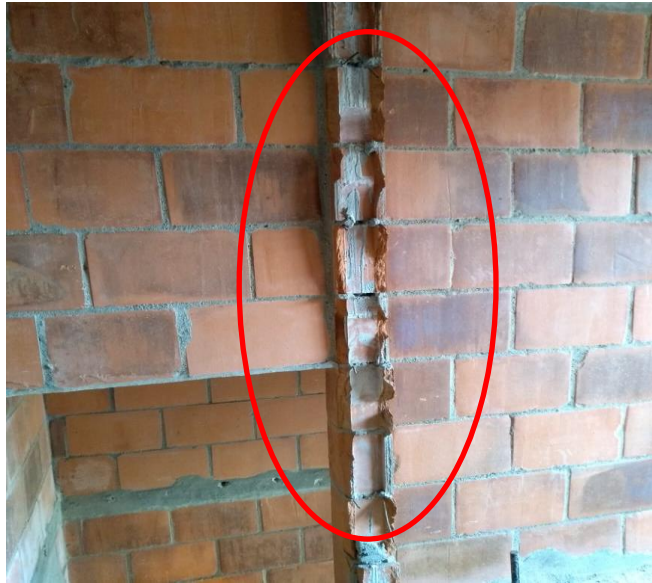
Figura 6.4.2.1. Demolición de muros estructurales.
