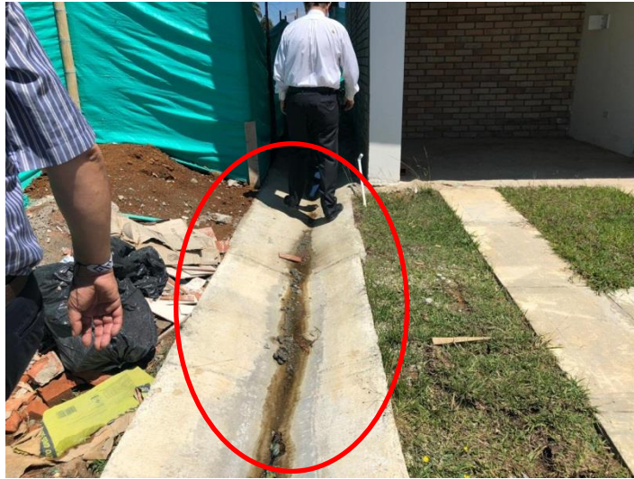
Figura 6.9.2.1. Obras de adecuación para mitigar las inundaciones.
