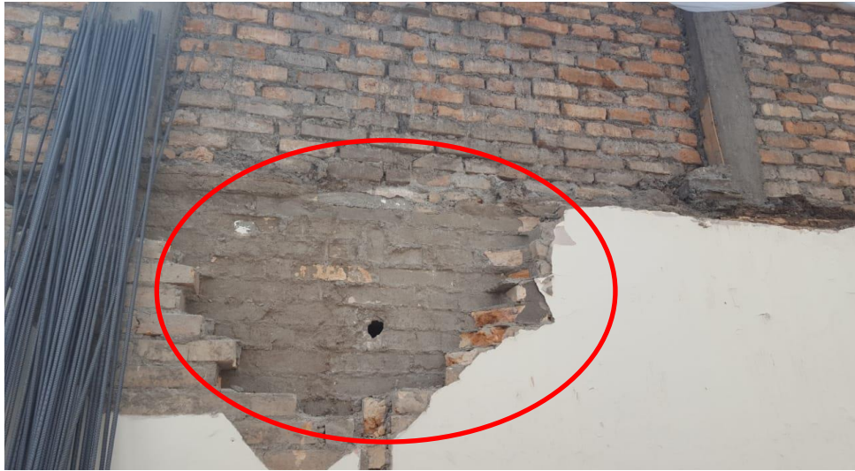
Figura. 6.1.2.2. Agujeros y demolición de parte de la pared colindante.
