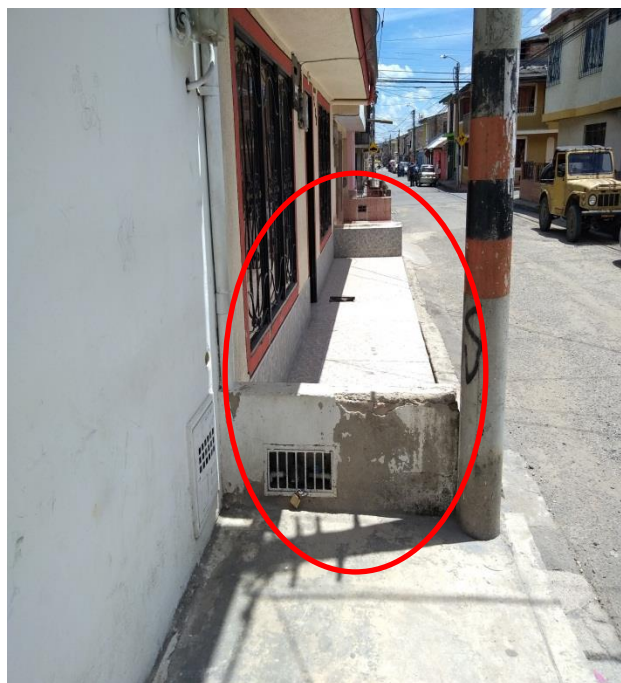
Figura 6.10.2.2. Dos muros de las mismas dimensiones invadiendo el andén.
