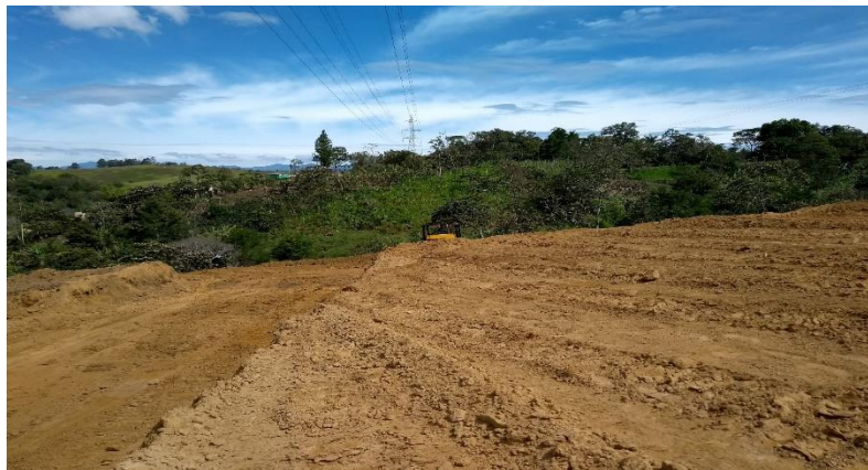
Figura 6.7.2.2. Movimiento de tierra.
