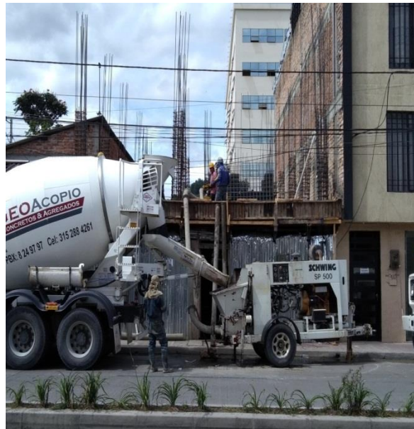
Figura 6.2.3.4. Se realiza fundición de la losa de segundo nivel.
