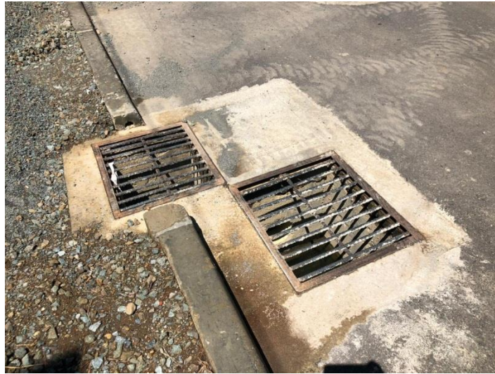
Figura 6.9.2.3. Sumideros con modificaciones al diseño.
