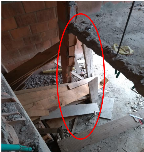
Figura 6.4.2.2. Demolición de muros estructurales.
