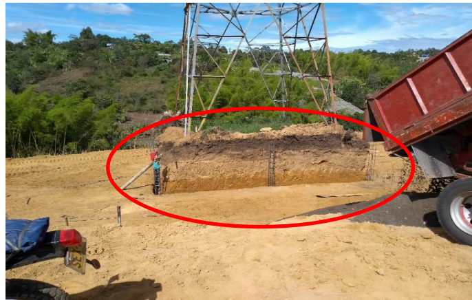
Figura 6.7.2.1. Construcción de muros sobre la torre de alta tensión.
