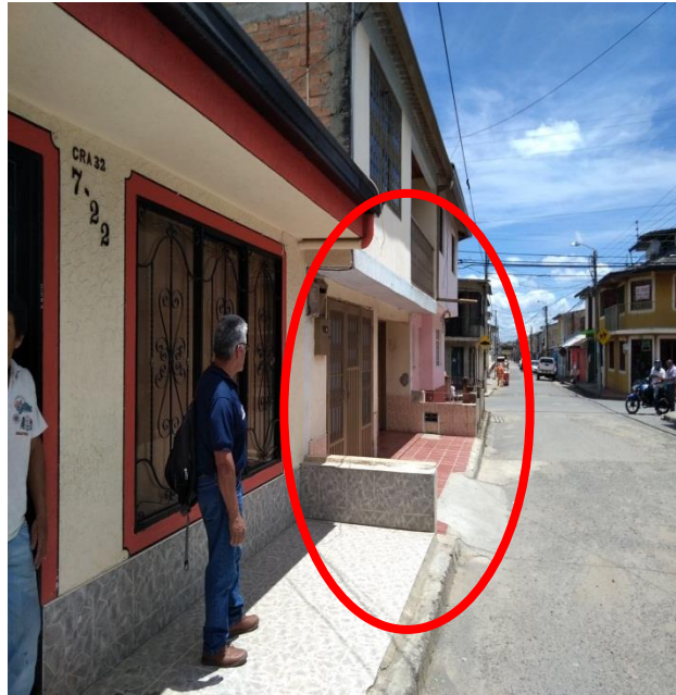
Figura 6.10.2.3. Muros invadiendo el andén.
