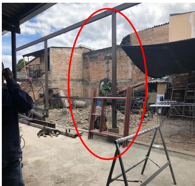
Figura 6.5.2.2. Nueva estructura metálica.
