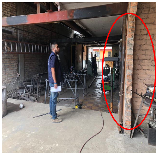
Figura 6.5.2.1. Demolición de muro divisorio.
