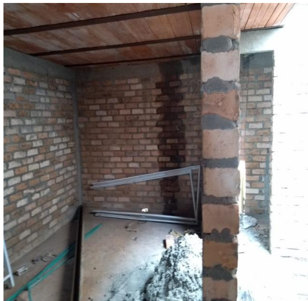
Figura 6.4.2.4. Estructura en mampostería de muros confinados.
