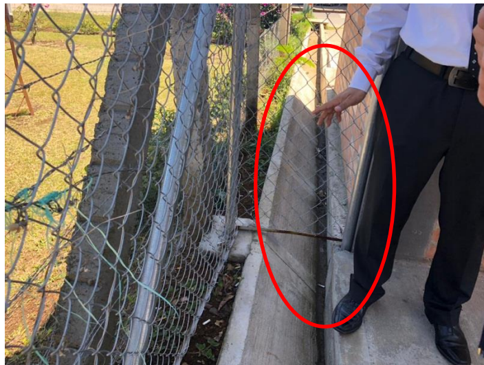
Figura 6.9.2.2. Obras de adecuación para mitigar las inundaciones.
