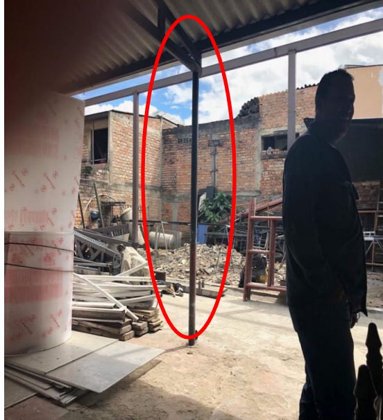
Figura 6.5.2.3. Nueva estructura metálica.
