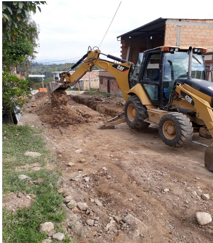
Figura 5. Actividad del Retro cargador Caterpillar 420 E.
