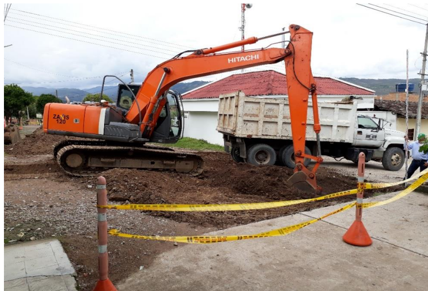
Figura 3. Actividad de la excavadora hidráulica sobre orugas Hitachi 120.
