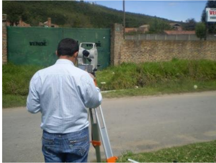
Figura 10. Estación total montada sobre el mojón de referencia en el parque principal del municipio de la Argentina.
