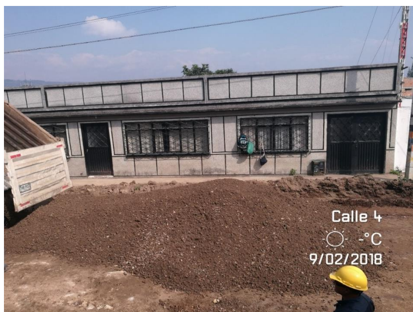
Figura 9. Suministro de subbase granular en la calle 4
