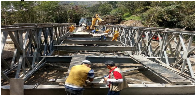
Figura 73. Detalle de la instalación del tablero.
