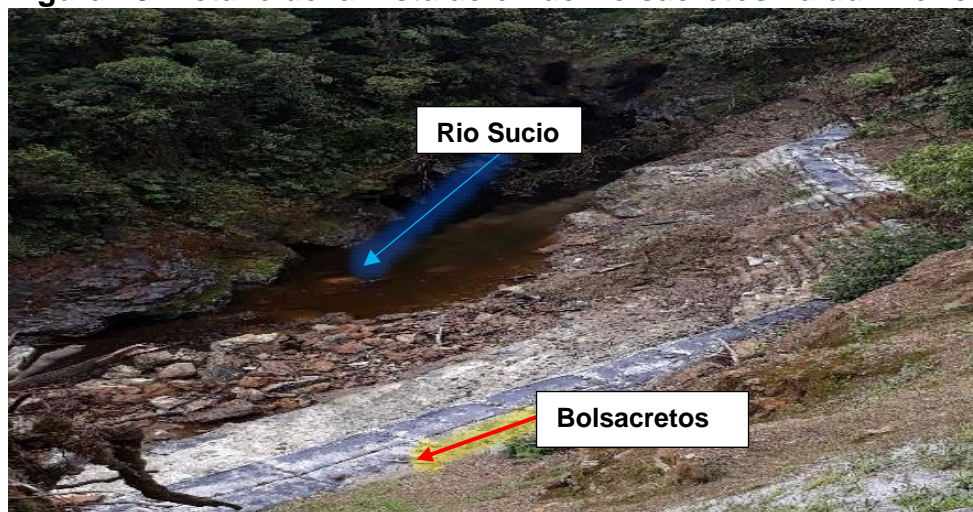
Figura 18. Detalle de la instalación de Bolsacretos Talud inferior
