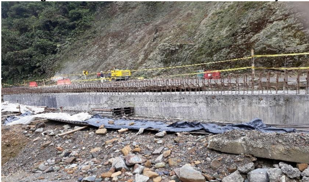
Figura 20. Detalle de la construcción del New Jersey
