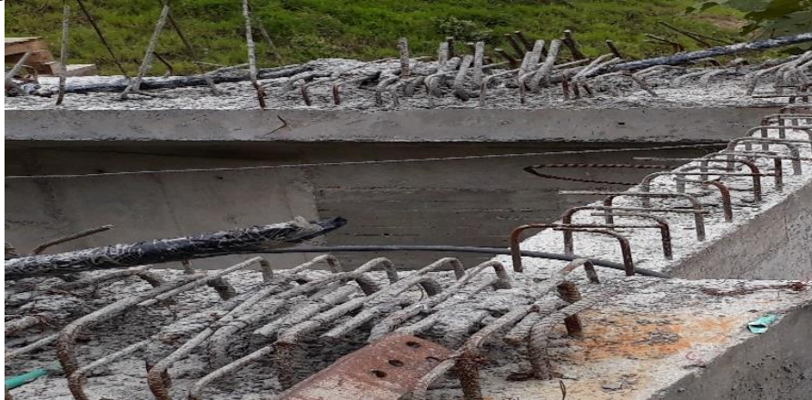
Figura 43. Detalle de los aceros con mortero seco Puentes No. 19
