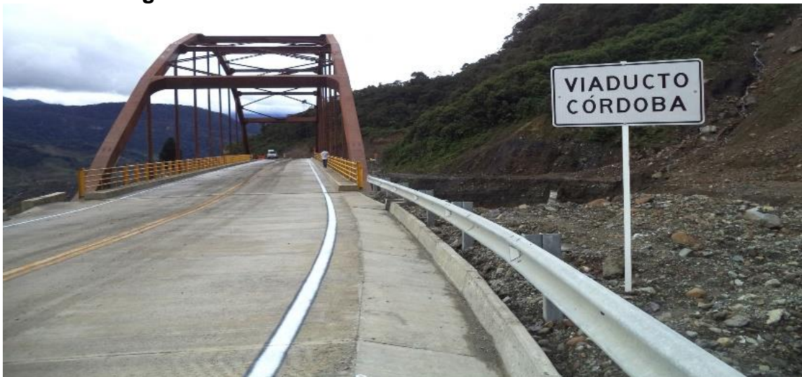
Figura 23. Detalle del Puente Córdoba en el año 2016
