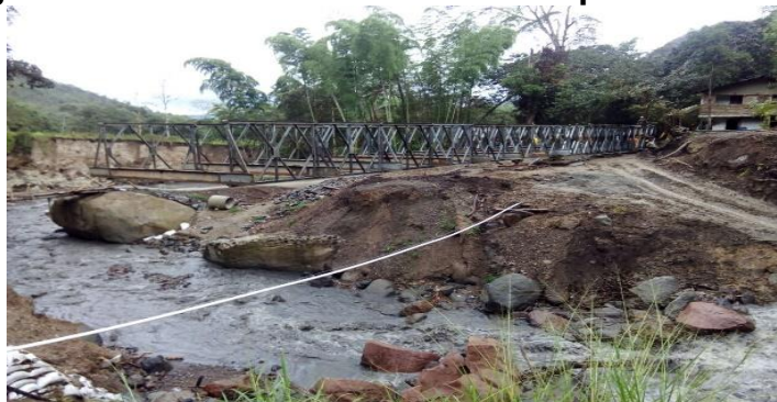
Figura 71. Detalle del lanzamiento de puente ACROW
