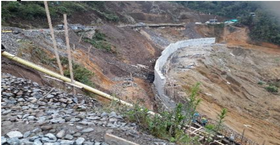
Figura 16. Detalle del muro en concreto reforzado PR 60+200
