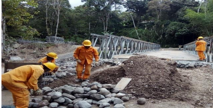
Figura 75. Detalle de la construcción de gaviones y confinamiento de la zona de entrada en la margen derecha.
