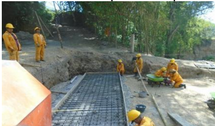
Figura 64. Detalle del armado de parrilla doble para losa superior.
