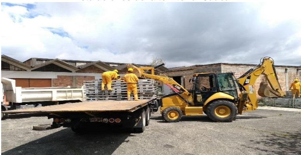
Figura 52. Cargue de estructura metálica puente ACROW desde las instalaciones de la territorial Cauca.
