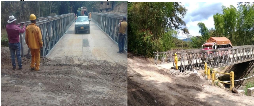
Figura 77 Habilitación del paso vehicular PR 2+0050. Vía 26CC04
