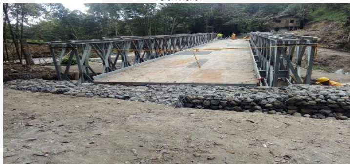
Figura 74. Detalle de la construcción de gaviones de protección zona de salida
