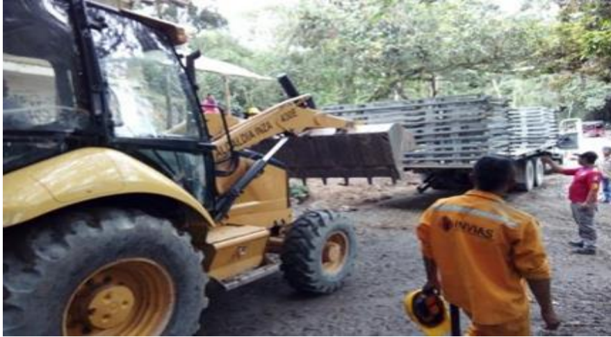
Figura 53. Descargue de estructura metálica puente ACROW en el PR 02+050
