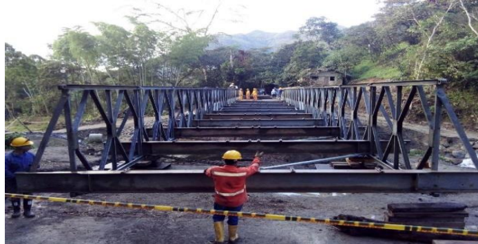
Figura 72. El puente ACROW llega al apoyo de la margen izquierda.
