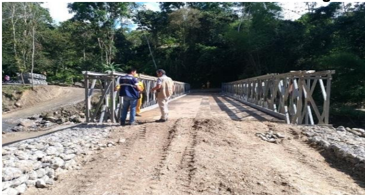
Figura 76 Detalle del acceso de entrada en la margen derecha.
