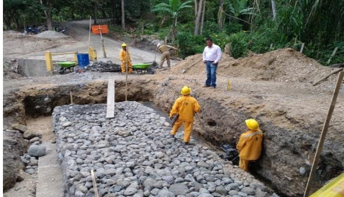
Figura 62. Detalle del relleno de zonas laterales
