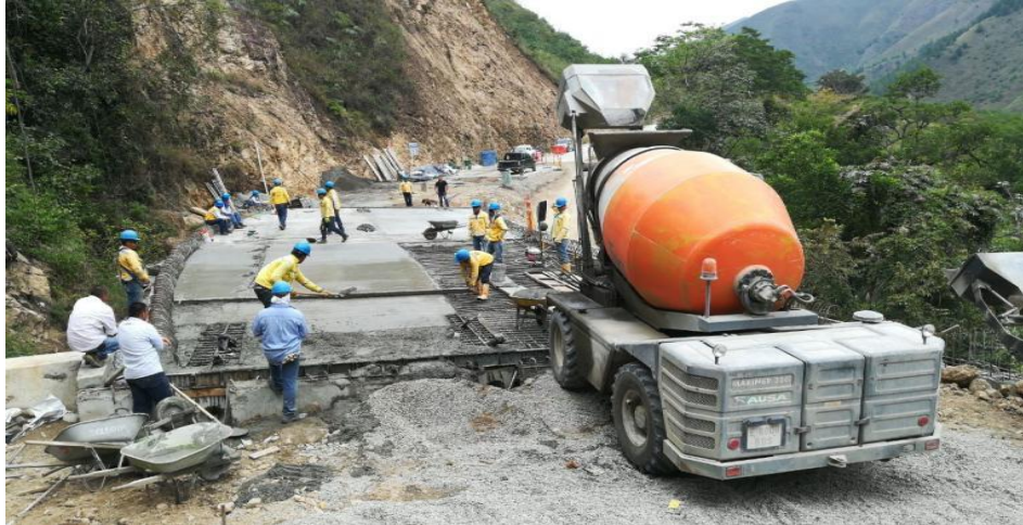
Figura 39. Fundición de la losa superior puente N° 9 Puerto valencia – Juntas ruta 3701
