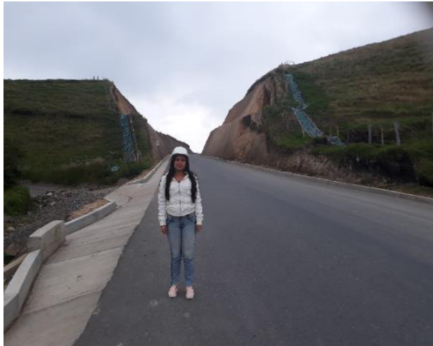
Figura 8. Detalle de la Ruta 2602 Pavimento Flexible PR 35+430 – PR 38+230
