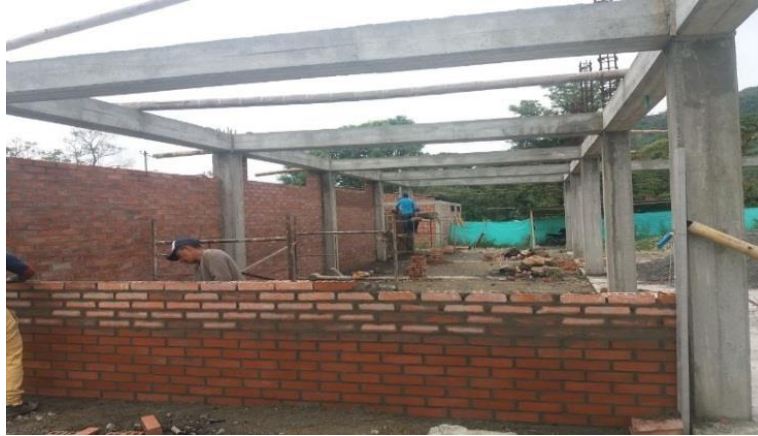
Figura 41. Construcción del salón comunal en el resguardo de San Andrés de Pisimbalá ruta 2602
