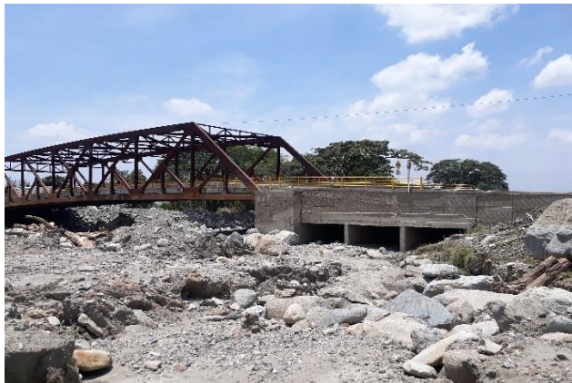
Figura 87. Detalle del Puente sobre el río La Paila en Corinto Cauca
