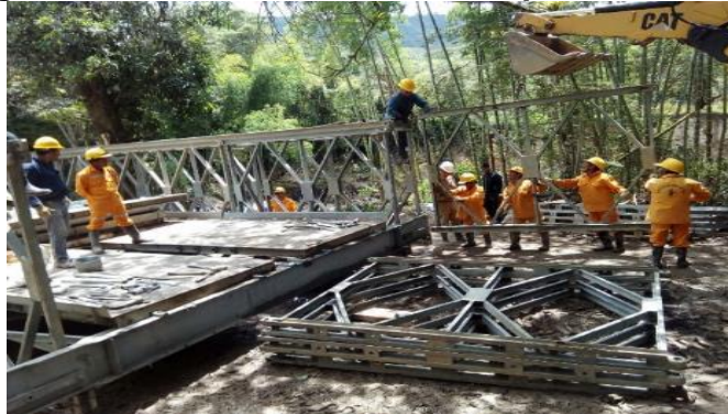
Figura 70. Detalle del armado del puente ACROW
