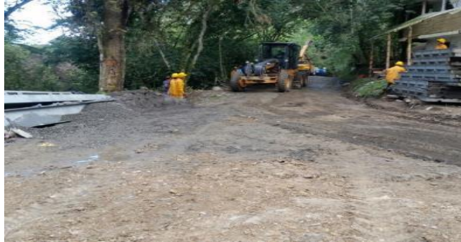
Figura 69. Detalle de la realización de la pista de lanzamiento para el puente ACROW.
