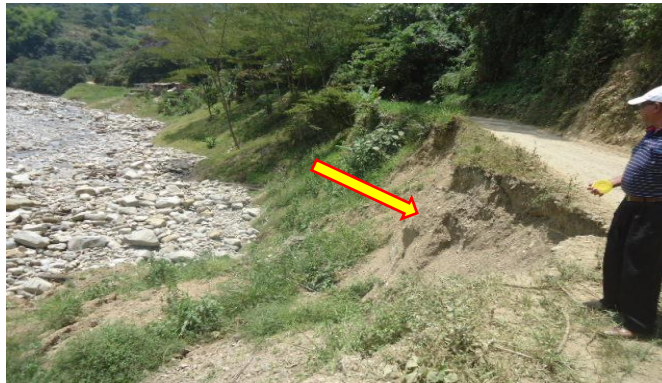
Figura 89. Detalle del sitio donde se va a construir el muro de pata en concreto reforzado en el PR 06+200 de la ruta 18070.
