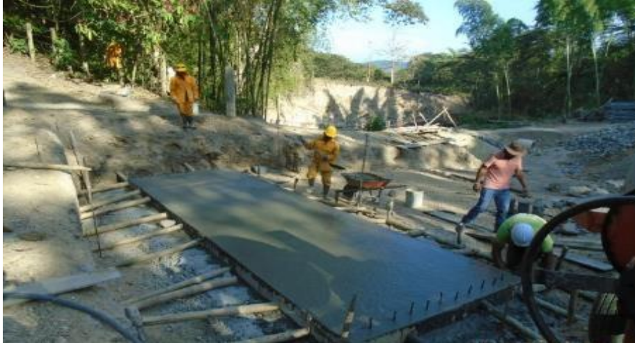
Figura 65. Detalle de la fundición de la losa superior
