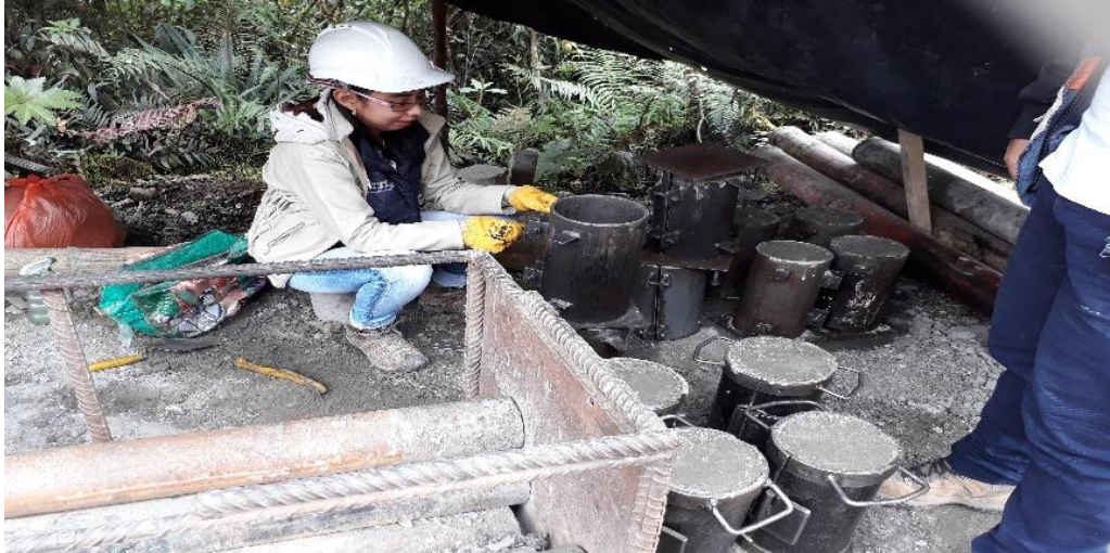
Figura 21. Detalle de la preparación de cilindros de concreto para el ensayo a la Compresión.
