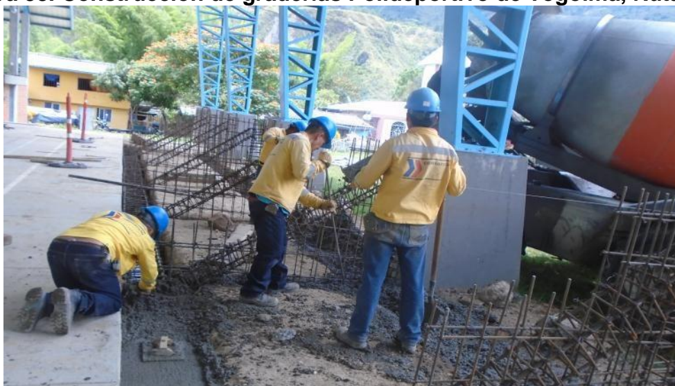
Figura 38. Construcción de graderías Polideportivo de Togoima, Ruta 3701
