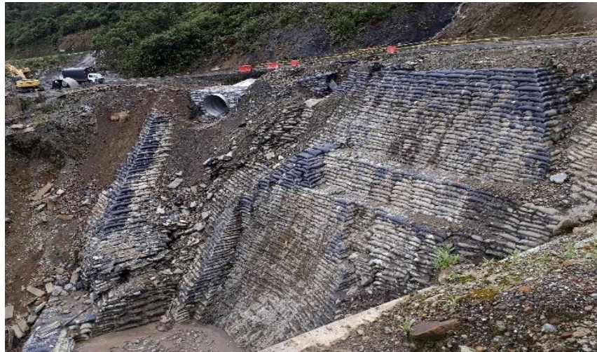
Figura 26. Detalle de la disposición de los bolsacretos para la estabilización del talud.
