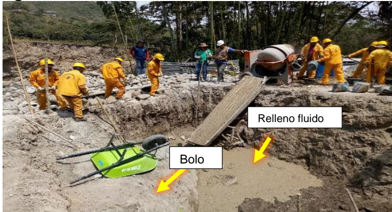
Figura 67. Detalle de la nivelación con relleno fluido
