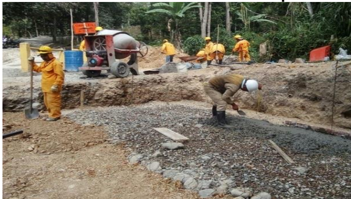
Figura 63. Detalle de la construcción de solado para la losa superior
