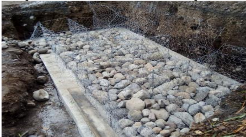
Figura 61. Detalle de construcción de gaviones
