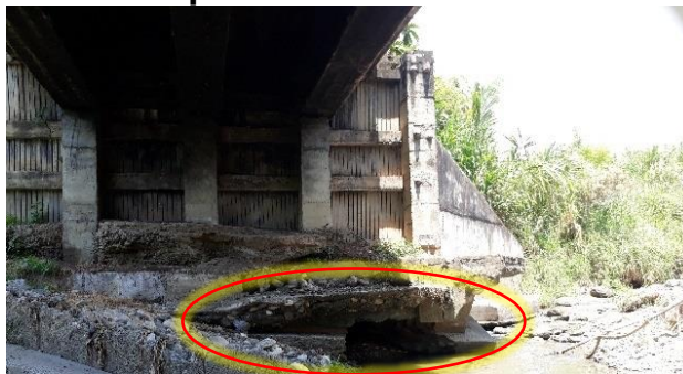
Figura 80. Detalle de socavación en el apoyo de la margen izquierda de la quebrada Las Cañas
