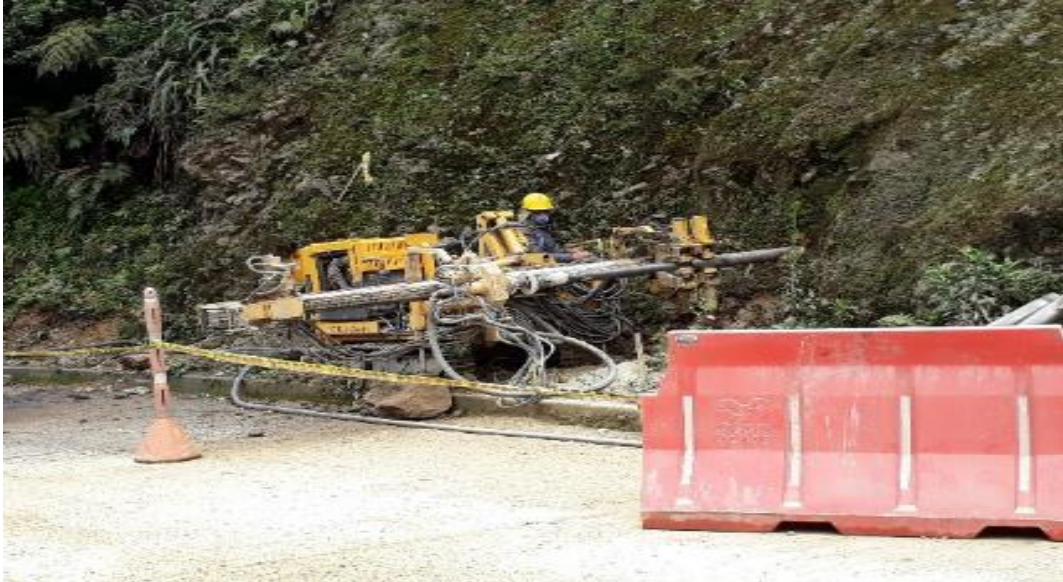
Figura 19. Detalle de la construcción de los drenes horizontales
