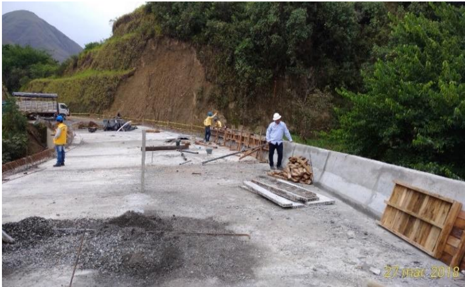
Figura 40. Construcción de la barrera tipo new jersey, PR 79+450 Puerto Valencia - Juntas Ruta 3701
