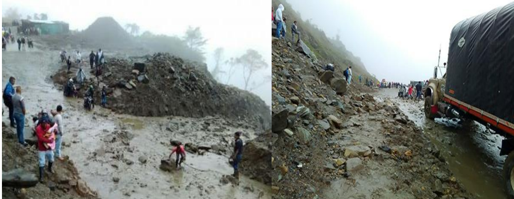
Figura 25. Detalle del paso vehicular en el sector de Córdoba en el PR 70+600
