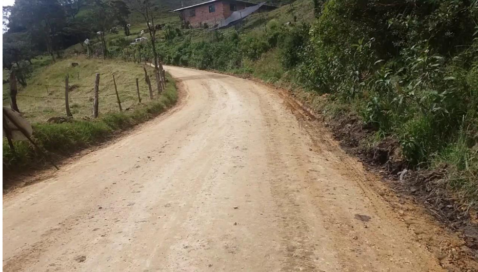
Figura 48. Detalle de la nivelación de la ruta 26CC07 PR 35
