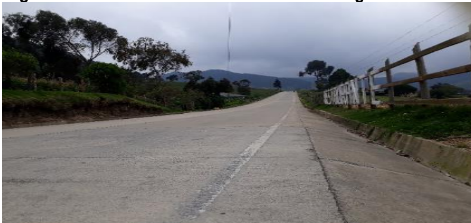
Figura 9. Detalle de la Ruta 2602 Pavimento Rígido PR 42+000
