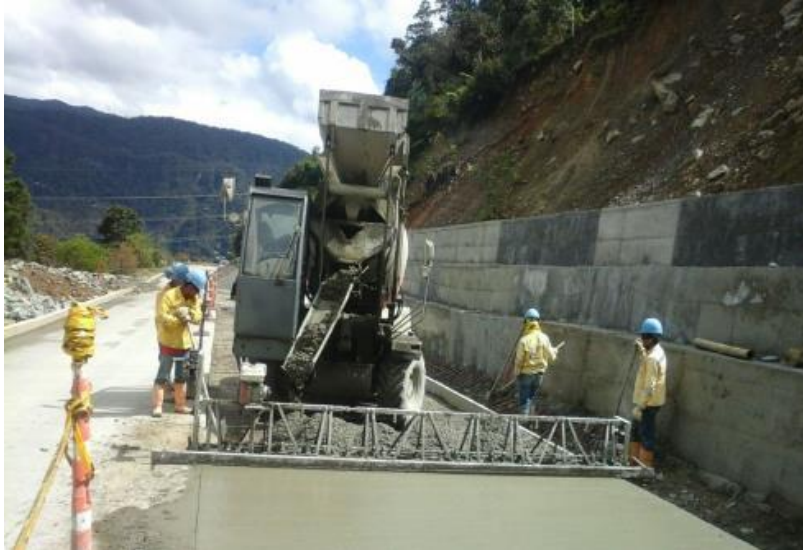
Figura 37. Instalación concreto hidráulico tramo Córdoba – Guanacas ruta 2602
