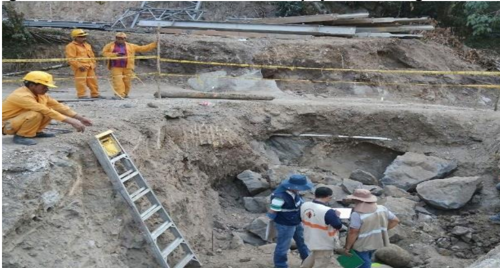
Figura 66. Detalle de la excavación del apoyo de la margen derecha.
