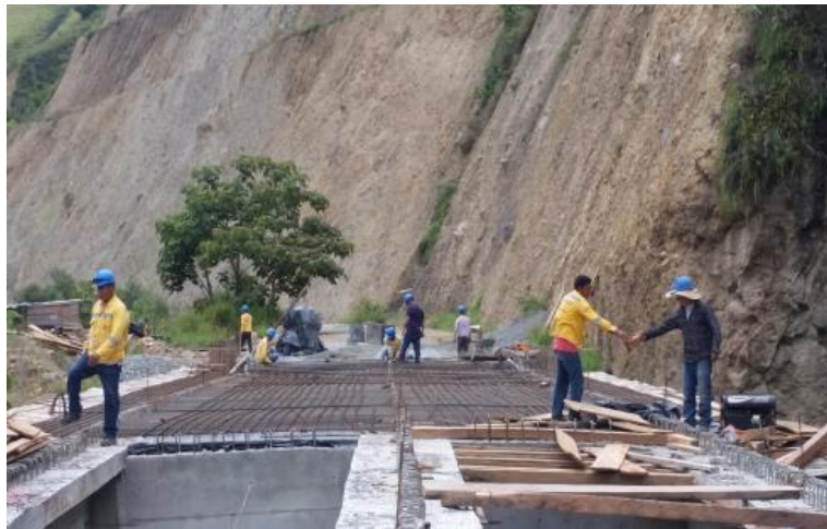
Figura 42. Encofrado y amarre acero losa superior puente N° 19 Puerto valencia – Juntas ruta 3701
