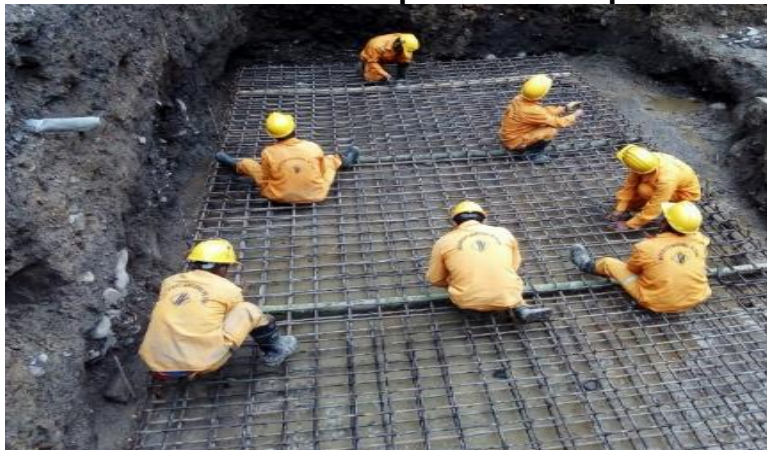
Figura 59 Detalle de armado de parrilla doble para losa inferior
