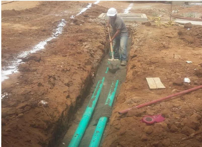
Ilustración 34. Capa de arena y tubería conduit. Fuente propia.
