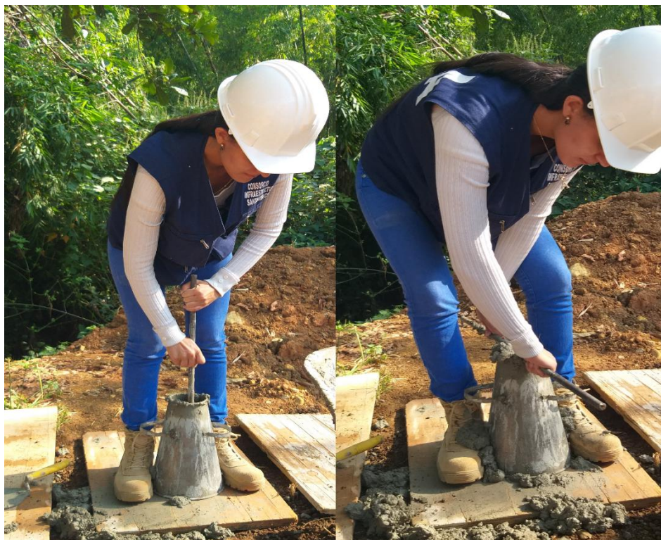
Ilustración 27. Elaboración prueba de asentamiento (slump). Fuente propia.
