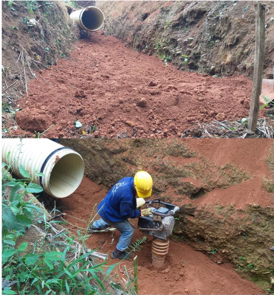
Ilustración 14. Relleno y compactación Fuente propia.
