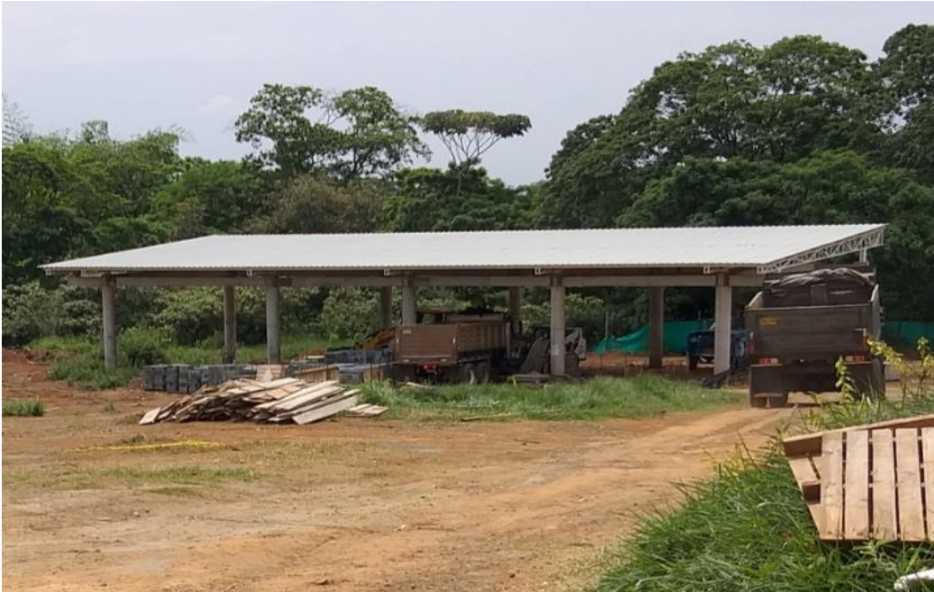
Ilustración 5. Portería acceso vehicular y peatonal Fuente propia.
