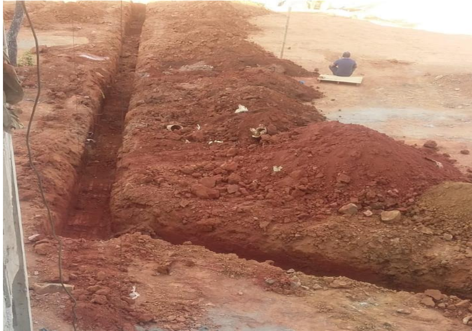
Ilustración 33. Zanja de 0.6 x 0.7 m para tubería eléctrica Fuente propia.
