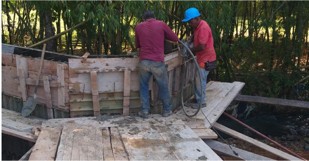
Ilustración 24. Vibrado concreto de las aletas Fuente propia.
