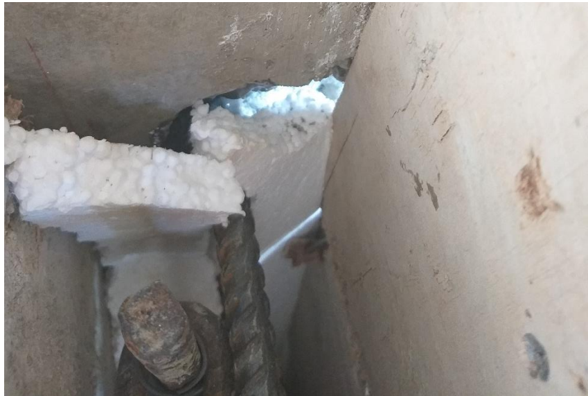
Ilustración 12. Dilatación (icopor) entre columneta y columna Fuente propia.
