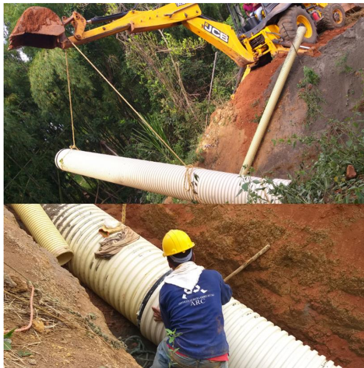
Ilustración 16. Instalación tubería pluvial de 24 pulg Fuente propia.
