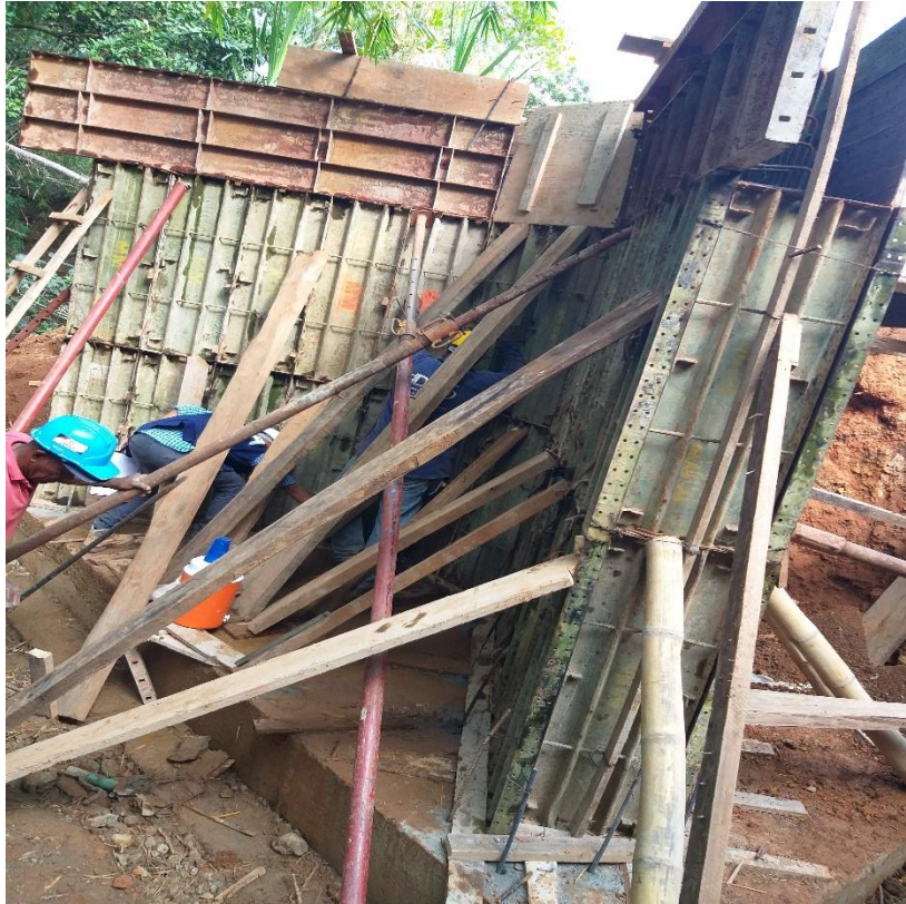
Ilustración 21. Instalación formaleta de aletas descole Fuente propia.
