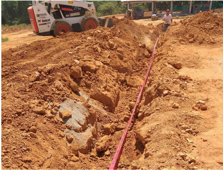
Ilustración 35. Instalación cinta peligro en relleno. Fuente propia.
