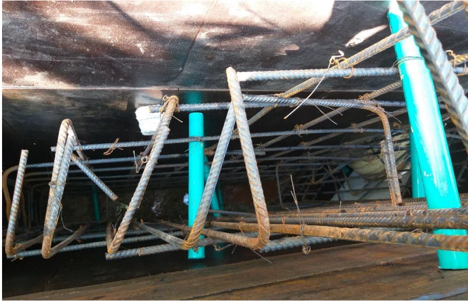
Ilustración 22. Acero refuerzo de aletas descole Fuente propia.
