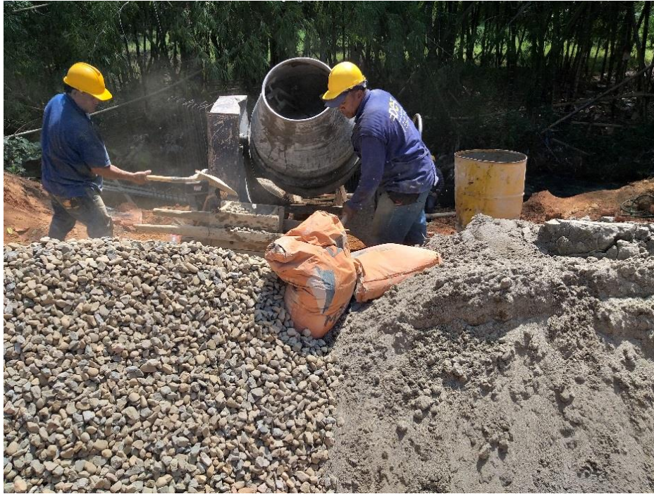
Ilustración 19. Elaboración mezcla de concreto Fuente propia.
