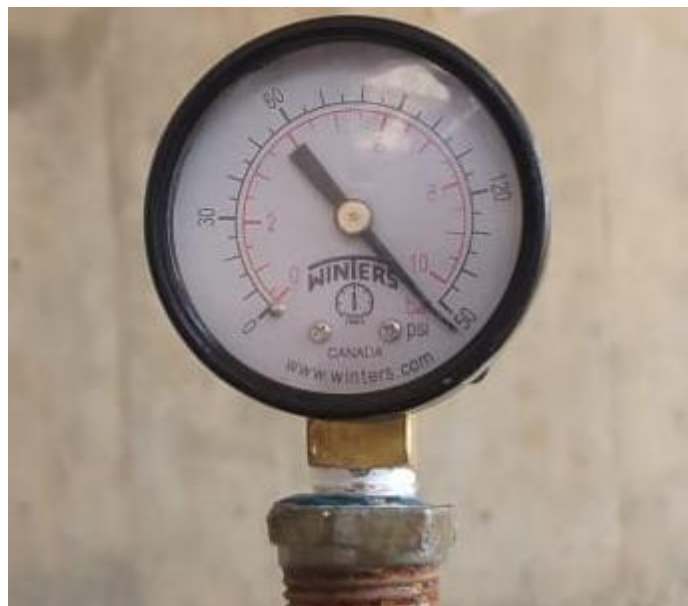
Ilustración 36. Prueba presión inicio. Fuente propia.
