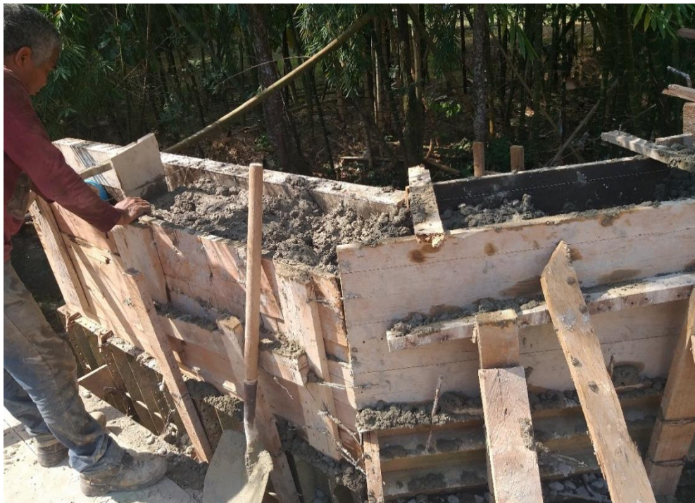
Ilustración 23. Vaciado concreto aletas descole Fuente propia.
