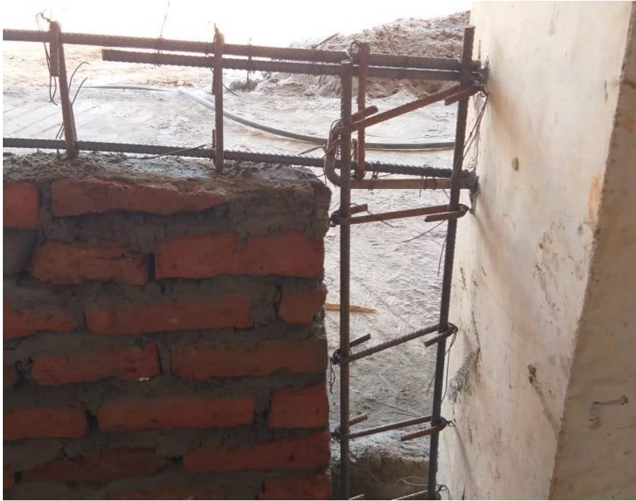
Ilustración 10. Anclajes viguetas y columnetas Fuente propia.
