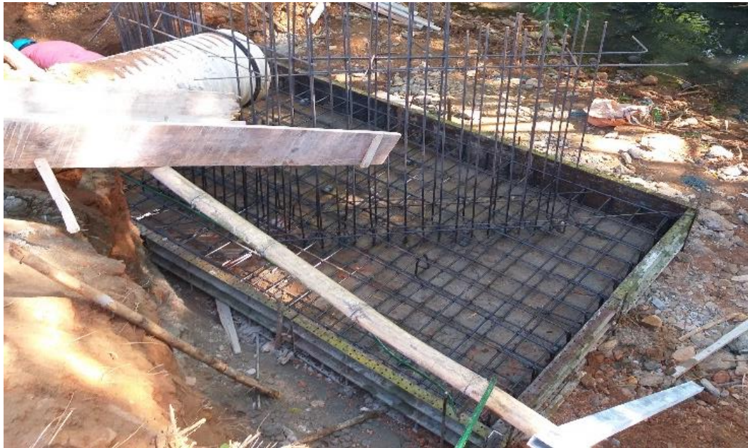
Ilustración 18. Formaleta losa de descole. Fuente propia.
