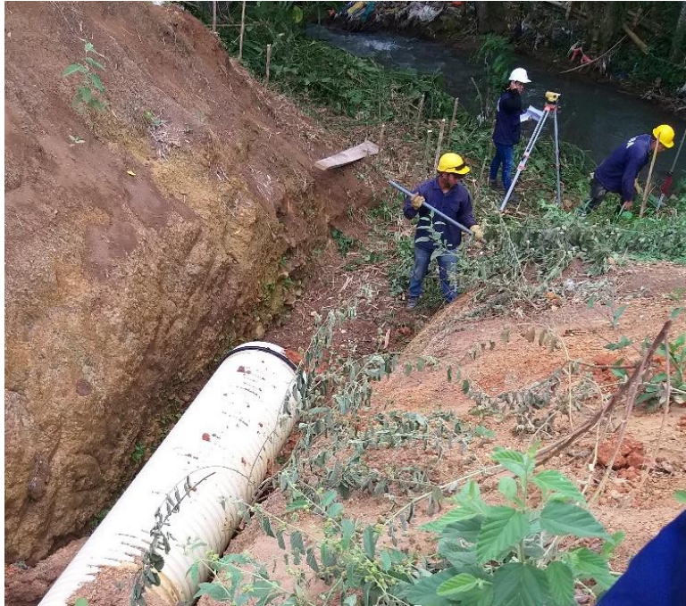
Ilustración 13. Verificación niveles tubería Fuente propia.
