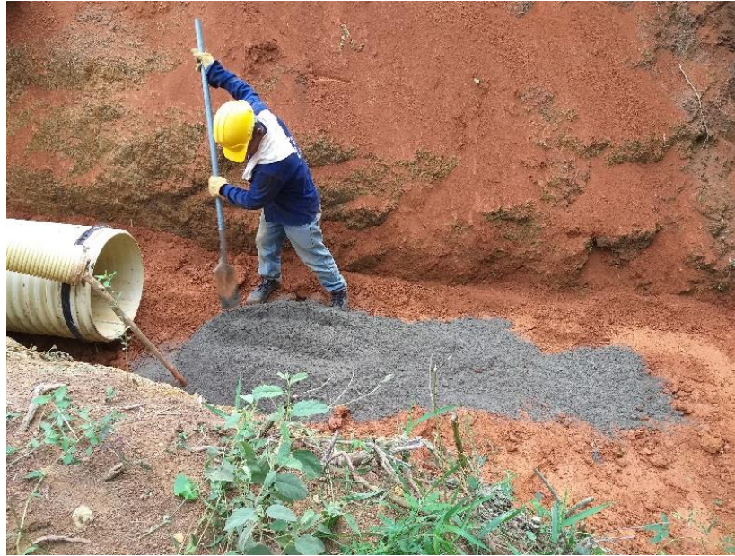
Ilustración 15. Instalación capa de arena. Fuente propia.
