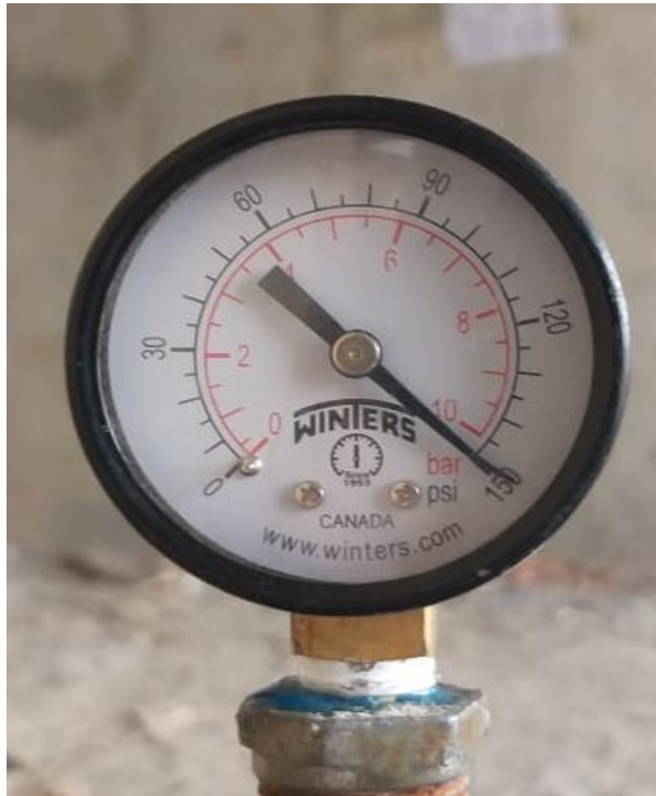
Ilustración 37. Prueba presión fin. Fuente propia.
