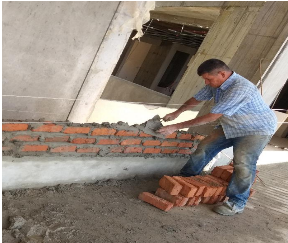
Ilustración 9. Pega de ladrillos muro rampa. Fuente propia.
