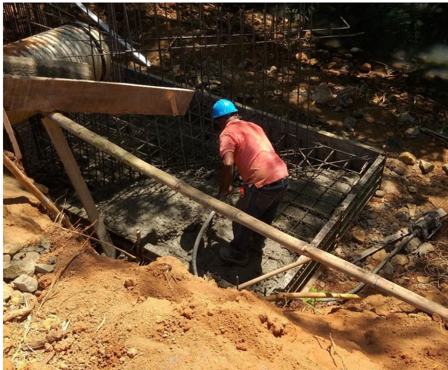
Ilustración 20. Vaciado y vibrado del concreto de la losa del descole Fuente propia.
