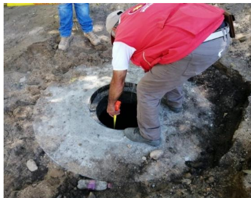
Figura 54 Cámara de inspección 1
