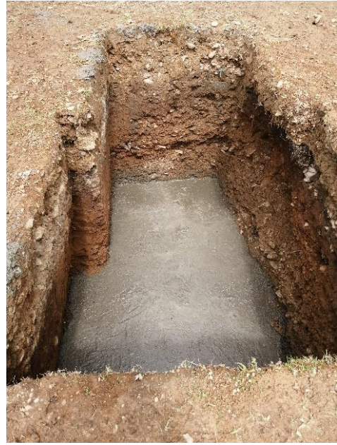
Figura 16 Solado de limpieza zapata eje 14-G.H
