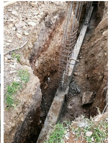
Figura 37 Encofrado pedestal
