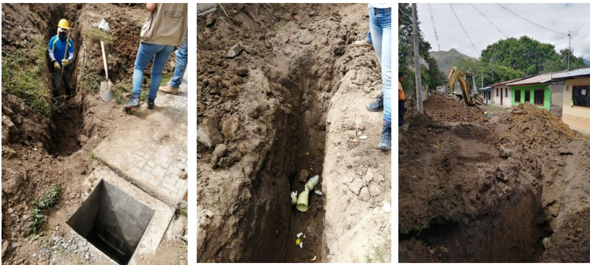
Figura 72 Excavación domiciliarias tramo 6-13
