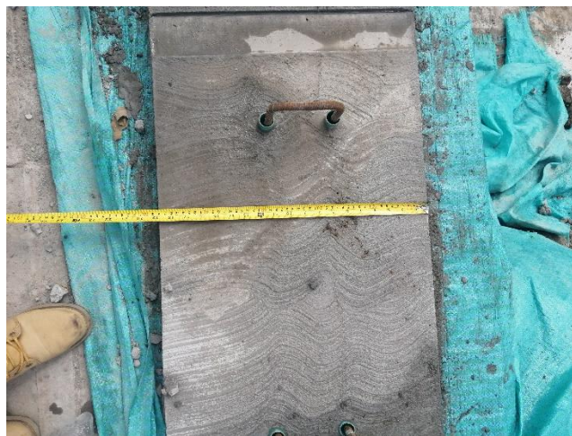
Figura 101 Medición de tapas tanque séptico y FAFA
