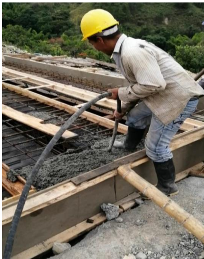
Figura 93 Vibrado del concreto
