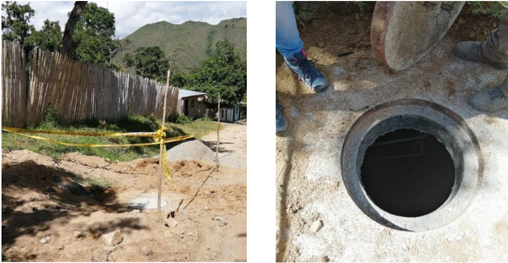
Figura 53 Cámara de inspección 2
