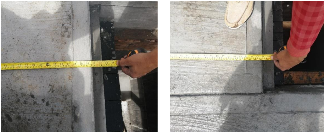
Figura 100 Medición losa superior fundida
