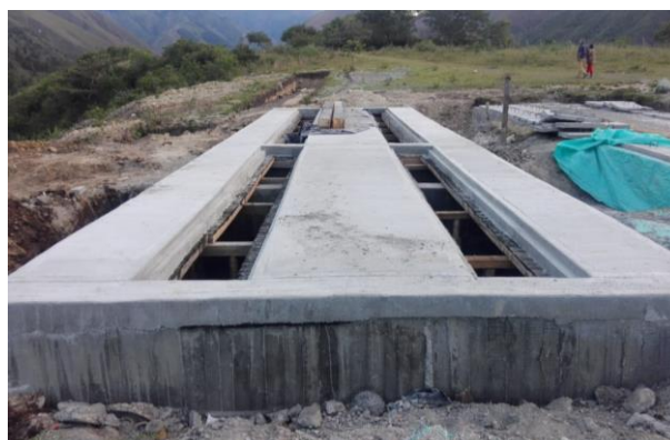
Figura 99 Losa superior tanque séptico y FAFA
