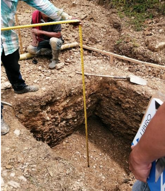
Figura 14 Excavación zapata eje 1-K
