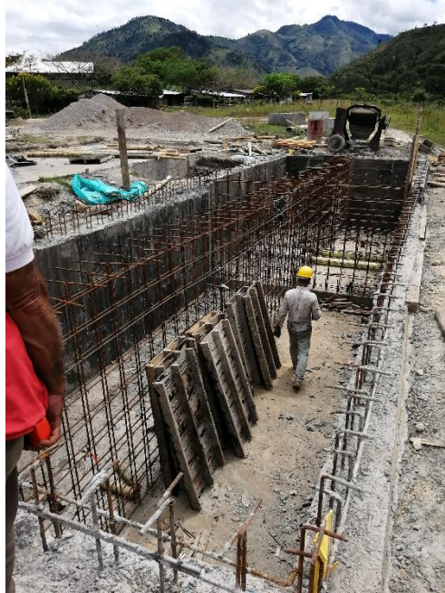
Figura 83 Muros internos tanque séptico y FAFA
