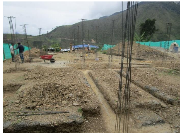
Figura 44 Solado viga de cimentación VC1
