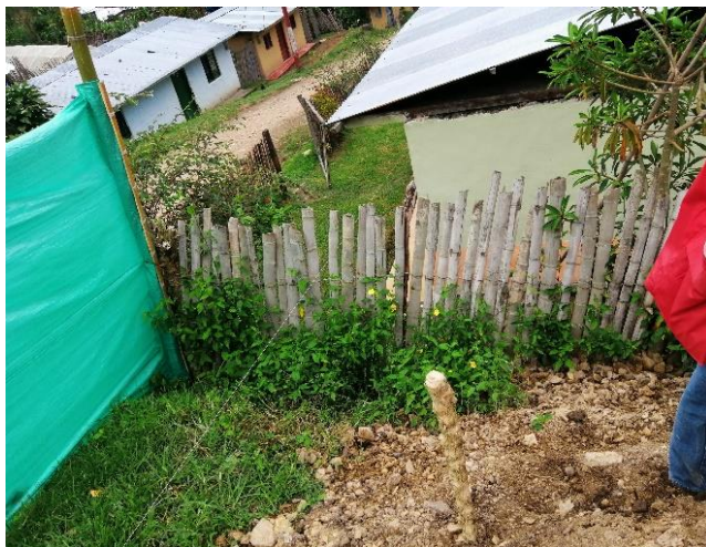
Figura 10 Punto de referencia para localización de paramento
