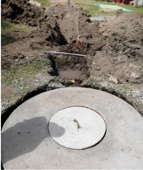
Figura 56 Cámara de inspección 7
