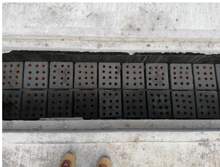
Figura 107 Instalación placas y pedestales
