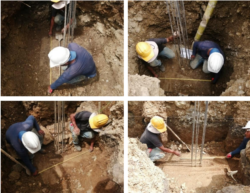
Figura 26 Chequeo medidas de zapatas
