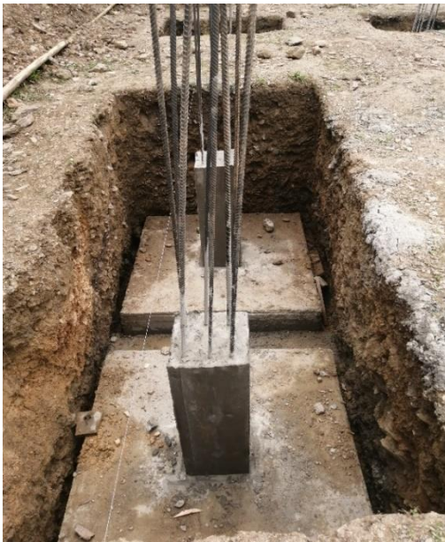
Figura 31 Zapatas fundidas eje 11-G,H
