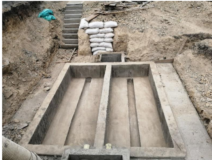
Figura 126 Gradas ingreso lechos de secado
