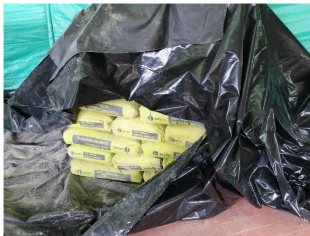
Figura 49 Almacenamiento del cemento
