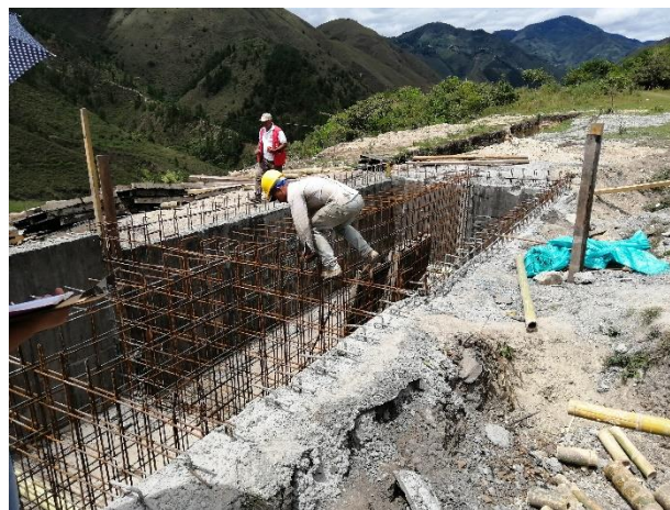
Figura 84 Acero muros internos tanque séptico y FAFA
