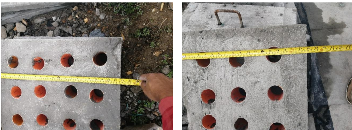
Figura 103 Placas filtro anaerobio
