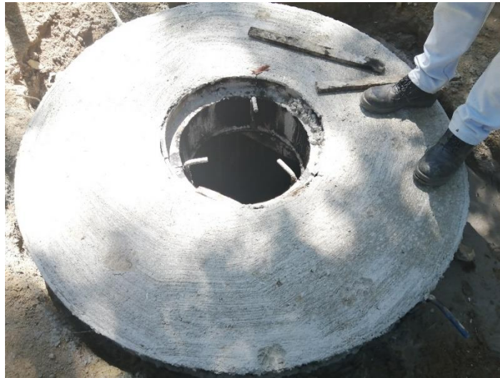
Figura 68 Cámara de inspección 0
