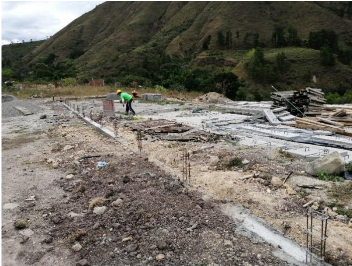
Figura 123 Viga de cimentación cerramiento
