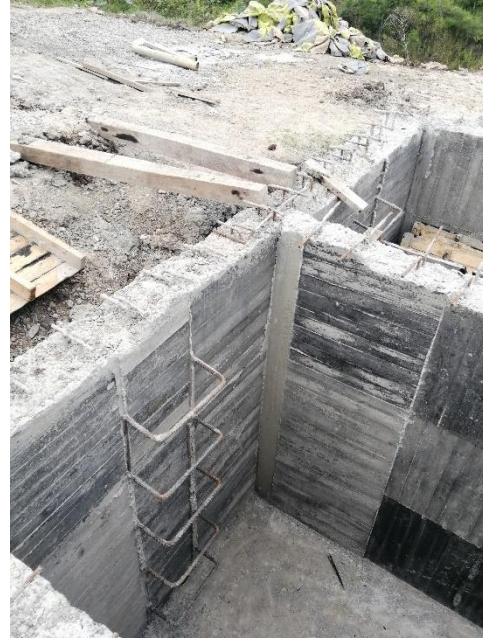
Figura 85 Muros tanque séptico y FAFA
