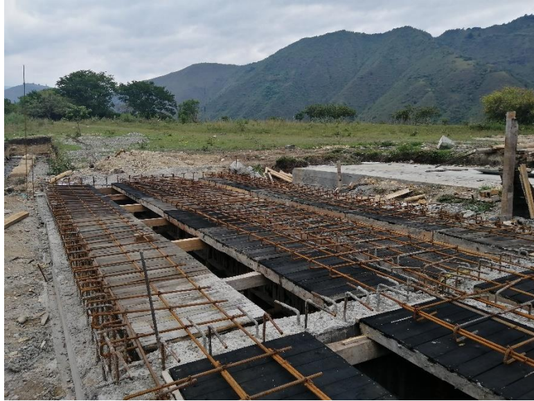
Figura 87 Encofrado losa superior
