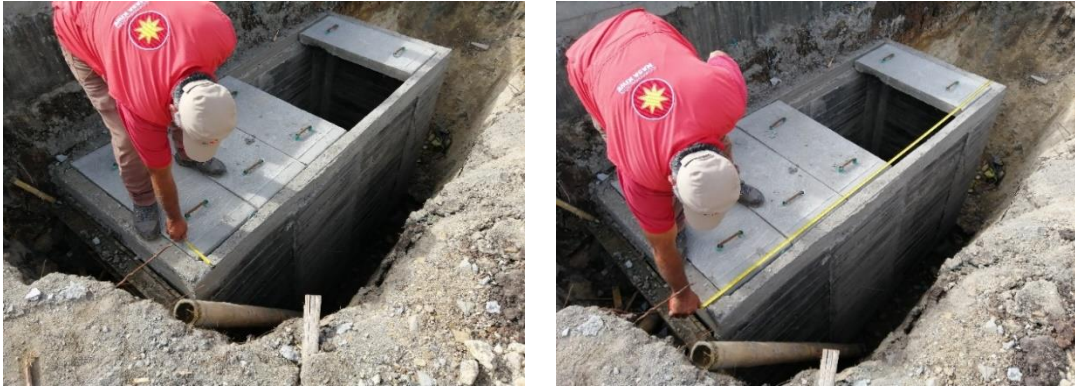
Figura 109 Revisión medidas caja de lavado
