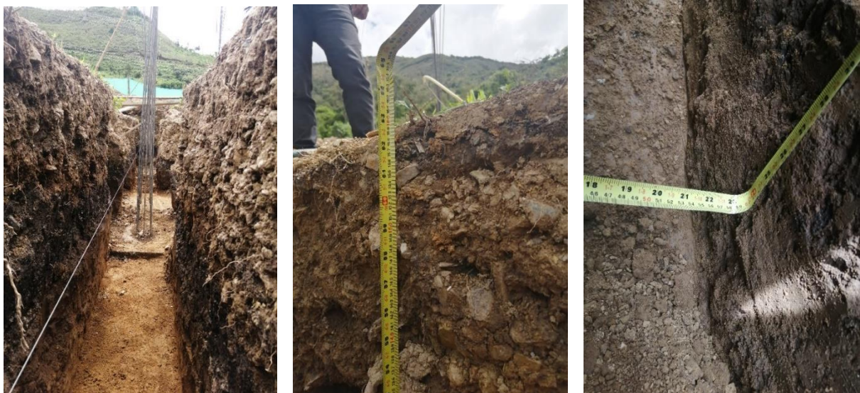
Figura 33 Excavación viga de cimentación VC3
