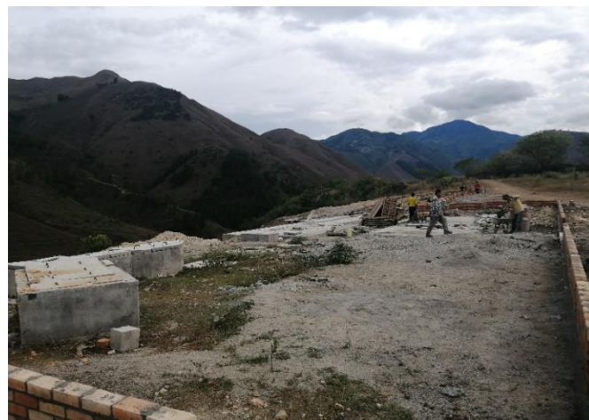
Figura 130 Estado final de la obra al terminar la pasantía
