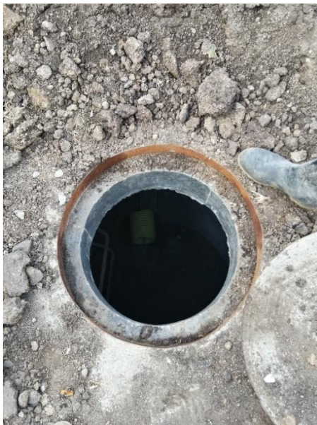
Figura 59 Cámara de inspección 4
