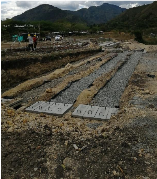
Figura 119 Biofiltro segunda fase terminados
