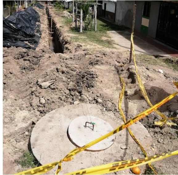
Figura 55 Cámara de inspección 8
