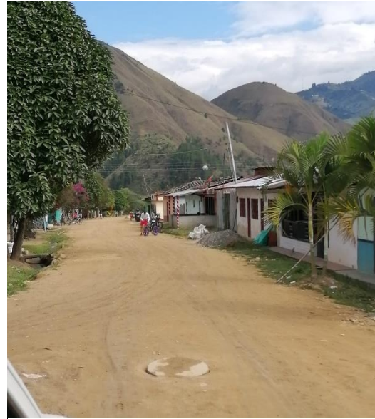
Figura 61 Tapa sin encajar cámara 20
