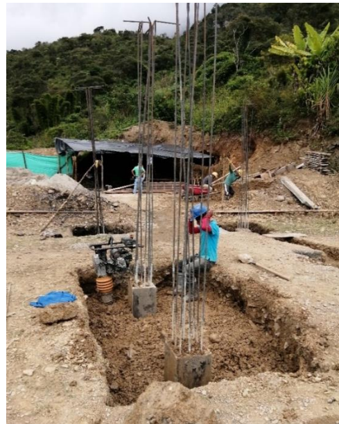
Figura 30 Zapatas fundidas eje 1-G,H
