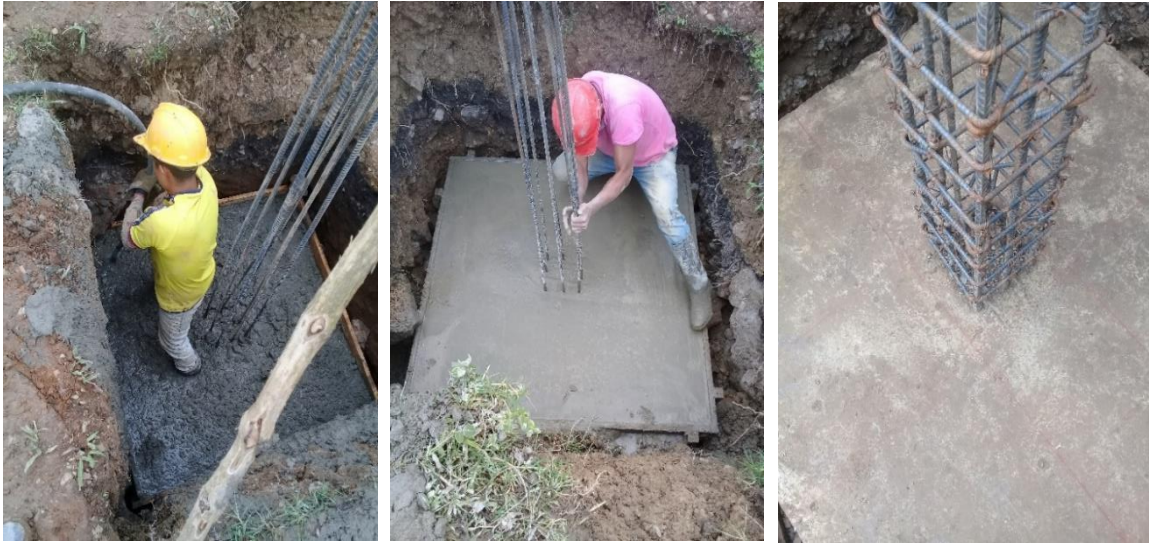
Figura 23 Fundición de zapata
