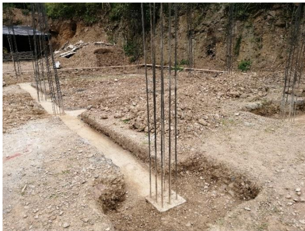
Figura 44 Solado viga de cimentación VC1
