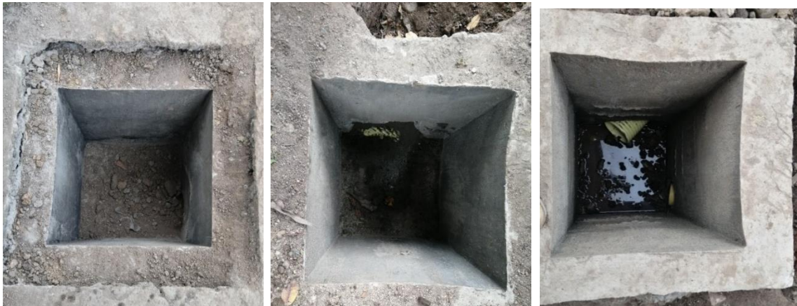
Figura 79 Cajas de inspección
