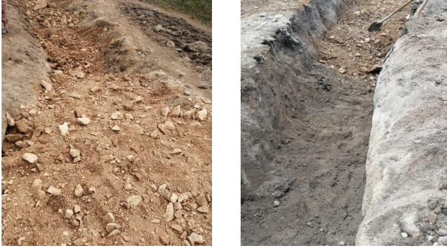
Figura 77 Material nuevo de relleno
