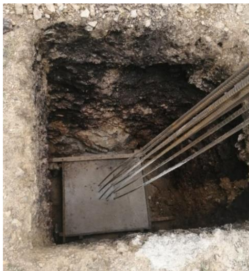
Figura 27 Zapata encofrada Z1 eje 5K
