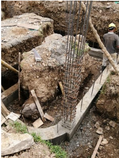
Figura 38 Castillos de acero pedestales
