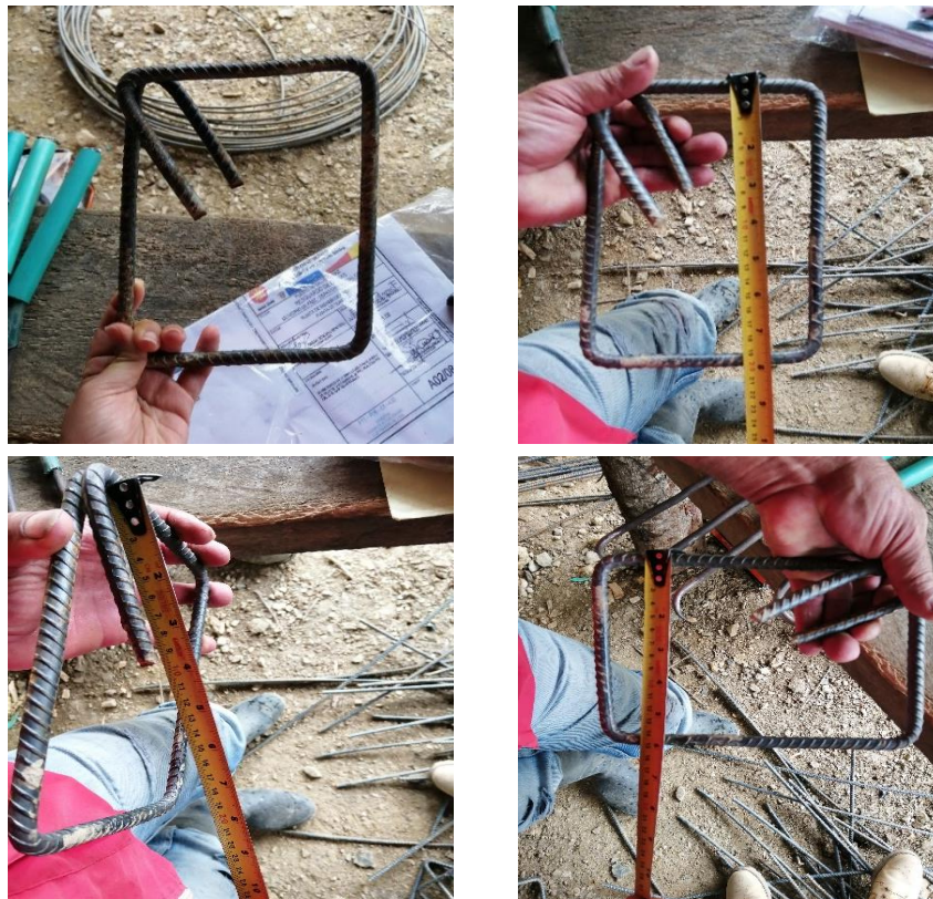
Figura 35 Flejado viga de cimentación VC3
