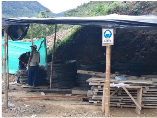
Figura 46 Acero almacenado sobrante
