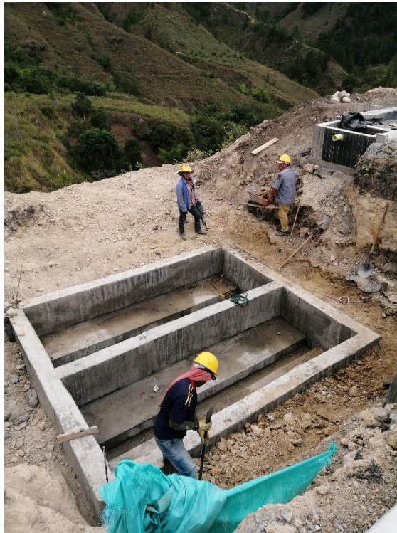
Figura 121 Lechos de secado
