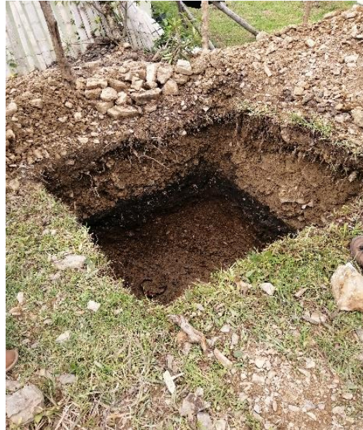
Figura 13 Excavación zapatas eje 15-F
