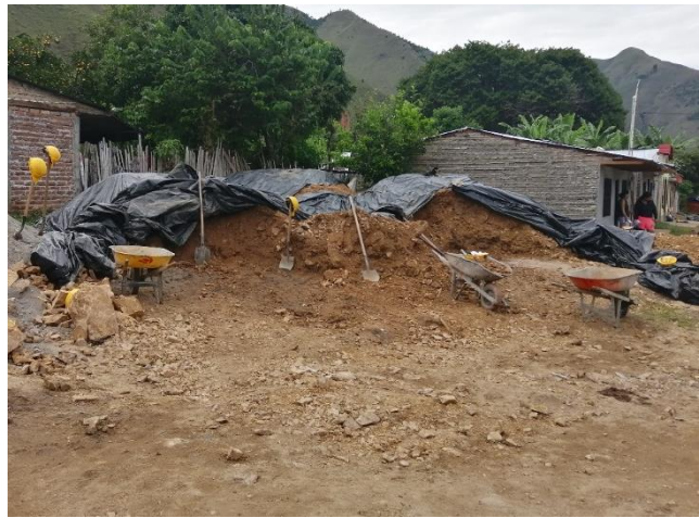
Figura 76 Material nuevo de relleno
