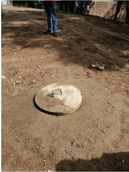
Figura 62 Tapa sin encajar cámara 3
