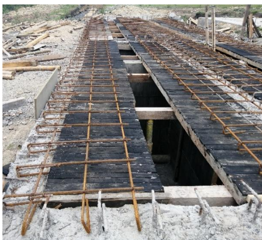
Figura 88 Acero de refuerzo losa superior
