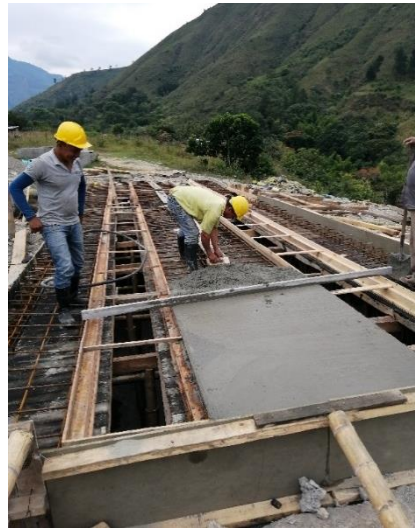
Figura 95 Nivelación y paso del codal
