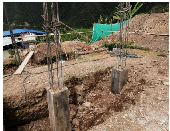
Figura 28 Zapata fundida eje 8-G,H
