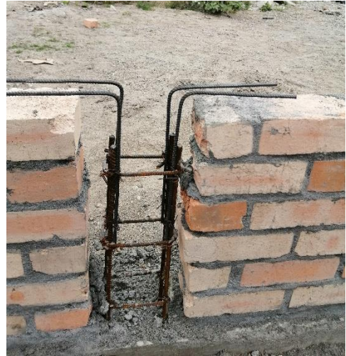
Figura 128 Castillo columneta
