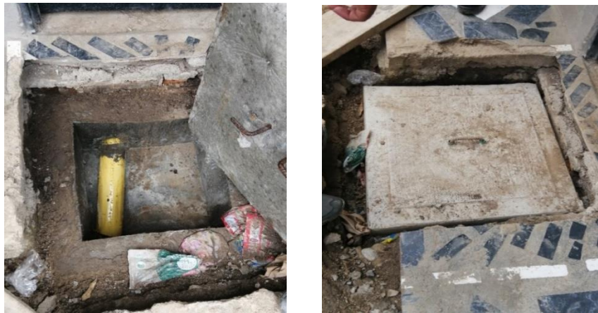
Figura 80 Caja de inspección
