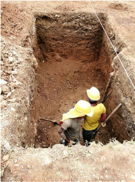
Figura 15 Excavación zapata eje 11 G-H
