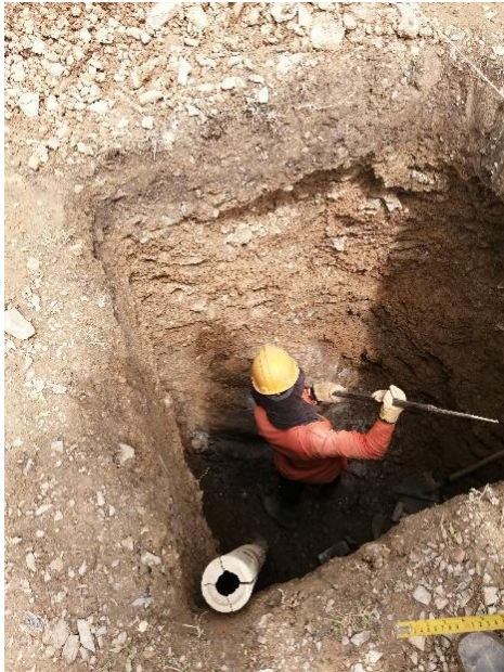
Figura 17 Excavación para zapata Z1 en el eje 5-k
