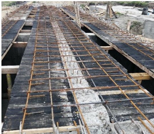
Figura 87 Encofrado losa superior
