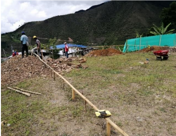
Figura 8 Localización y replanteo
