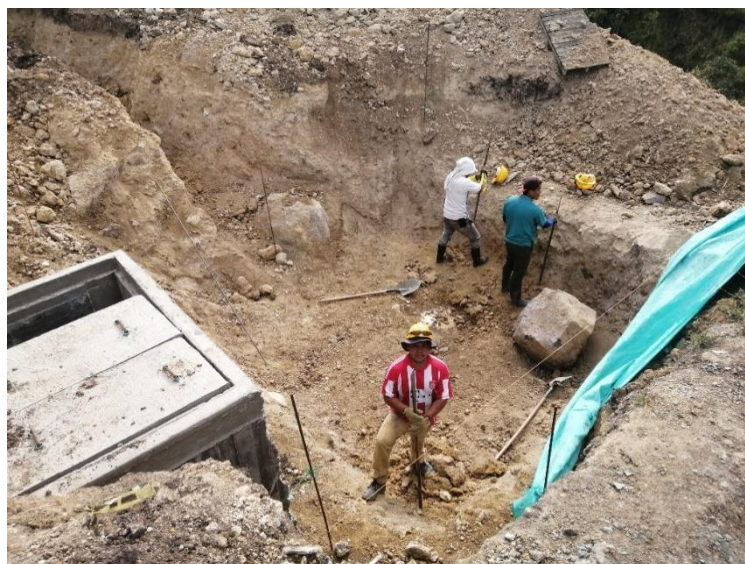
Figura 120 Excavación lechos de secado
