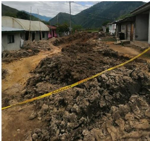
Figura 75 Material de excavación húmedo
