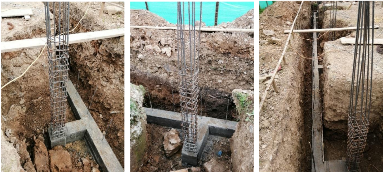
Figura 36 Viga de cimentación VC3
