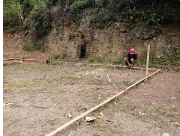
Figura 8 Localización y replanteo
