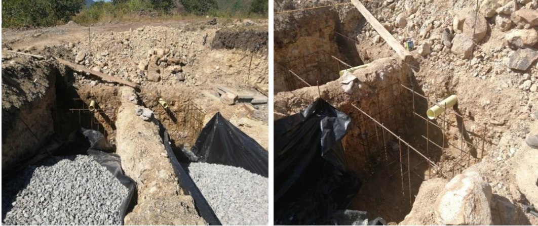
Figura 116 Armado cajas de salida biofiltro
