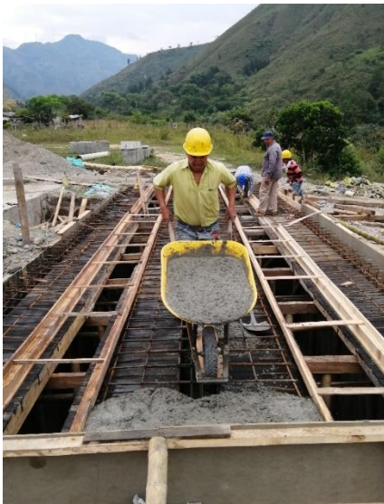
Figura 94 Transporte y colocación de la mezcla de concreto
