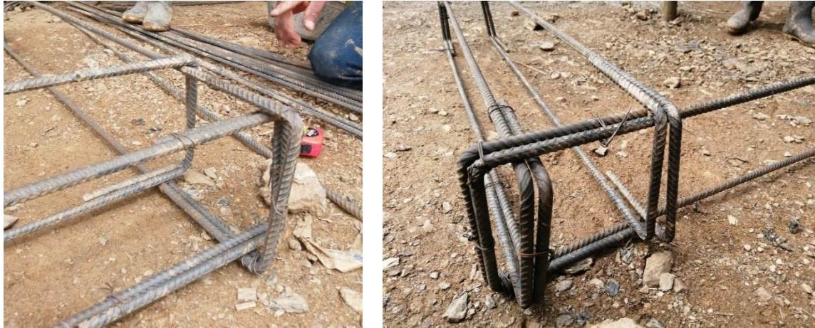
Figura 20 Armado de aceros zapata Z5
