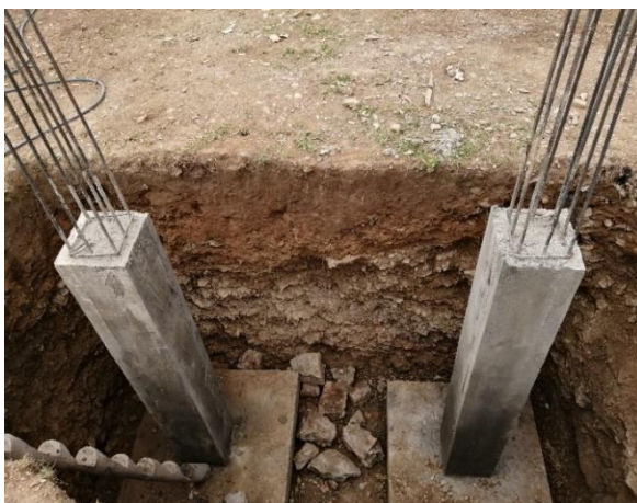
Figura 29 Compactación relleno de zapatas eje 5
