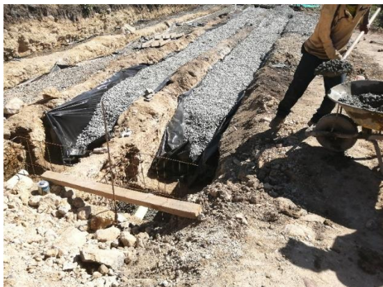
Figura 115 Excavación para biofiltros
