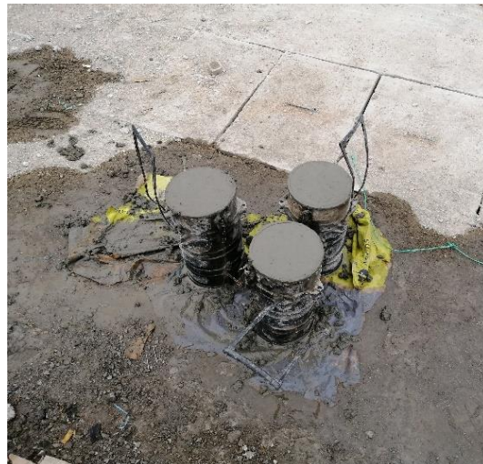
Figura 97 Cilindros para ensayo resistencia a la compresión
