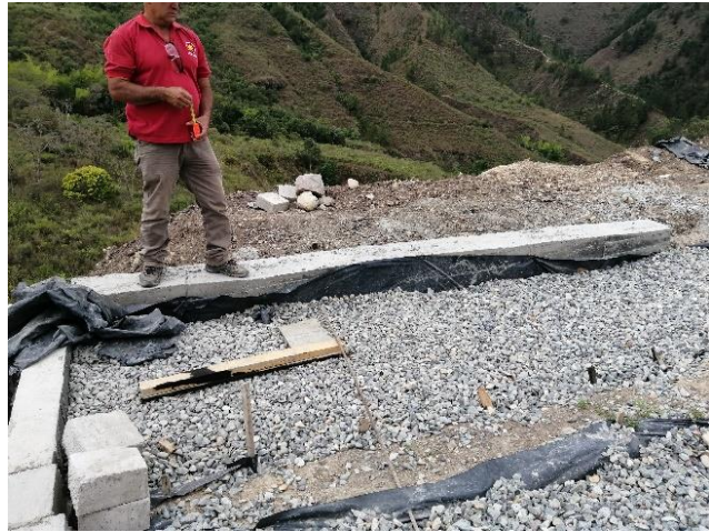
Figura 118 Muro de contención-biofiltro
