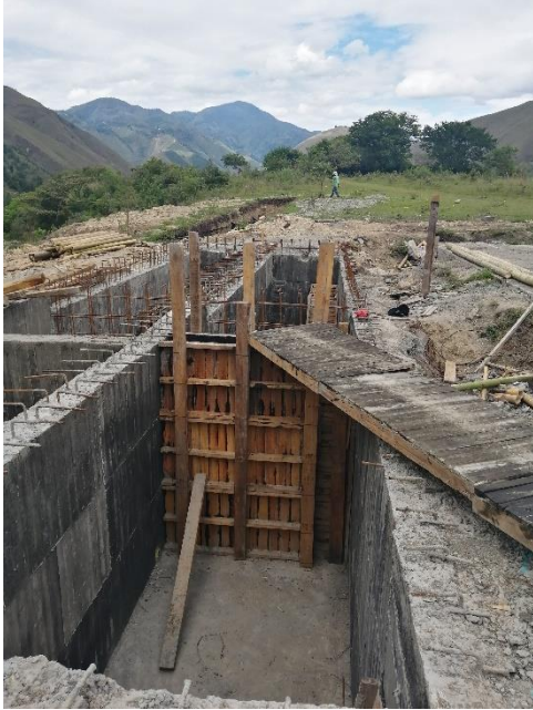
Figura 86 Encofrado muro interno PTAR
