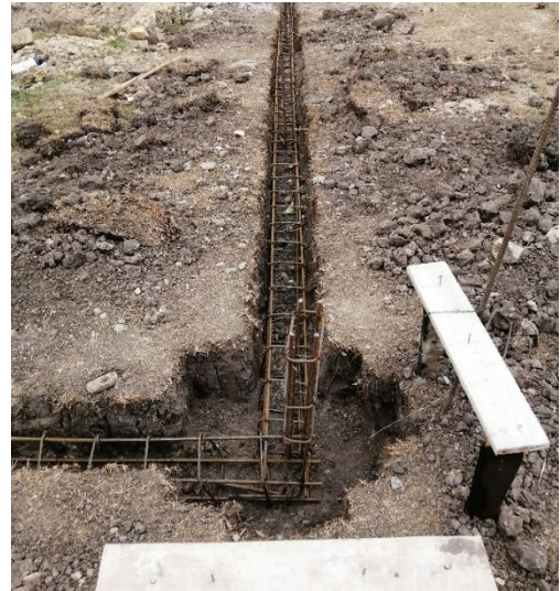
Figura 122 Castillos viga de cimentación y columnetas
