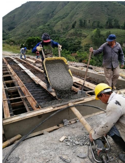
Figura 94 Transporte y colocación de la mezcla de concreto
