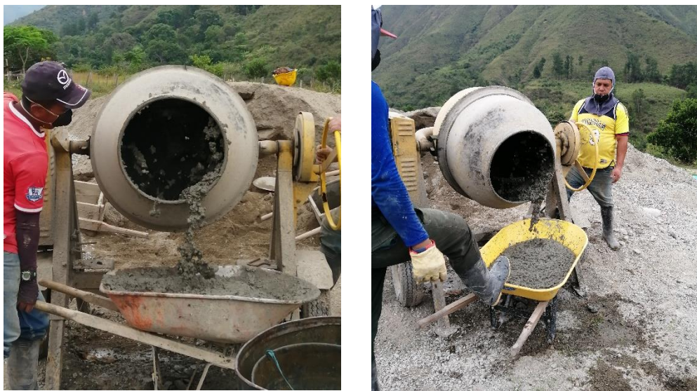
Figura 91 Preparación mezcla de concreto de 4000PSI
