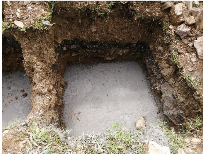
Figura 18 Solado de limpieza zapata eje A-14,15
