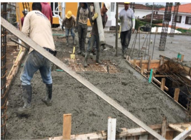
Figura 11. Expansión y vibrado del concreto en la losa.
