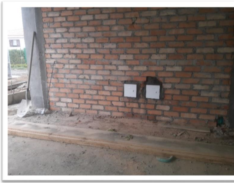
Figura 30. Instalación de las cajas de paso.
