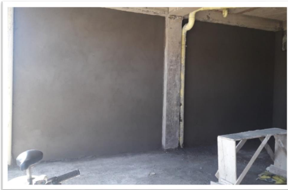
Figura 37. Muro repellado totalmente.
