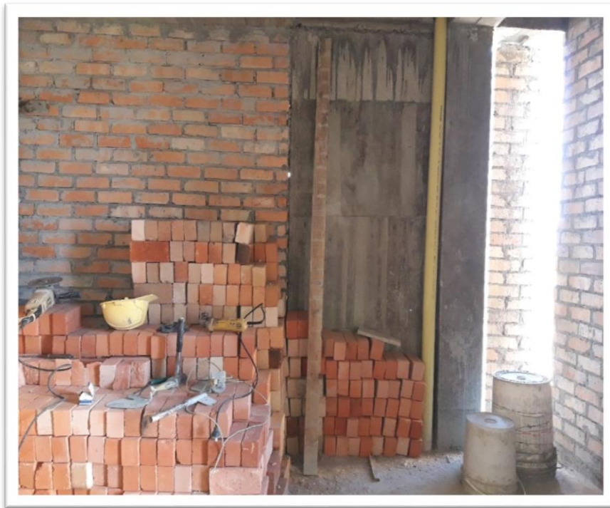
Figura 27. Tubería hidráulica y sanitaria instalada.
