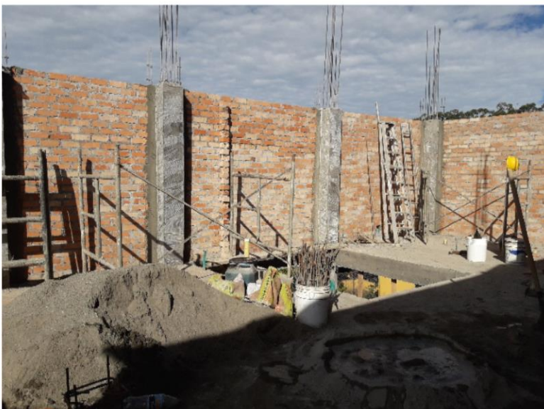
Figura 34. Curado de las columnetas.
