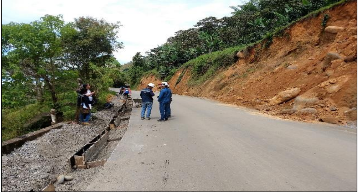
Figura 13.PR 27+015 Construcción cunetas.
