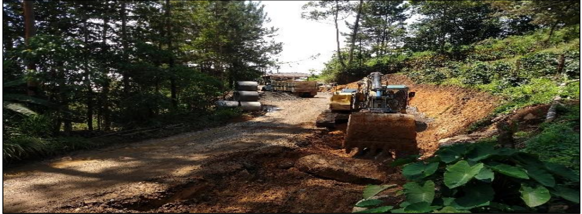
Figura 15. PR 28+632 excavación para cajeo
