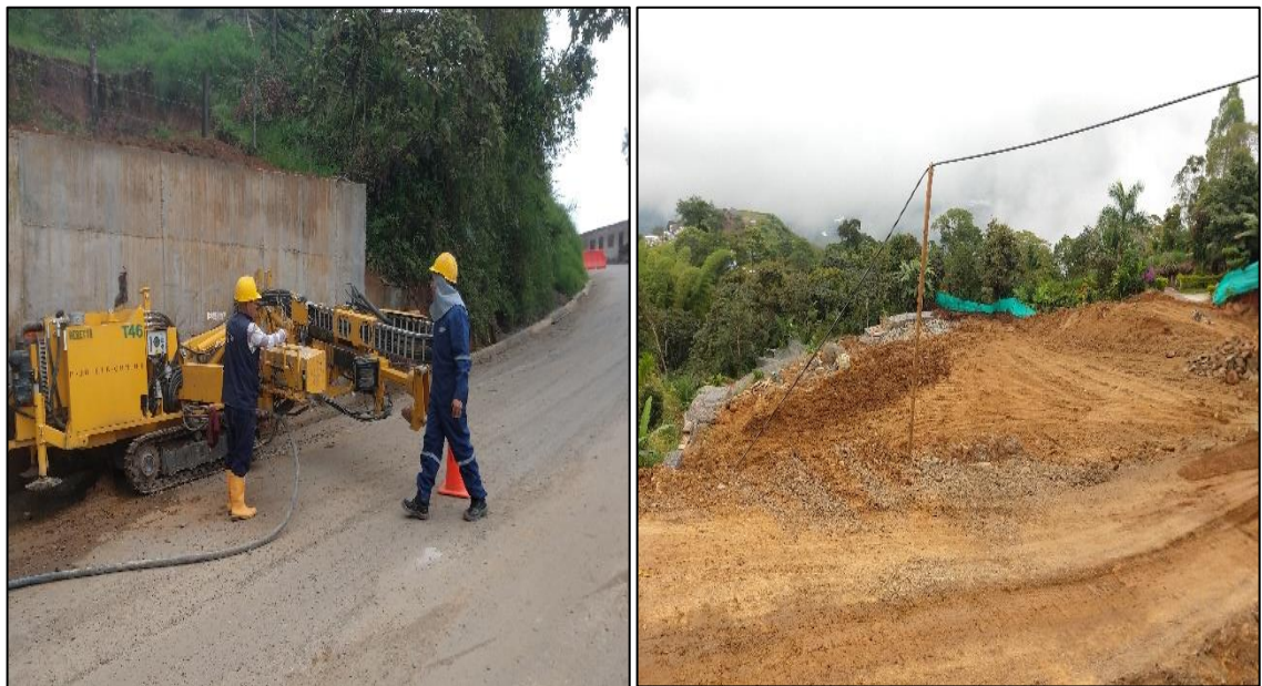
Figura 12. PR 25+590 Construcción drenes para control nivel freático y vista general ZODME Bello Horizonte
