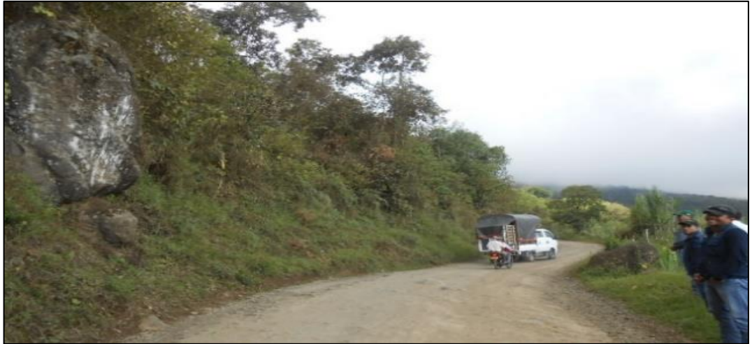
Figura 2. Condiciones iniciales de la vía
