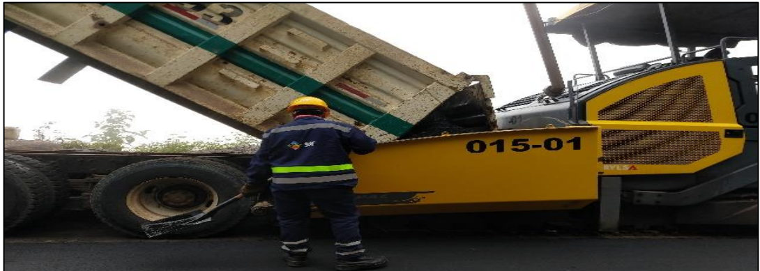
Figura 16. PR 26+020 maquinaria en funcionamiento
