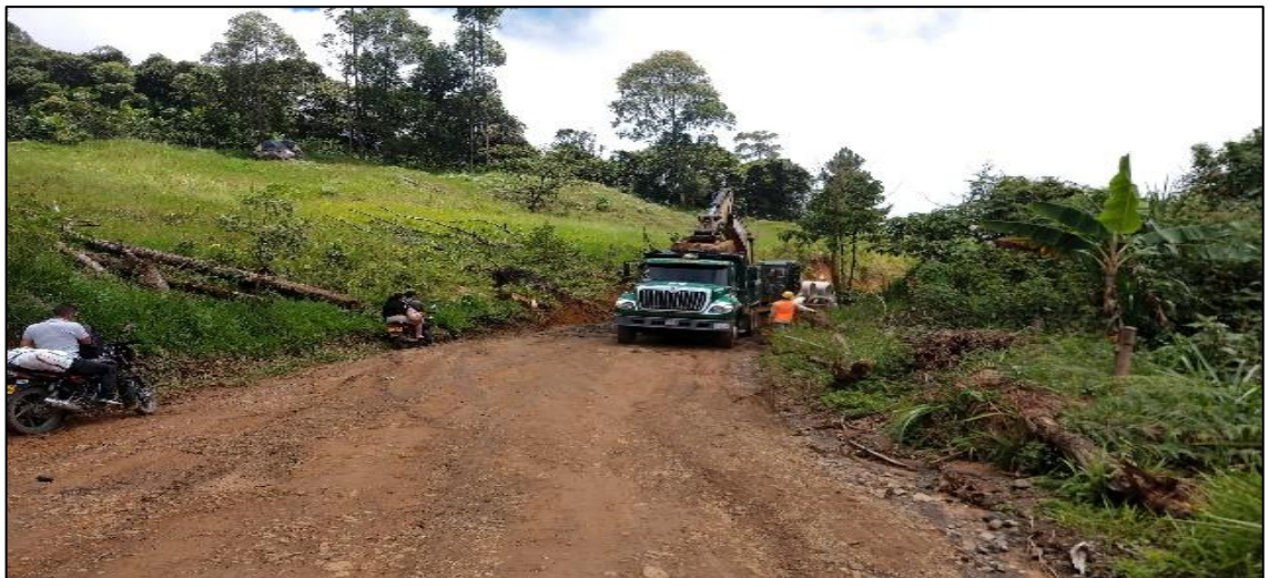
Figura 18. PR 28+400 material de excavación en vehículo
