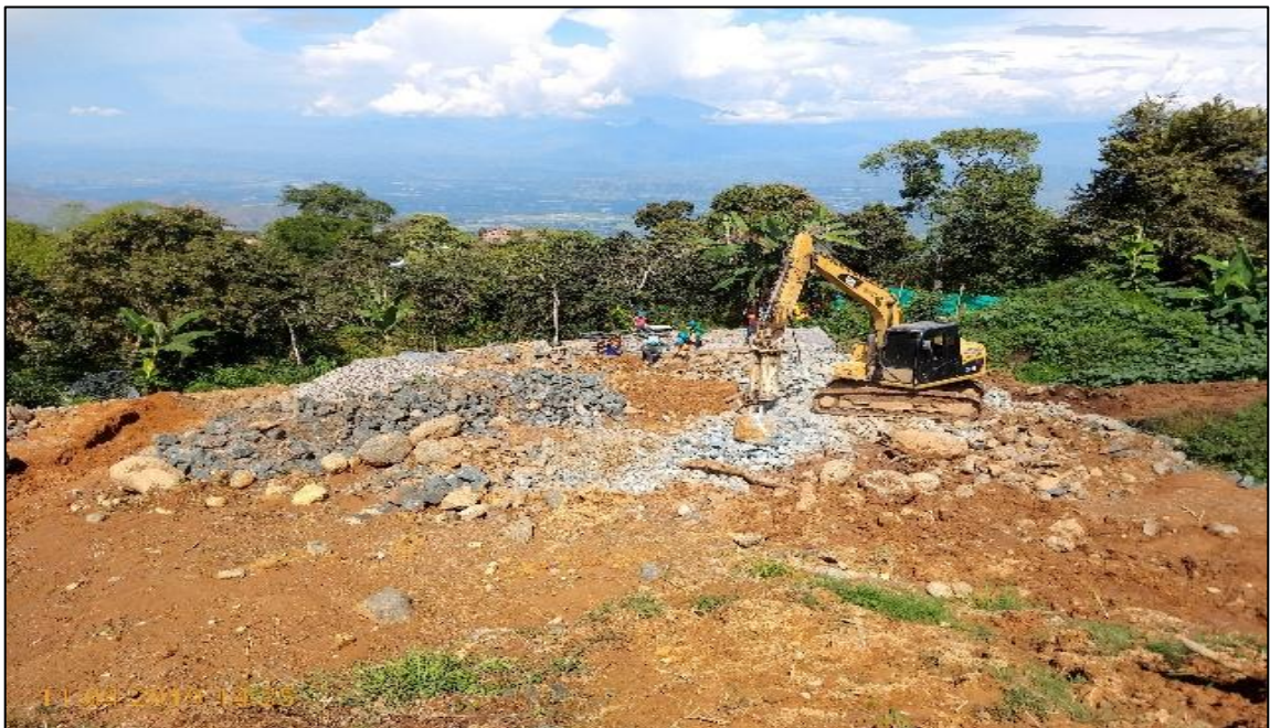
Figura 14.Zodme Bello Horizonte, demolición roca para Gavión
