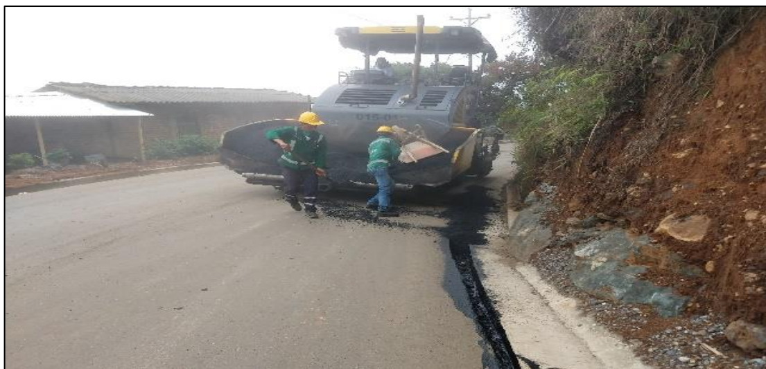
Figura 21. PR 25+980 personal de obra.
