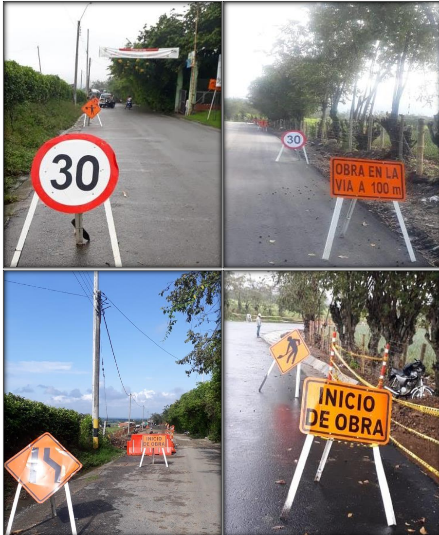
Figura 8.37. Señalización instalada por el contratista
