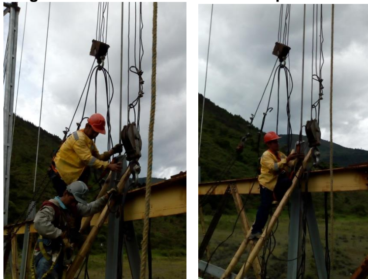
Figura 8.19. Instalación de nuevos pendolones.
