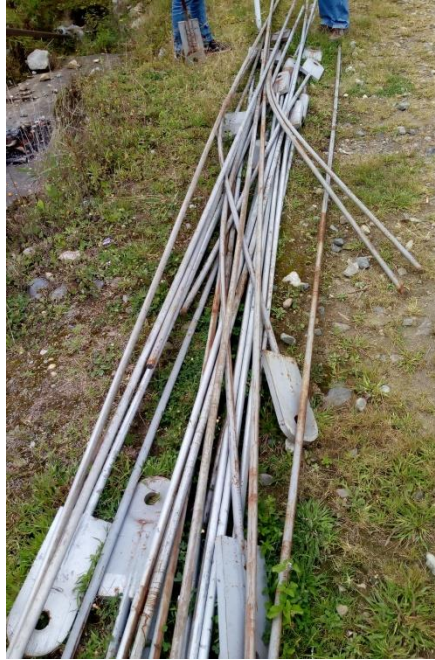
Figura 8.18. Pendolones antiguos retirados
