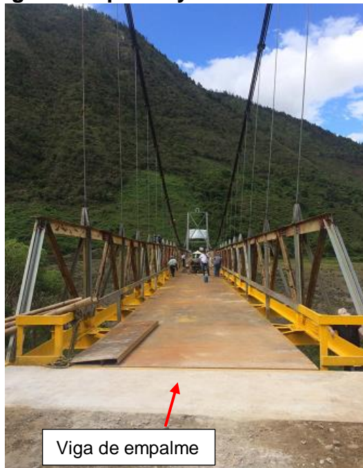
Figura 8.34. Viga de empalme y nueva vista frontal del puente.
