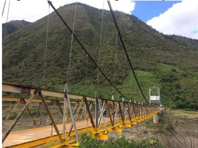
Figura 8.30. Nueva vista general de puente.
