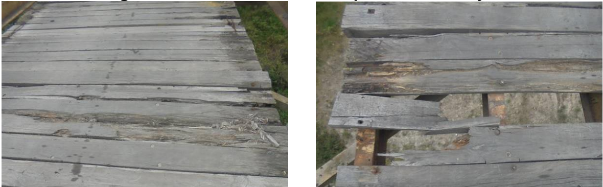
Figura 8.14. Piso en madera del puente El Naranjal.
