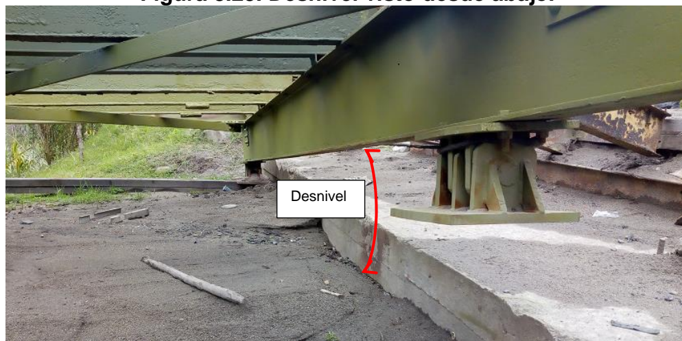
Figura 8.23. Desnivel visto desde abajo.
