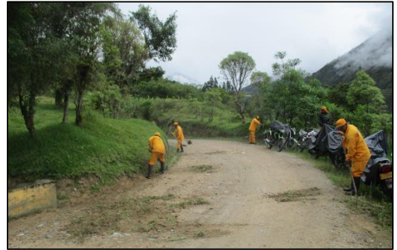
Figura 8.8. Bacheo y limpieza de cunetas en el sector del PR 70+0600 al PR 72+0800.
