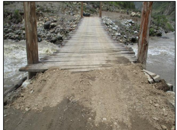
Figura 8.9. Bacheo en vía alterna y acceso al puente provisional Naranjal en el PR 74+0878.
