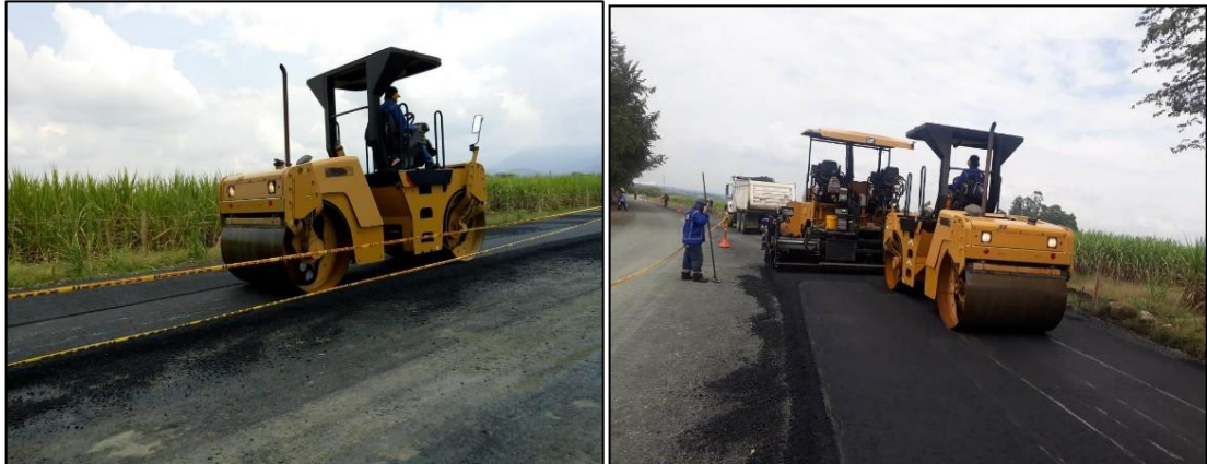
Figura 8.41. Compactación del pavimento con compactador de rodillo liso.
