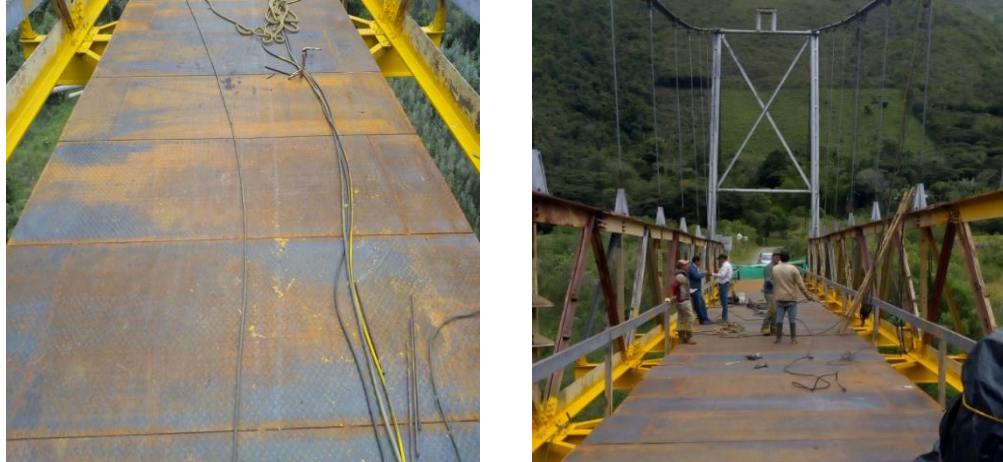
Figura 8.25. Colocación de piso metálico.
