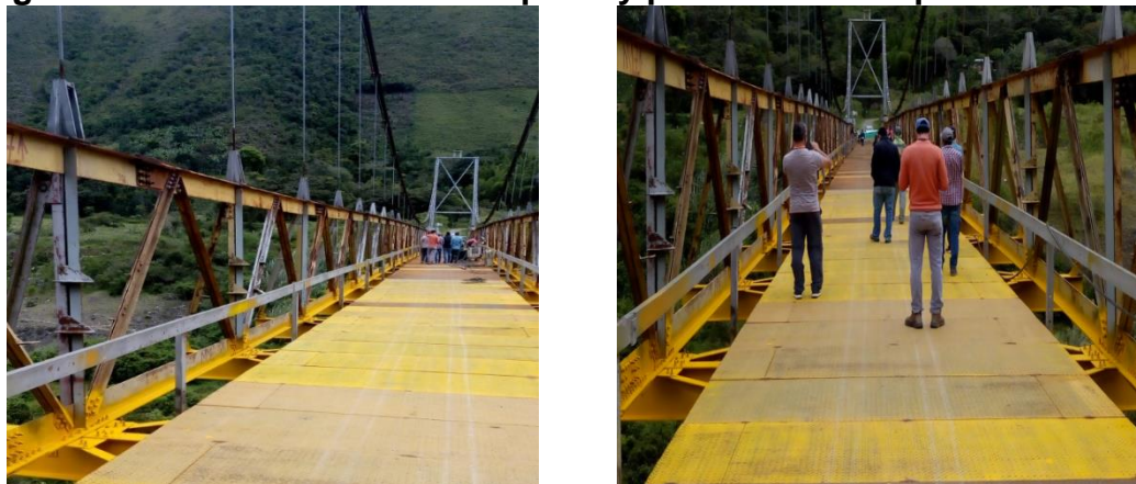
Figura 8.27. Continuación de limpieza y pintado de la superestructura.
