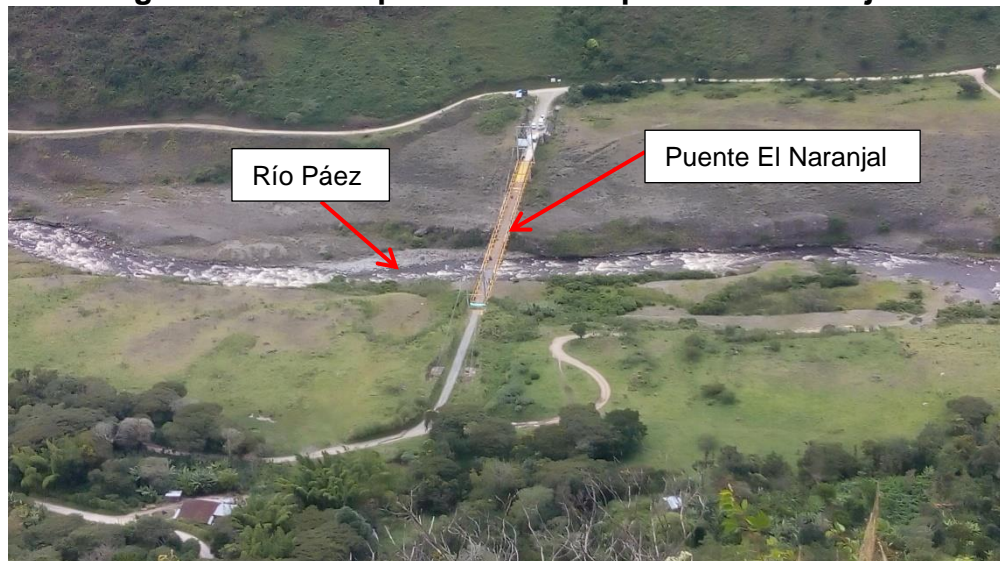
Figura 8.13. Vista panorámica del puente El Naranjal.
