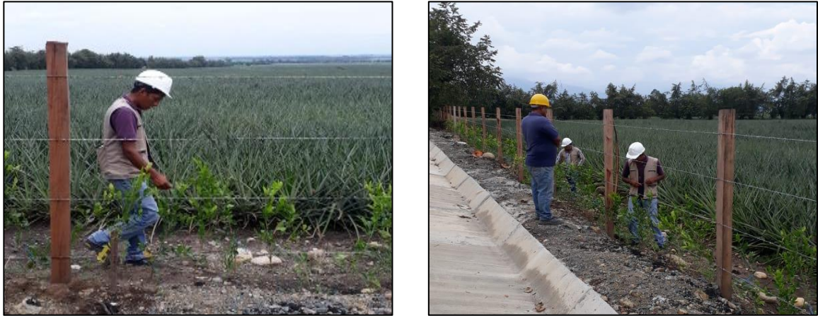
Figura 8.48. PR 0+270 al PR 0+327- MI- Instalación de Swinglea.
