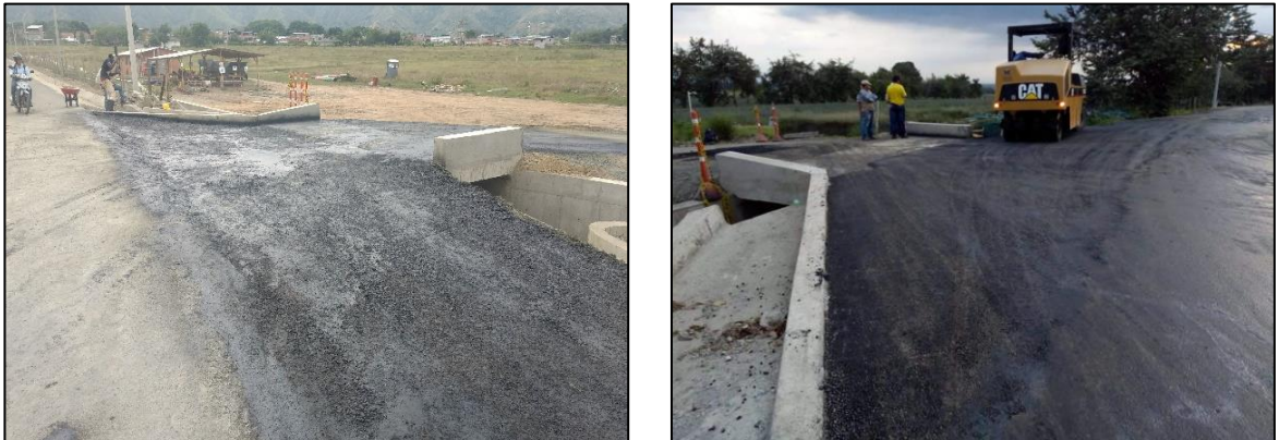
Figura 8.44. PR0+240 al PR0+247 margen izquierda adecuación de rampa de acceso a base militar.
