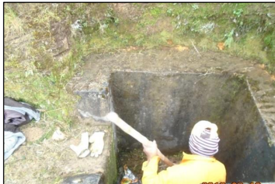
Figura 8.3. Limpieza de alcantarillas y descoles del PR 20+0000 al PR 21+0000.
