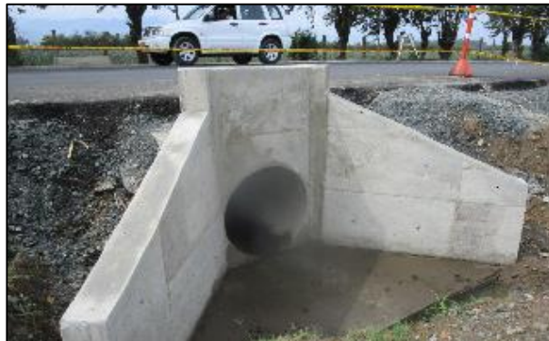
Figura 8.42. PR 0+610 Construcción de Alcantarilla - Cabezal De Salida.
