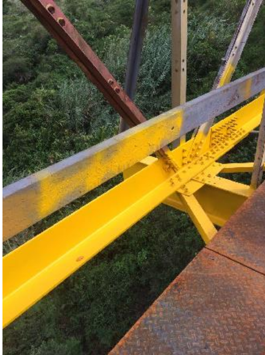
Figura 8.33. Nueva tornillería instalada y pintada.
