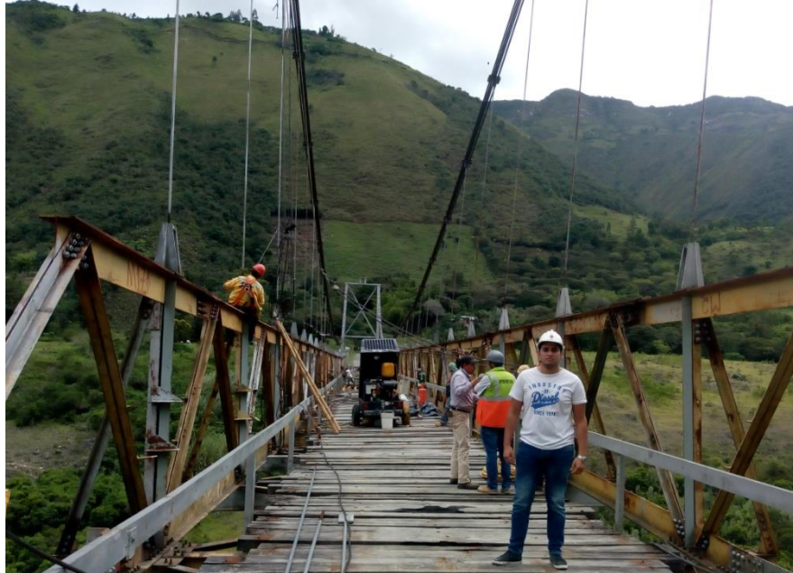
Figura 8.12. Vista de frente del puente El Naranjal.
