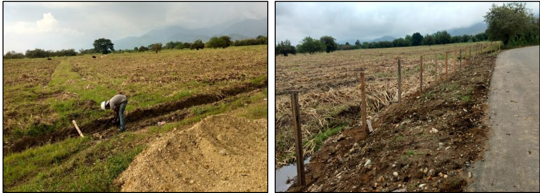
Figura 8.46. PR 0+000 al PR 0+020 Construcción de cuneta en “V”.
