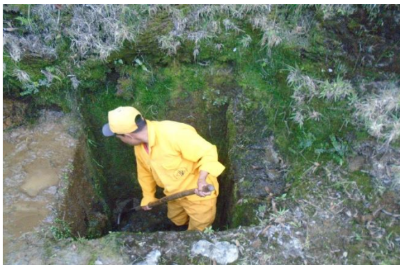
Figura 8.4. Limpieza de alcantarillas en el sector del PR 27+0000 al PR 28+0000.
