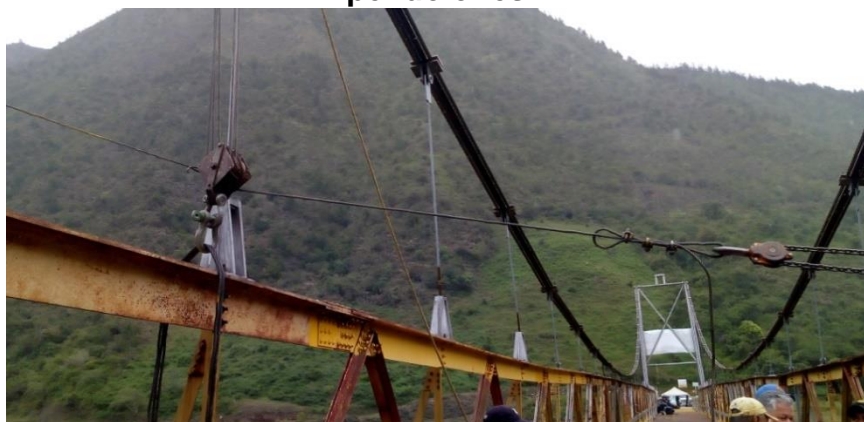
Figura 8.28. Continuación de cambio de tornillería y reparación de pendolones.
