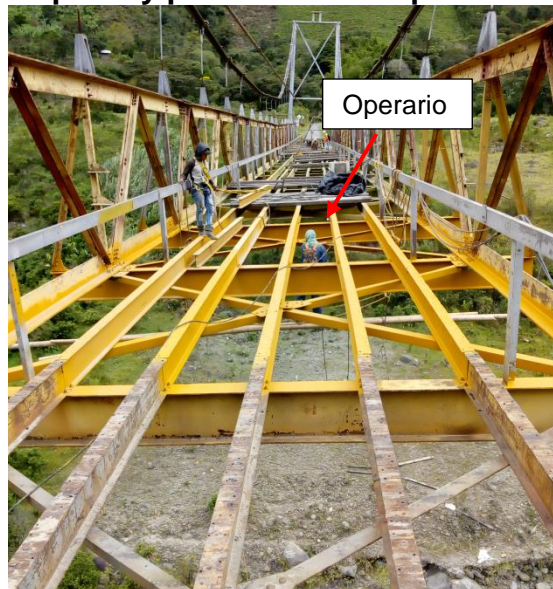
Figura 8.21. Limpieza y pintado de la superestructura metálica.
