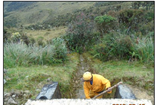
Figura 8.3. Limpieza de alcantarillas y descoles del PR 20+0000 al PR 21+0000.
