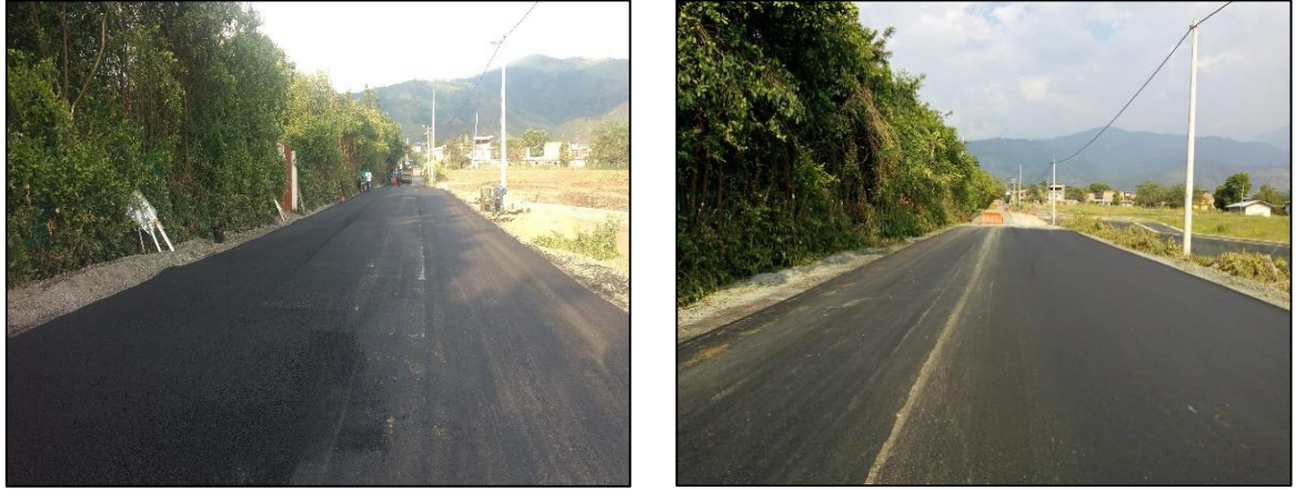
Figura 8.43. PR 0+080 al PR 0+000 instalación de mezcla asfáltica.
