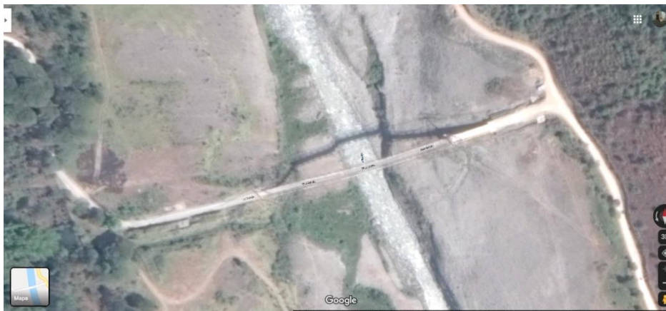
Figura 8.10. Localización del Puente El Naranjal salva el paso sobre el río Páez: PR 74+878 al PR 75+000. Ruta Tierra Cruz – Mosoco – El Naranjal en el Departamento del Cauca.
