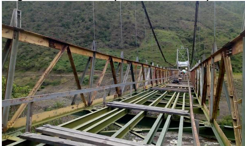
Figura 8.15. Retiro del piso en madera del puente.
