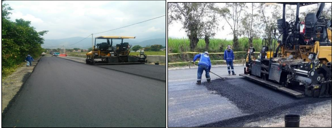
Figura 8.40. Pavimentadora en ejecución.
