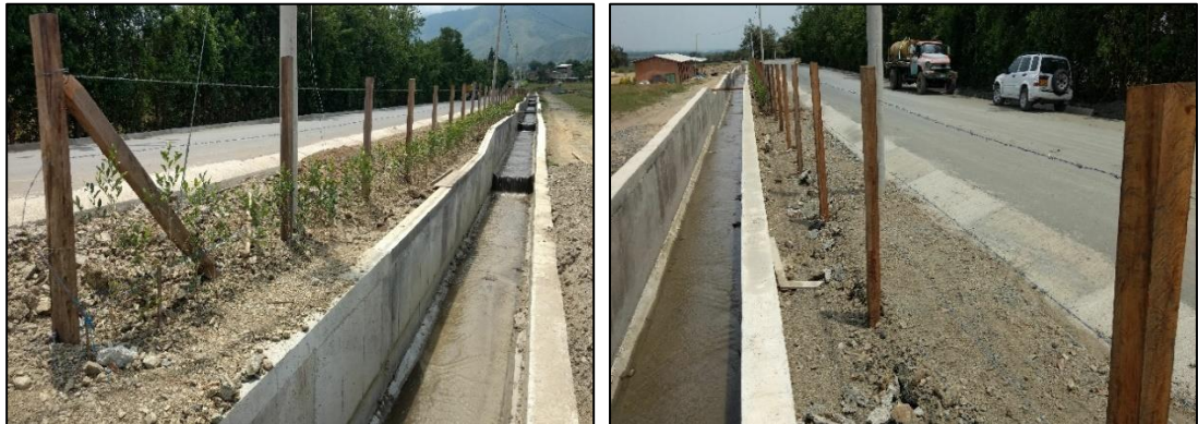
Figura 8.45. PR0+040 al PR0+150 margen izquierda-Replicación de cercas con postes de madera y siembra - Swinglea
