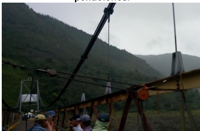
Figura 8.29. Continuación de cambio de tornillería y reparación de pendolones.
