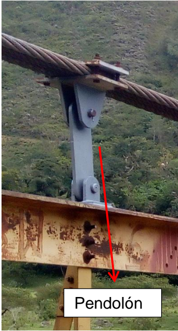
Figura 8.16. Pendolón central del puente.
