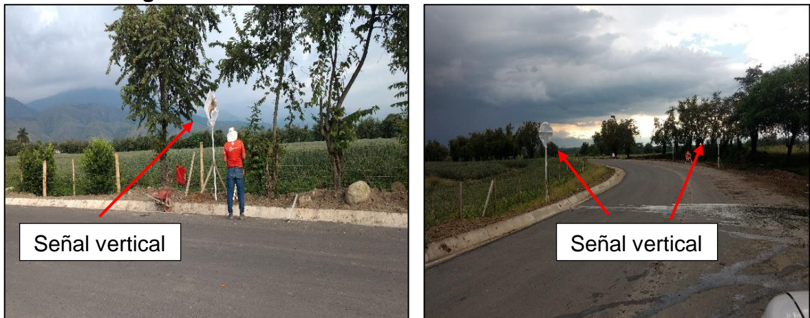
Figura 8.47. Inicio de instalación de señales verticales.
