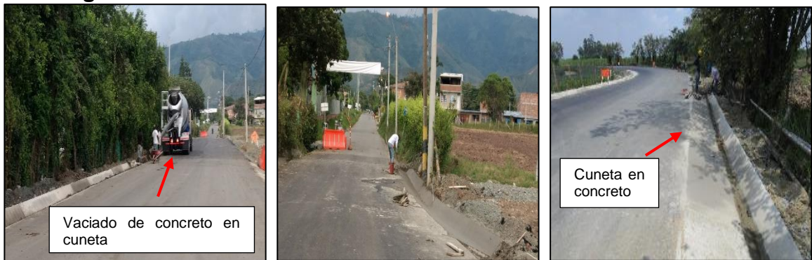
Figura 8.46. PR 0+000 al PR 0+020 Construcción de cuneta en “V”.
