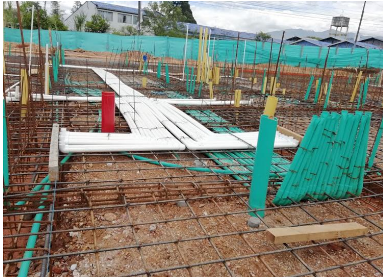
Ilustración 44 Instalación red eléctrica
