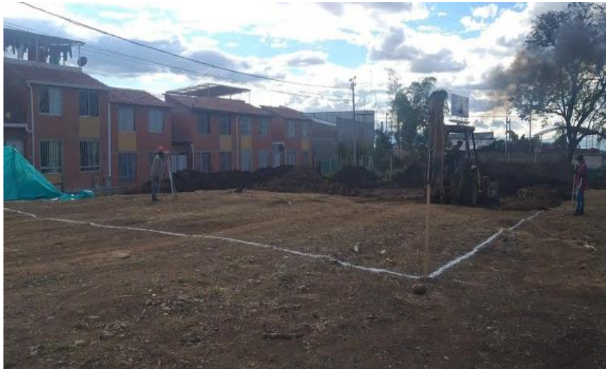
Ilustración 26 Localización de la losa de cimentación.
