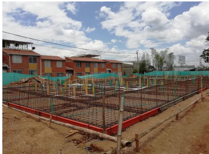
Ilustración 50 Losa cimentación lista para fundición
