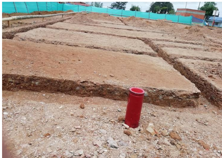
Ilustración 47 Instalación tubería red contra incendios.
