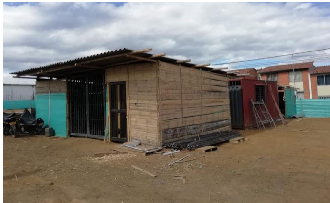
Ilustración 23 Campamento de la obra.
