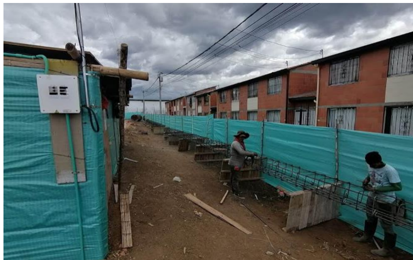
Ilustración 34 Amarre de acero de refuerzo
