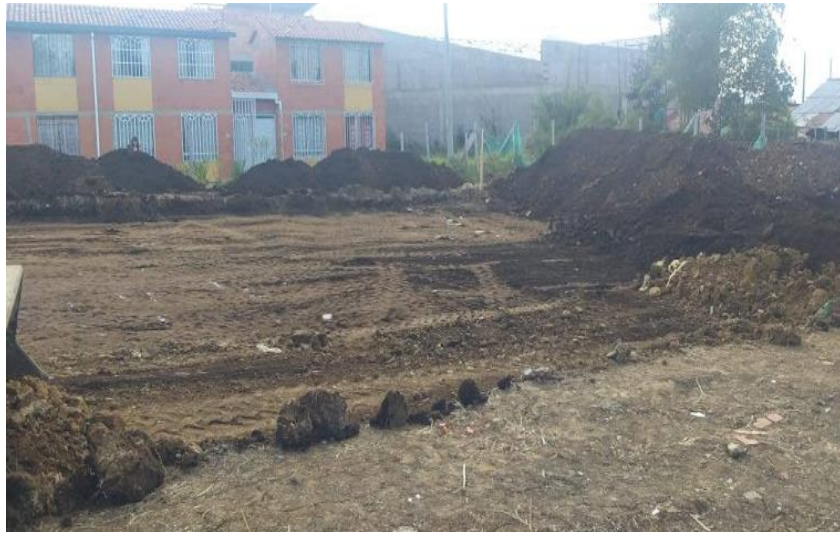
Ilustración 20 Retiro de capa vegetal
