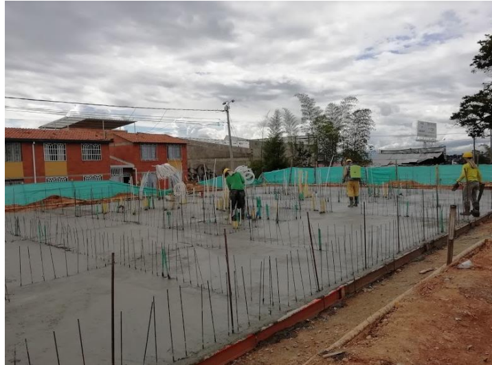
Ilustración 59 Aplicación de antisol
