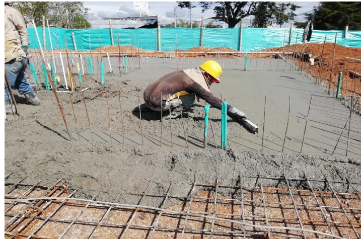
Ilustración 55 Nivelación de concreto
