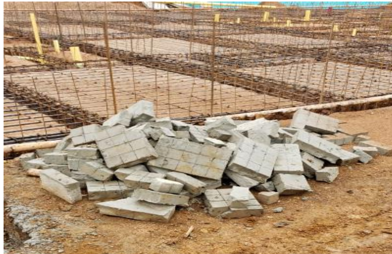
Ilustración 36 Panelitas de concreto
