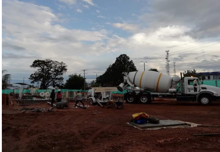
Ilustración 53 Descarga de mixer en bomba estacionaria.
