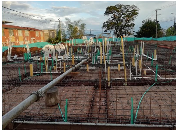
Ilustración 52 Tubería de hierro de la bomba.
