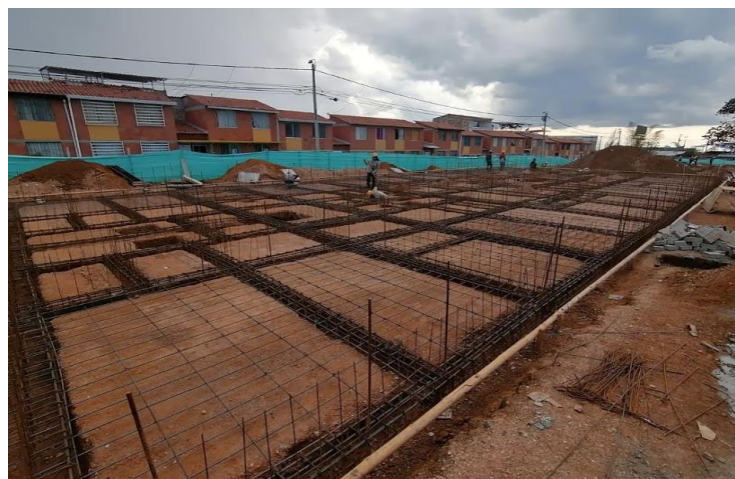
Ilustración 38 Instalación de vigas de acero de refuerzo
