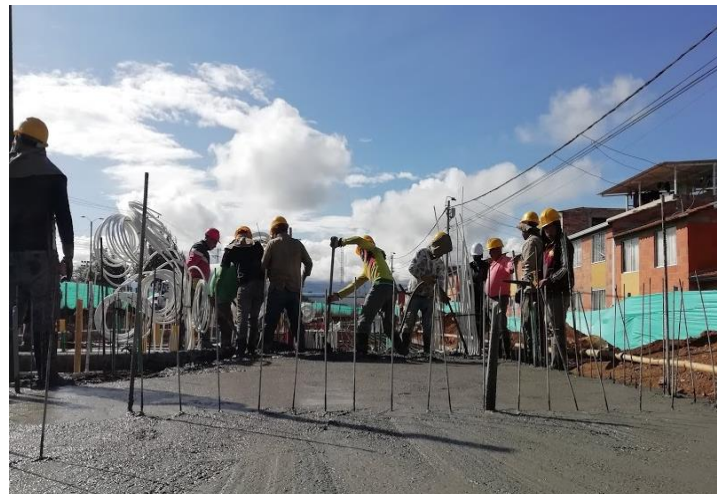
Ilustración 56 Vibrado del concreto
