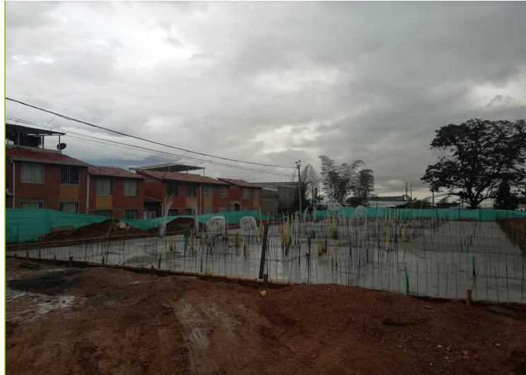
Ilustración 58 Losa cimentación fundida completamente.
