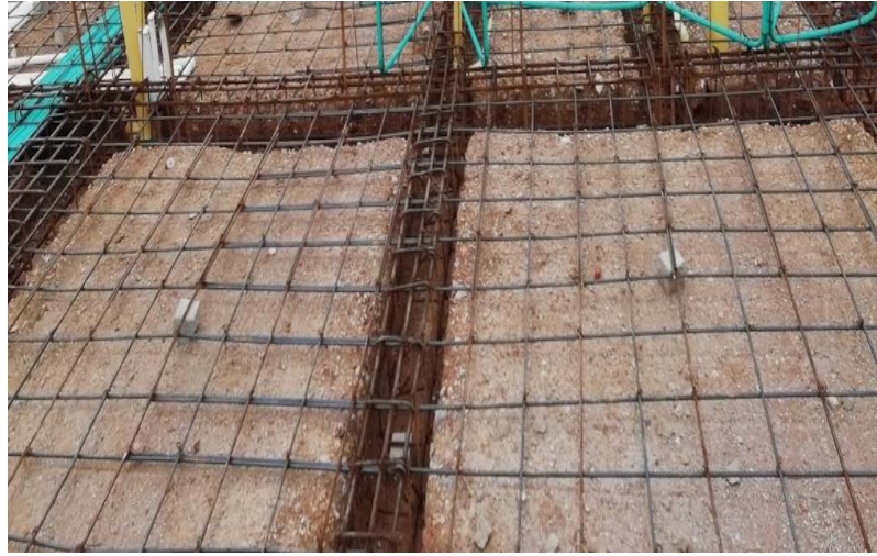
Ilustración 35 Acero de refuerzo sobre panelitas de concreto
