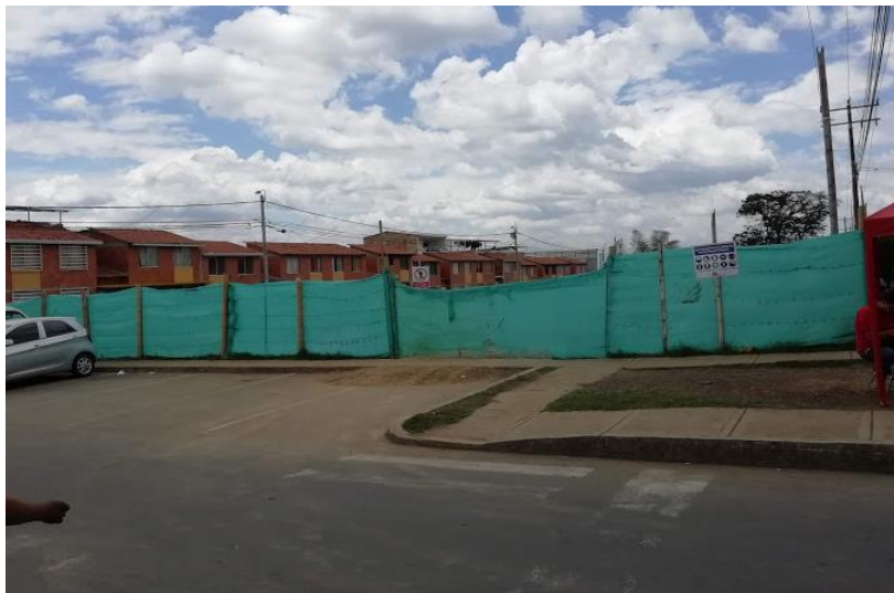
Ilustración 18 Cerramiento de la obra con yute.
