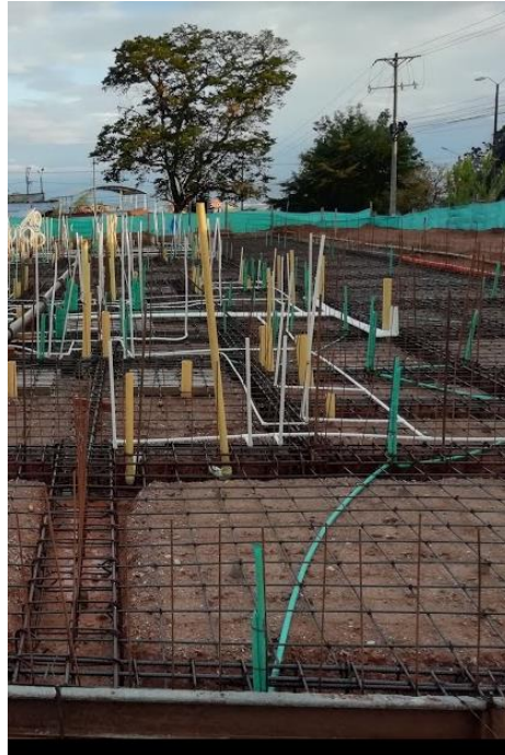
Ilustración 40 Instalaciones hidráulicas
