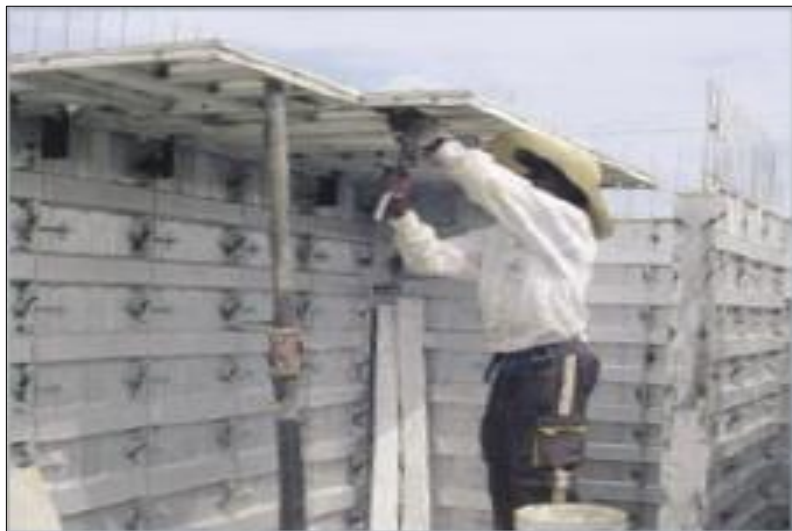
Ilustración 12 Sistema de formaleta que se empleará
