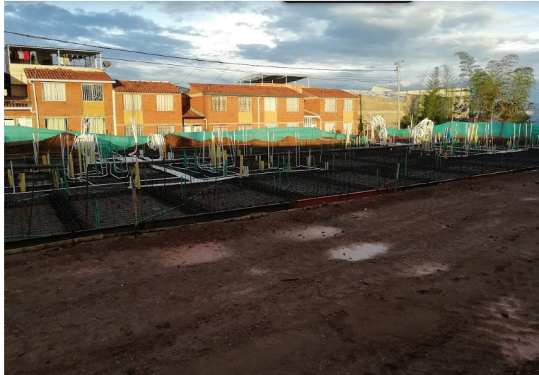
Ilustración 49 Instalación red de gas domiciliario terminada
