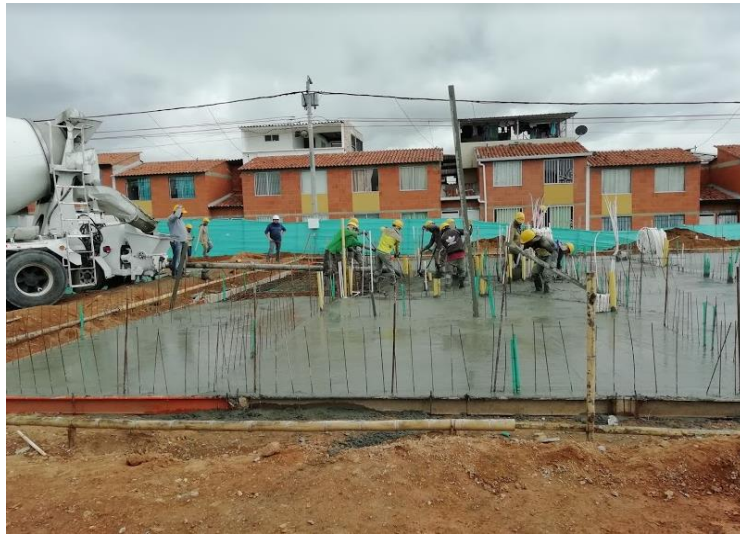
Ilustración 57 Medición del complemento de concreto
