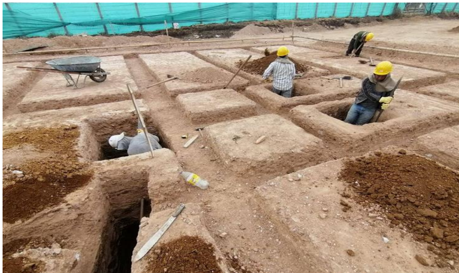
Ilustración 32 Excavación de vigas y cajas de inspección.
