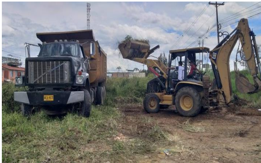
Ilustración 21 Cargue y retiro de marjal sobrante.
