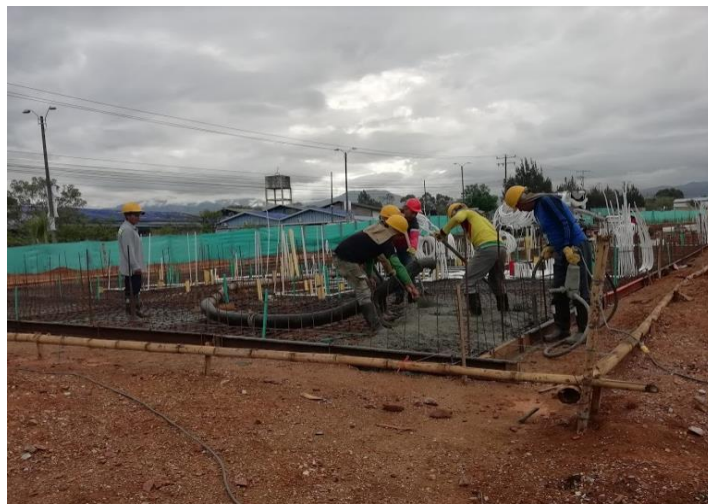
Ilustración 54 Descarga de concreto a través de tubería
