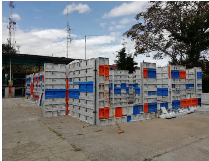
Ilustración 11 Formaleta a utilizar en el proyecto.
