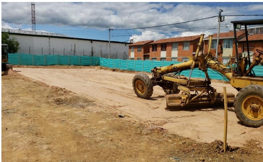
Ilustración 29 Perfilación con motoniveladora
