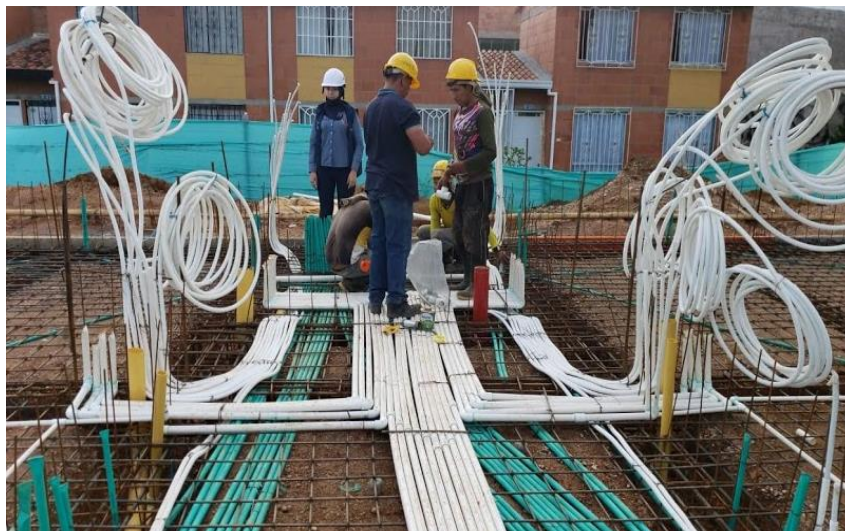
Ilustración 49 Instalación red de gas domiciliario.
