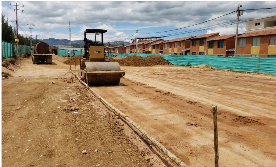
Ilustración 28 Compactación con material tipo roca muerta
