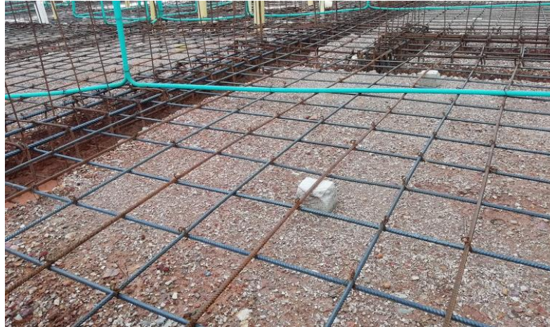
Ilustración 37 Instalación acero de refuerzo sobre panelitas de concreto
