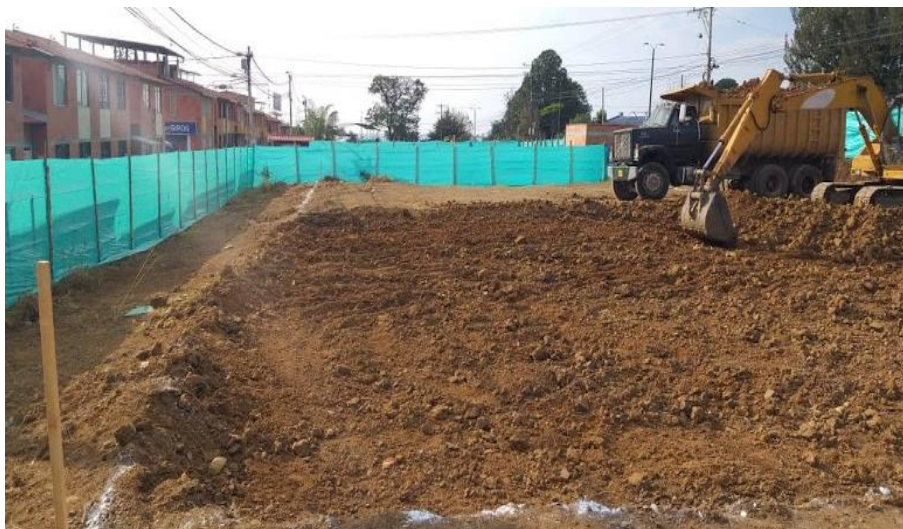
Ilustración 27 Cajeo del área de cimentación
