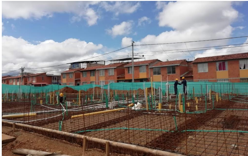
Ilustración 48 Instalación red de gas domiciliario.
