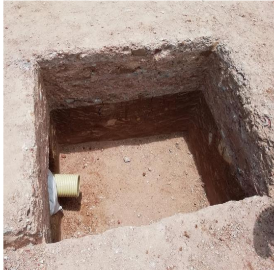
Ilustración 42 Excavación para caja de recolección
