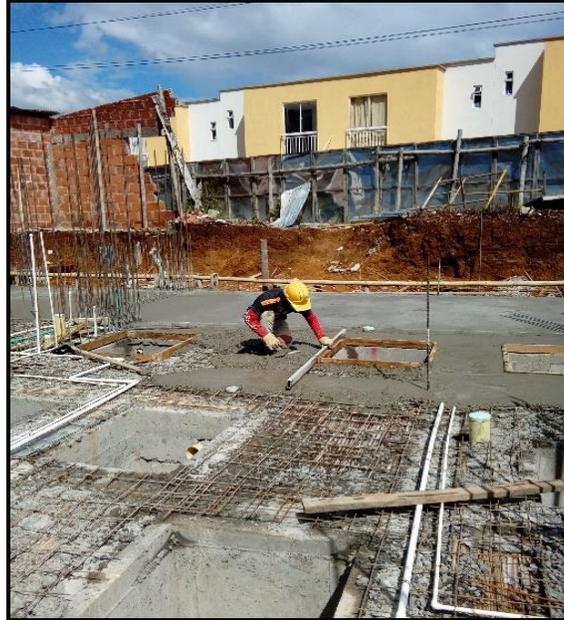
Ilustración 10. Fundición de losa superior
