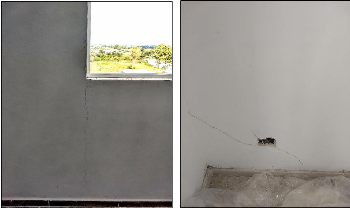
Ilustración 24. Revisión de fisuras al interior del inmueble
