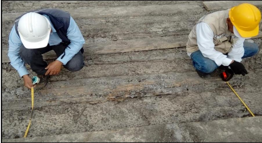
Ilustración 8. Medición de vigas post-fundición
