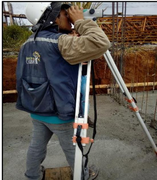
Ilustración 11. Control de niveles losa superior
