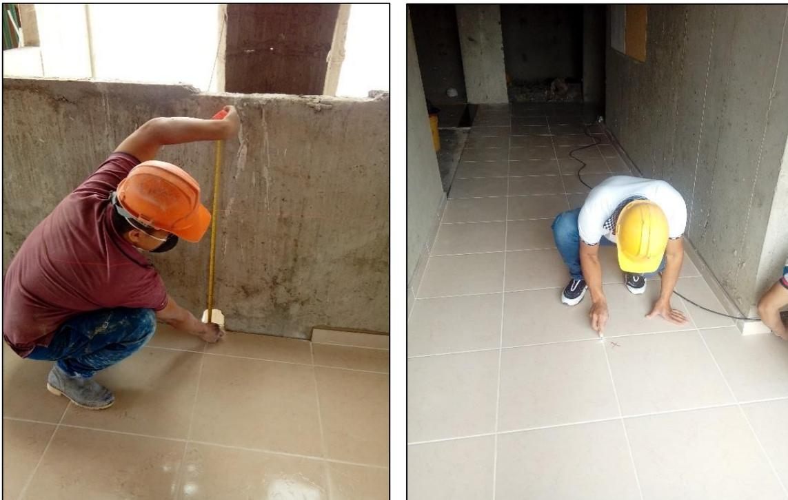
Ilustración 14. Revisión de enchape - zona común
