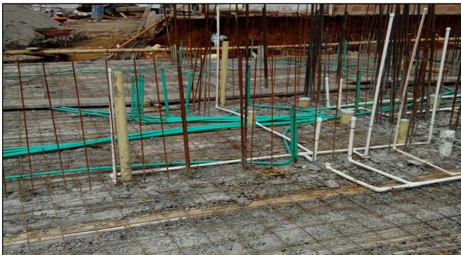
Ilustración 9. Instalación de red eléctrica e hidráulica
