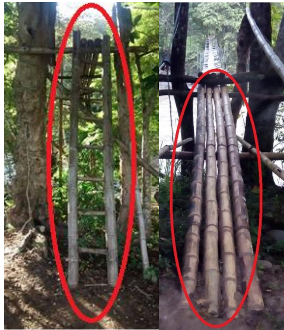
Ilustración 15. Escalera y rampa, para accesos al puente. Fuente: Propia.
