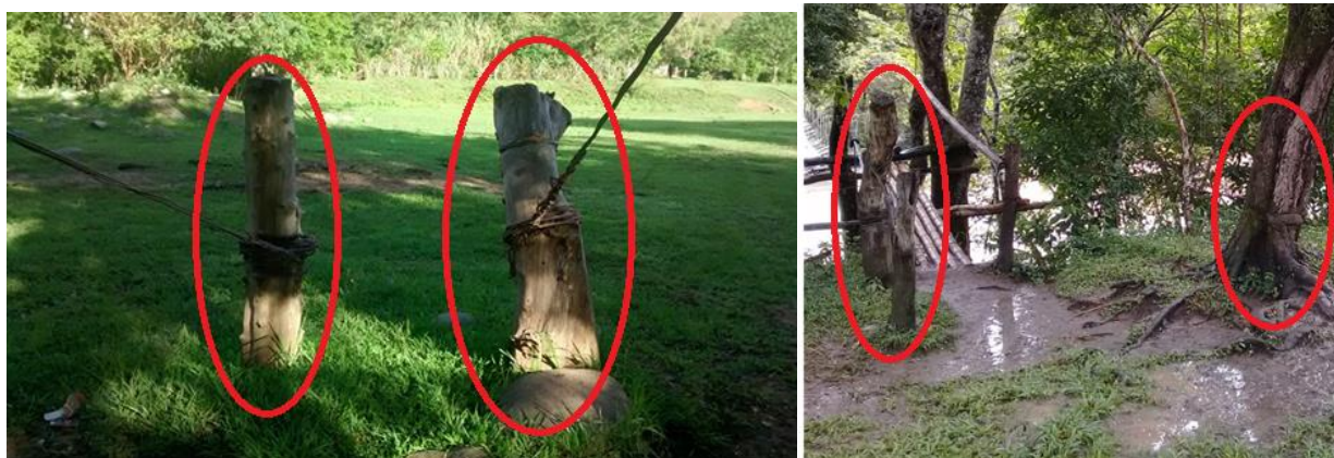
Ilustración 14. Anclajes de maderos “Matarraton – Cañafistol”. Fuente: Propia.
