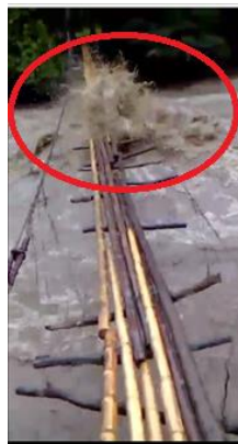
Ilustración 17. En época de invierno, río en aumento, crestas de olas pasando por encima del tablero del puente, gálibo 0.0 metros, vs época de verano río con galibo de 2.5 metros. Fuente: Propia.
