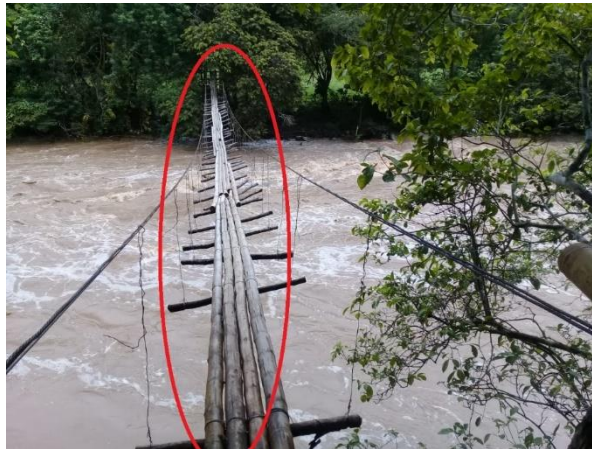
Ilustración 11. Tablero hecho en guadua. Fuente: Propia.
