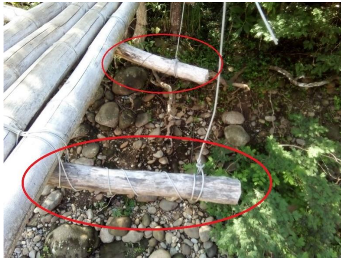
Ilustración 13. Travesaños de madera “Guayacán- Carbonero”. Fuente: Propia.
