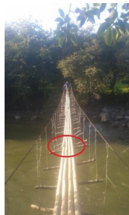
Ilustración 17. En época de invierno, río en aumento, crestas de olas pasando por encima del tablero del puente, gálibo 0.0 metros, vs época de verano río con galibo de 2.5 metros. Fuente: Propia.
