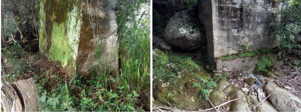
Ilustración 44: Estribo lado derecho Aguas abajo, Estribo lado izquierdo, aguas abajo. Fuente: Propia.
