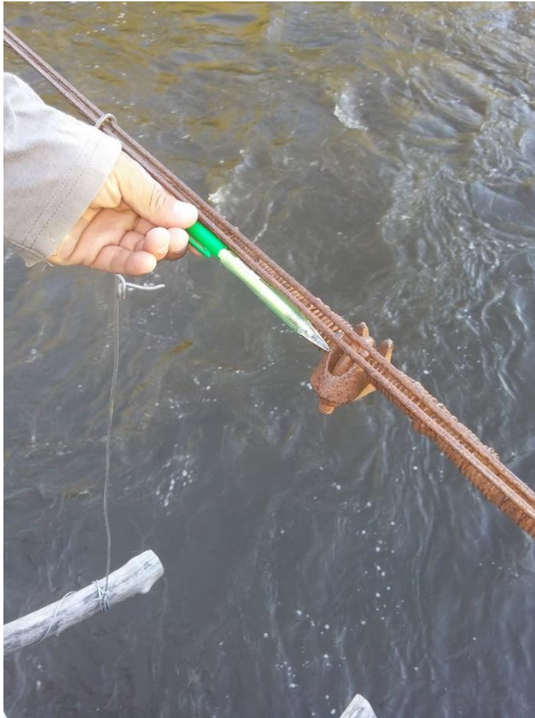
Ilustración 10. Cable principal del puente actual. Fuente: Propia.
