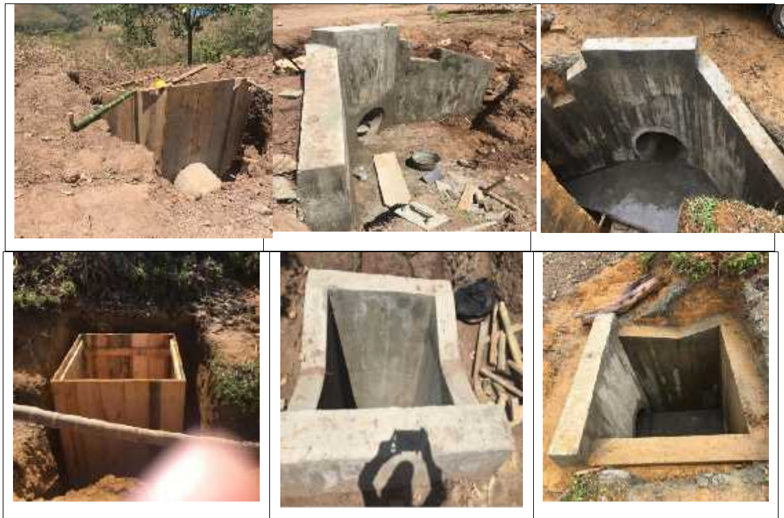
Ilustración 18: fundición del concreto
