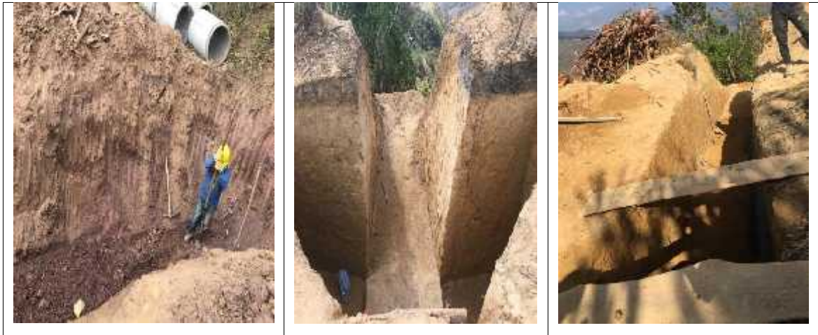
Ilustración 15: excavaciones a mano
