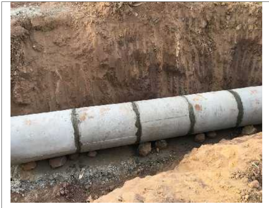
Ilustración 17: instalación de tubería
