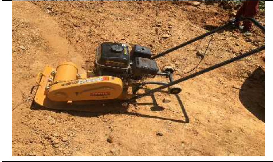
Ilustración 19 compactación del material de relleno
