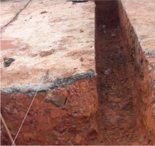
Figura 44. Excavación de zanjas para tubería de descarga sanitaria
