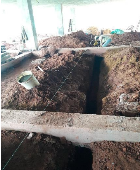
Figura 53. Excavación de zanjas en parqueadero subterráneo
