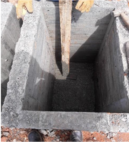
Figura 50. Cajas de inspección fundidas en concreto simple Torre C
