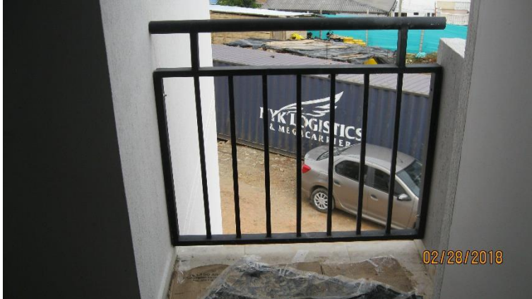
Figura 22. Baranda en habitación principal
