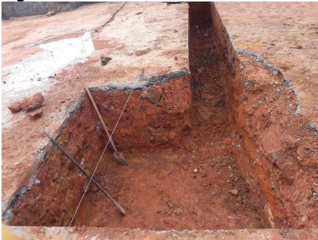
Figura 40. Excavación foso ascensor Torre C
