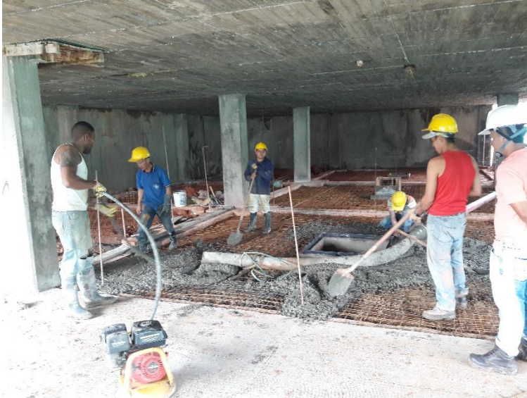
Figura 65. Vibrado del concreto
