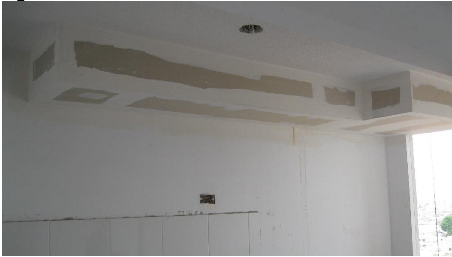
Figura 24. Cielo raso de cocina
