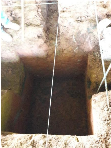
Figura 54. Excavación de cajas de inspección en parqueadero subterráneo
