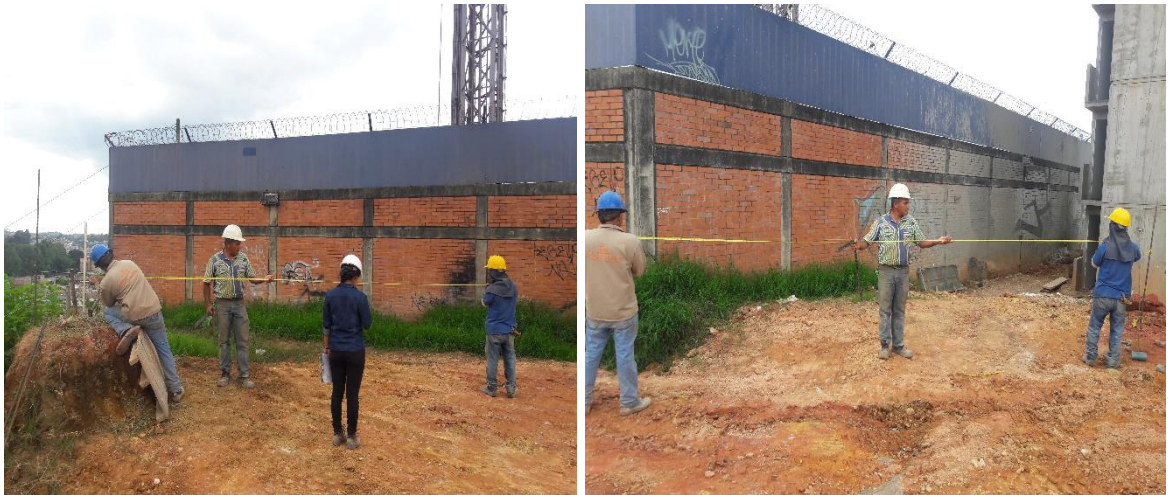
Figura 29. Localización y Toma de medidas Torre C
