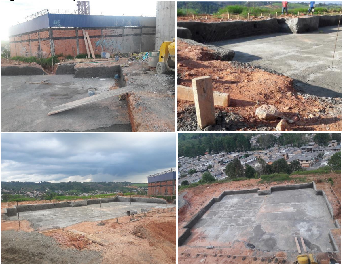
Figura 36. Champeo de Protección muros de excavación Torre C
