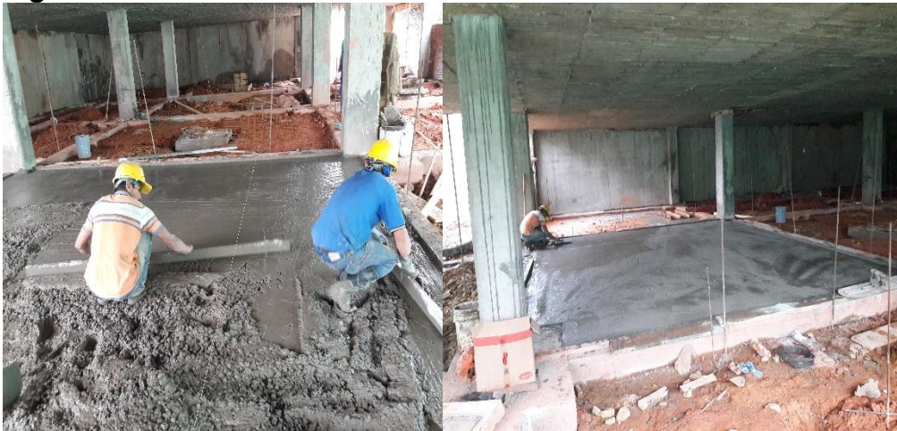
Figura 66. Terminado del concreto con codal
