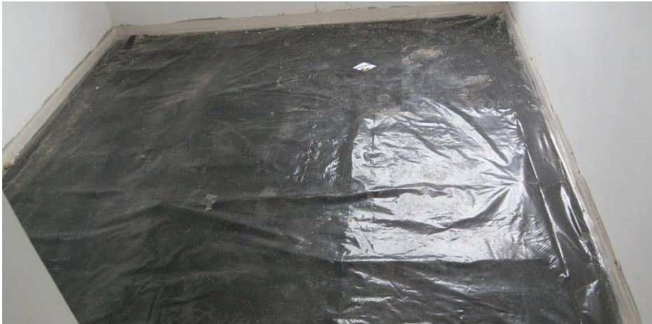
Figura 17 Forrado de protección enchape
