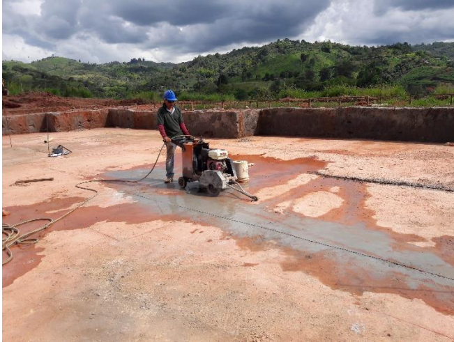
Figura 39. Cortes en solado para excavación de foso ascensor Torre C
