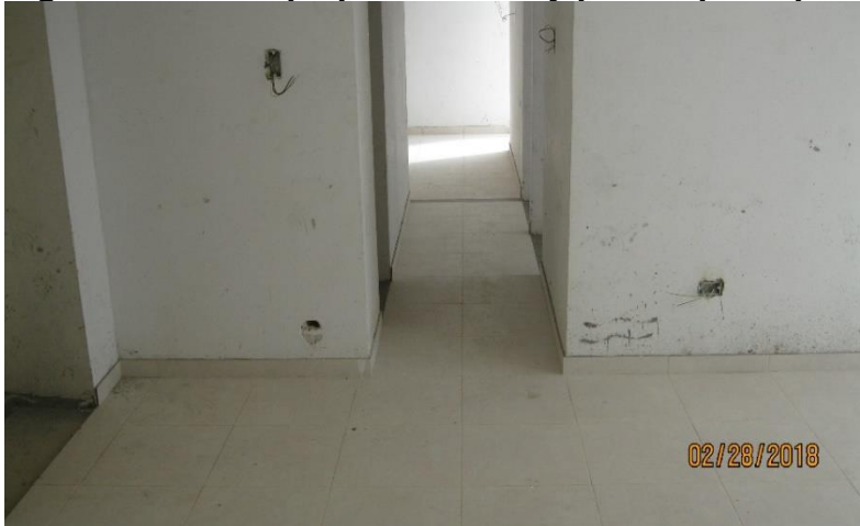
Figura 11. Enchape piso en sala y pasillo principal
