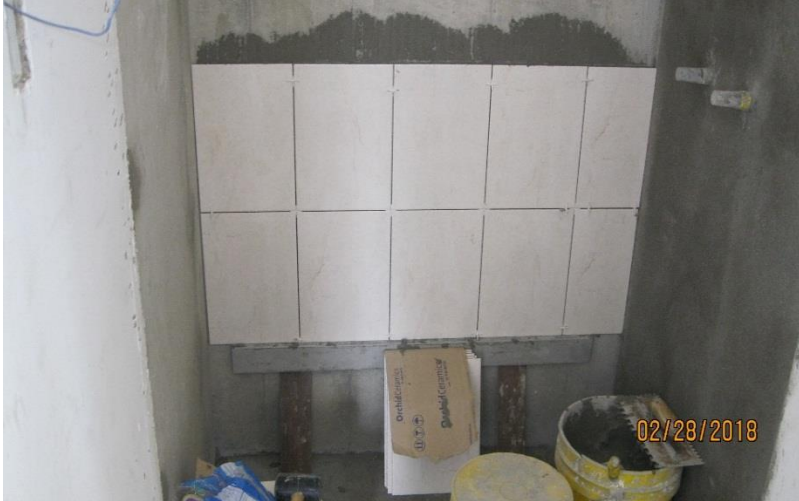
Figura 14. Enchape de muros en duchas de apartamentos
