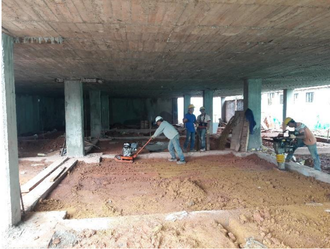
Figura 61. Compactación manual sub-rasante
