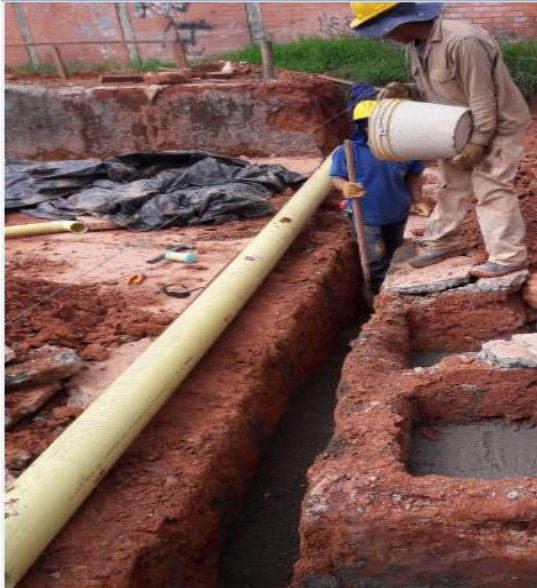
Figura 45. Cama de arena en zanjas Torre C
