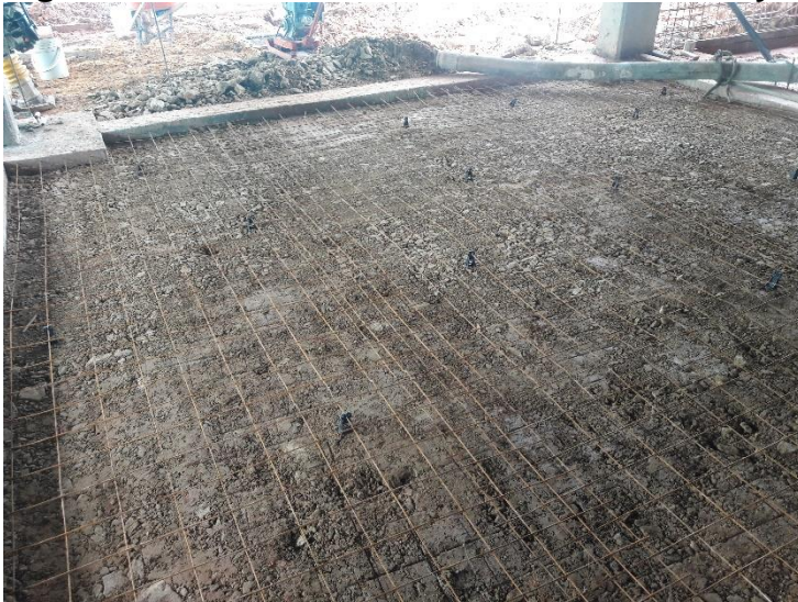
Figura 62. Instalación de malla de retracción y temperatura
