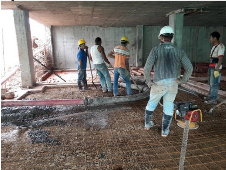
Figura 64. Fundición en concreto de modulo
