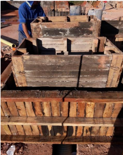
Figura 49. Formaleta para cajas de inspección Torre C
