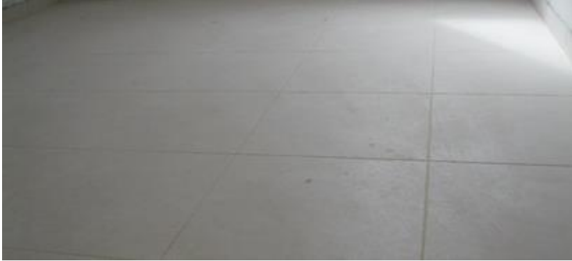
Figura 12. Enchape de piso
