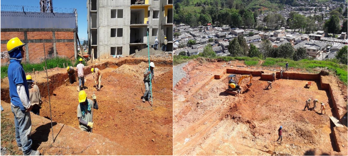
Figura 34. Perfilado manual en excavación Torre C
