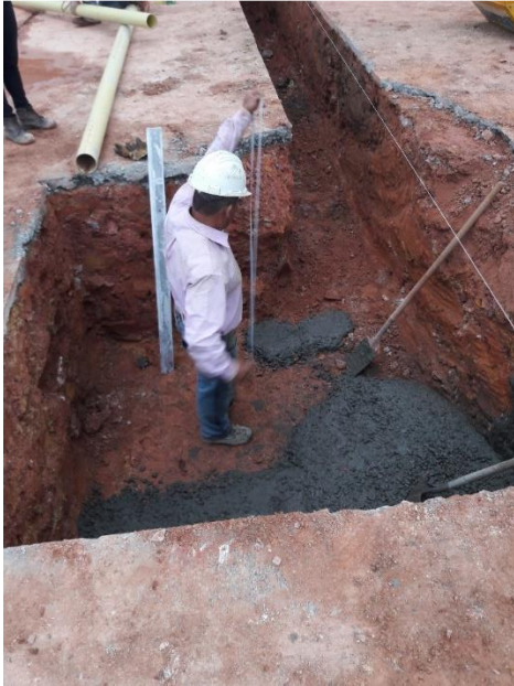
Figura 41. Fundición solado en foso ascensor Torre C
