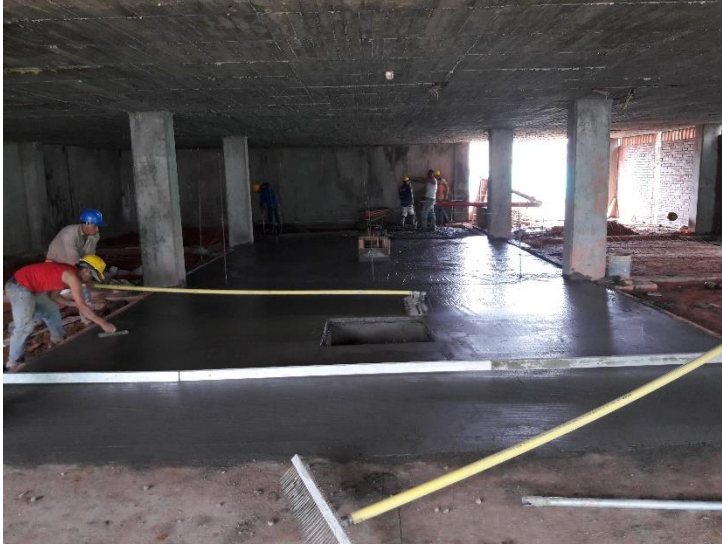
Figura 67. Terminado del módulo de concreto
