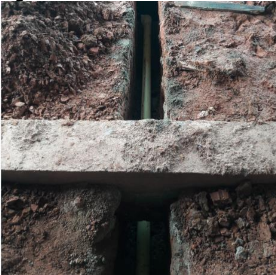
Figura 55. Instalación de tubería en sótano parqueadero
