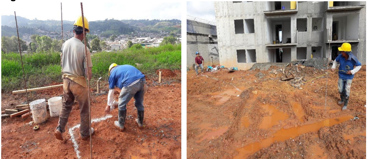
Figura 30. Demarcación con cal Torre C
