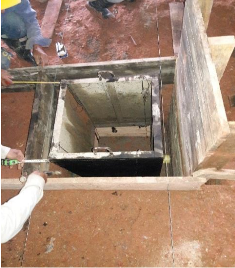
Figura 57. Formaleta para cajas de inspección en sótano parqueaderos
