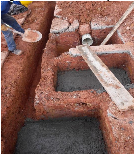
Figura 48. Solado de limpieza en cajas de inspección Torre C
