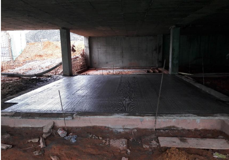
Figura 68. Rallado del módulo de concreto
