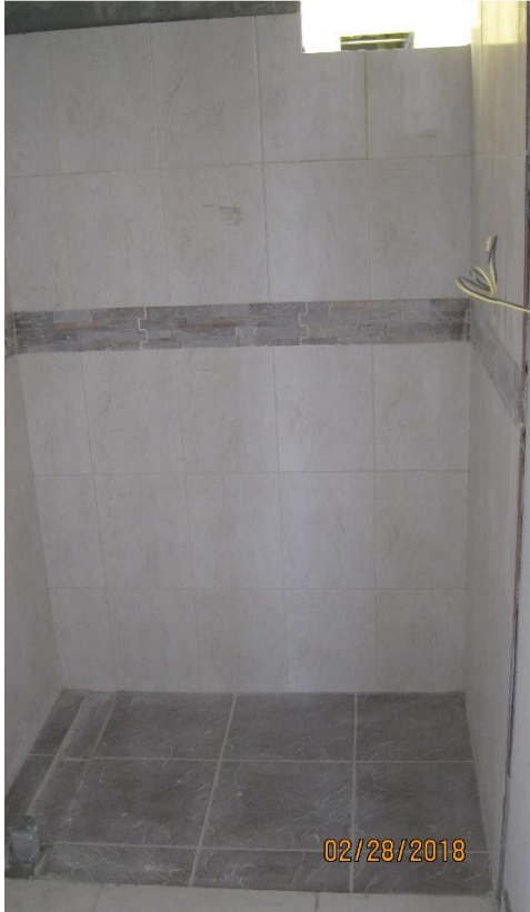
Figura 15. Enchape de ducha terminado
