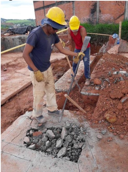
Figura 46. Excavación manual de cajas de inspección Torre C
