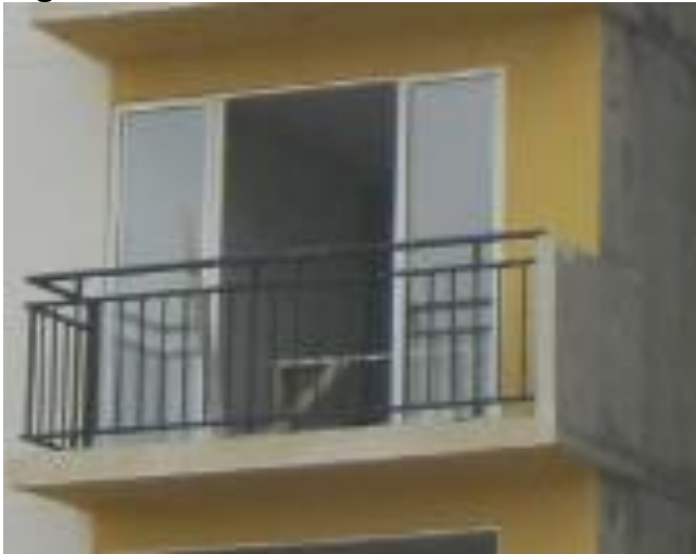
Figura 21. Barandas en balcones Torre B
