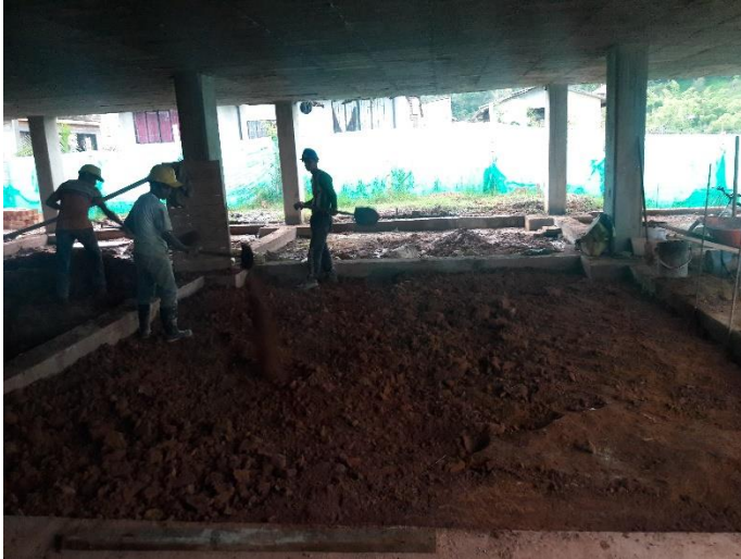
Figura 59. Riego de material para compactar sub-rasante
