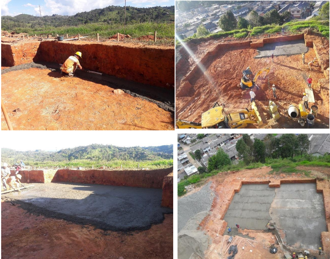
Figura 35. Solado de nivelación y limpieza Torre C
