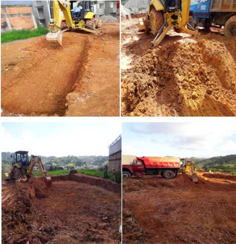
Figura 32. Excavación a nivel de cimentación Torre C
