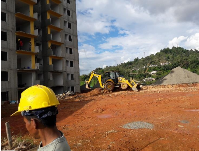
Figura 26. Limpieza de terreno Torre C
