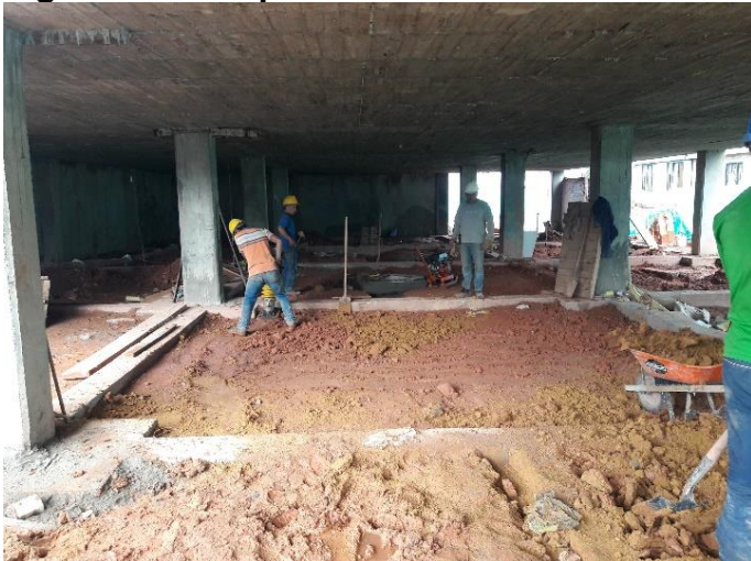
Figura 60. Compactación con saltarín de la sub-rasante
