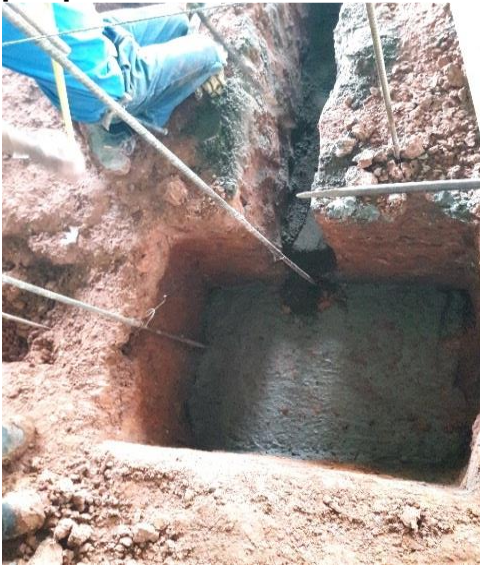
Figura 56. Solado de nivelación en cajas de inspección en sótano parqueaderos
