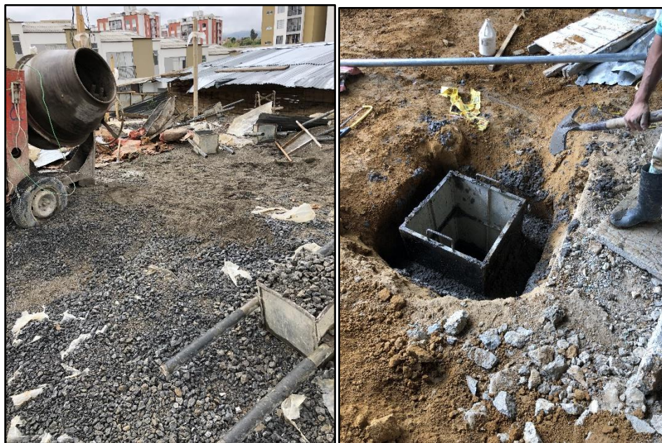
Figura 29. Mezcla de concreto 1:2:3 y fundición de cámaras. Fuente: tomada por el pasante.
