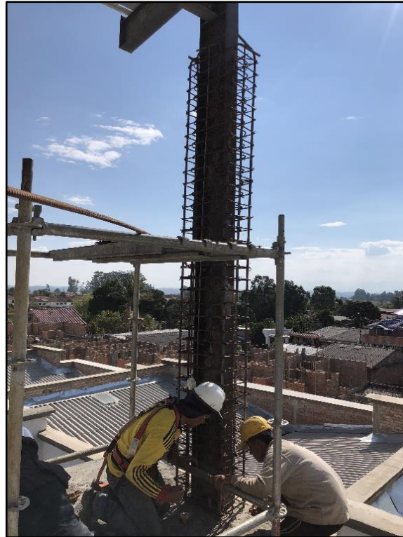
Figura 15 Colocación del refuerzo tipo C8. Fuente: tomada por el pasante.
