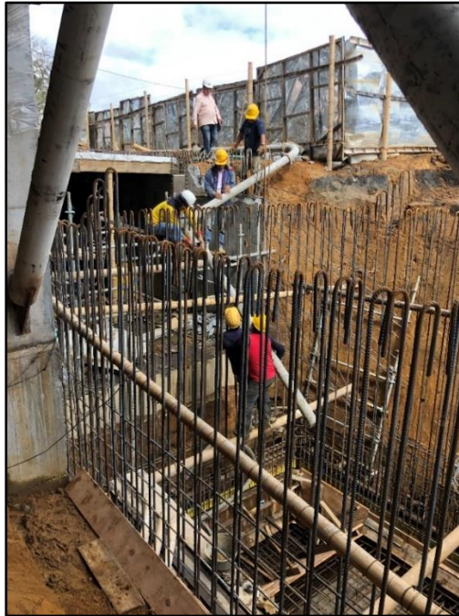
Figura 55. Armado de tubería. Fuente: tomada por el pasante.
