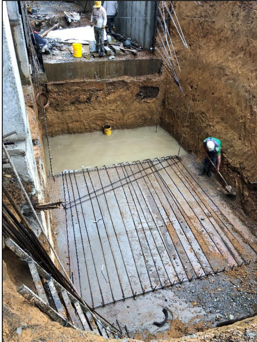
Figura 51. Cimbrado y ubicación de refuerzo. Fuente: tomada por el pasante.
