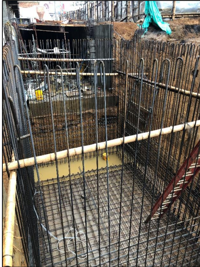
Figura 53. Refuerzo vertical para los muros del tanque. Fuente: tomada por el pasante.
