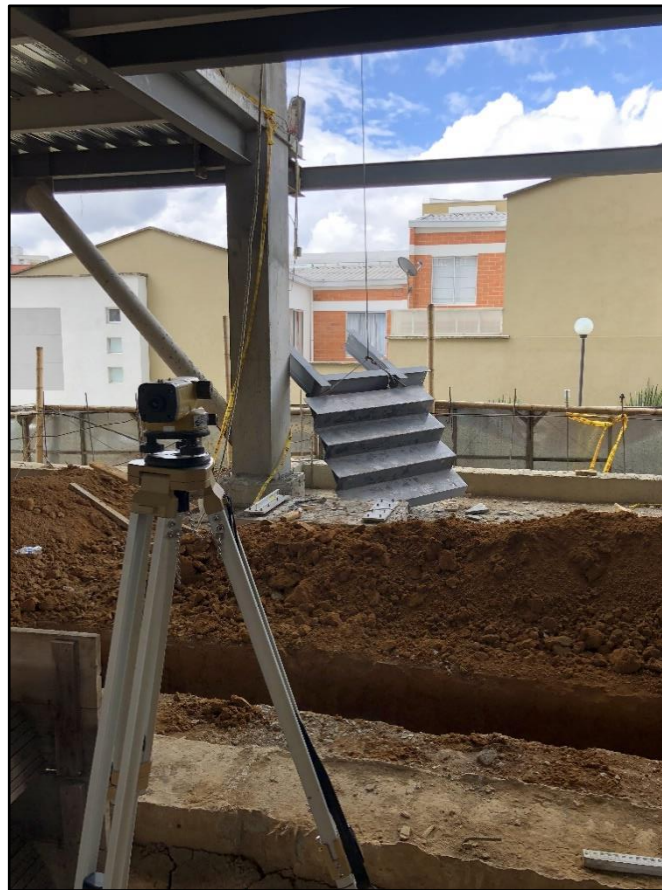
Figura 38. Nivel de escalera. Fuente: tomada por el pasante.
