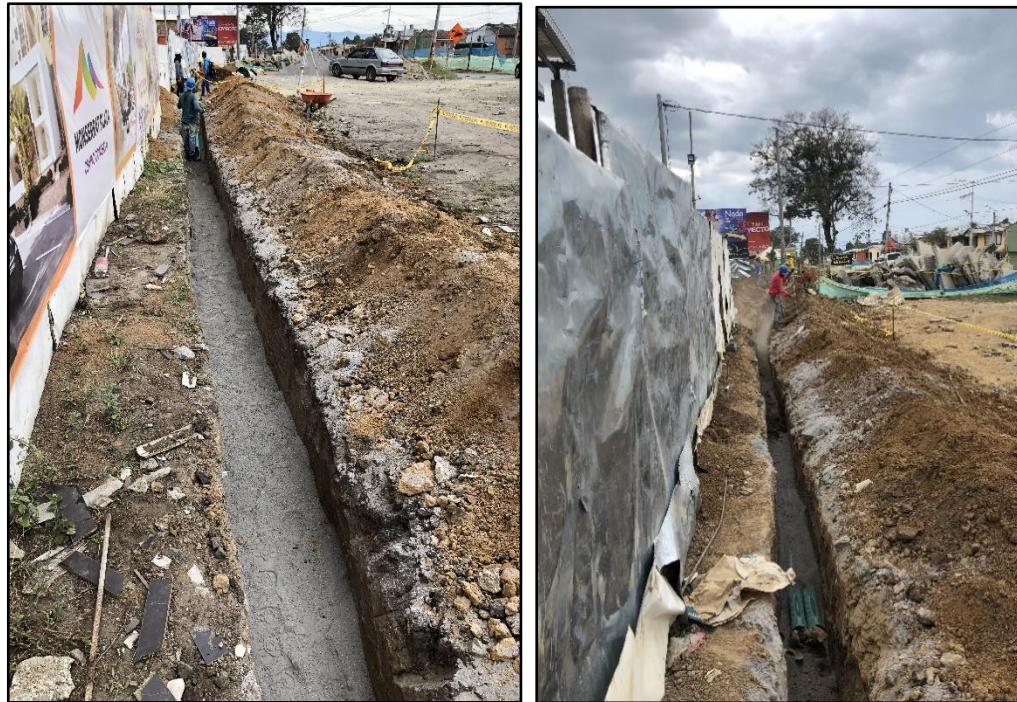
Figura 34. Instalación de tubería de telefonía. Fuente: tomada por el pasante.
