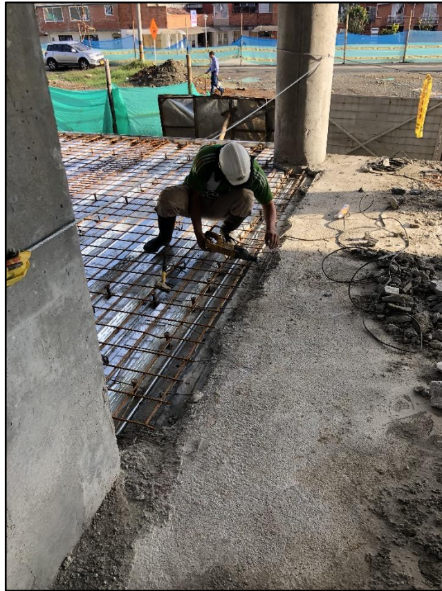
Figura 10. Perforación para anclajes. Fuente: tomada por el pasante.
