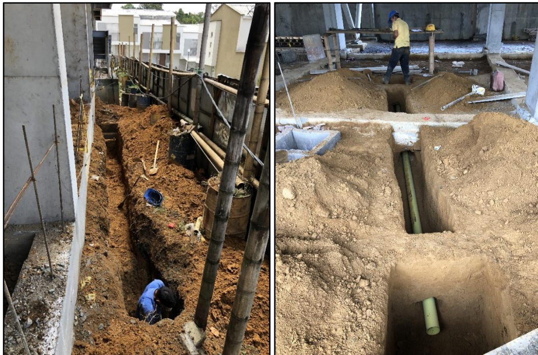
Figura 28. Excavación e instalación de tubería. Fuente: tomada por el pasante.
