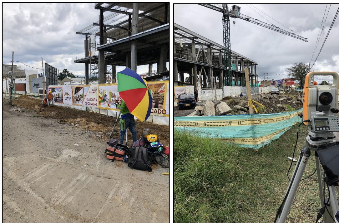
Figura 30. Amarre levantamiento topográfico. Fuente: tomada por el pasante.
