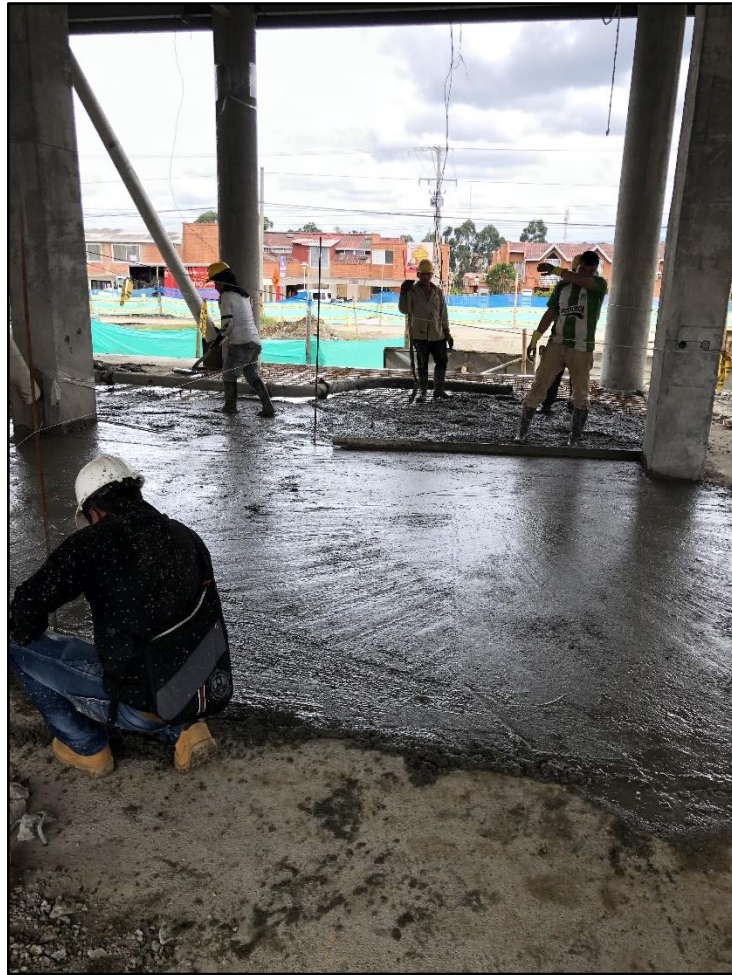
Figura 12. Platachado de la superficie de losa. Fuente: tomada por el pasante.
