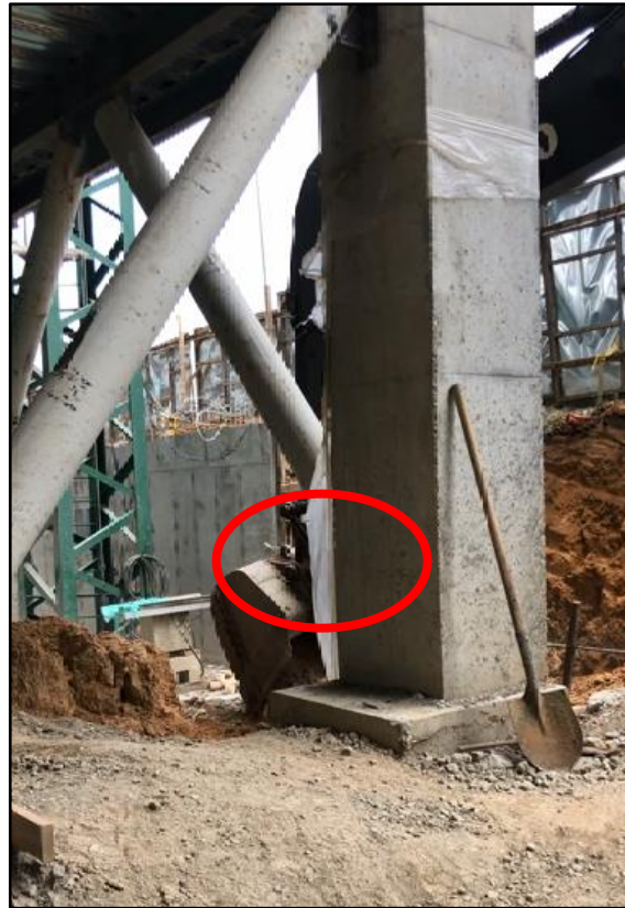
Figura 43. Cimentación torre grúa. Fuente: tomada por el pasante.
