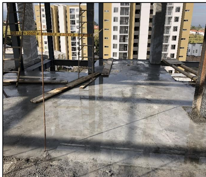
Figura 6. Curado de losa. Fuente: tomada por el pasante.
