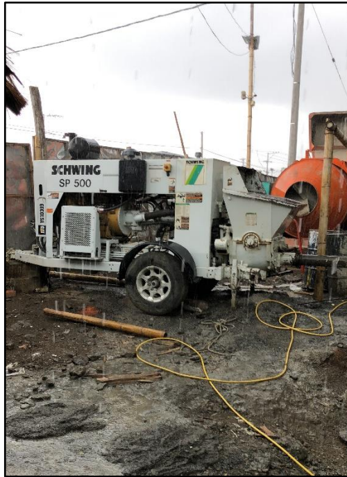
Figura 18. Bombeo de concreto. Fuente: tomada por el pasante.
