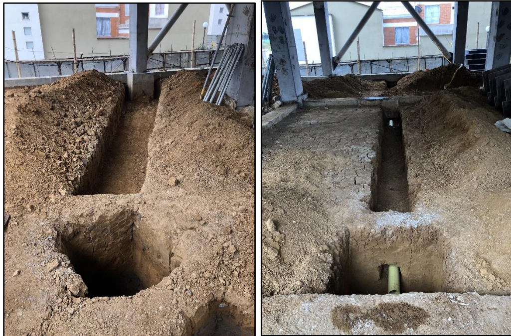
Figura 27. Excavación e instalación de tubería. Fuente: tomada por el pasante.
