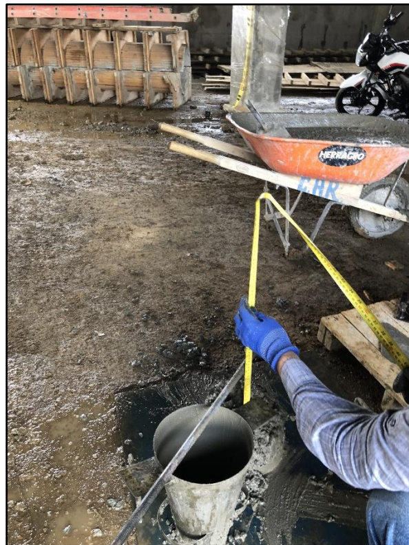
Figura 63. Ensayo de asentamiento. Fuente: tomada por el pasante.
