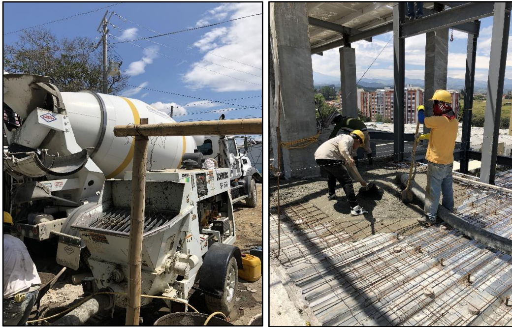
Figura 5. Mixer y colocación de concreto Premezclado. Fuente: tomada por el pasante.
