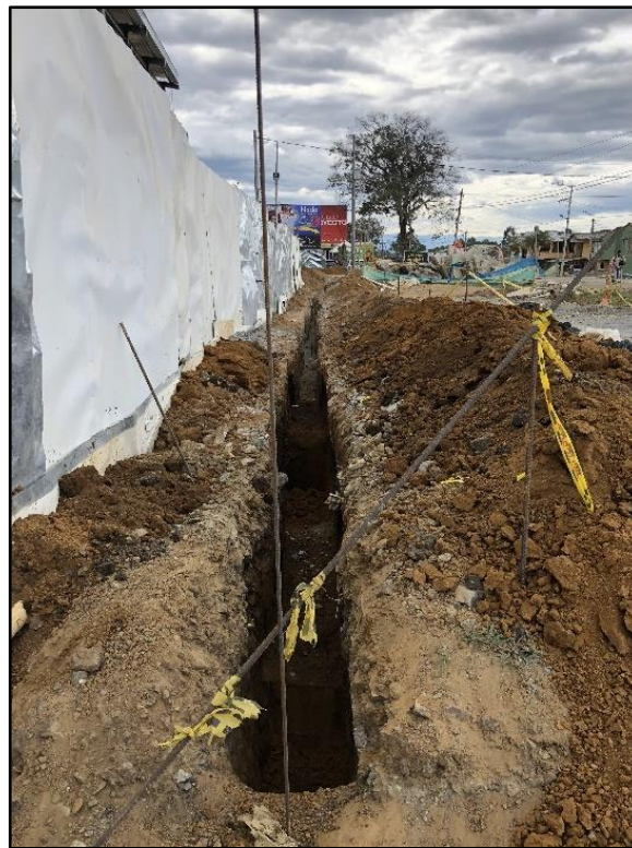
Figura 32. Excavación para tubería de telefonía. Fuente: tomada por el pasante.
