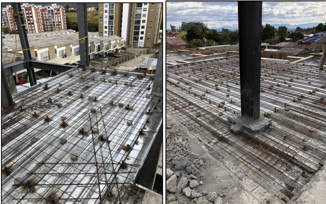
Figura 4. Colocación de aceros. Fuente: tomada por el pasante.
