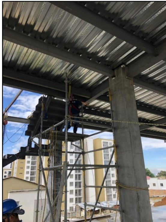
Figura 40. Fijación de escalera a viga principal. Fuente: tomada por el pasante.
