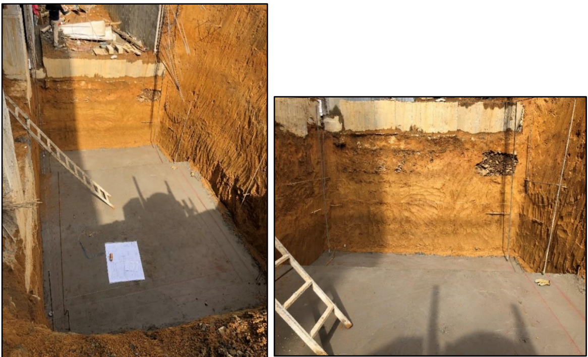
Figura 50. Solado del tanque. Fuente: tomada por el pasante.
