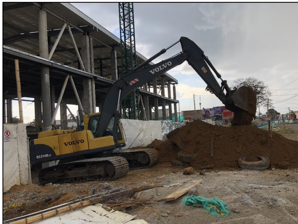
Figura 45. Excavación y limpieza de tanque. Fuente: tomada por el pasante.
