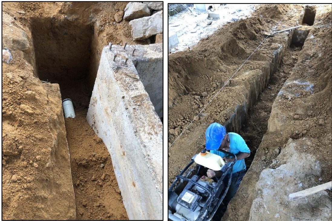
Figura 24. Excavación y relleno de zanjas y compactación de relleno. Fuente: tomada por el pasante.
