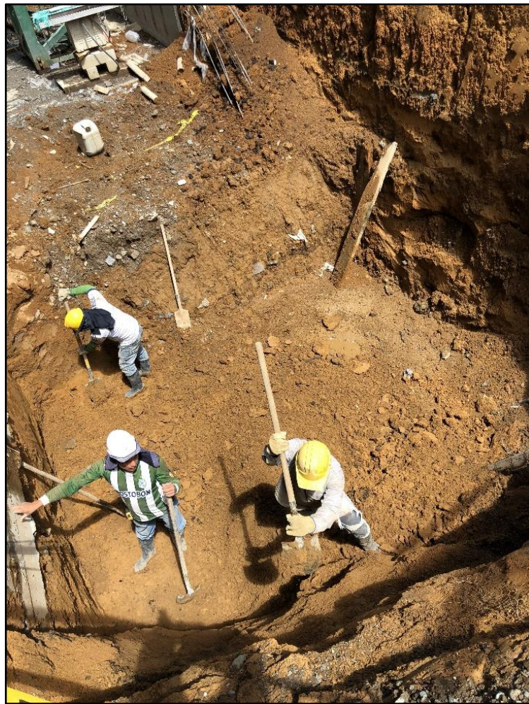
Figura 46. Perfilado de talud. Fuente: tomada por el pasante.
