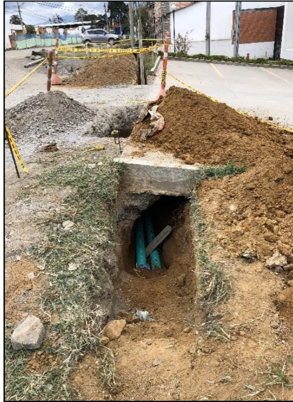
Figura 36. Excavación entrada de condominio. Fuente: tomada por el pasante.
