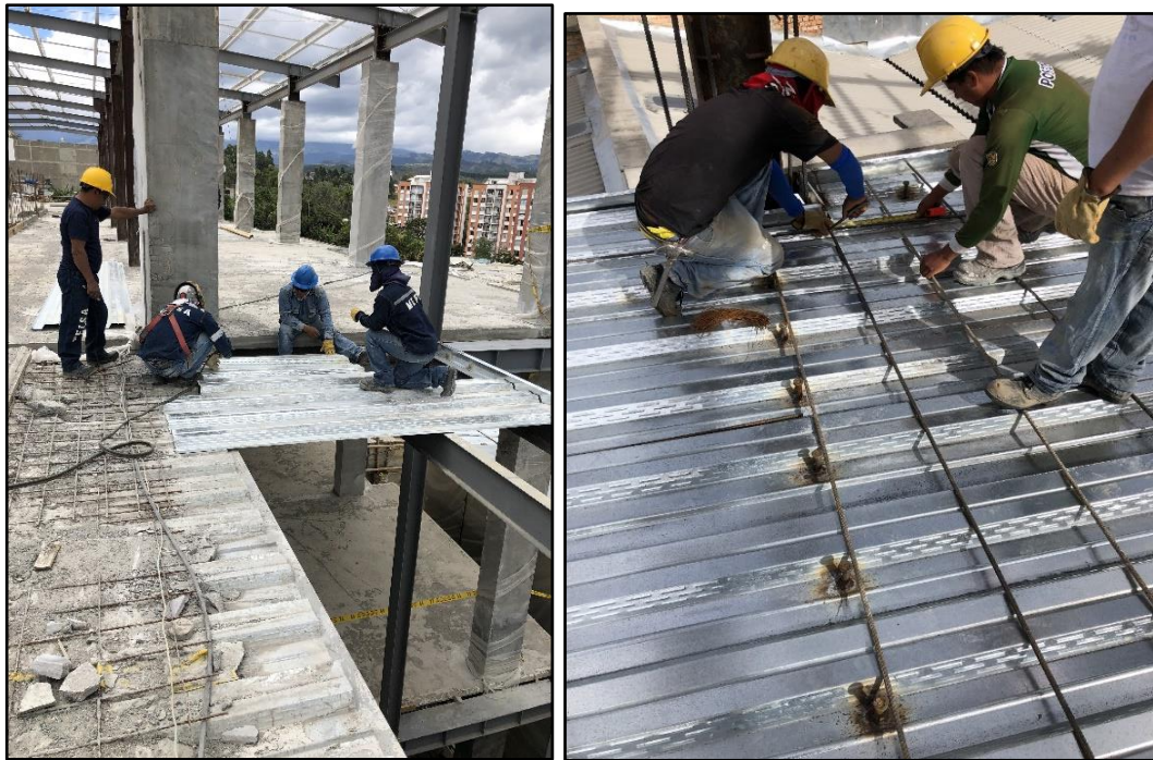
Figura 2. Instalación, soldadura y colocación de acero. Fuente: tomada por el pasante.
