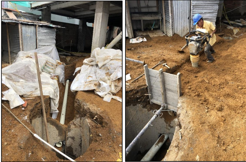
Figura 25. Excavación e instalación de tubería. Fuente: tomada por el pasante.
