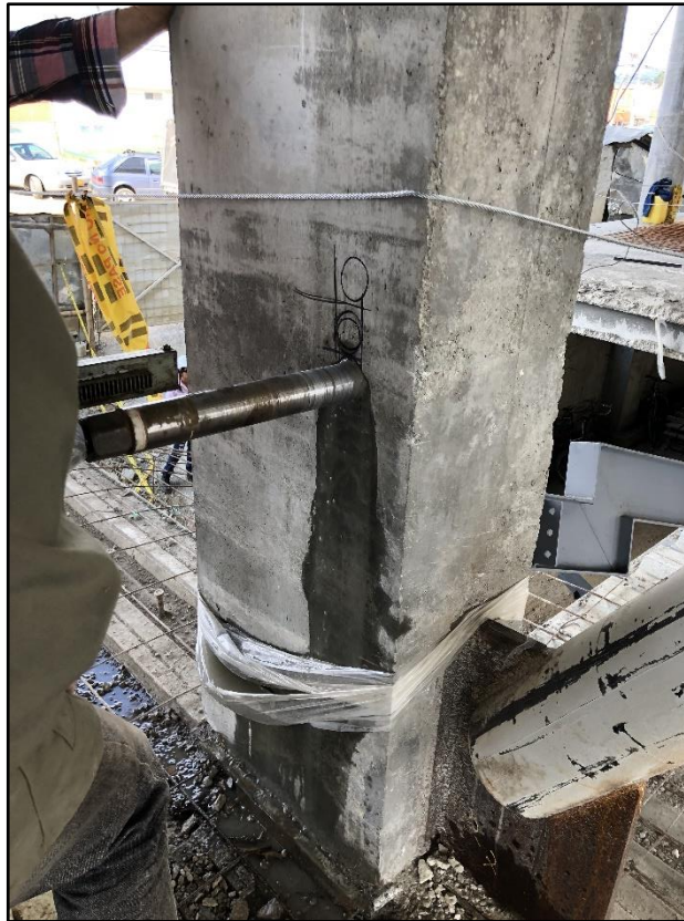
Figura 60. Extracción de núcleos. Fuente: tomada por el pasante.
