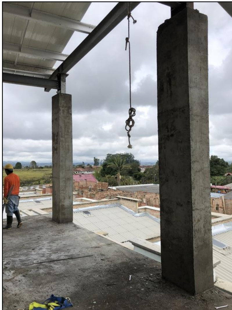
Figura 20. Desencofrado de columnas. Fuente: tomada por el pasante.
