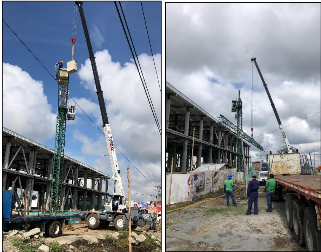
Figura 47. Desmonte de torre grúa. Fuente: tomada por el pasante.
