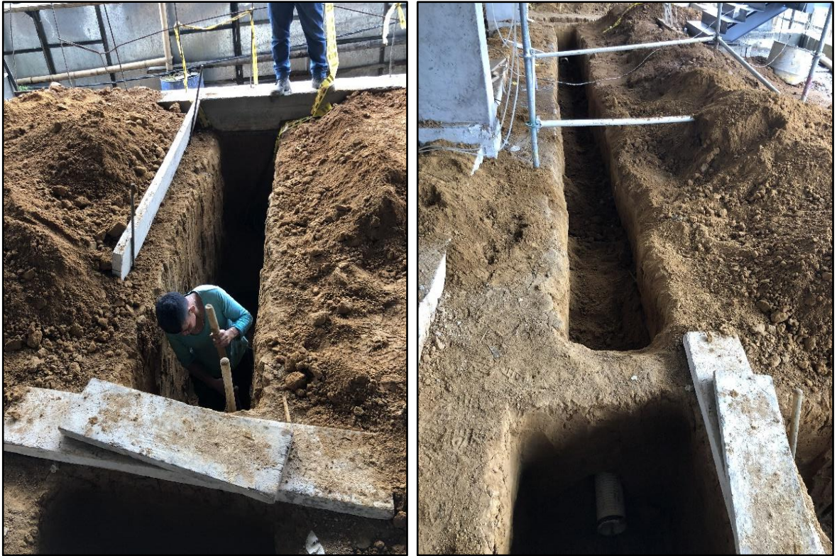
Figura 26. Excavación e instalación de tubería. Fuente: tomada por el pasante.
