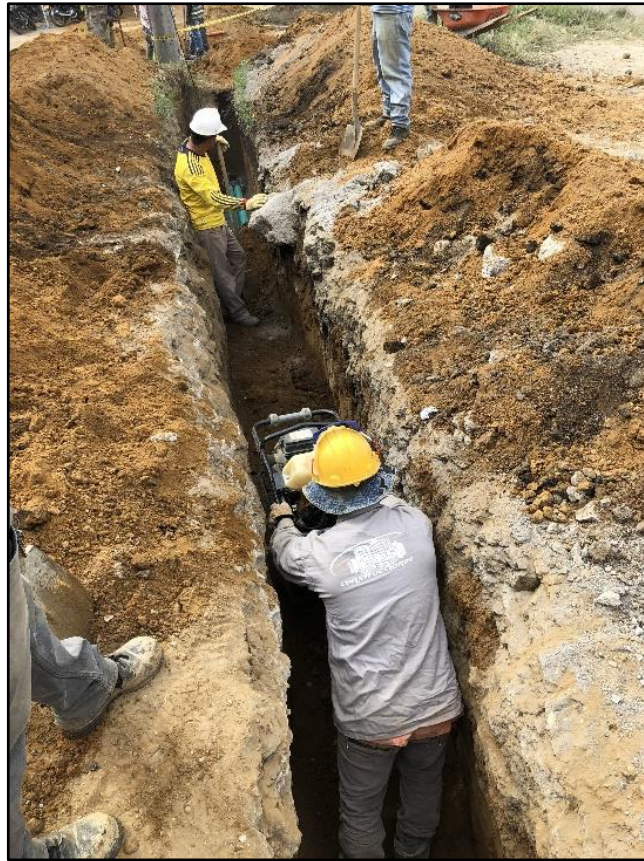
Figura 35. Compactación de relleno. Fuente: tomada por el pasante.
