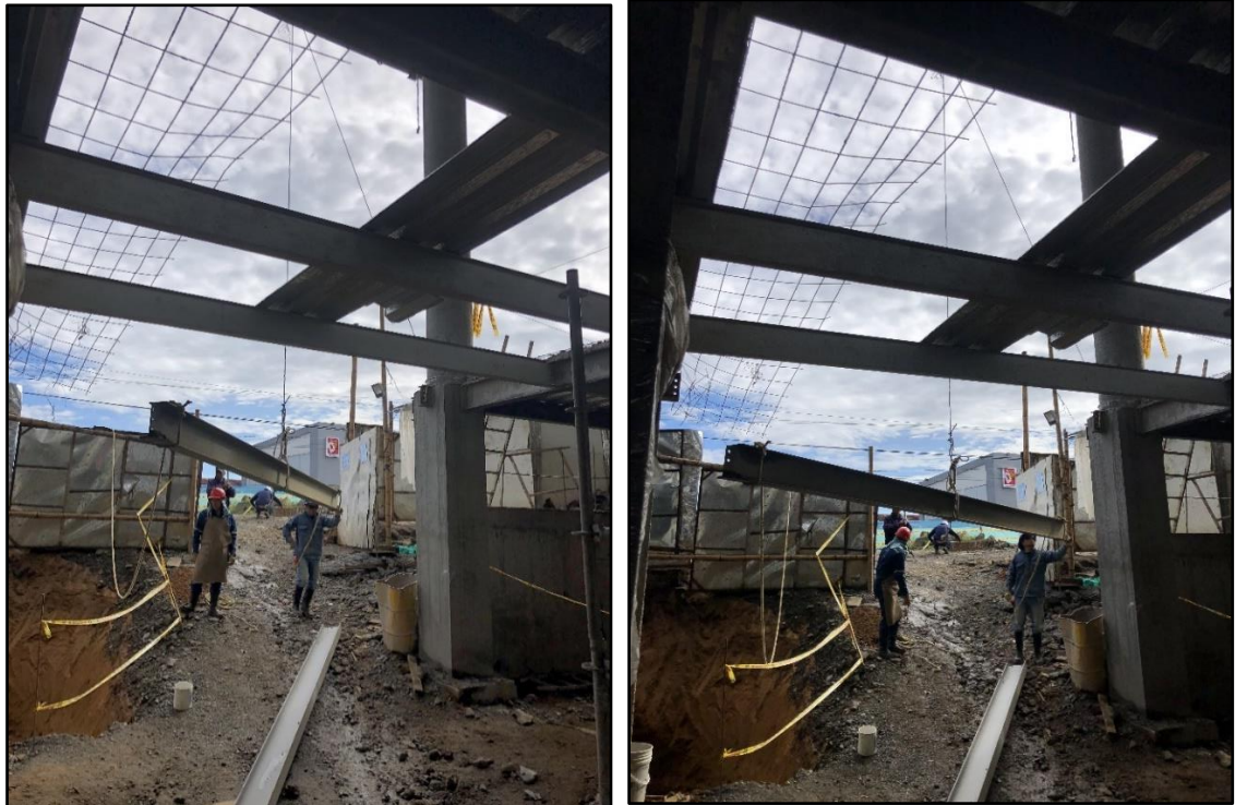
Figura 8. Instalación de vigas. Fuente: tomada por el pasante.
