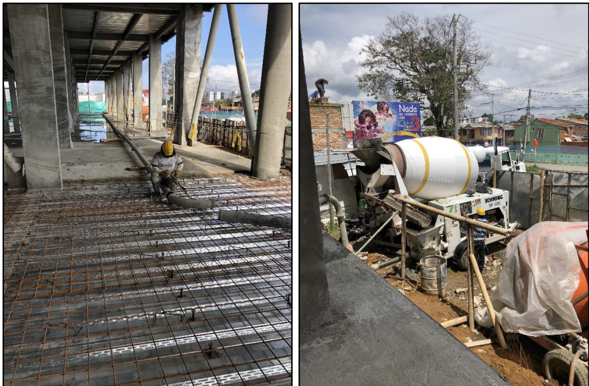
Figura 11. Armado de tubería, autobomba y mixer con concreto premezclado. Fuente: tomada por el pasante.
