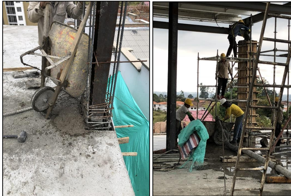
Figura 19. Fundición de columna. Fuente: tomada por el pasante.
