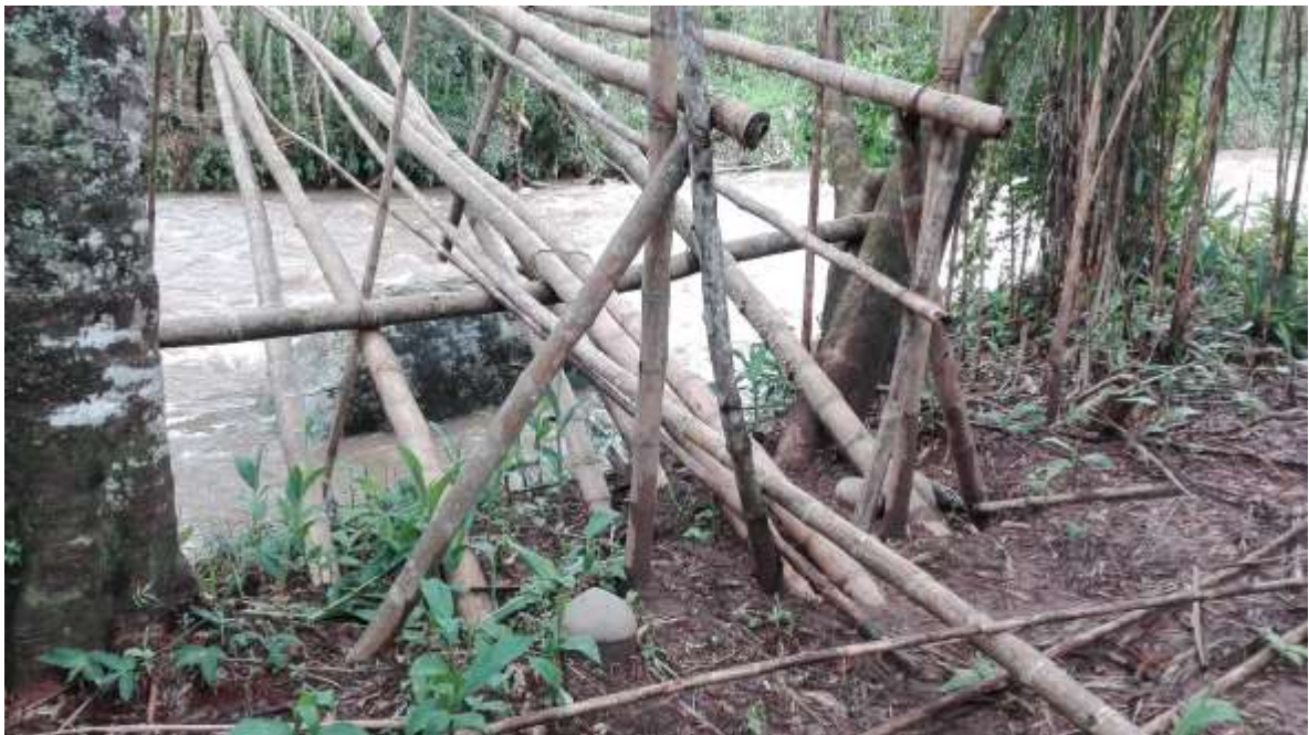
Foto 11. Acceso al puente costado izquierdo aguas abajo
