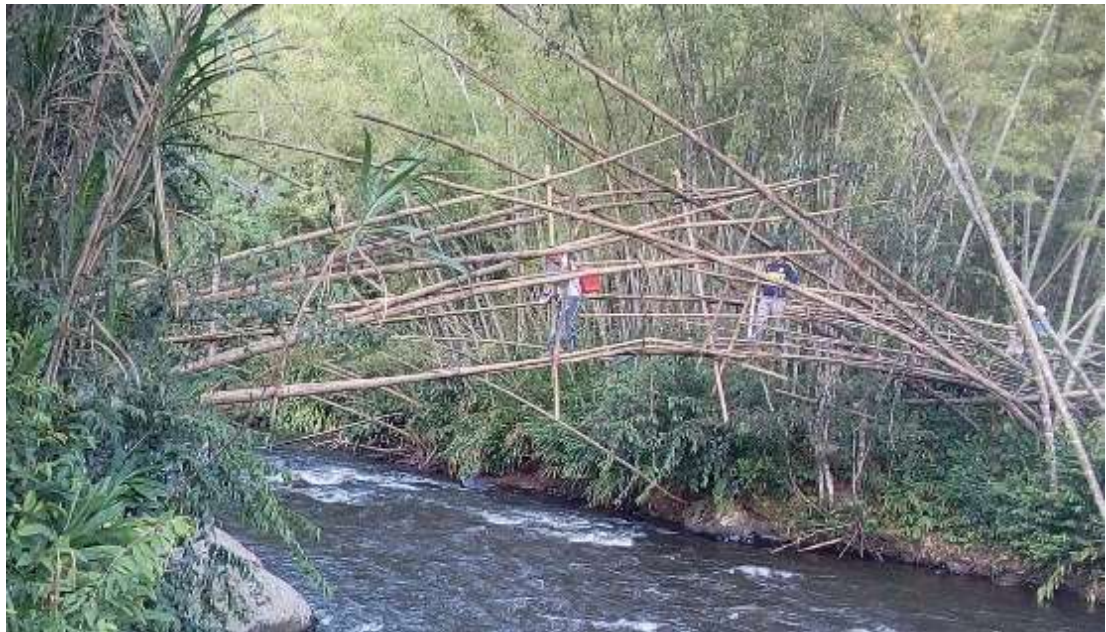
Foto 1. Vista general del puente
