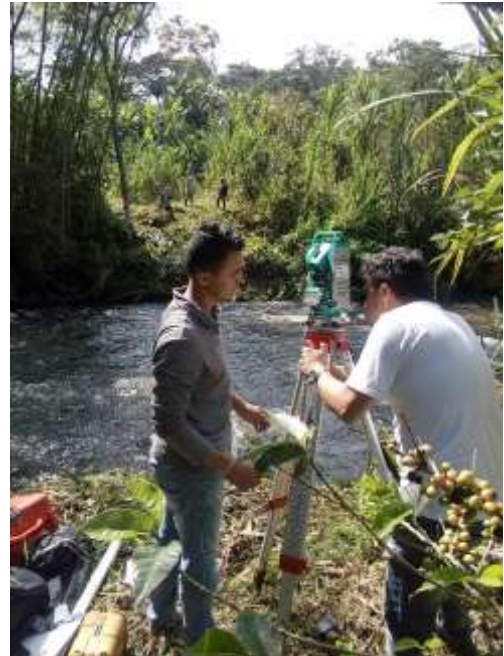
Foto 13. Instalación de equipos de topografía
