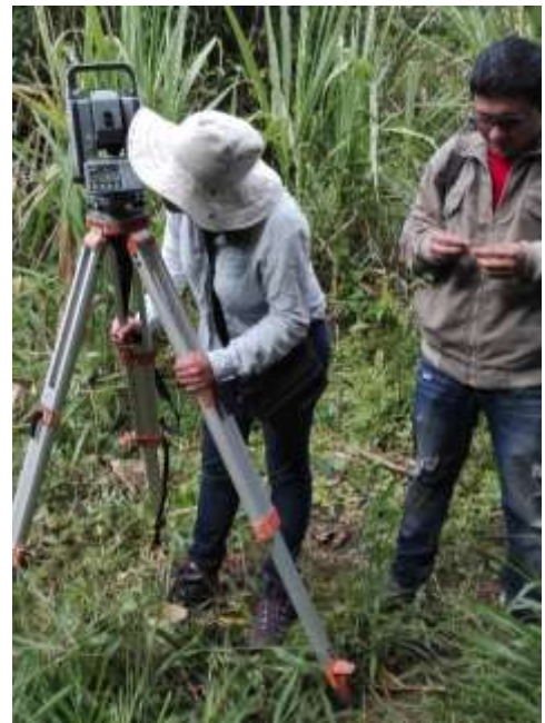
Foto 17. Instalación de estación total
