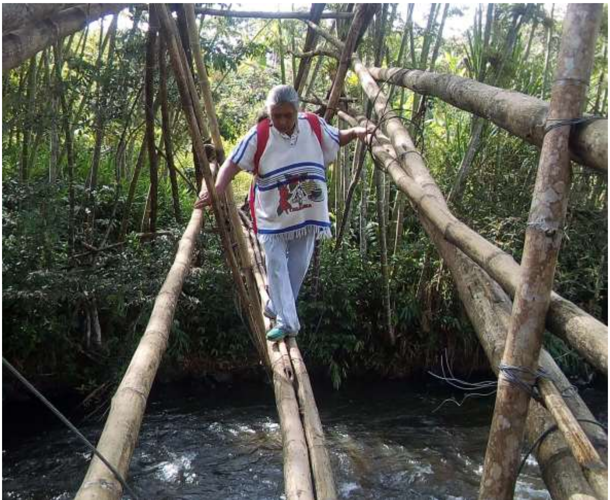
Foto 2. Uso normal del puente
