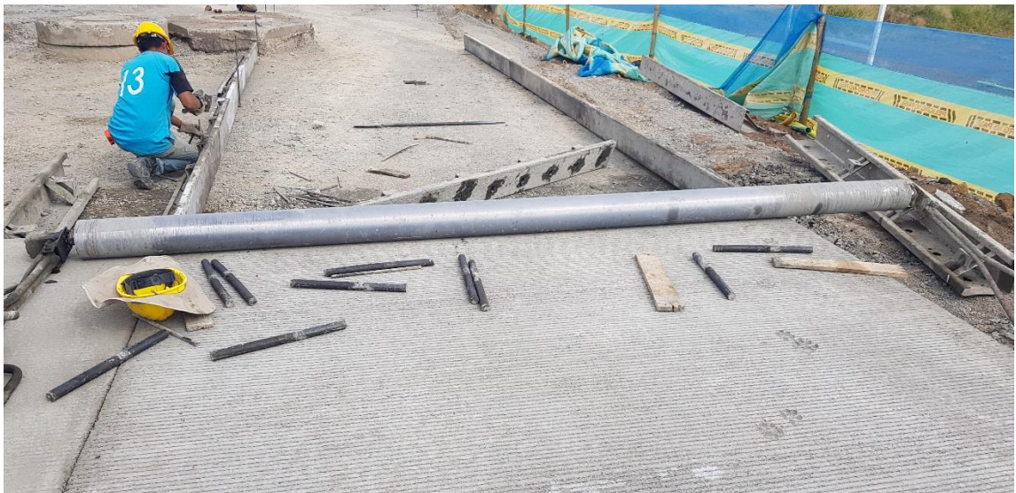
Figura N°25: Instalación de formaletas.
