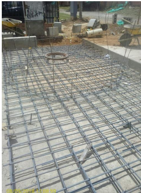
Figura N°22: Refuerzo doble parrilla en construcción de una losa con presencia de cámara de Emtel.
