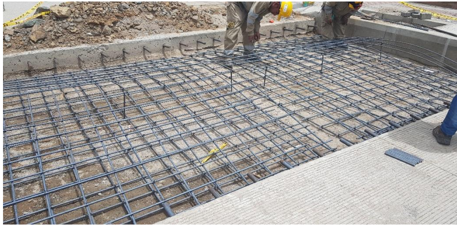
Figura N°23: Refuerzo doble parrilla en construcción de un reductor de velocidad.
