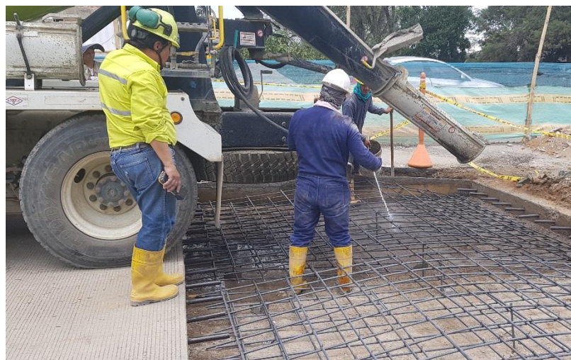
Figura N°24: Riego de agua sobre la superficie (su base) a fundir.
