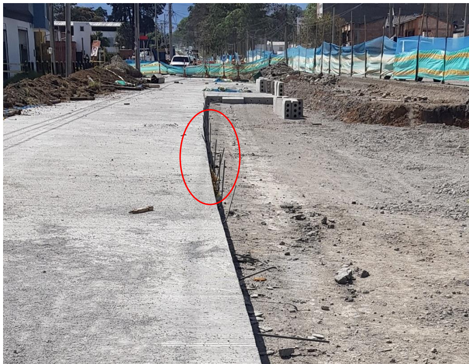
Figura N°19: Barras de amarre (Junta longitudinal) – Carril exterior, calzada norte.
