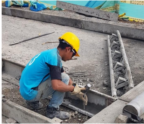
Figura N°26: Empleo de pines para la fijación de las formaleas.
