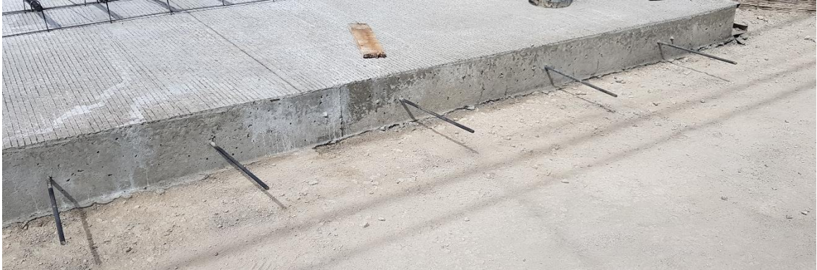
Figura N°18: Barras de amarre.
