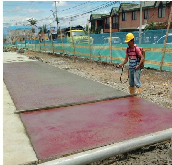
Figura N°38: Aplicación película líquida de Anti sol.
