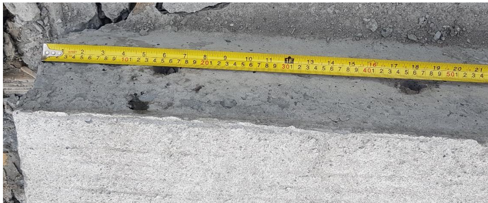
Figura N°17: Verificación separación entre dovelas.
