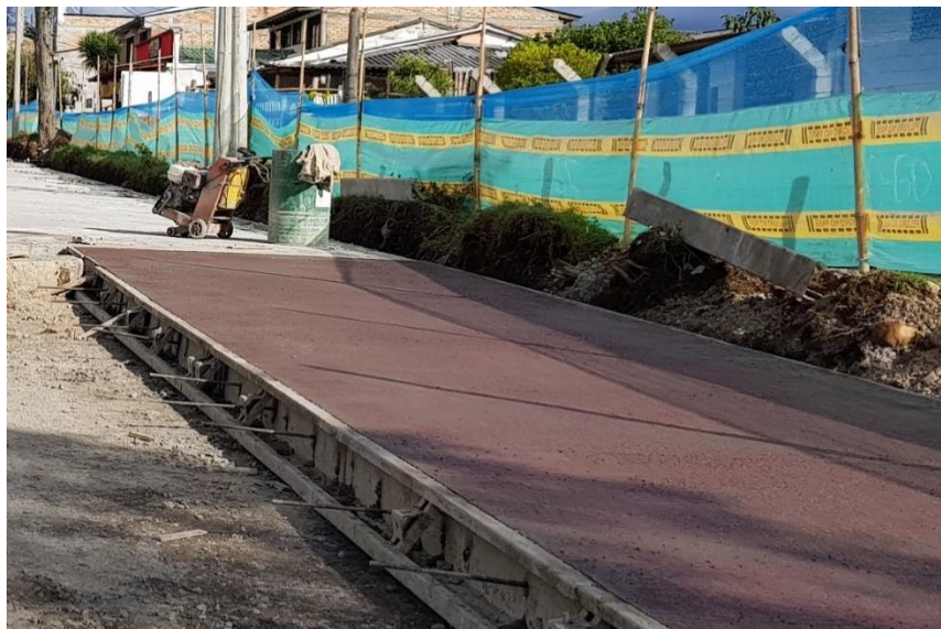
Figura N°37: Curado de losas – Cubrimiento con película líquida.
