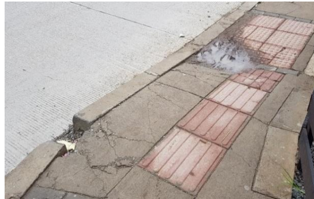
Figura N°54: Losetas destruidas.
