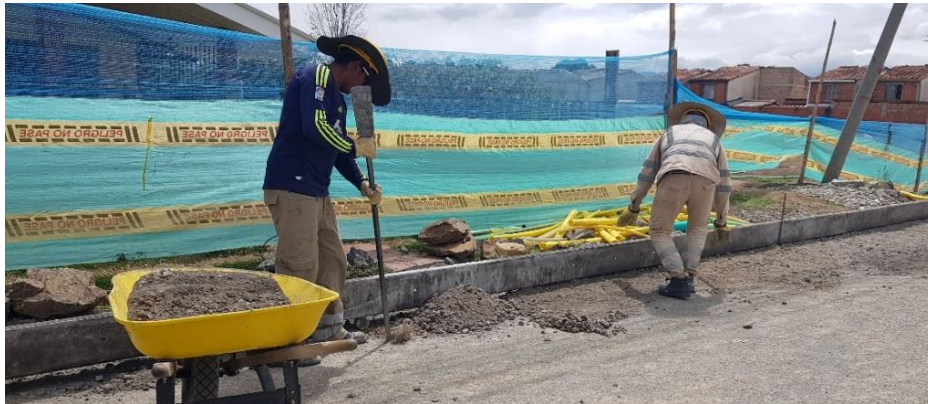
Figura N°59: Proceso de conformación de sub base con herramienta manual.
