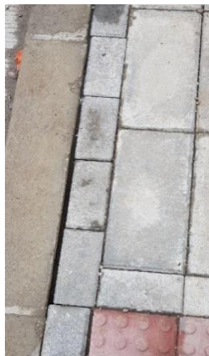
Figura N°56: Alineación adoquines.
