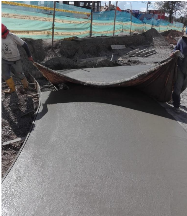
Figura N°31 y N°32: Proceso de Micro texturizado.
