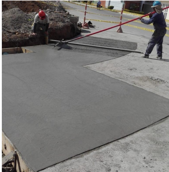
Figura N°33: Proceso de Macro texturizado.
