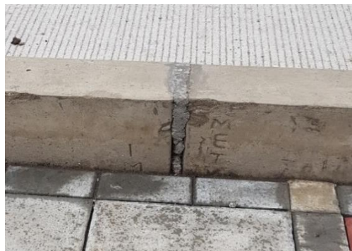
Figura N°55: Juntas entre bordillos borde de vía.
