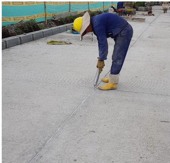
Figura N°43: Sello de juntas - Aplicación de silicona autonivelante.
