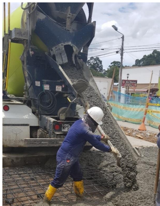
Figura N°27: Colocación del concreto.
