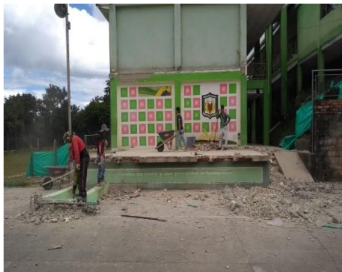
Ilustración 9: Demoliciones vigas existentes.
