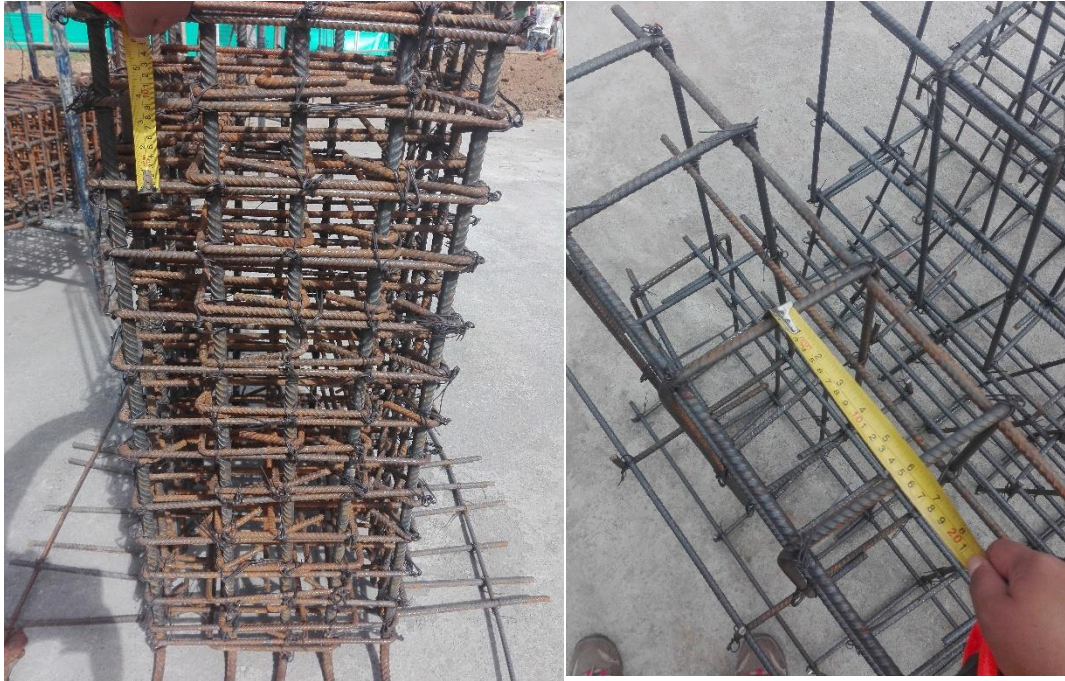
Ilustración 20: Verificación separación de acero.
