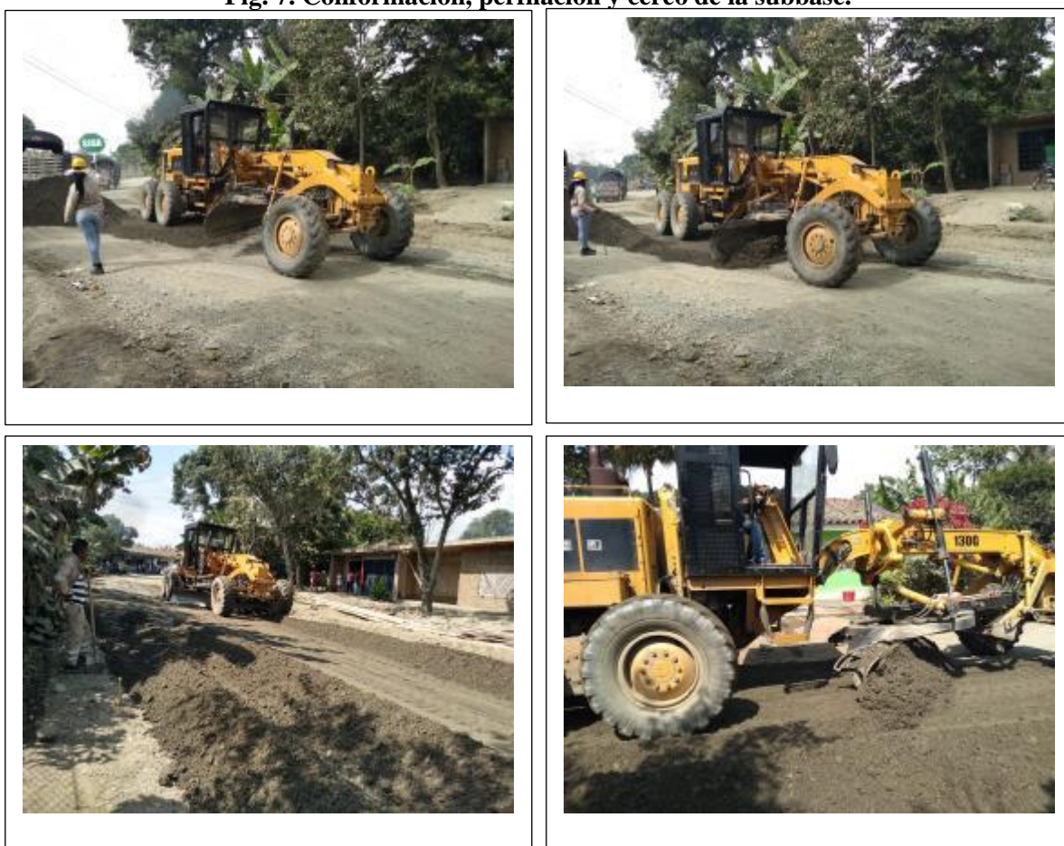
Fig. 7. Conformación, perfilación y céreo de la subbase.
