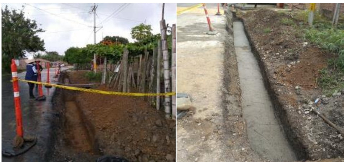
Fig. 51. Excavación del terreno y solado para ejecución de muro de contención
