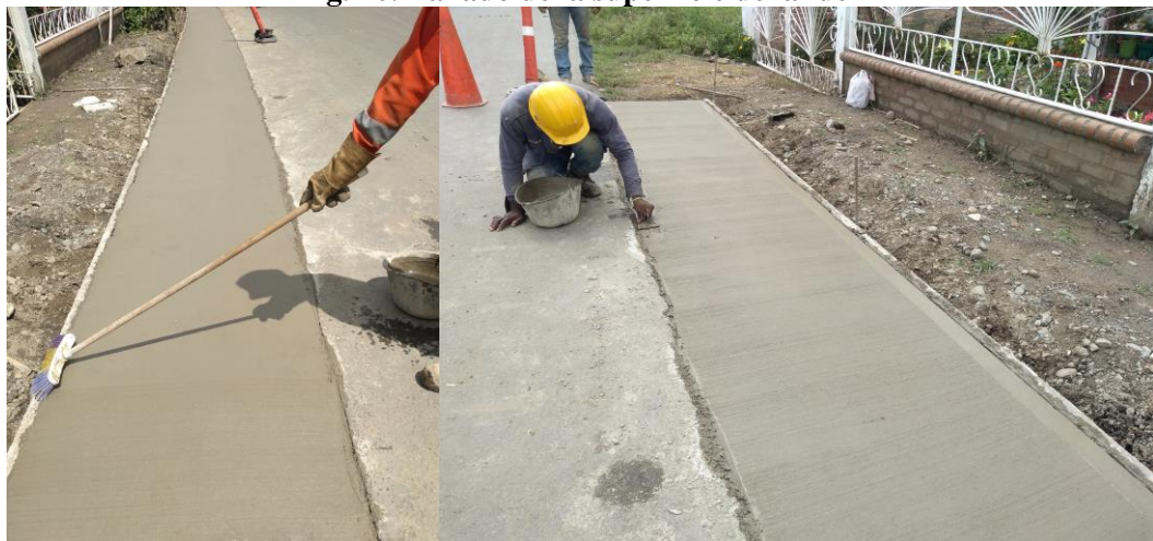
Fig. 40. Tallado de la superficie del andén
