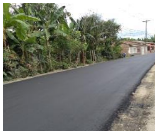
Fig. 34. Capa asfáltica terminada
