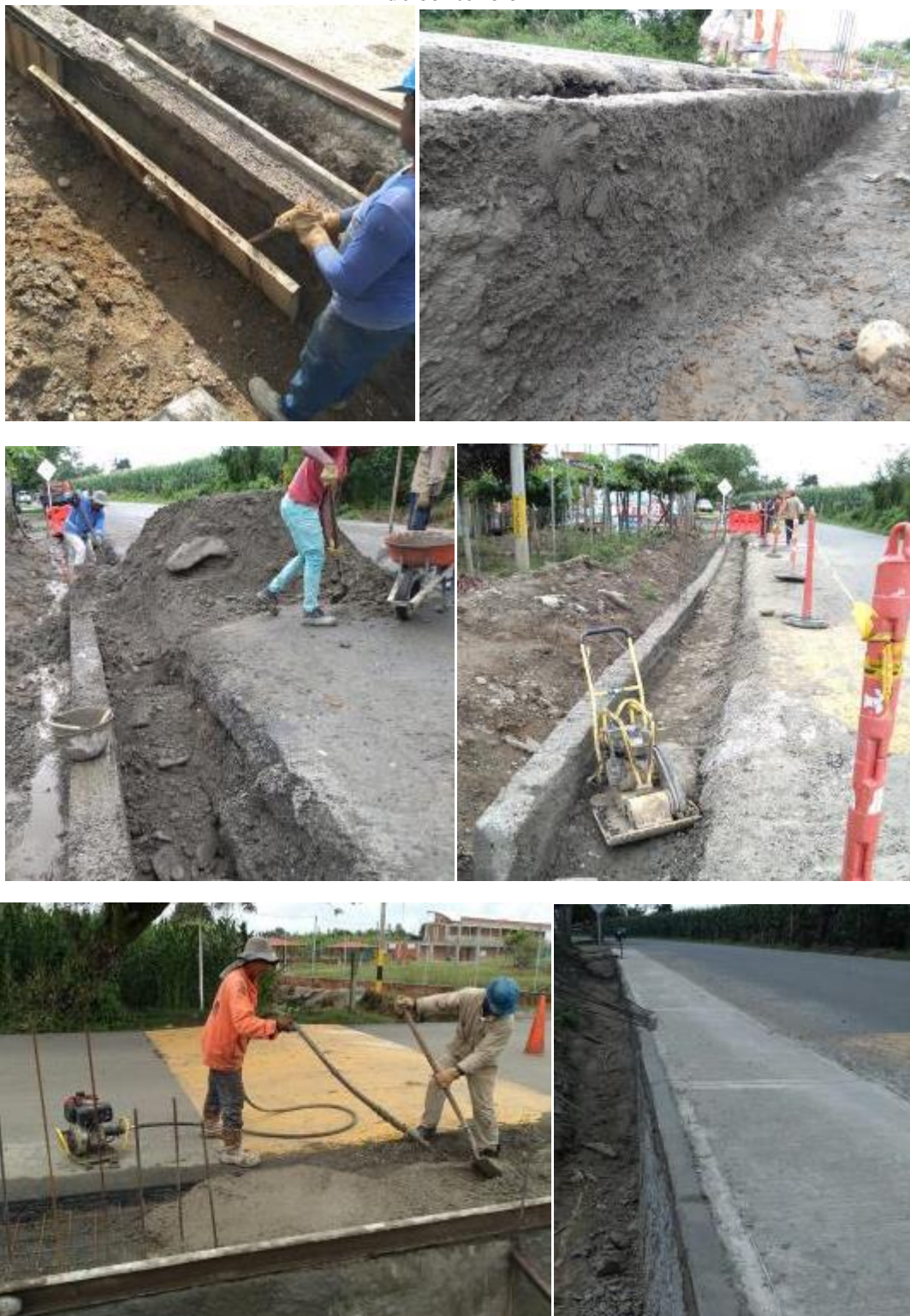
Fig. 56. Desencofrado, pulido, relleno, compactación y elaboración de andén para el muro de contención
