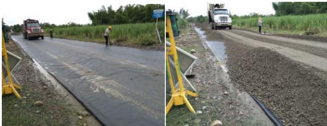
Fig. 22. Instalación de capa de subbase
