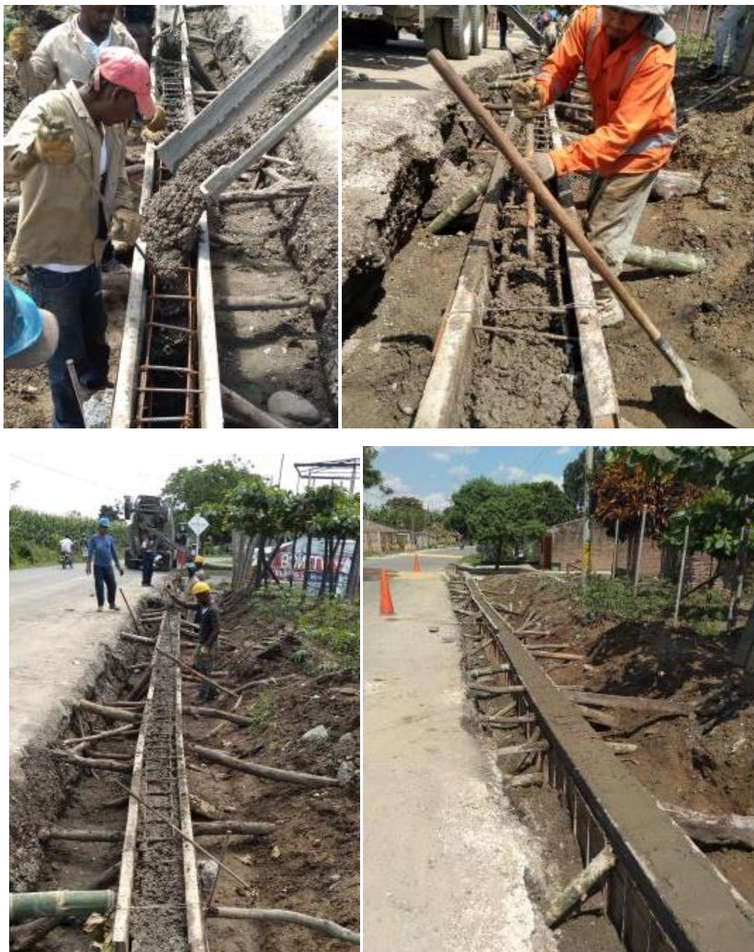
Fig. 55. Fundición de muro de contención.
