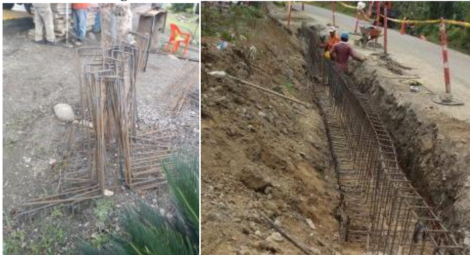
Fig. 52. Refuerzo del muro de contención
