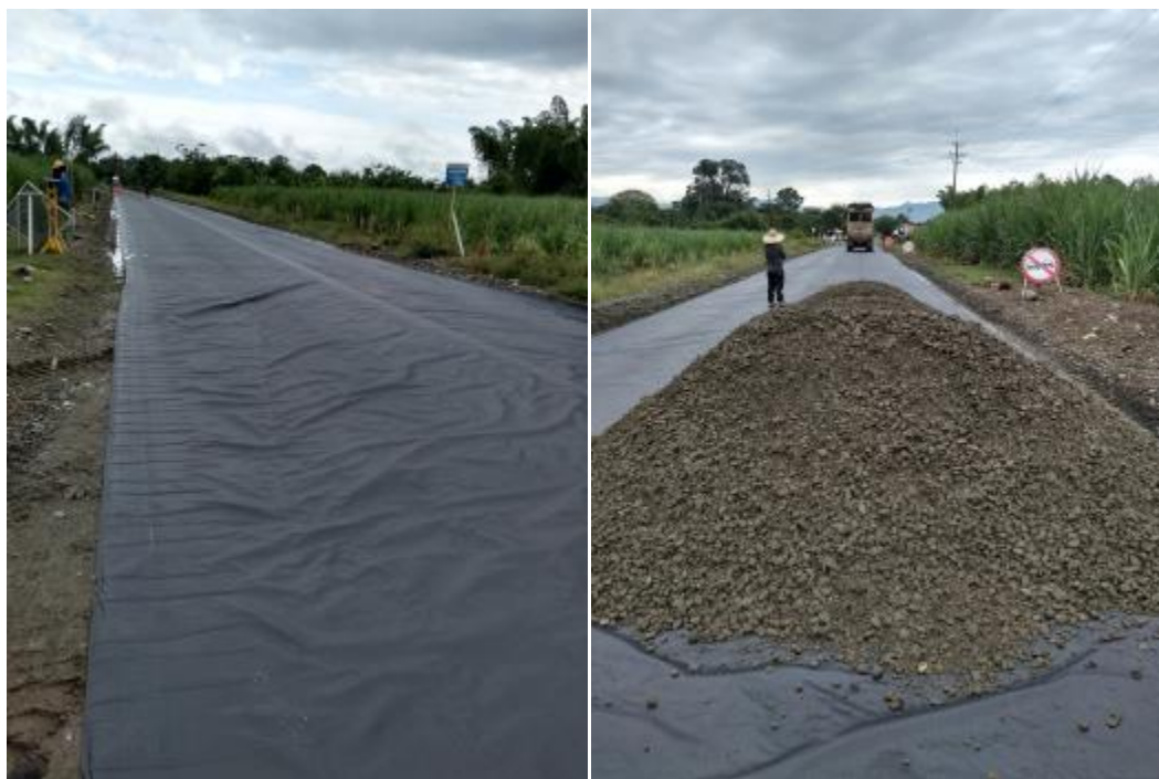
Fig. 21. Extensión de geotextil tejido
