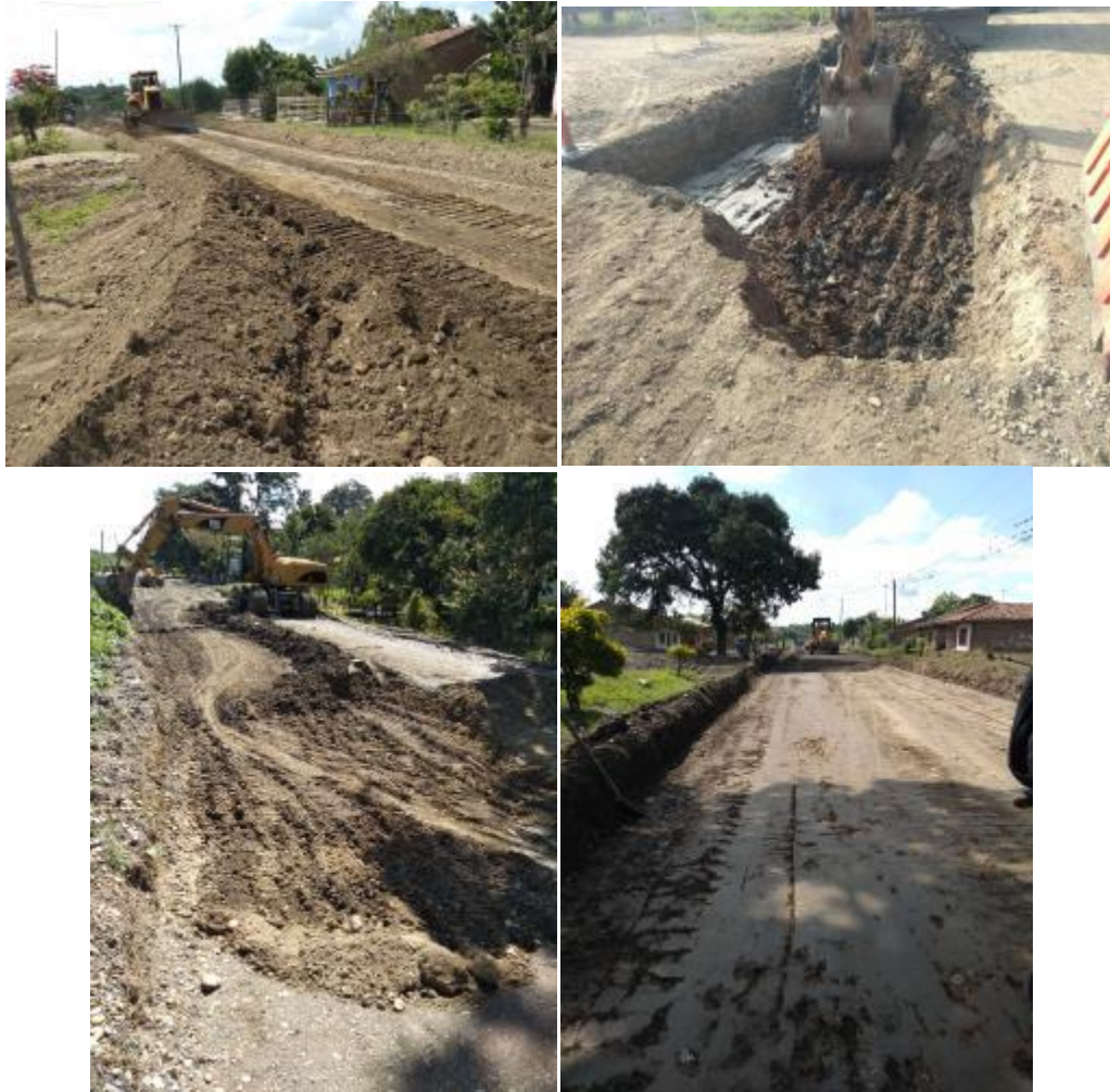
Fig. 19. Excavacion y perfilación de subrasante
