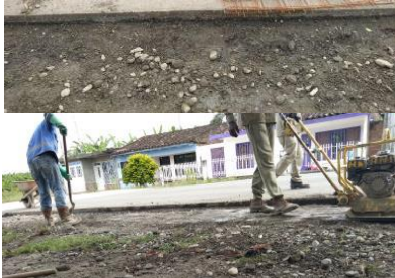
Fig. 36. Excavación, relleno y compactación para elaboración de andenes
