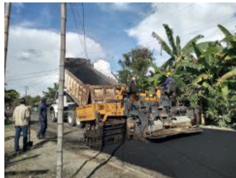
Fig. 31. Vaciado de la mezcla asfáltica
