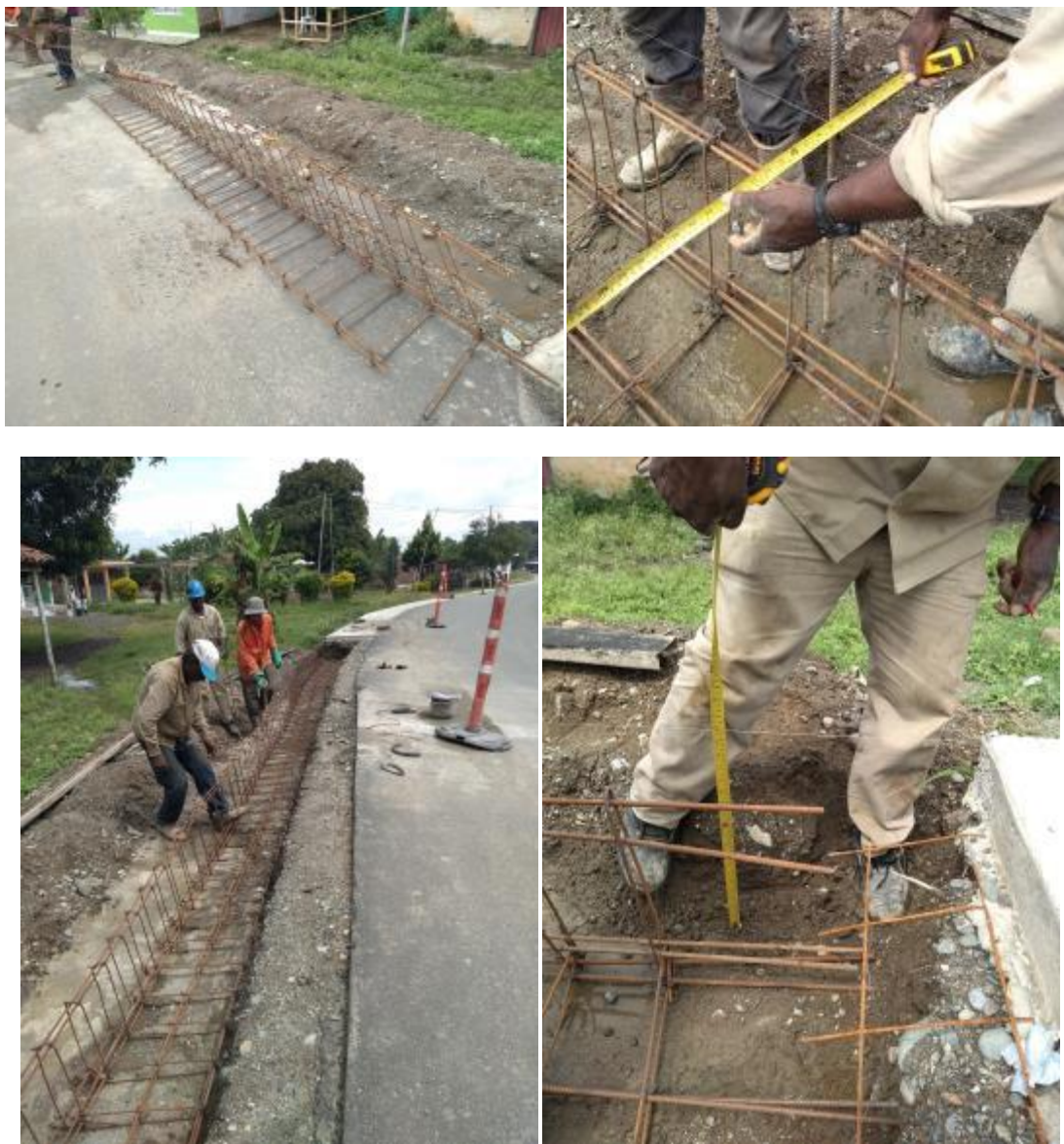
Fig. 44. Instalación de refuerzo del bordillo con zarpa
