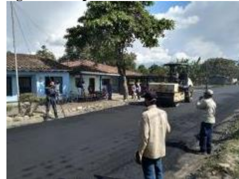
Fig. 32. Compactación rodillo metálico.
