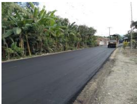
Fig. 33. Compactación con rodillo neumático
