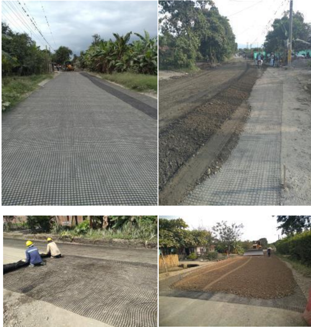
Fig. 27. Extensión de geomalla e instalación de base.
