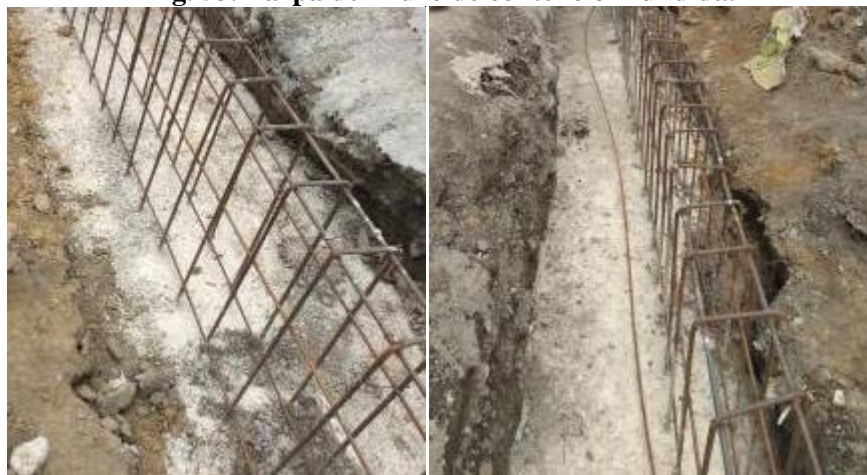
Fig. 53. Zarpa del muro de contención fundida.
