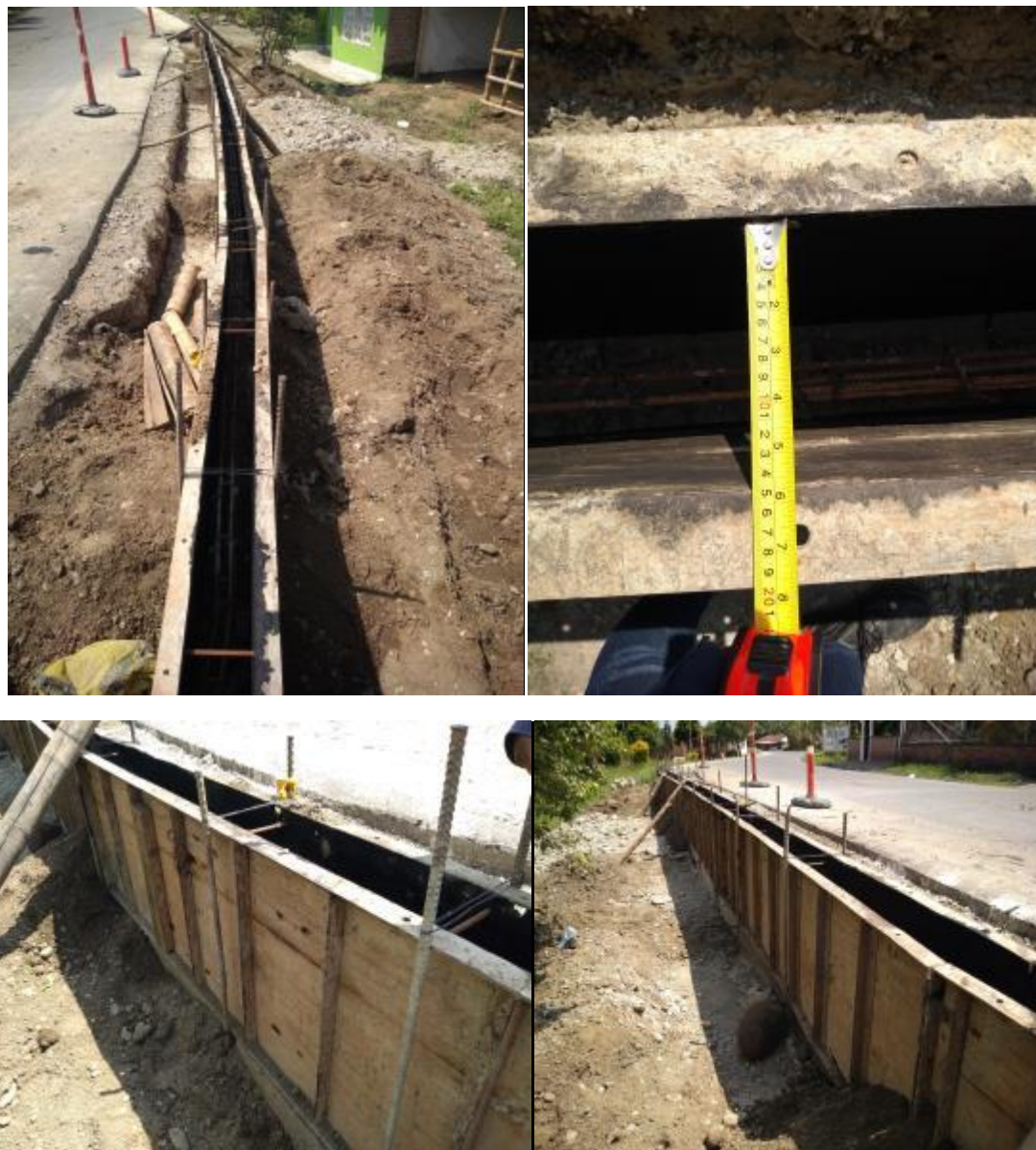
Fig. 47. Encofrado y atracado de bordillo
