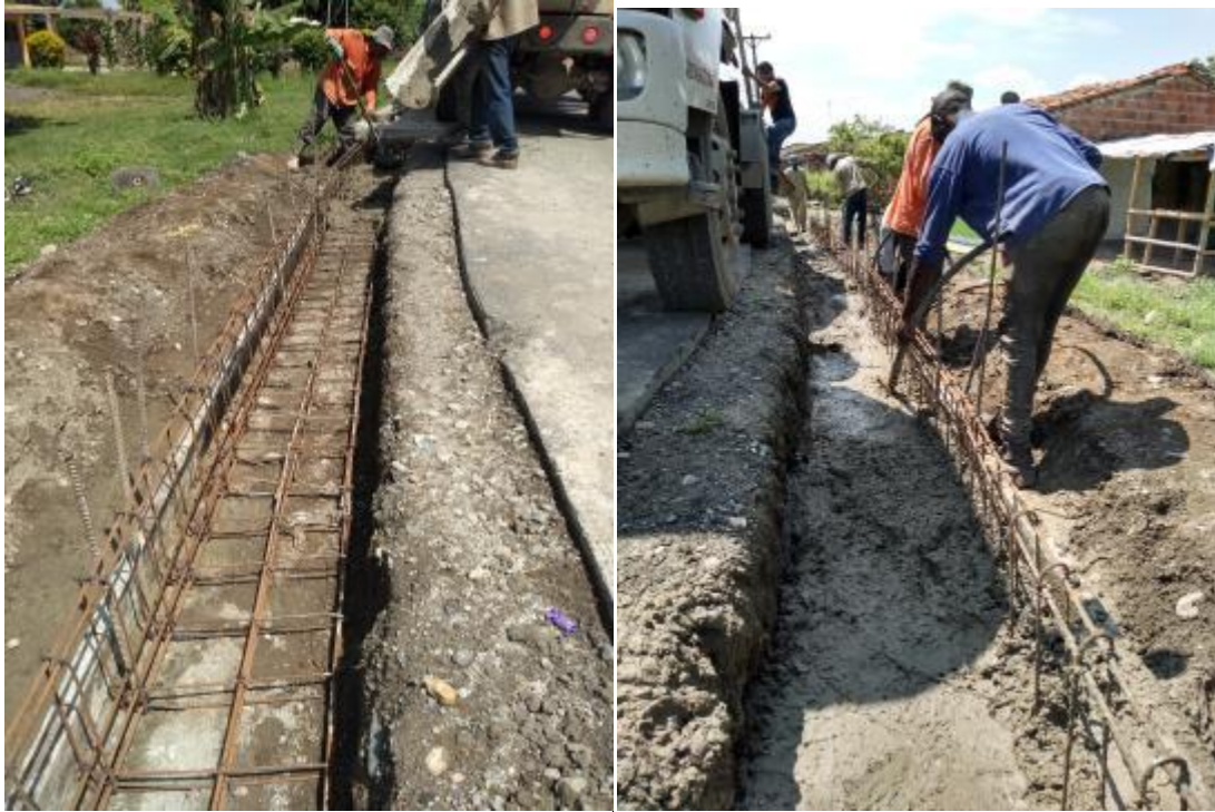
Fig. 46. Vaciado y vibrado de concreto para zarpa de bordillo
