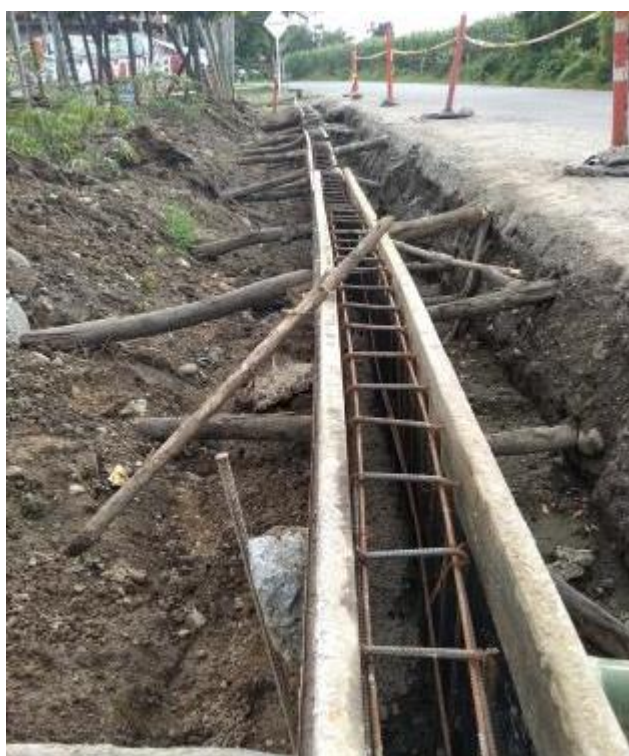
Fig. 54. Formaleta para la pantalla del muro de contención
