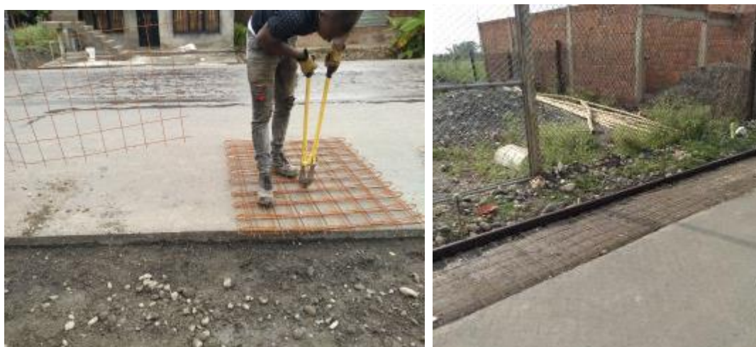
Fig. 38. Corte e instalación de refuerzo para concreto andén.
