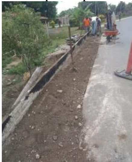
Fig. 48. Relleno y compactación con material de préstamo para bordillo
