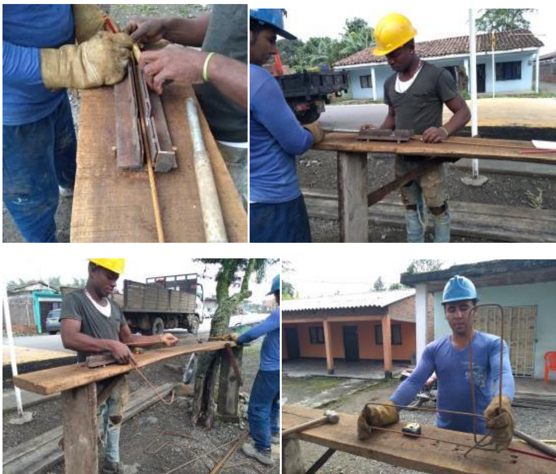
Fig. 43. Flejado de acero para refuerza transversal del bordillo con zarpa
