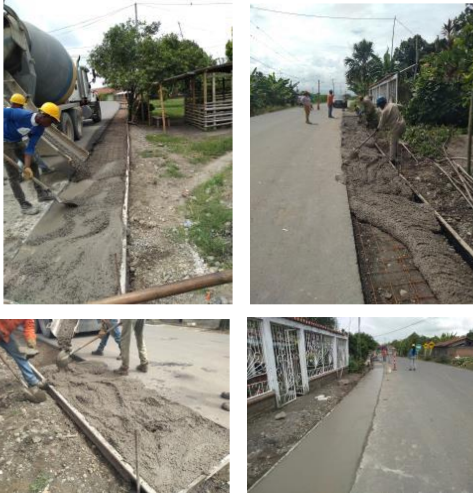
Fig. 39. Fundición de andenes en concreto de 3000 PSI
