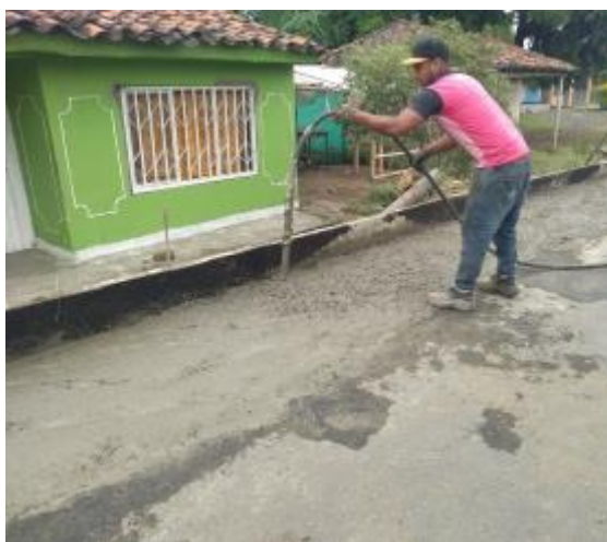
Fig. 49. Ejecución de andén sobre bordillo con zarpa
