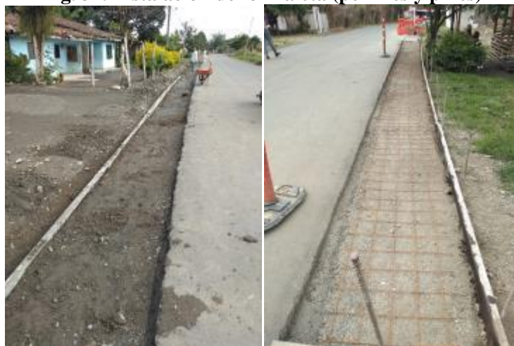
Fig. 37. Instalación de formaleta (perlines y pines)
