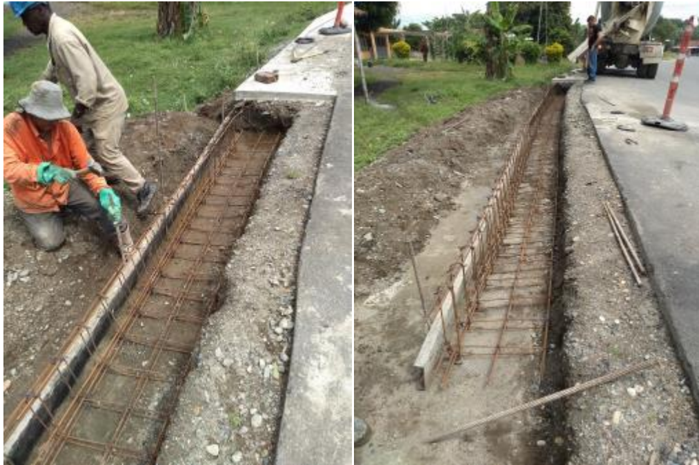
Fig. 45. Instalación de formaleta para fundición de la zarpa perteneciente al bordillo
