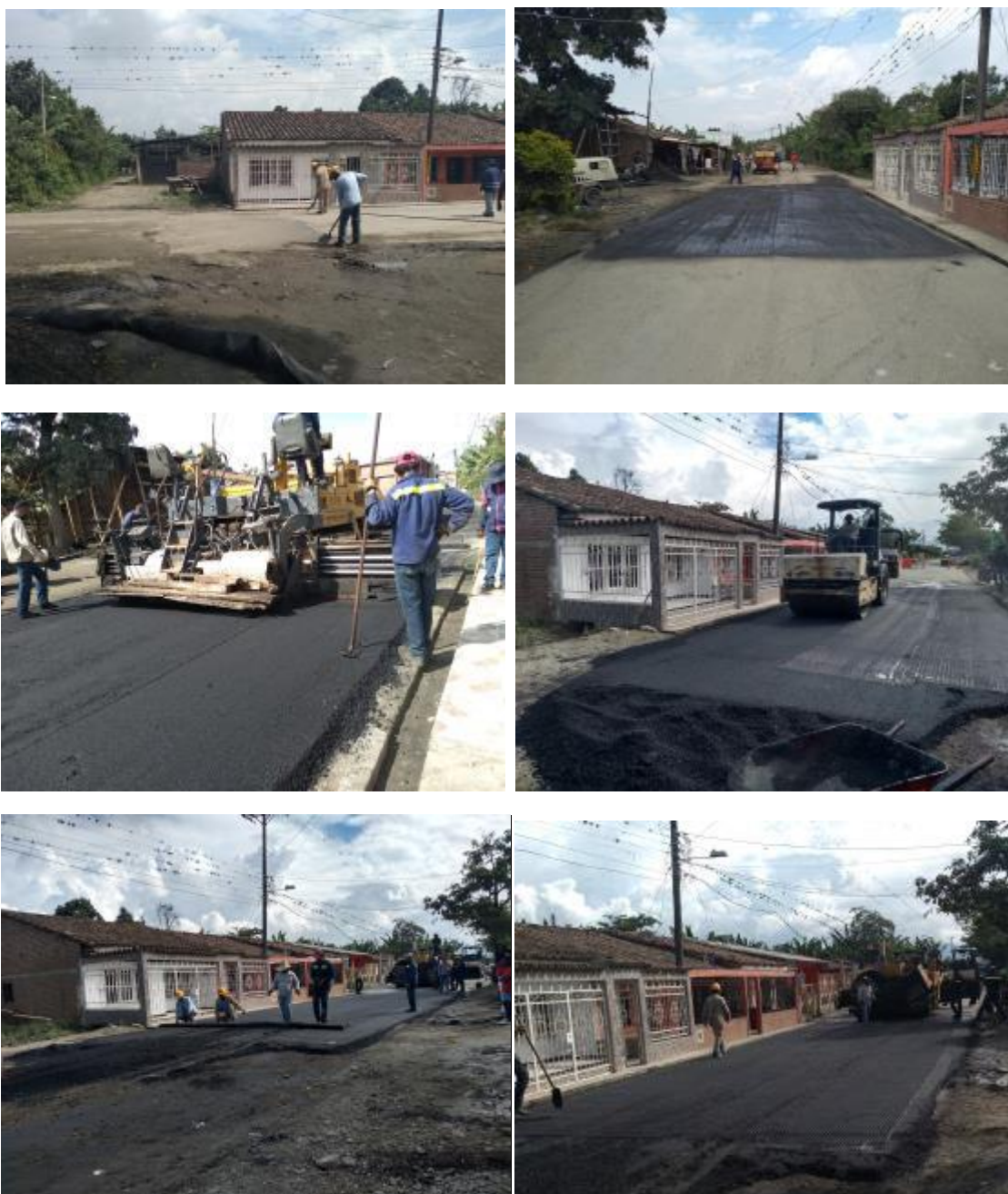
Fig. 29. Limpieza, imprimación y renivelación de carpeta asfáltica existente desde el empalme
