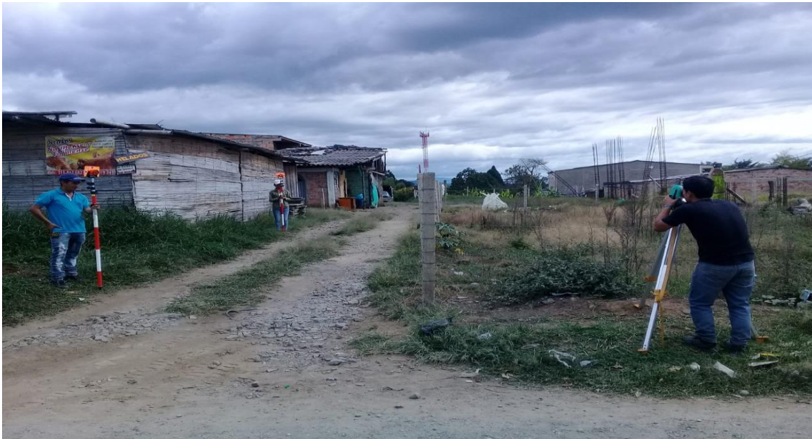
Figura 12. Toma de detalles con Estación Total
