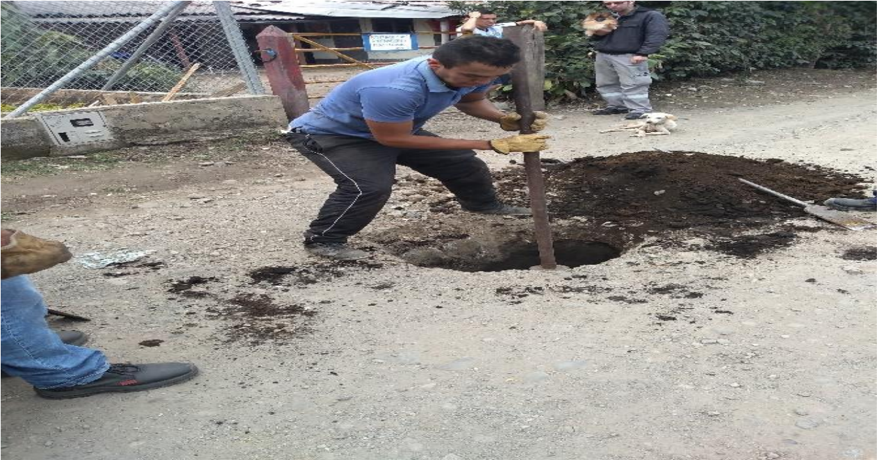
Figura 27. Excavación Abscisa k0+ 160
