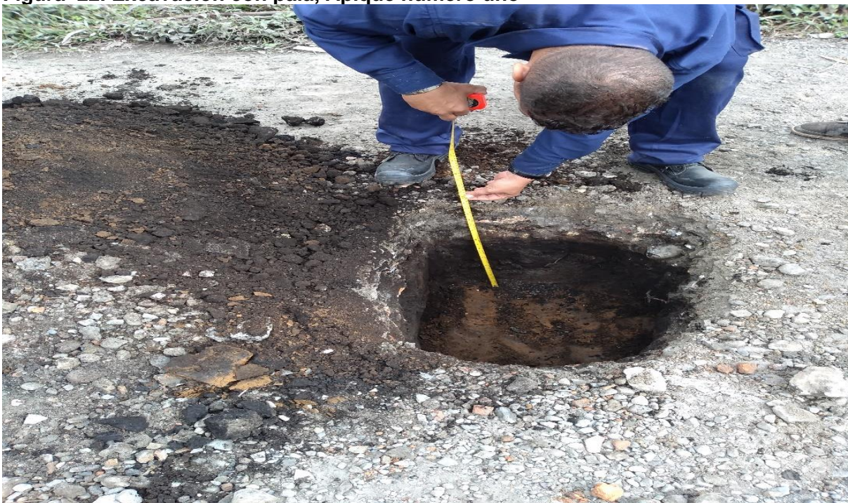
Figura 22. Excavación con pala, Apique número uno
