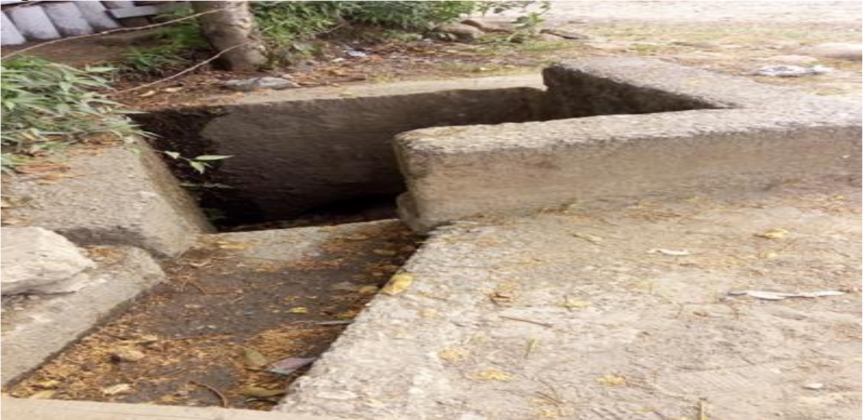
Figura 52. Alcantarilla existente en el sector
