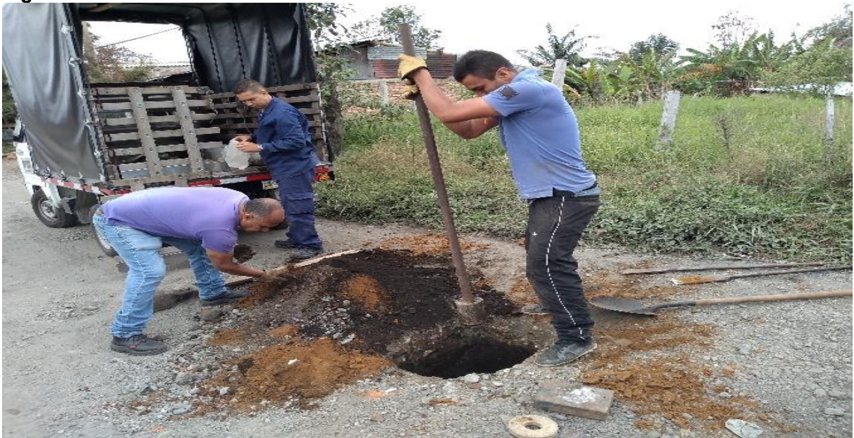
Figura 26. Excavación Abcisa k0+ 060
