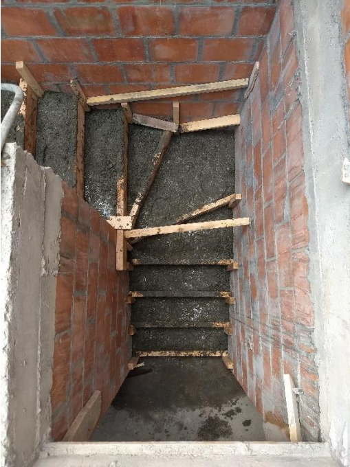
Figura 81. Fundición gradas
