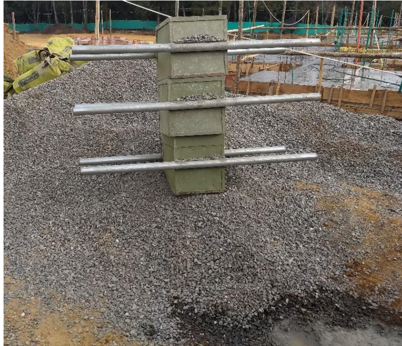
Figura 24. Cajones para agregados
