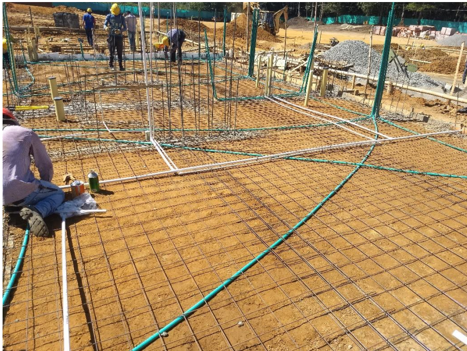
Figura 51. Tendido de instalaciones
