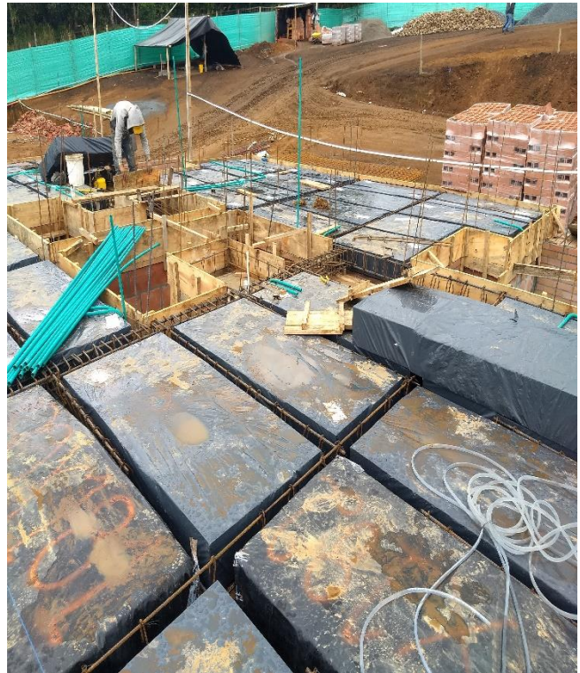
Figura 63. Colocación de casetones
