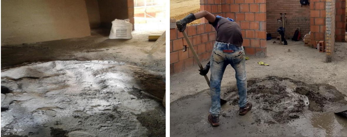
Figura 85. Mezcla manual mortero de pega
