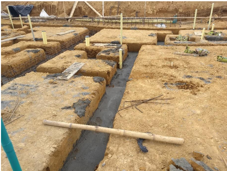
Figura 42. Solado de limpieza
