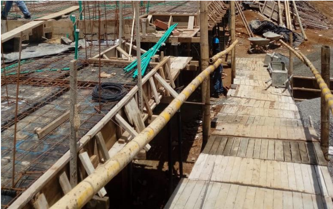
Figura 70. Rampa madera para ascenso del concreto
