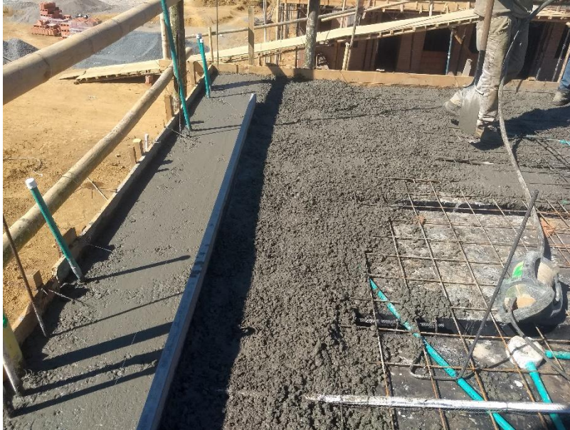
Figura 73. Nivel de losa con hilo guía
