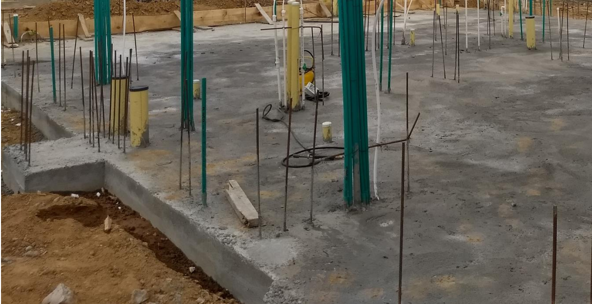
Figura 88. Refuerzo vertical en varilla 3/8" y anclajes
