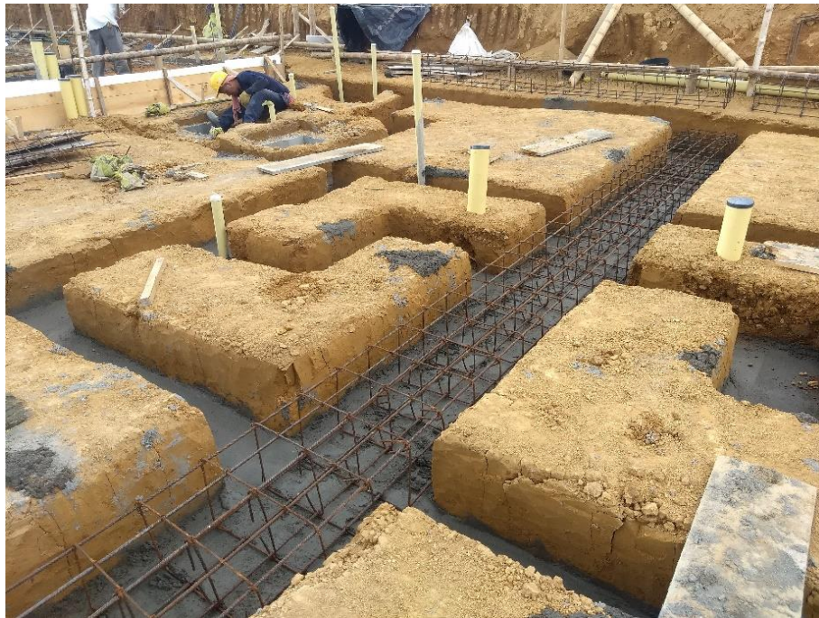
Figura 43. Colocación del refuerzo en vigas
