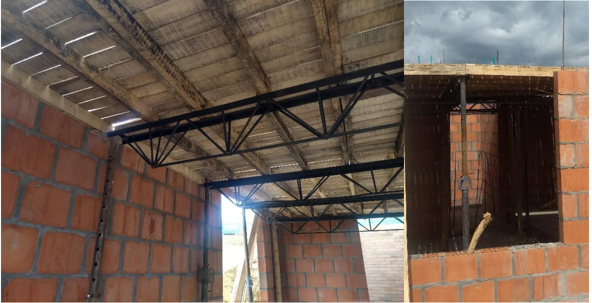
Figura 53. Entablero para losa
