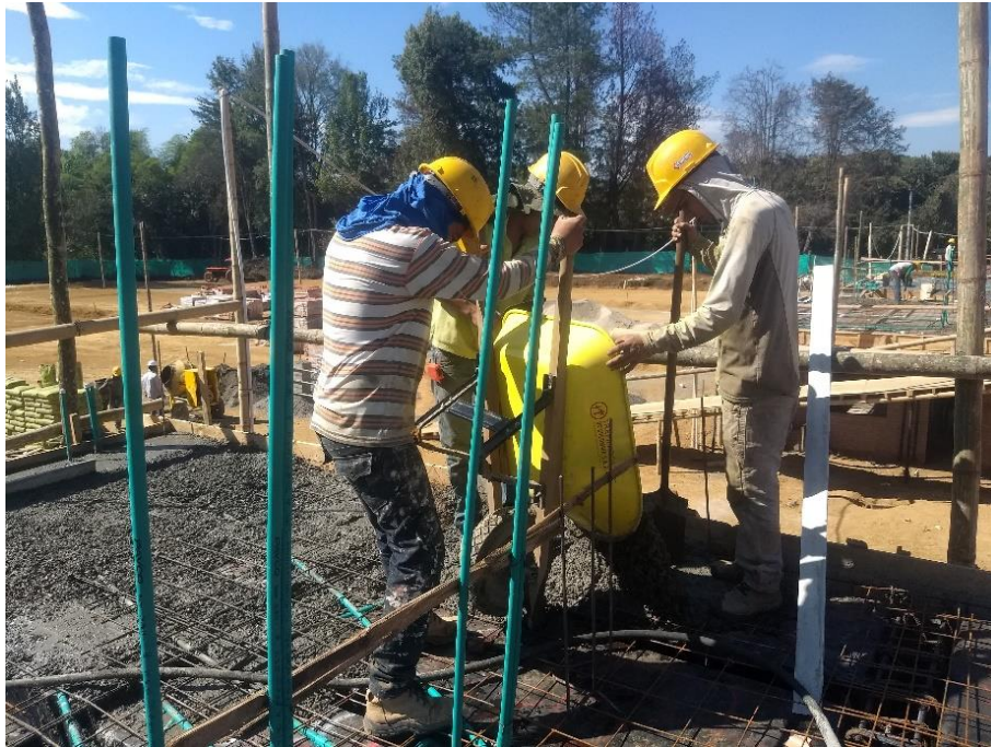
Figura 71. Vaciado del concreto en losa
