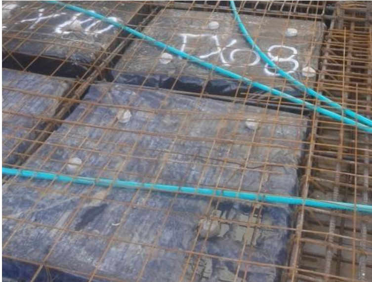
Figura 64. Tubería eléctrica embebida en la losa
