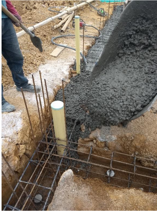
Figura 48. Vaciado en Vigas
