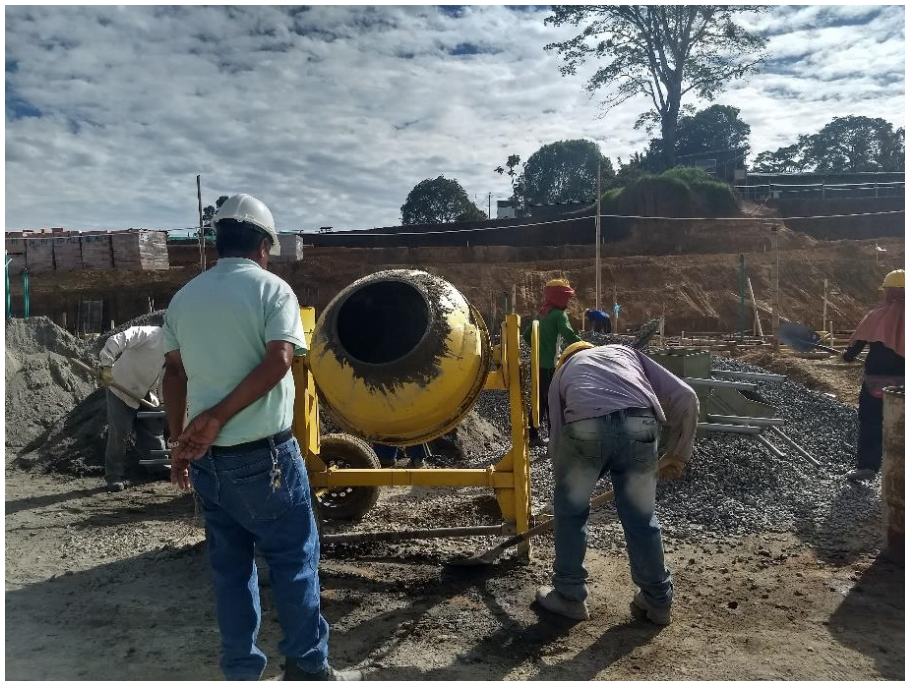
Figura 47. Preparación del concreto
