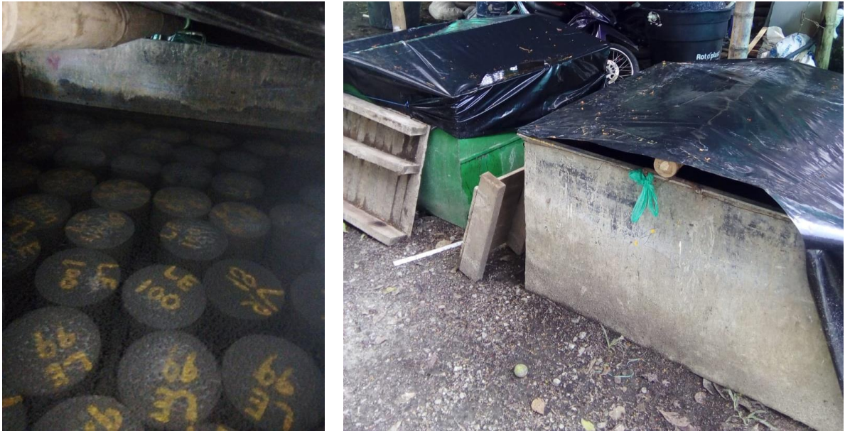
Figura 31. Curado de cilindros de concreto
