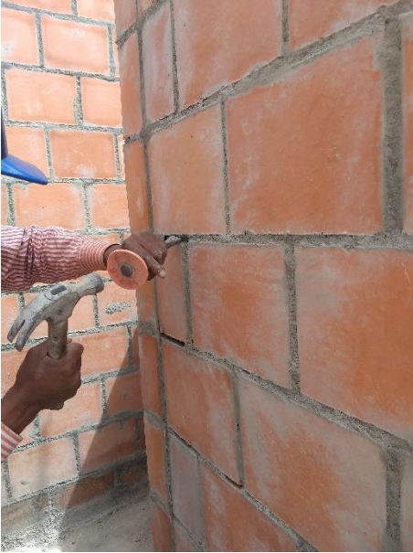
Figura 98. Chequeo de Grafiles
