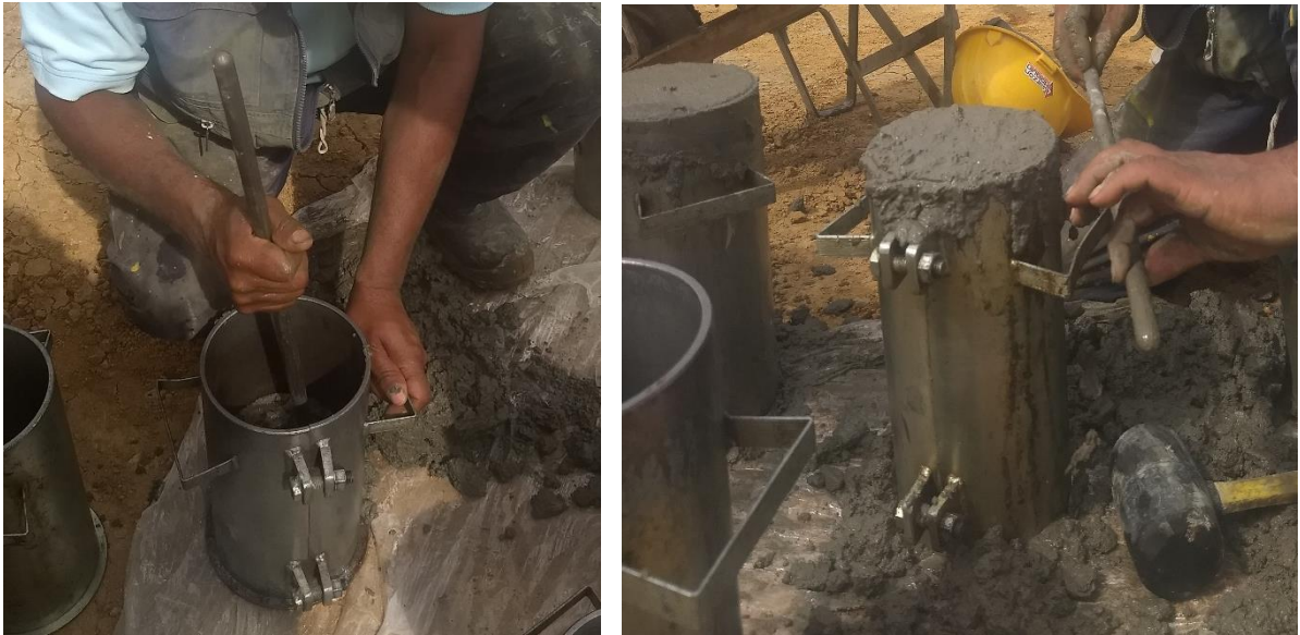
Figura 30. Toma de cilindros de concreto
