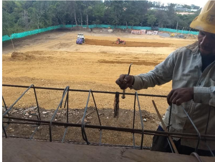
Figura 55. Flejado del acero de refuerzo para vigas
