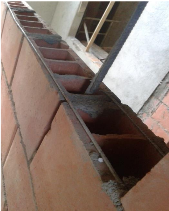
Figura 86. Referencia grafiles cada dos hiladas
