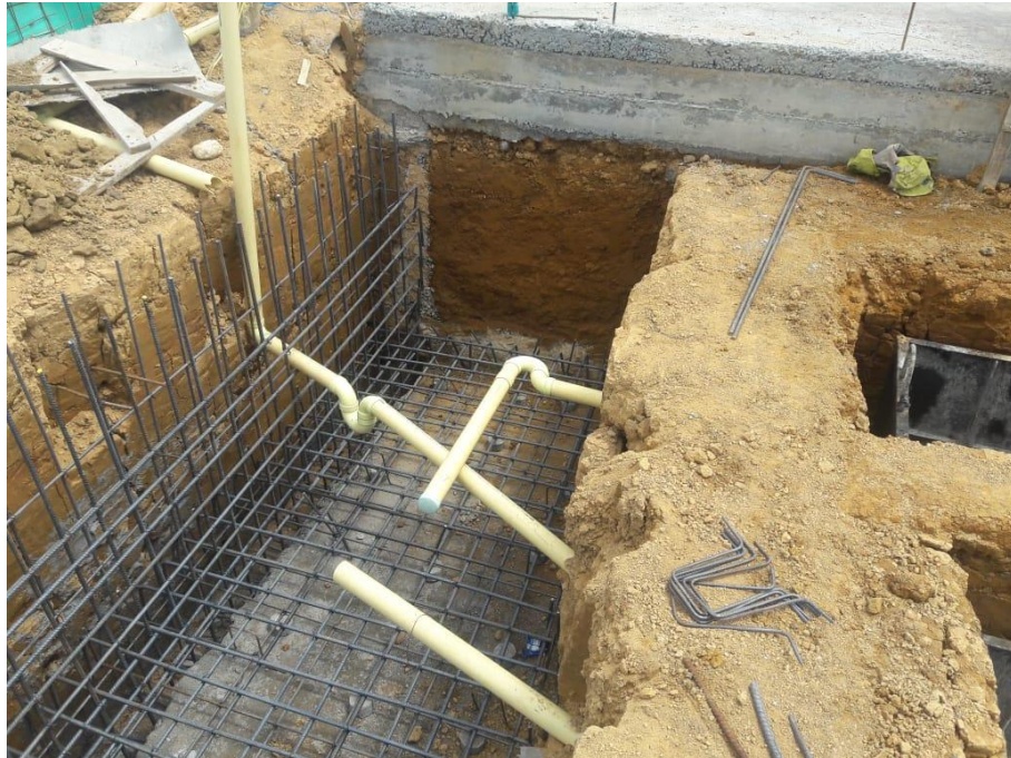
Figura 32. Aceros del muro
