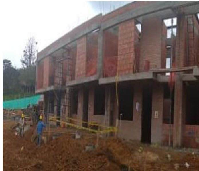
Figura 105. Señalización de excavaciones
