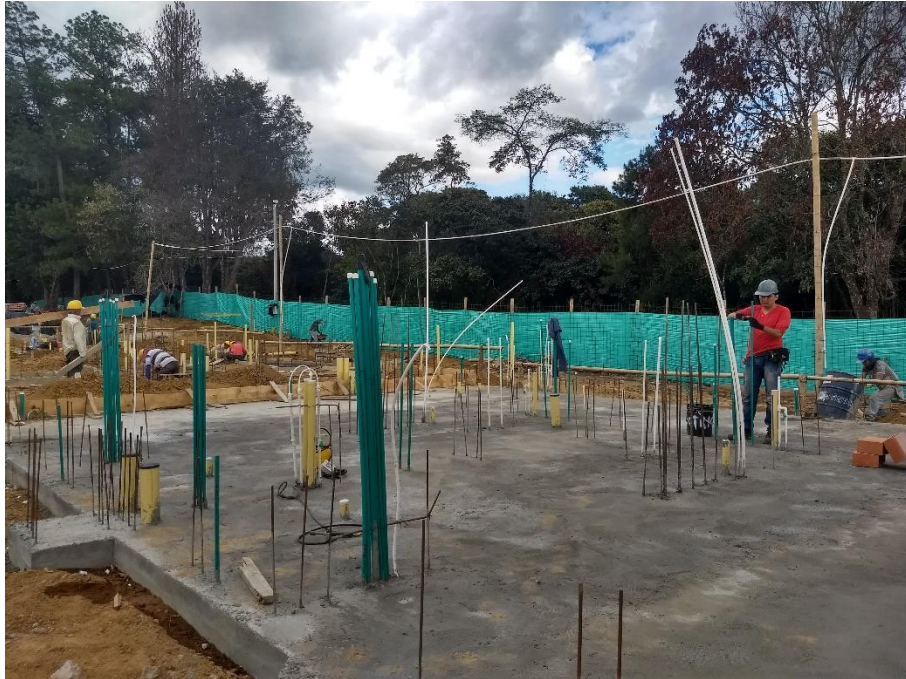
Figura 52. Losa de cimentación terminada
