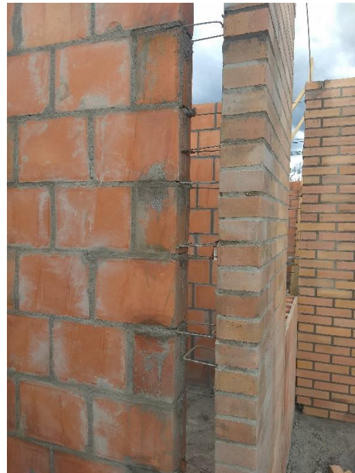
Figura 87. Conectores entre muros
