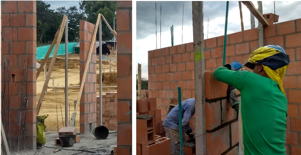
Figura 93. Escuadras y plomos en la construcción de muros
