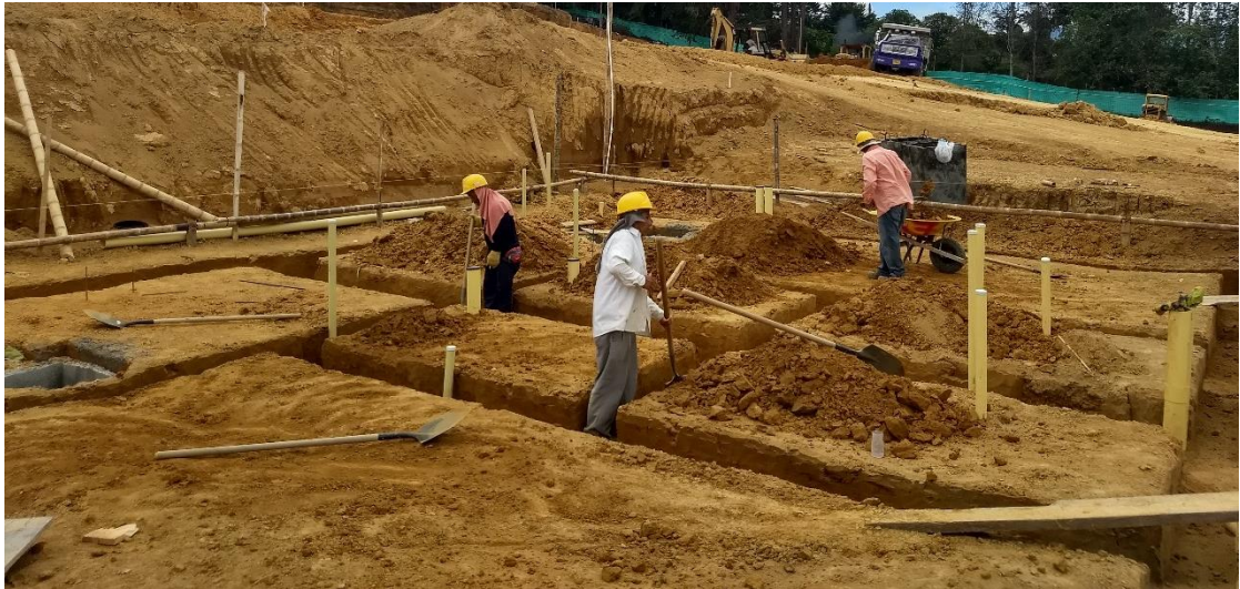
Figura 41. Excavación de vigas de cimentación
