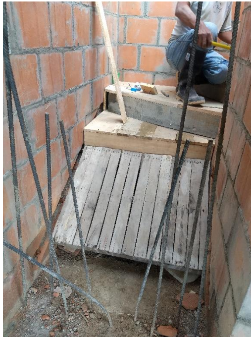
Figura 79. Encofrado escalera
