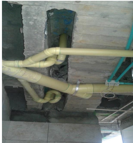
Figura 67. Red hidráulica por cielo
