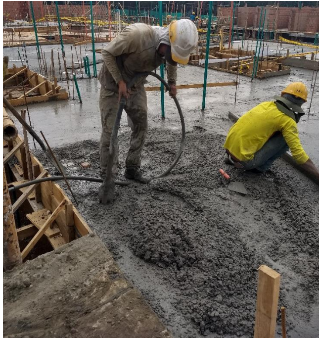
Figura 72. Vibrada losa de entrepiso
