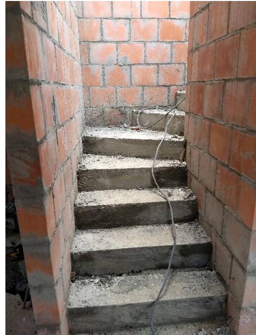
Figura 82. Escalera desencofrada
