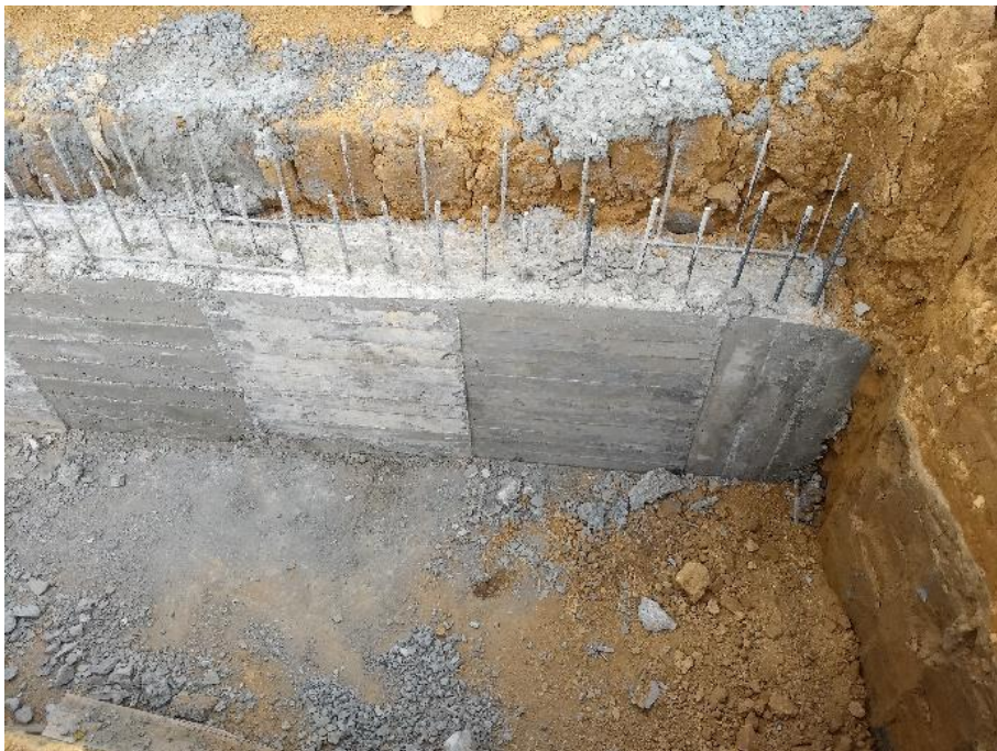
Figura 38. Desencofrado en pantalla
