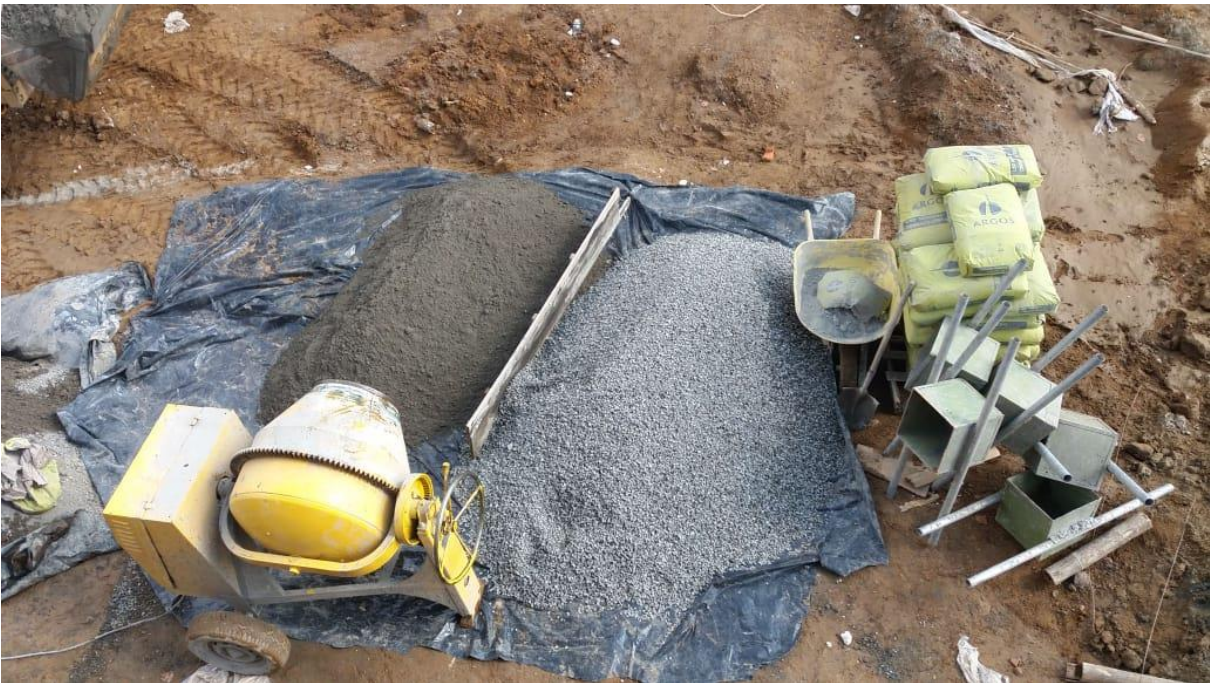
Figura 69. Materiales para fundición de losas
