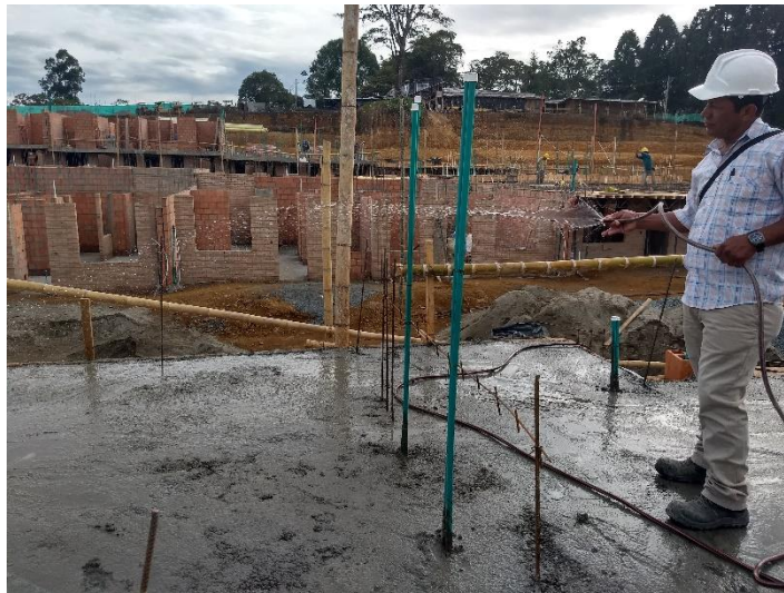
Figura 76. Curado de losas
