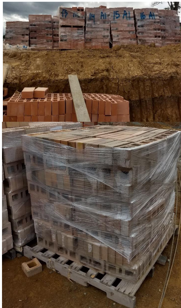
Figura 84. Almacenamiento del ladrillo
