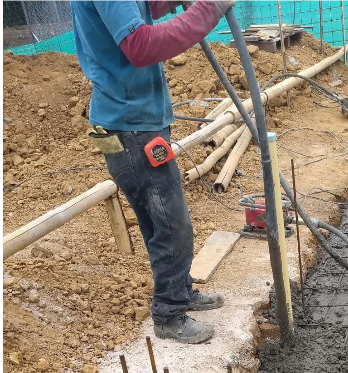
Figura 37. Vibrado del concreto en pantallas
