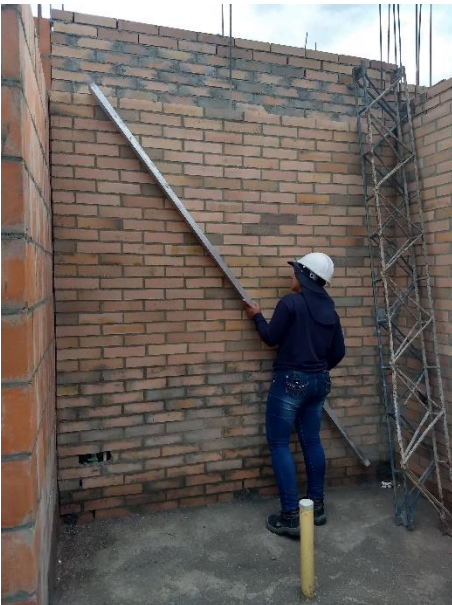
Figura 100. Chequeo de uniformidad y plomada
