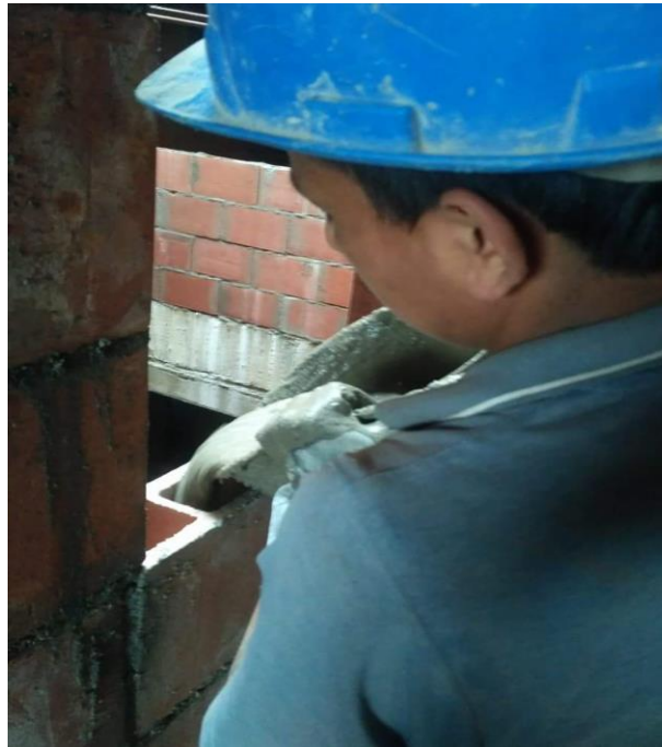
Figura 97. Fundición de dovelas con grouting
