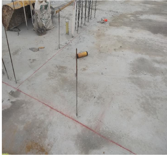
Figura 90. Cimbra localización de muros
