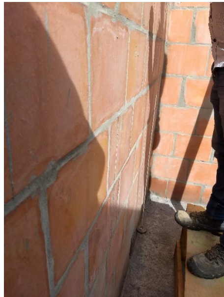
Figura 100. Chequeo de uniformidad y plomada
