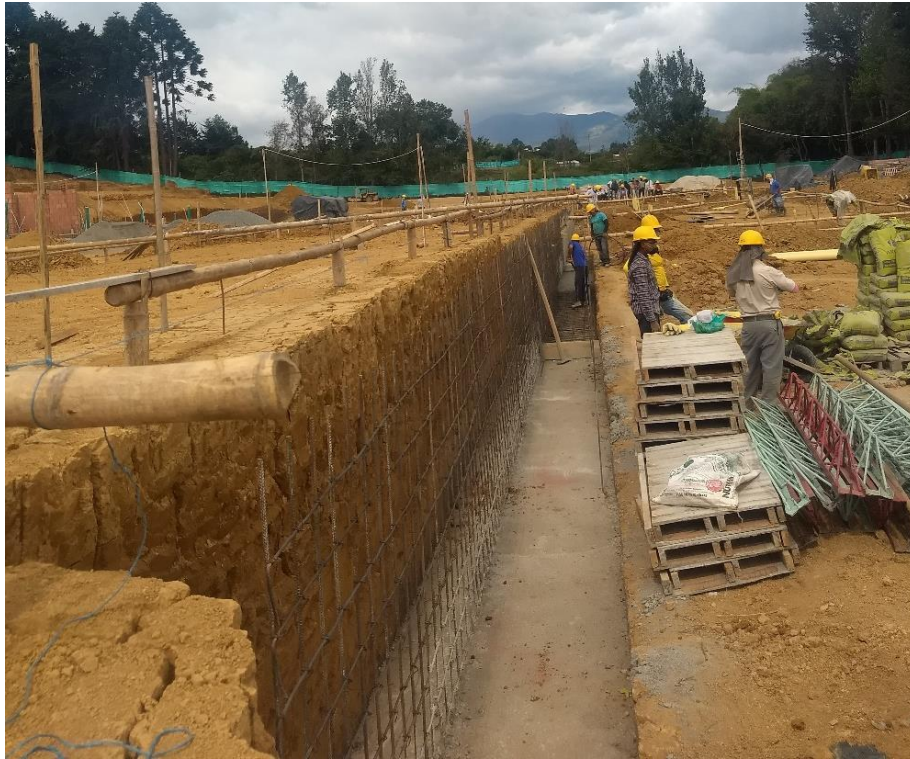
Figura 34. Colocación de formaletas
