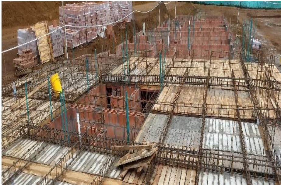
Figura 55. Flejado del acero de refuerzo para vigas
