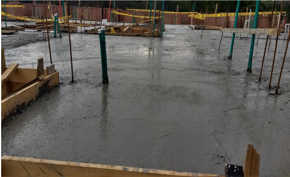
Figura 75. Losa de entrepiso terminada
