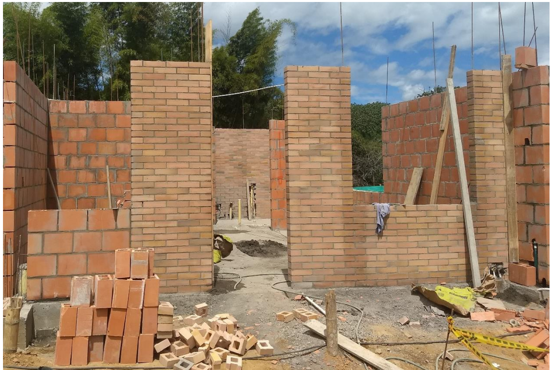
Figura 8. Estado inicial de la obra
