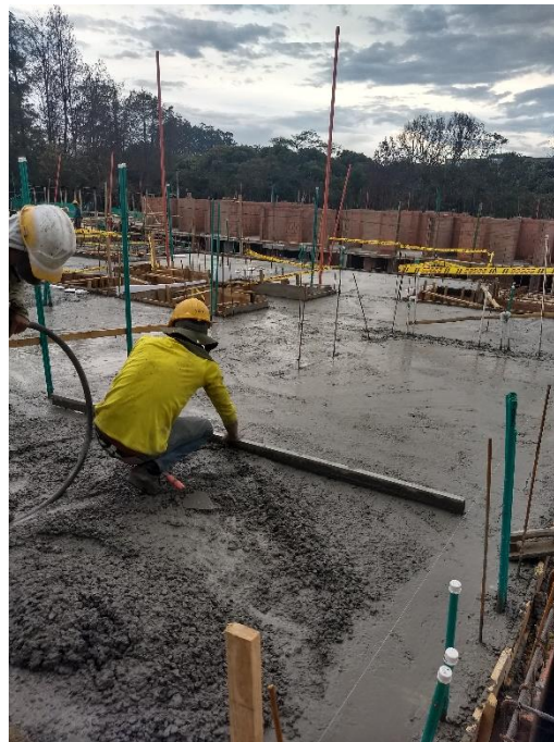
Figura 74. Acabado de losa con codal
