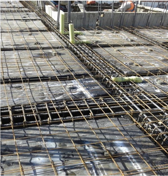
Figura 66. Red hidráulica embebida
