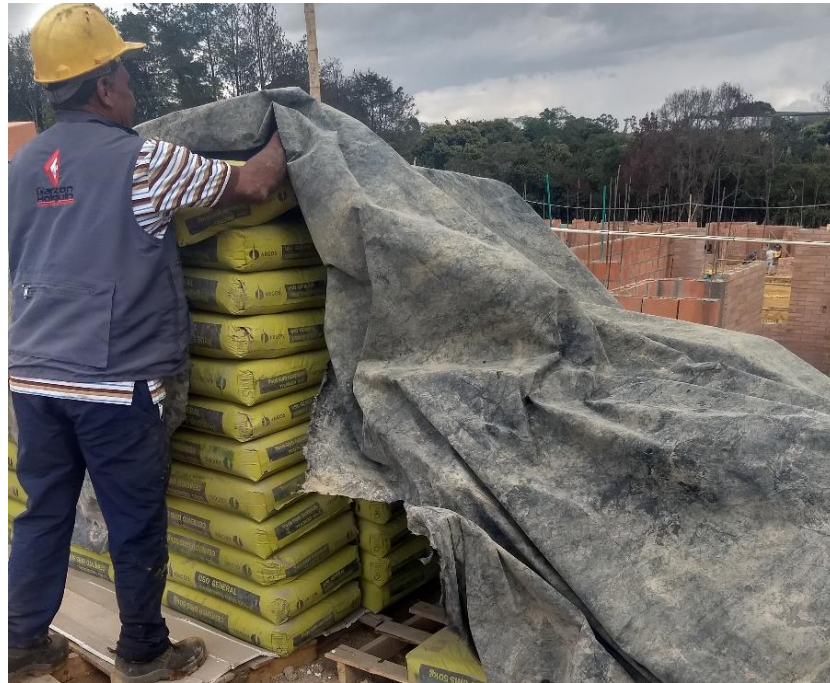
Figura 10. Almacenamiento del cemento
