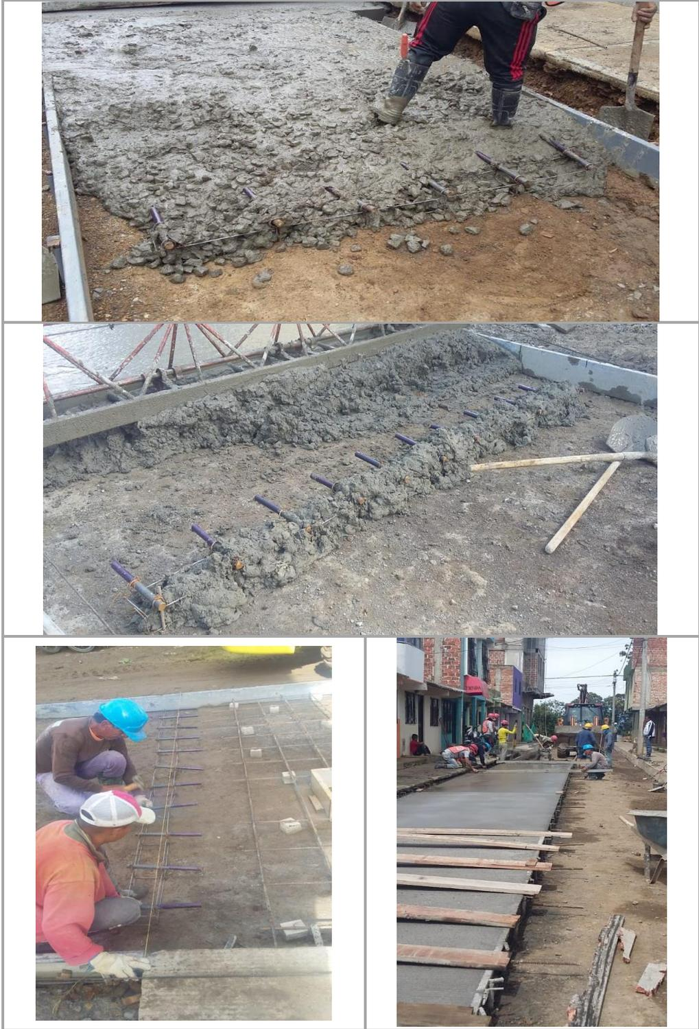
**5.2.10.3 Producción y transporte del concreto.** Una vez aceptado el diseño de mezcla y el equipo por el interventor, se procede a preparar la mezcla con el carmix, éste equipo es una hormigonera con una producción según ficha técnica de 3,5 m<sup>3</sup> de ccto por amasada para concretos de alta resistencia, pero su producción real para un concreto de 4000 PSI con proporciones 1:1,41:2,12 es de 2,7 m<sup>3</sup>, comprobado previamente.
