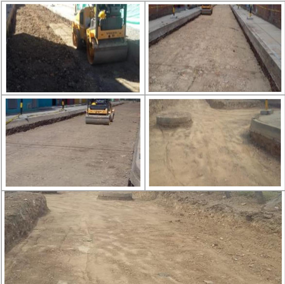
**5.2.4 Filtro longitudinal  $h=1.50m$ ,  $a=0,60m$ , incluye suministro de tubería perforada 6"**
