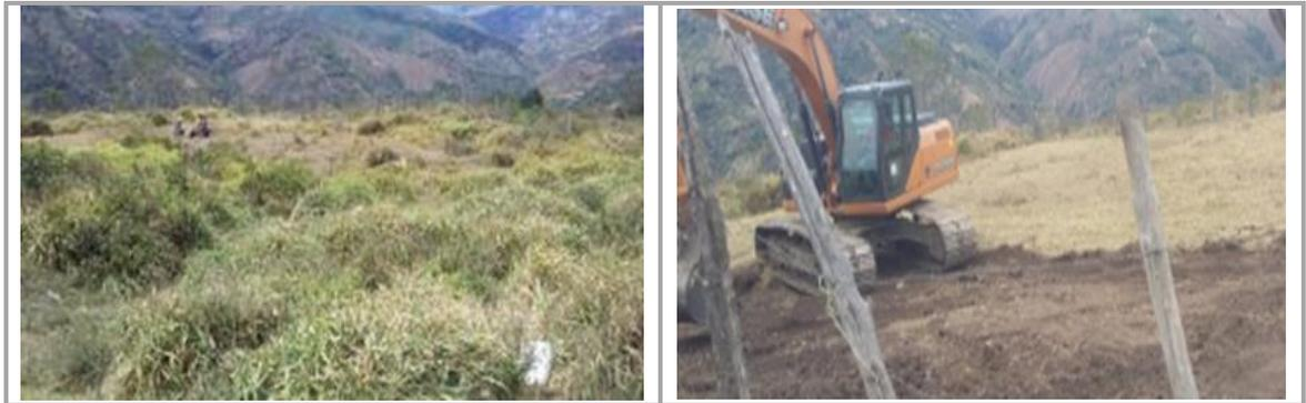
También se realizaron labores de excavación en el tramo 6 o vía principal, debido a que la tubería perteneciente al sistema de riego de Buesaco se encontró a 50 cm por debajo de la subrasante, conjuntamente con interventoría y el Gerente del sistema de riego de Buesaco se decidió profundizarla, primero se realizaron actividades de descubrimiento de la tubería para definir que longitud de ésta había que profundizar.
