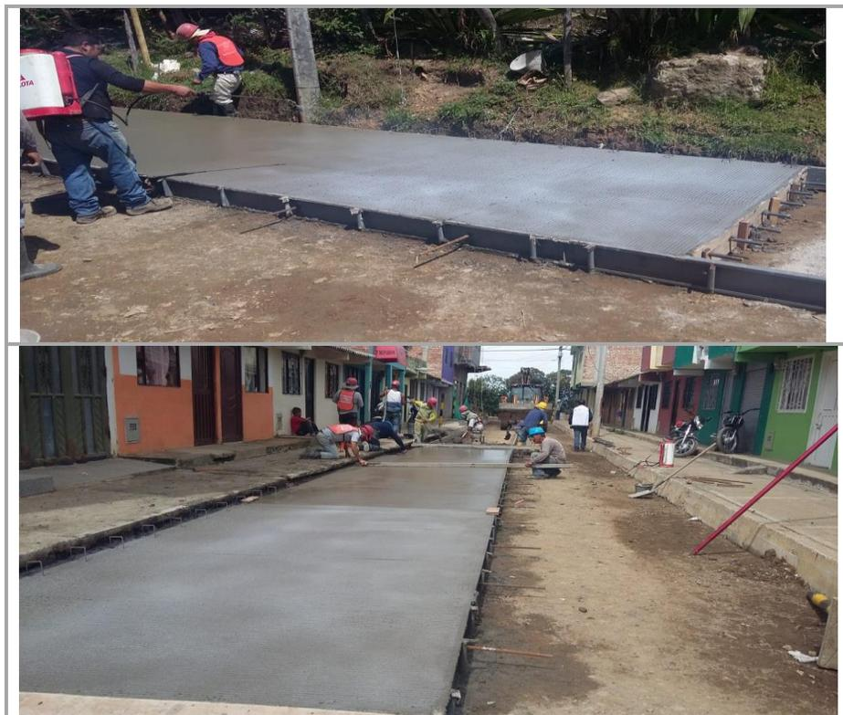
**5.2.10.8 Corte de juntas.** Se verificó que el corte de las juntas se realizó cuando el concreto presentó las condiciones de endurecimiento propicias para soportar el peso del equipo y del personal involucrado en la tarea y antes de que se produzcan agrietamientos no controlados; Por experiencia del ingeniero residente el concreto fue aserrado entre las 5 y las 7 horas posteriores a su colocación.
