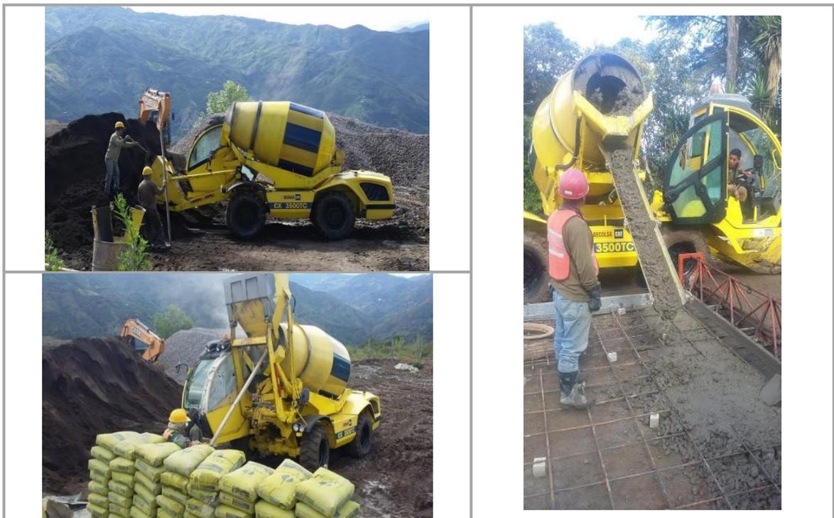
**5.2.10.4 Manejabilidad del concreto.** Es de importancia la verificación de ésta propiedad del concreto fresco ya que de la manejabilidad depende la mezcla, transporte, colocación, compactación y terminado sin que pierda su homogeneidad.
