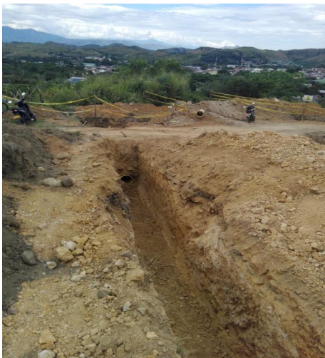
Figura 8. Instalación de tubería corrugada.
