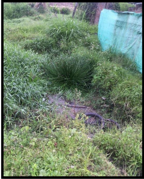
Figura 28. Tanque séptico viejo.
