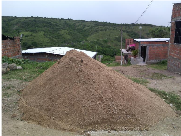
Figura 21. Arena para cama de tubería.
