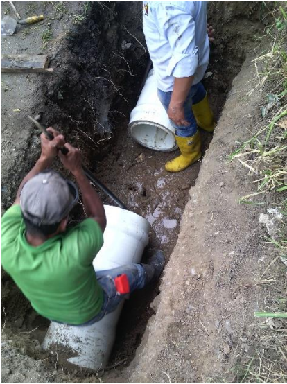
Figura 32. Instalación de válvula ventosa (14”).
