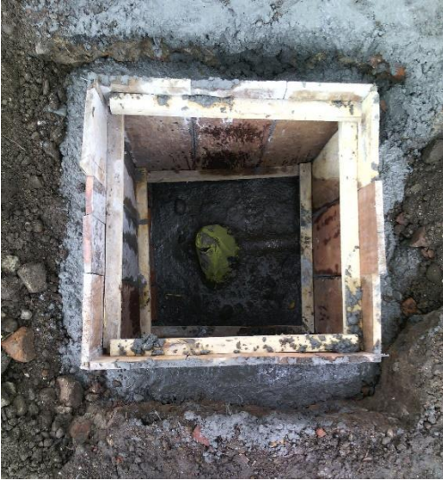
Figura 31. Construcción cajillas y tapas de inspección.
