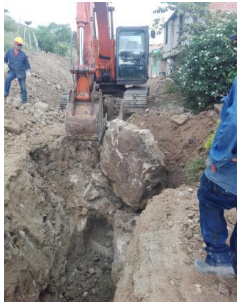
Figura 6. Excavación mecánica y manual.
