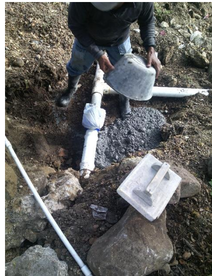
Figura 30. Instalación válvula de corte rápido (3") encofrada en concreto para evitar levantamiento de la tubería por la presión del agua.
