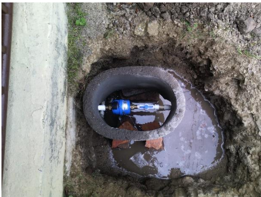
Figura 33. Contadores con sus respectivos accesorios.
