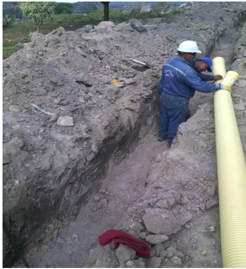
Figura 10. Sillas Y para acometidas domiciliarias
