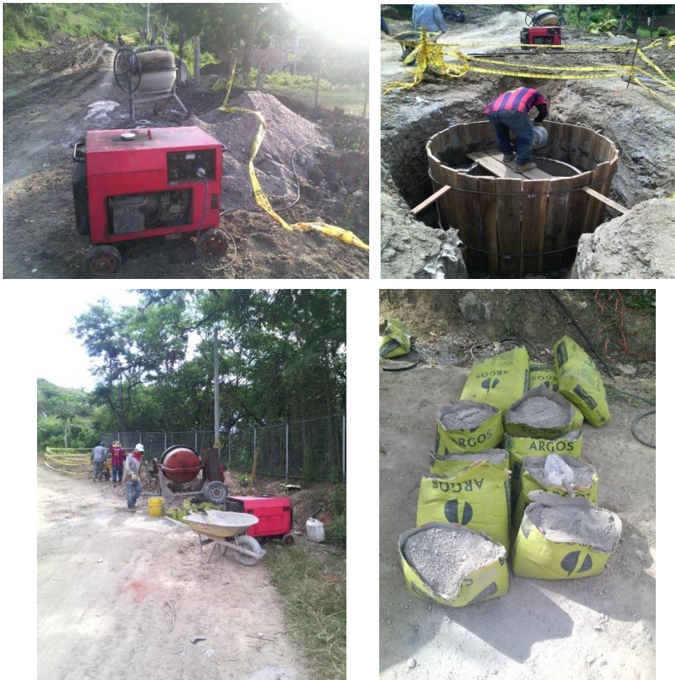
Figura 13. Producción y Transporte del concreto en obra.
