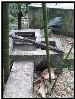
Figura 22. Cajilla desarenadora.
