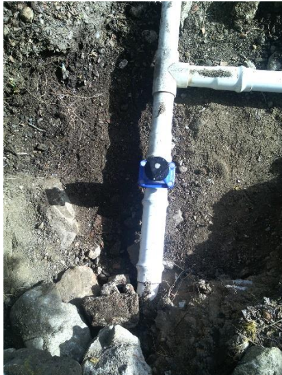
Figura 30. Instalación válvula de corte rápido (3") encofrada en concreto para evitar levantamiento de la tubería por la presión del agua.
