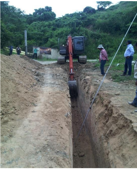
Figura 6. Excavación mecánica y manual.
