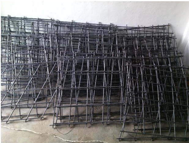
Figura18. Almacenamiento de hierro armado bajo techo.
