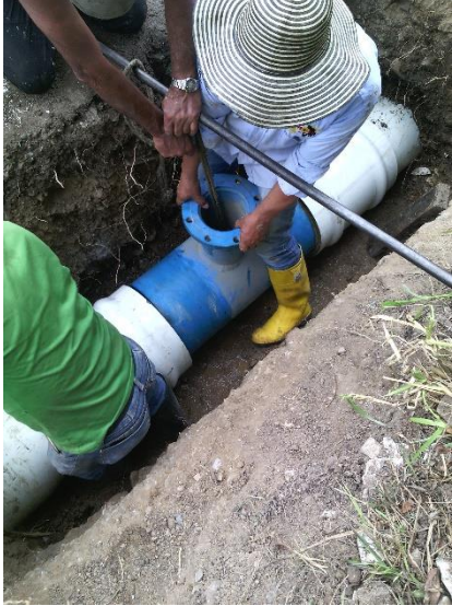
Figura 32. Instalación de válvula ventosa (14”).
