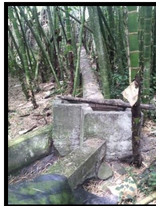
Figura 22. Cajilla desarenadora.
