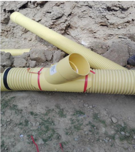
Figura 10. Sillas Y para acometidas domiciliarias
