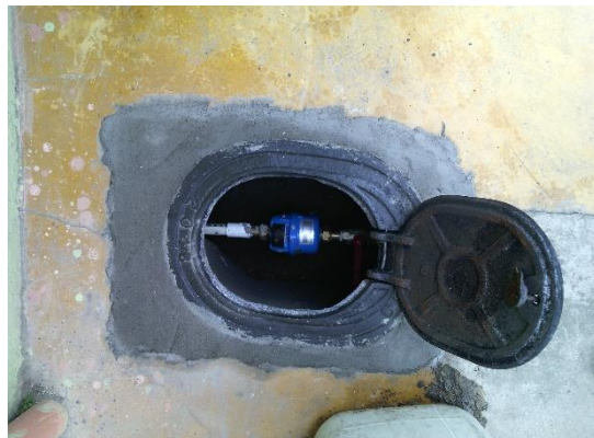
Figura 33. Contadores con sus respectivos accesorios.
