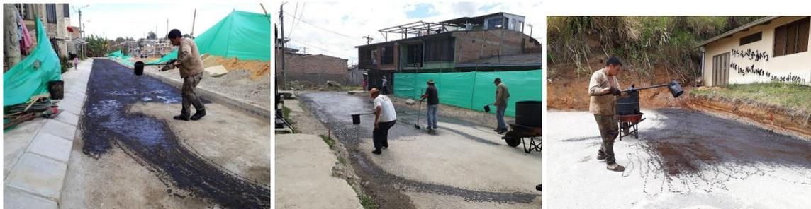
Ilustración 51. Riego de Imprimación. Aplicación del ligante en la capa de base granular de forma manual.
