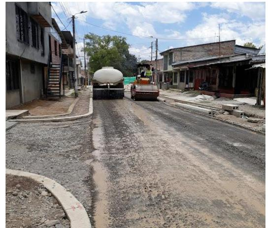
Ilustración 47. Base Granular. Humedecimiento y compactación de la capa. Barrio Nuevo Japón.
