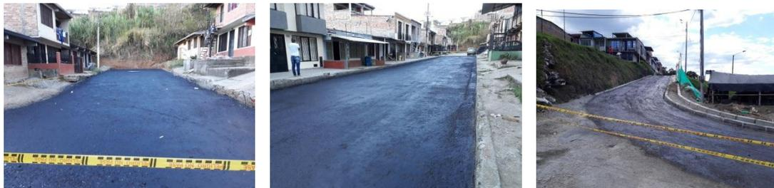
Ilustración 52. Riego de Imprimación. Superficie Imprimada.
