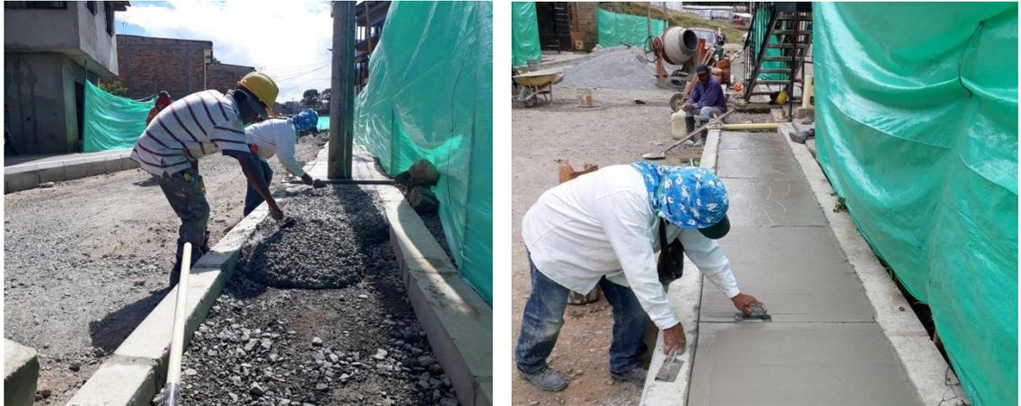
Ilustración 65. Acabados de urbanismo. Fundición de la loseta de concreto.
