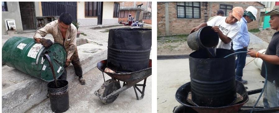
Ilustración 50. Riego de Imprimación. Determinación de la dosificación del ligante.
