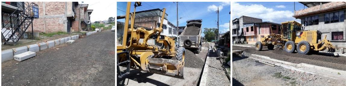
Ilustración 45. Base Granular. Instalación de sardineles tipo A 10 y extensión de material granular. Barrio Nuevo Japón.
