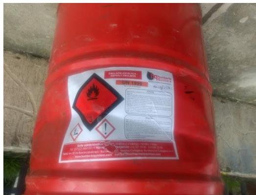
Ilustración 48. Riego de Imprimación. Tipo de emulsión utilizada CRL-1
