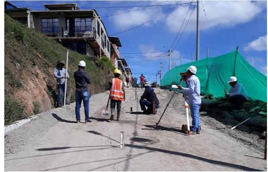
Ilustración 46. Base Granular. Definición del espesor de la capa. Barrio Los Cristales.
