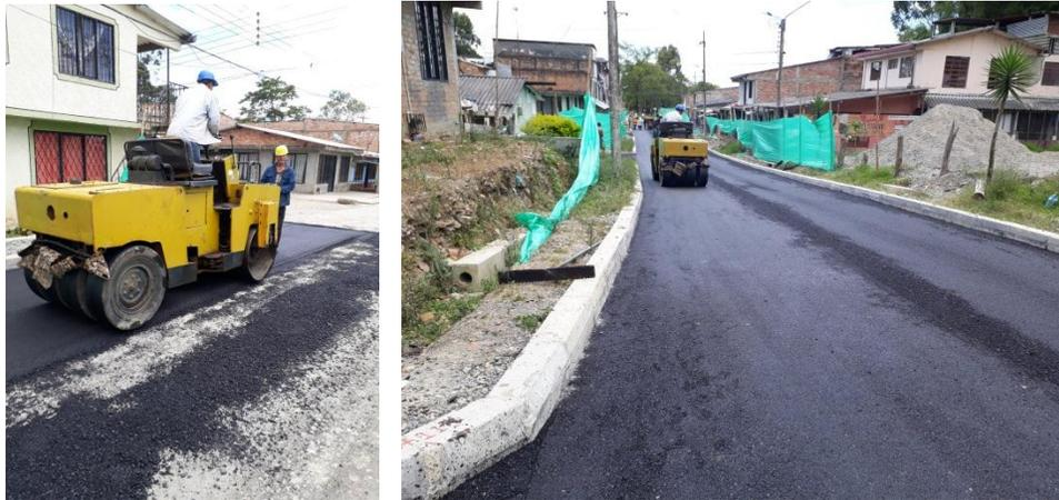
Ilustración 58. Colocación de la carpeta asfáltica. Compactador mixto Hyster.
