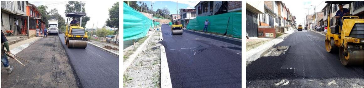
Ilustración 57. Colocación de la carpeta asfáltica. Compactador liso.
