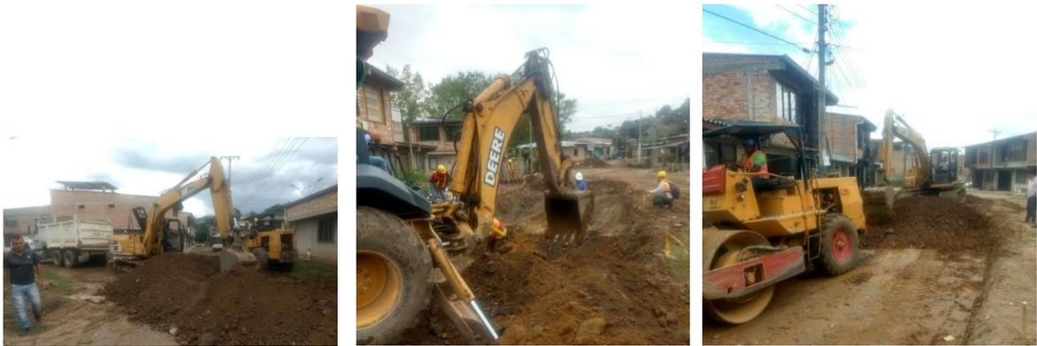
Ilustración 17. Movimiento de tierras. Excavación y compactación Barrio Nuevo Japón.
