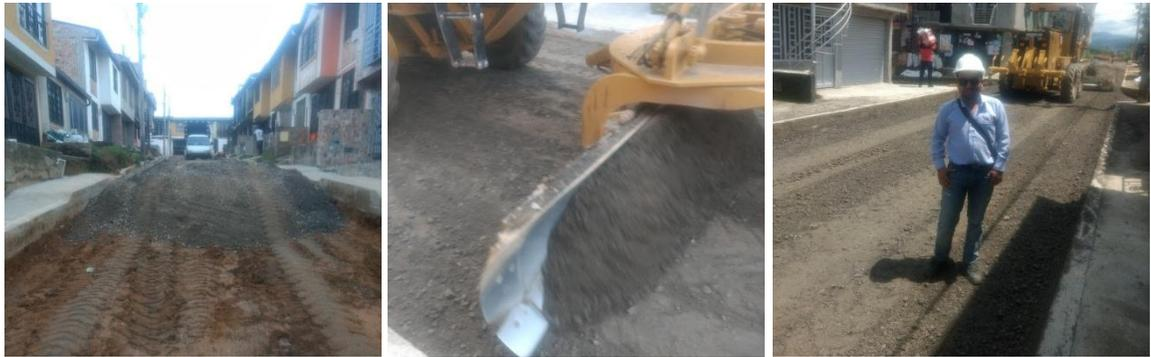
Ilustración 40. Sub-base granular. Extensión de material granular Barrio Ciudad 2000.
