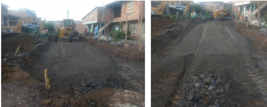
Ilustración 39. Sub-base granular. Extensión de material granular Barrio Nuevo Japón.
