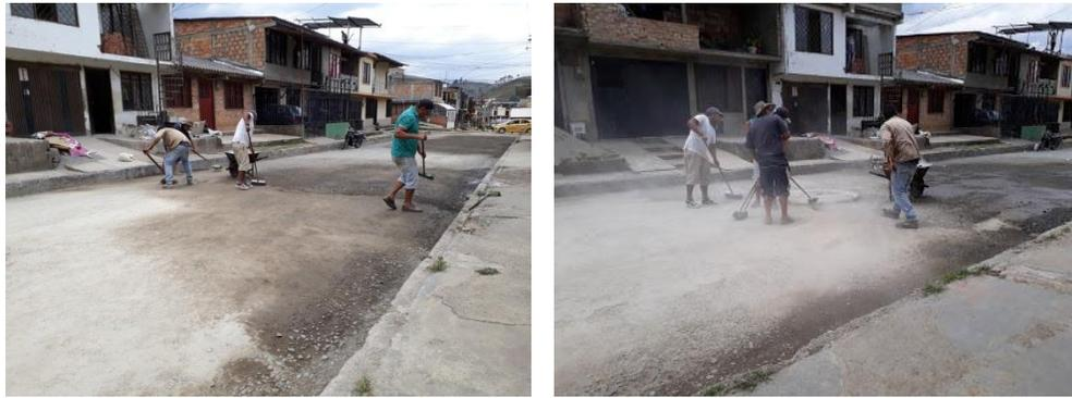
Ilustración 49. Riego de imprimación. Limpieza de la base granular.
