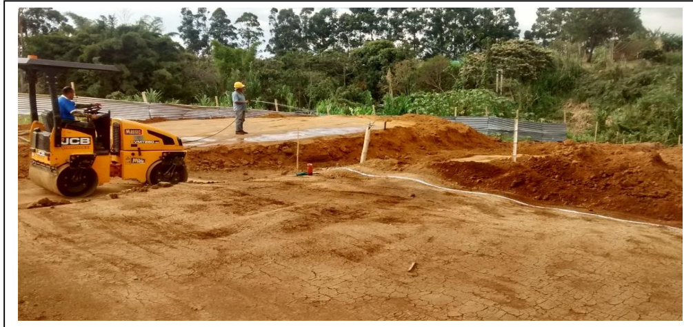
Figura 6.3.6 Mejora de humedad del suelo de relleno.
