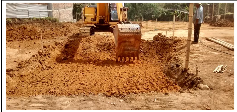
Figura 6.3.4 Cajeo de vía
