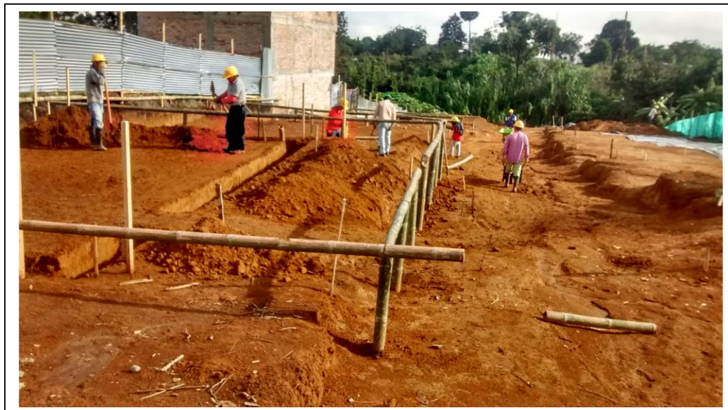
Figura 6.12.1. Replanteo casas tipo B
