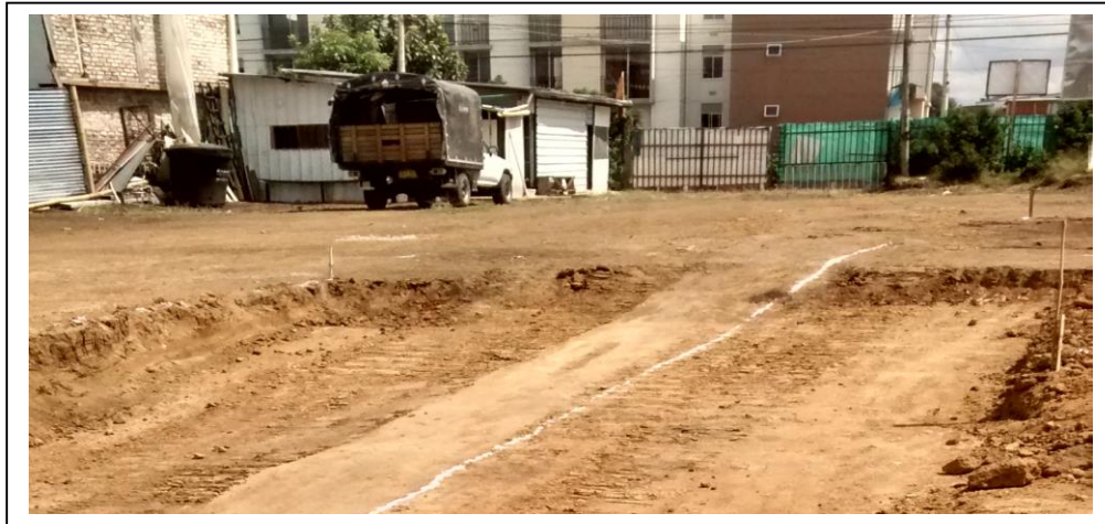
Figura 6.4.3 Trazado zanja de alcantarillado
