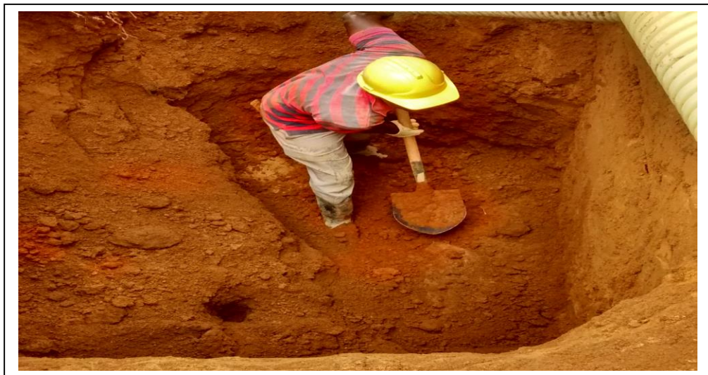
Figura 6.4.13 Retiro material con exceso de humedad
