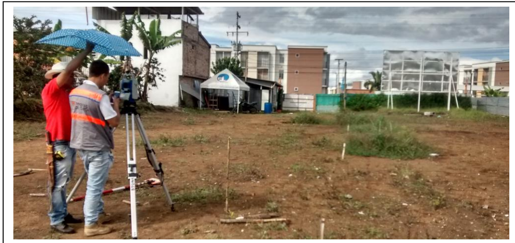
Figura 6.2.1 Replanteo Topográfico
