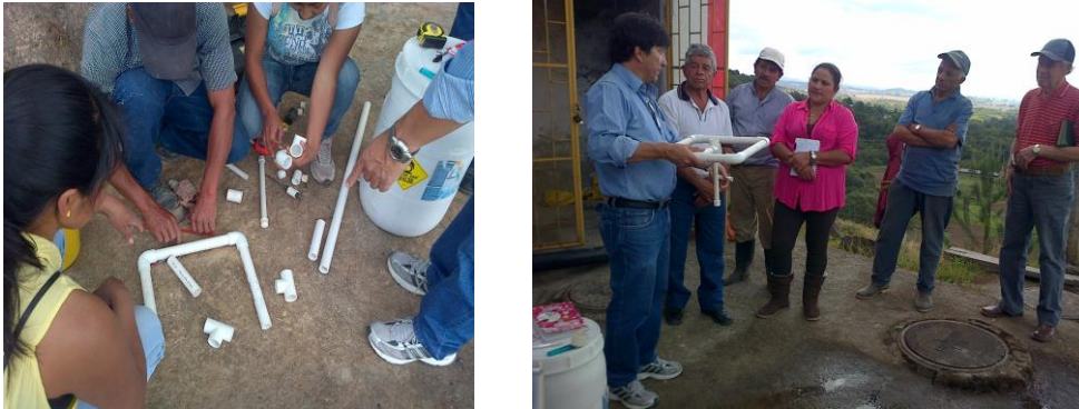
Figura 15. Fotografías construcción dosificador de cabeza constante.
