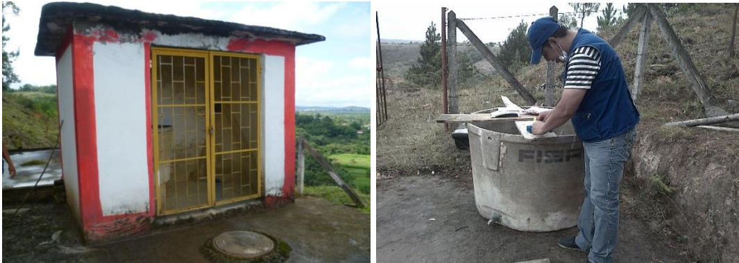
Figura 12. Fotografía caseta de protección y tanque de asbesto cemento
