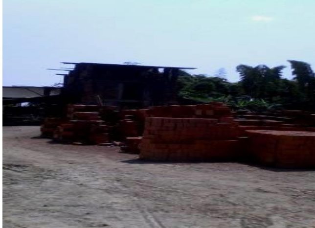
Figura 9. Horno tipo PAMPA, ladrillera Puerto Tejada
