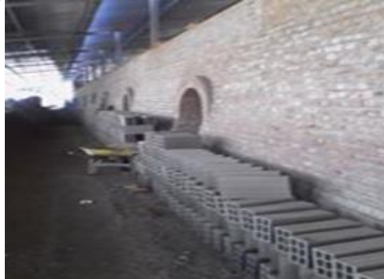
Figura 12. Horno tipo Túnel, ladrillera Ladritec
