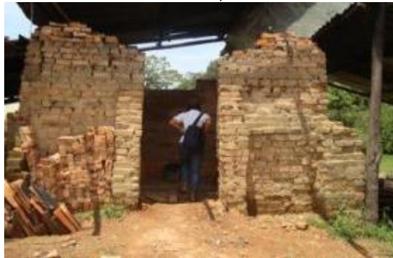
Figura 6. Horno PAMPA 2, Ladrillera Los Tejares
