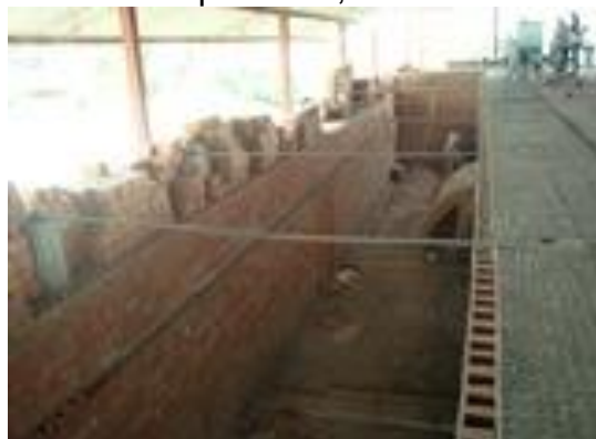
Figura 8. Horno tipo Túnel, ladrillera Santa Rosa
