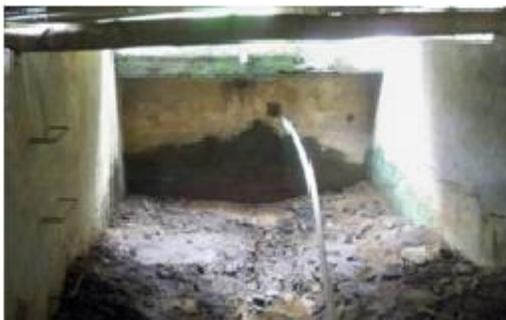
Filtro lento de arena: existió un sistema de tratamiento por filtración lenta en arena, el cual ya está totalmente deteriorado, se removieron las capas de arena que tenía para su correcto funcionamiento, las paredes de la estructura están bastante agrietadas por lo que sería casi que imposible pensar en una reparación, la manguera de dos pulgadas que se observa en la tubería es la que se conecta con la red de distribución en épocas de verano. (*Figura 7*)
