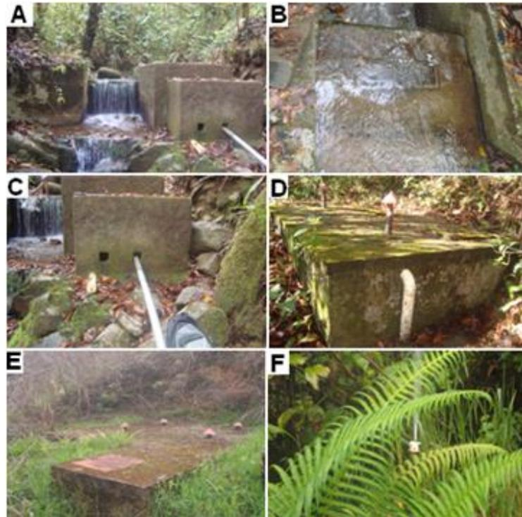
Bocatoma: es una captación de tipo frontal, la estructura está en regular estado, los materiales con que fue construida son concreto, ladrillo y varillas de hierro, su estado actual evidencia el tiempo que lleva de servicio o un mantenimiento inadecuado, tiene 15 años de funcionamiento. *(Fotografía A de la Figura 14)*
