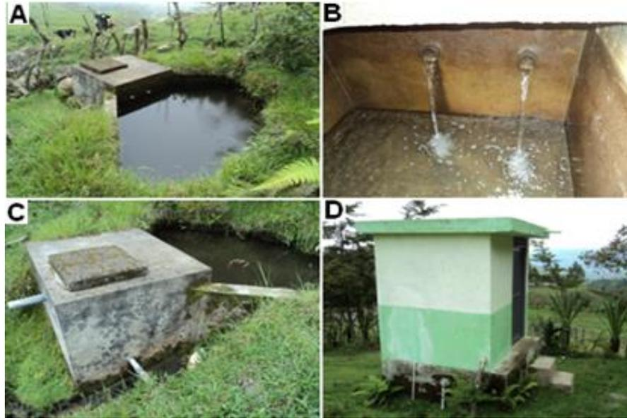
Bocatoma: está ubicada en un nacedero, es una estructura elaborada en concreto y ladrillo, la captación de agua se hace a través de dos orificios que son tubos de PVC de 2 pulgadas, la estructura se encuentra en regular estado, tiene una tubería de lavado de 4 pulgadas. (Fotografía A de la Figura 13)
