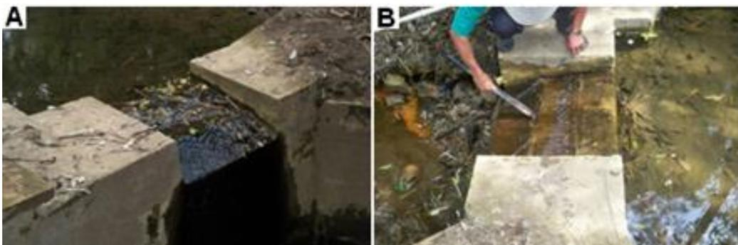
Bocatoma auxiliar: está en buenas condiciones, fue elaborada en ladrillo y concreto, funciona hace 8 años, pero por ser usada solo en situaciones especiales no se realiza un mantenimiento adecuado, se ubicada cerca de un camino que es muy transcurrido por los habitantes del sector, labriegos e incluso animales. *(Fotografía A de la figura 4)*
