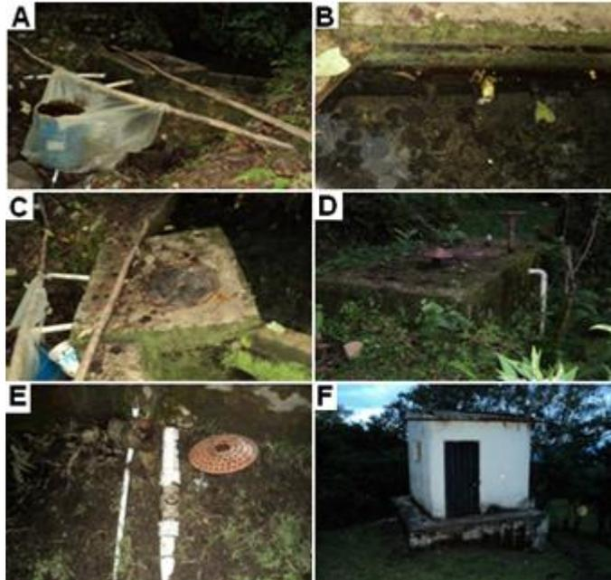
Tanque colector: sus medidas son 1,20 metros de largo, de ancho tiene 1,31 metros y su altura es de 1,2 metros, el control de nivel es una tubería de 1 ½ pulgadas, el espesor de sus paredes es el de un ladrillo en la posición de tizón, la tubería para el lavado es de 1 ½ pulgadas; el agua se conduce hasta el desarenador a través de 150 metros de tubería de 2 pulgadas de PVC. (Fotografía C de la Figura 19)
