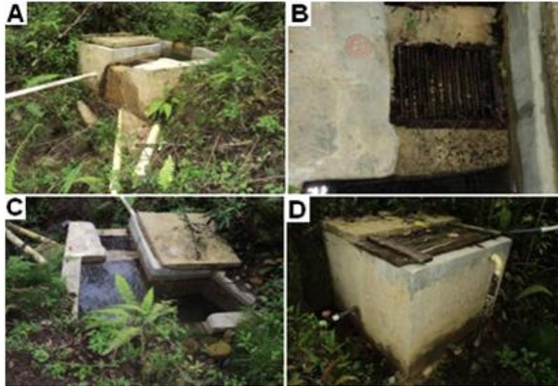
Rejilla de captación: tiene 32 cm de largo y 25 cm de ancho, cuenta con 12 barrotes de hierro corrugado de  $\frac{1}{2}$  pulgada, no está bien diseñada porque no cuenta con bisagras para realizar la limpieza del canal recolector. (*Fotografía B de la Figura 21*)
