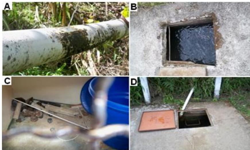
Conducción bocatoma desarenador: se usan 400 metros de tubería PVC de 4 pulgadas, la cual se ha perforado en algunos lugares para vaciar el aire, estos orificios funcionan como válvulas de aireación. *(Fotografía A de la Figura 3)*
