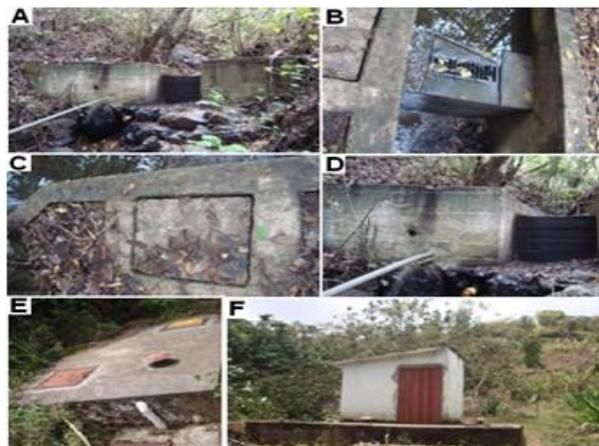
Tanque de almacenamiento y caseta de cloración: fueron construidos en ladrillo en forma de tizón, concreto y varillas de hierro, el tanque de almacenamiento es enterrado con 5,5 metros de largo por 6 de ancho y una profundidad de 1,80 metros, el agua alcanza una altura de 1,58 metros, no se evidencian fugas en la estructura; la caseta de cloración no está en funcionamiento desde hace más de dos años. (Fotografía F de la Figura 5)
