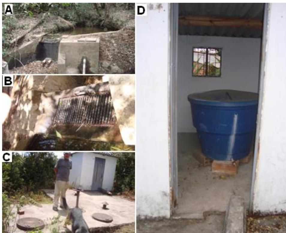
Bocatoma auxiliar: es un dique toma, está elaborada en ladrillo, concreto y varillas de hierro, lleva funcionando 12 años, la estructura está en buen estado. (Fotografía A de la Figura 10)
