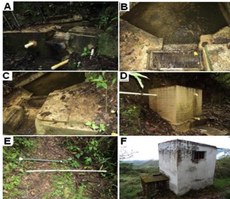
Bocatoma: es un dique toma de captación frontal, tiene 28 años de funcionamiento, fue construido en ladrillo, cemento, arena y varillas de hierro, se le hicieron en noviembre del año 2011 algunas renovaciones como la cimentación del fondo comprendido entre las paredes laterales de la estructura para facilitar las actividades de lavado que se realizan atraves de una tubería de 6 pulgadas, también se corrigieron algunas fugas, la estructura está en buen estado. (*Fotografía A de la Figura 20*)
