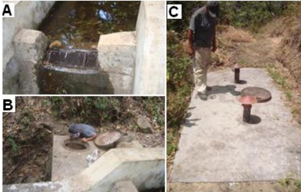
Tanque recolector: presenta problemas de filtración a la salida de la conducción, la estructura no está en buen estado, se observó poco volumen de agua en su interior, se encuentra sucio por falta de mantenimiento, a la salida de la unidad no cuenta con una válvula de cierre rápido, tiene también una tubería de 4 pulgadas para el lavado. (Fotografía B de la Figura 9)
