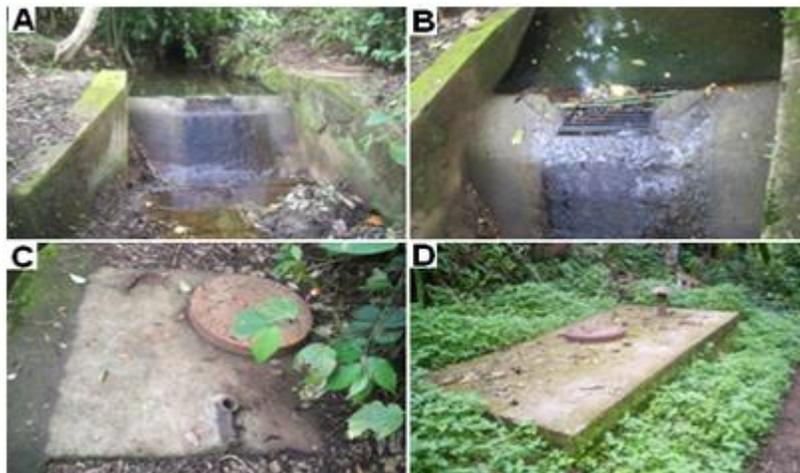
Bocatoma Antigua (auxiliar): tiene más de 40 años de vida útil es usada solo en época de verano, está en malas condiciones, la reja de captación está mal diseñada. (Fotografías A y B de la Figura 6)
