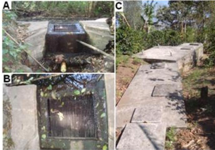
Desarenador y tanque de almacenamiento: son estructuras que se encuentran en buen estado los materiales usados en su construcción son cemento arena y varillas de hierro, no funciona bien en épocas de invierno, y este sector se vio en la necesidad de recurrir a racionamientos educativos por el desperdicio que se estaba presentando a causa de la sequía ya que la gente usaba el agua para labores de riego. (Fotografía C de la Figura 8)
