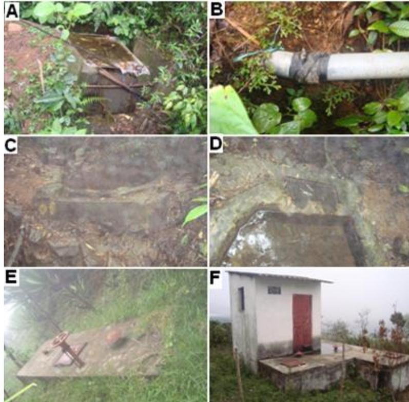
Abducción: se hace a través de una tubería de 2 pulgadas que está bastante deteriorada el tramo es de 10 metros hasta el desarenador. (Fotografía B de la Figura 17)
