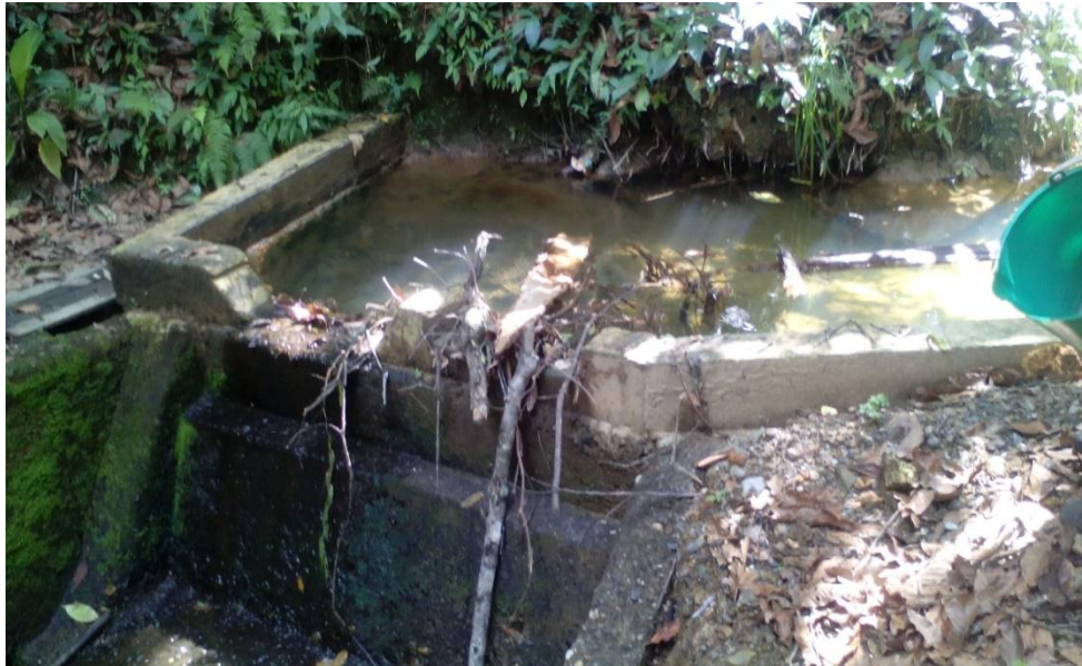
Figura 26. Abastecimiento de agua Pisojé Alto.
