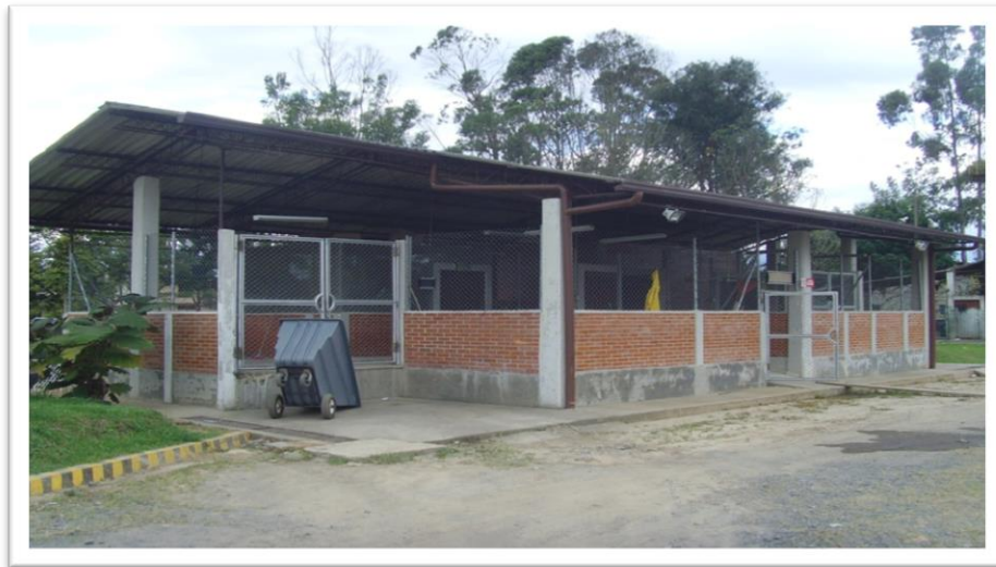
Figura 10. Almacenamiento Central de Residuos Hospitalarios del HSLV
