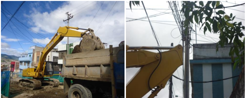
Figura 50. Campo de maniobra de la retroexcavadora.
