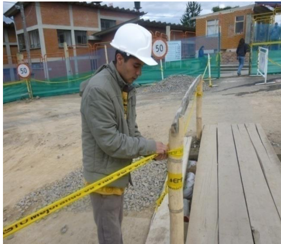
Figura 60. Instalación y medición de cinta de señalización.
