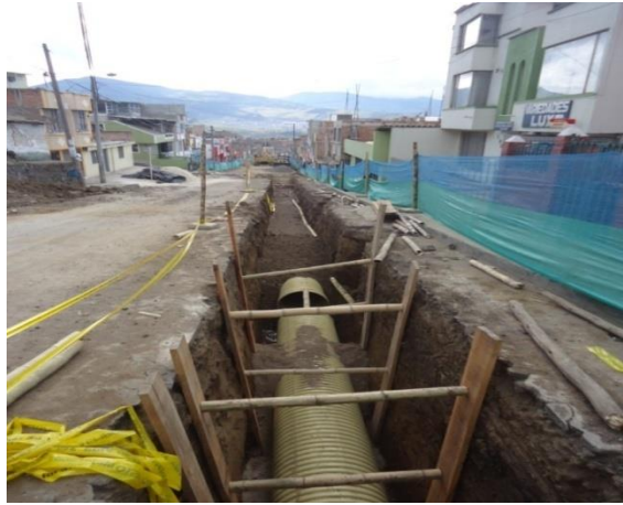
Figura 11. Vista frontal de entibado en zanja con colector.
