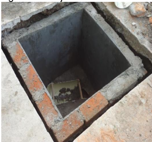
Figura 24. Caja domiciliaria terminada.
