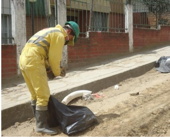
Figura 26. Limpieza de la zona de trabajo.
