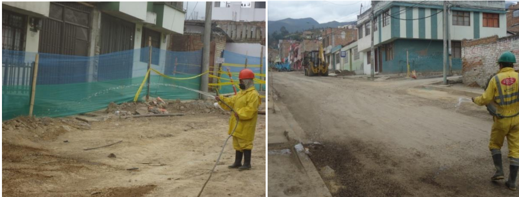
Figura 40. Riegos en frente de obra.
