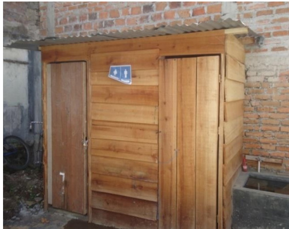
Figura 45. Adecuación de sanitarios en el campamento.
