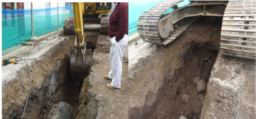
Figura 7. Retiro de tubería en concreto.
