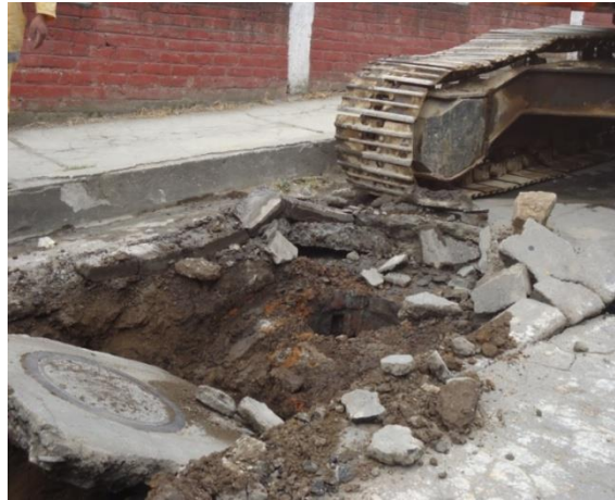
Figura 6. Demolición de cámaras de inspección.
