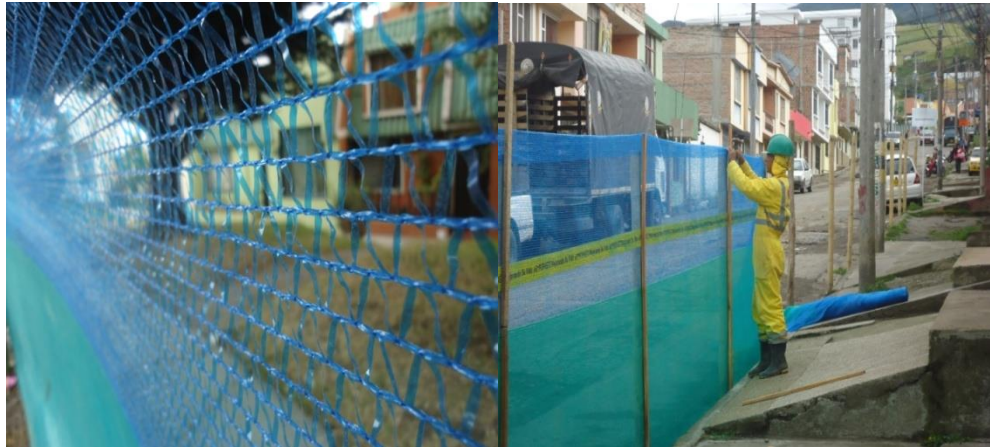
Figura 36. Detalle e instalación de polisombra.
