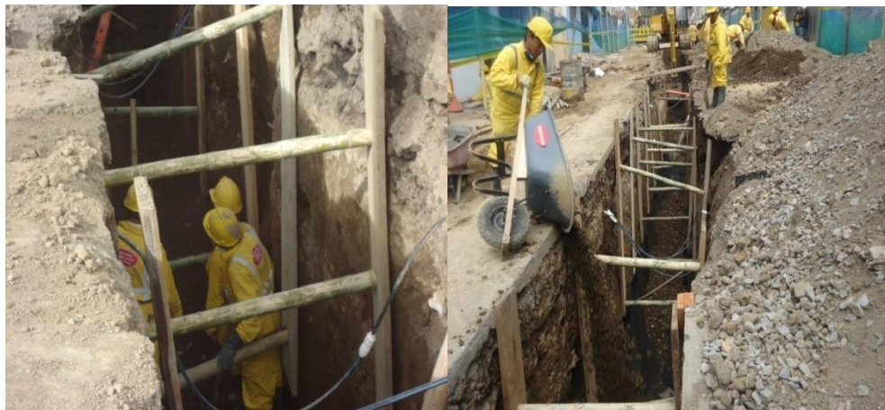
Figura 10. Entibado de excavación.
