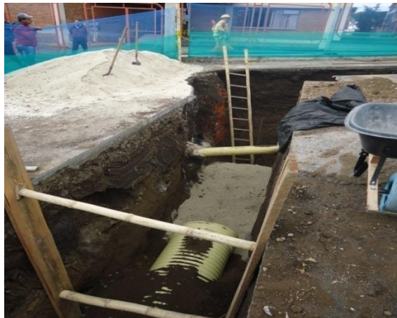
Figura 13. Vista de la tercera capa.
