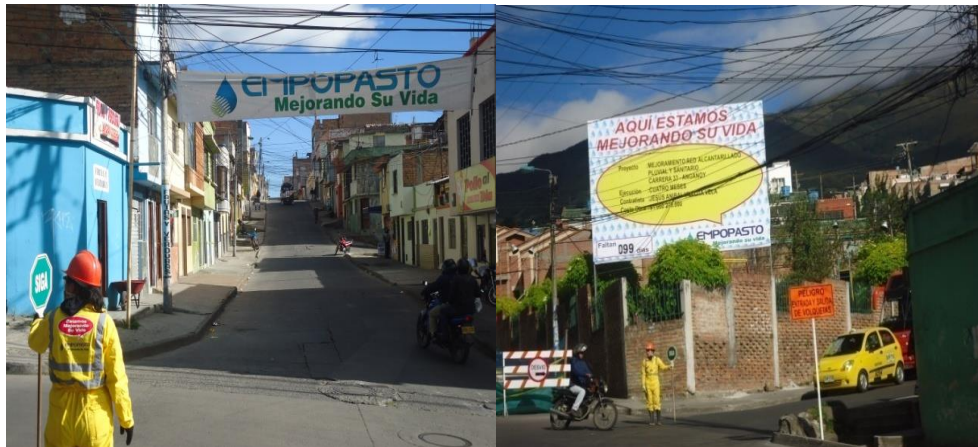
Figura 55. Controladoras de tráfico en vía de influencia a la obra.
