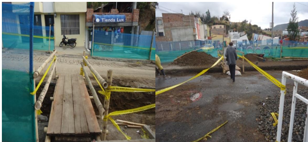
Figura 33. Señalización y puente peatonal.
