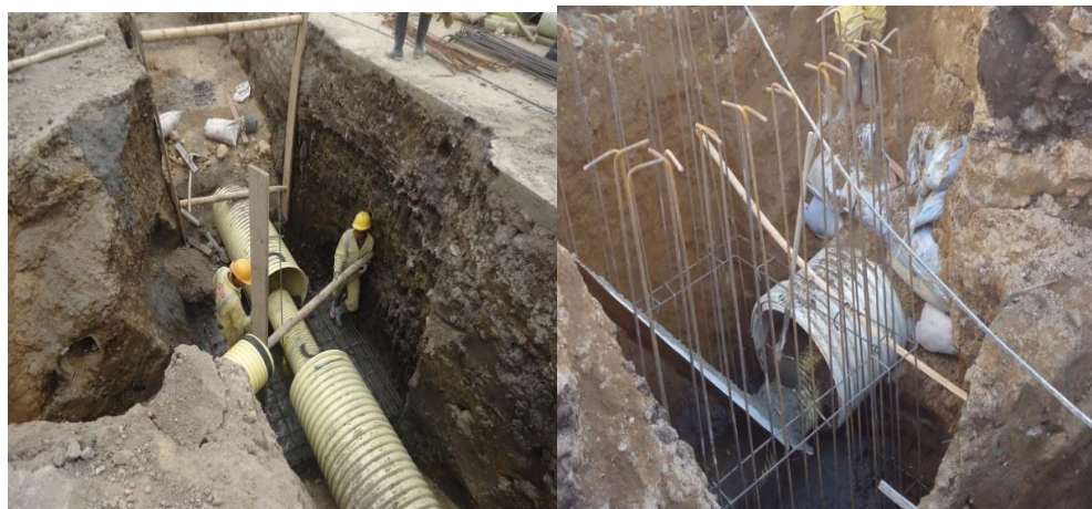
Figura 18. Cimentación de cámara.
