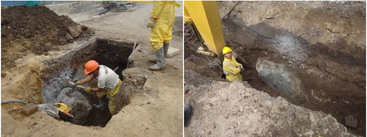
Figura 9. Corte de roca manual y con retroexcavadora.
