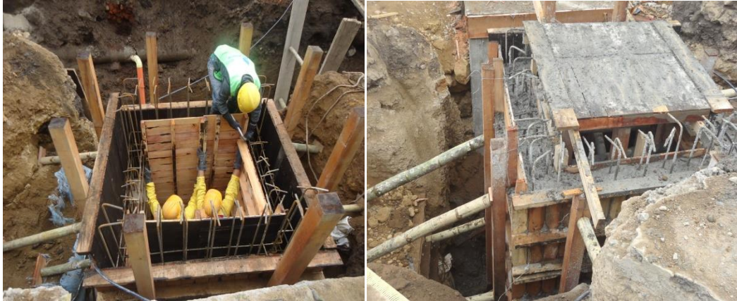
Figura 19. Construcción de formaleta.
