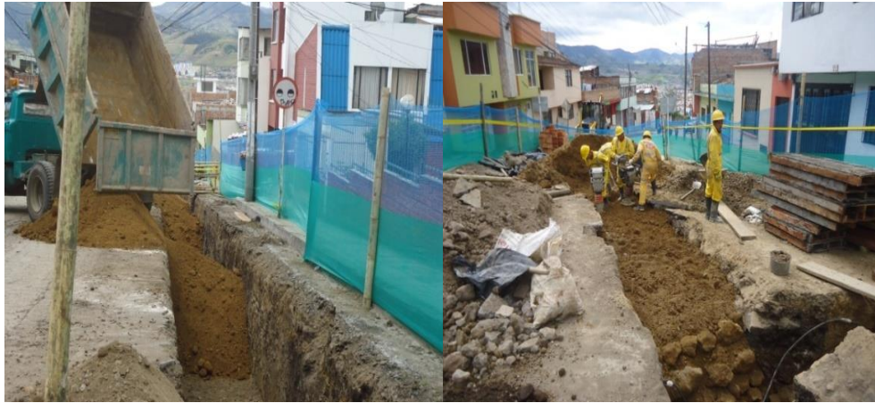
Figura 16. Relleno de la zanja.
