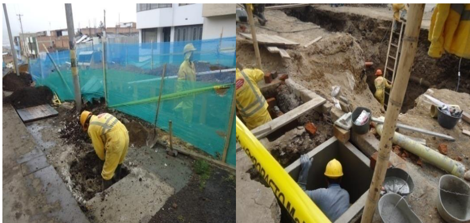
Figura 23. Construcción de caja domiciliaria.
