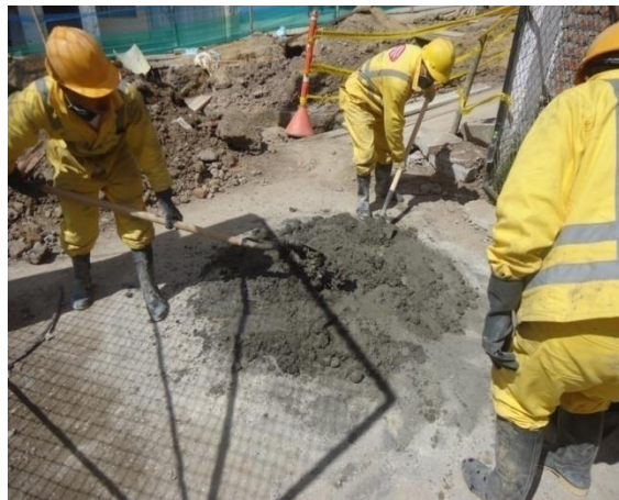
Figura 43. Mezcla de concreto.
