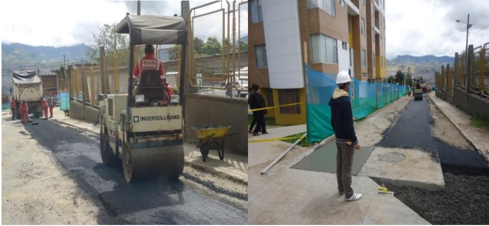
Figura 63. Pavimentación del último tramo.
