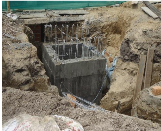
Figura 20. Cámara de inspección casi terminada.
