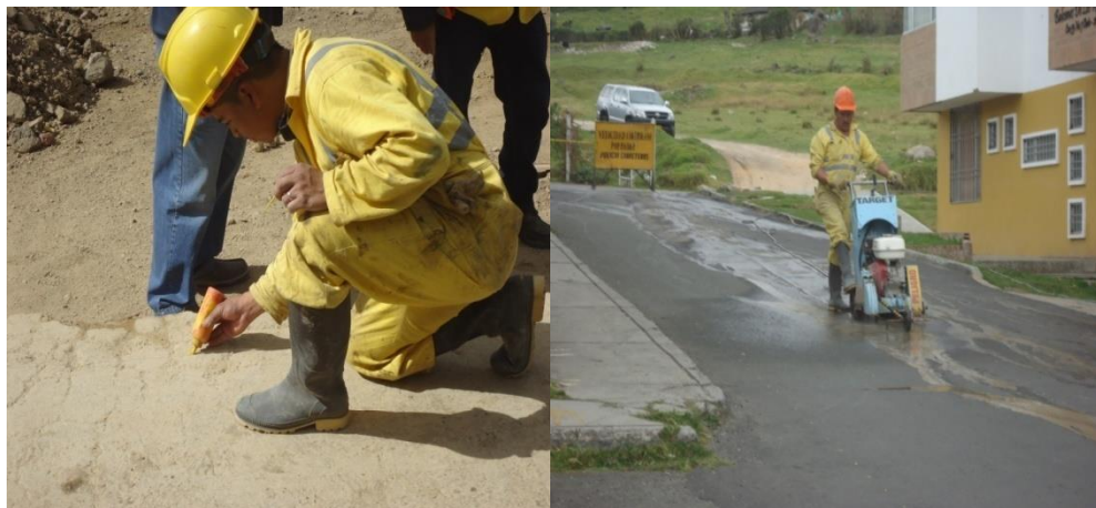
Figura 5. Trazado y corte de pavimento.
