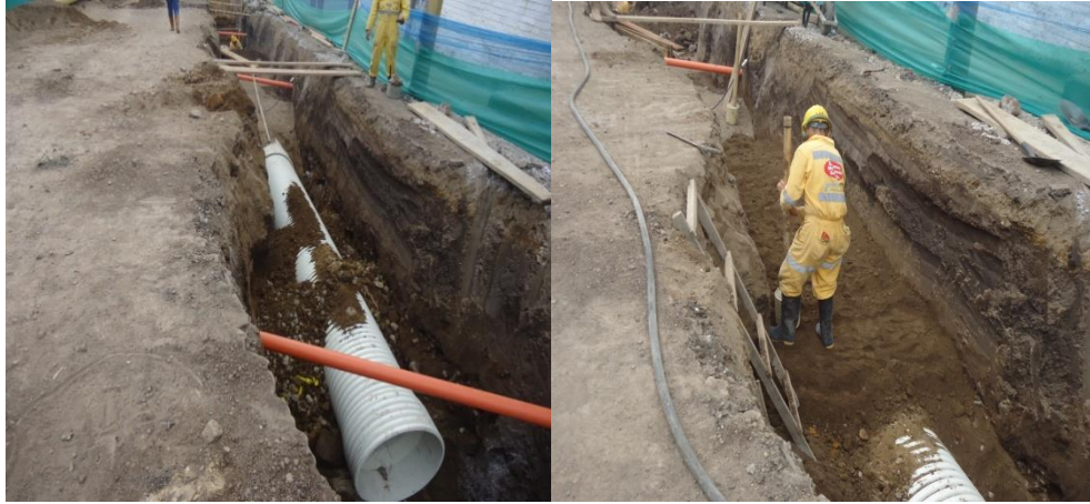
Figura 14. Vista y compactación del material de atraque.
