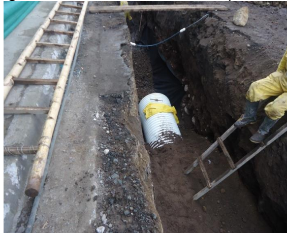
Figura 15. Vista de material compactado.
