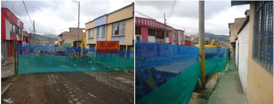
Figura 38. Aislamiento de obra con polisombra.
