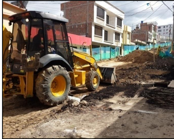
Figura 31. Levantamiento de escombros.
