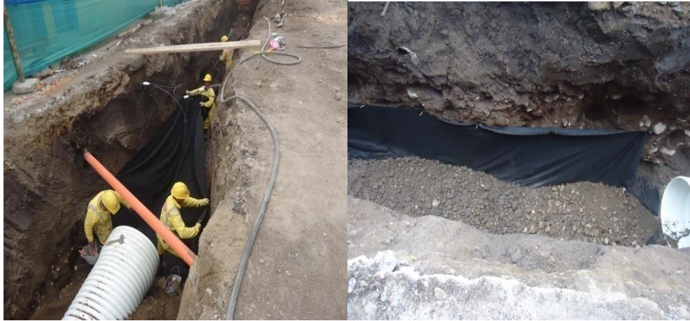
Figura 12. Anclaje del filtro a la zanja.
