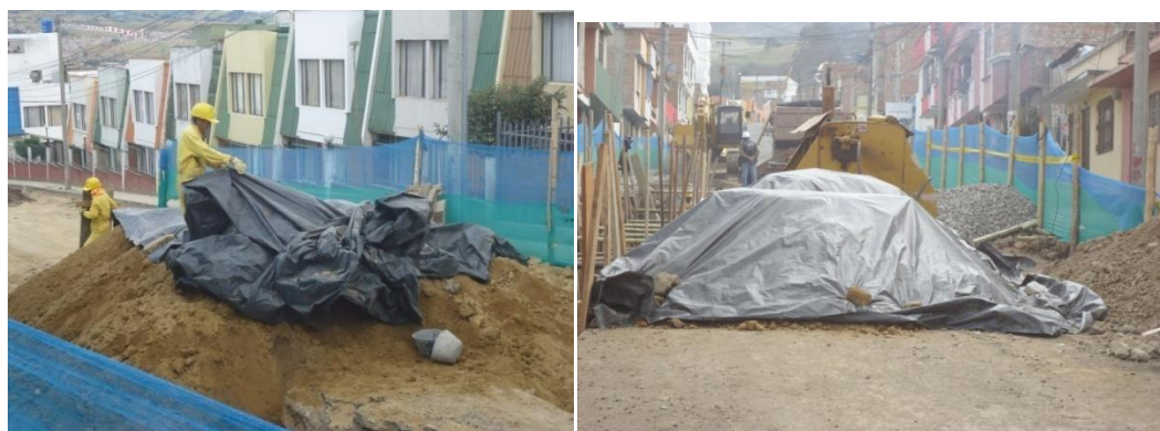
Figura 30. Protección del material de relleno con plástico.
