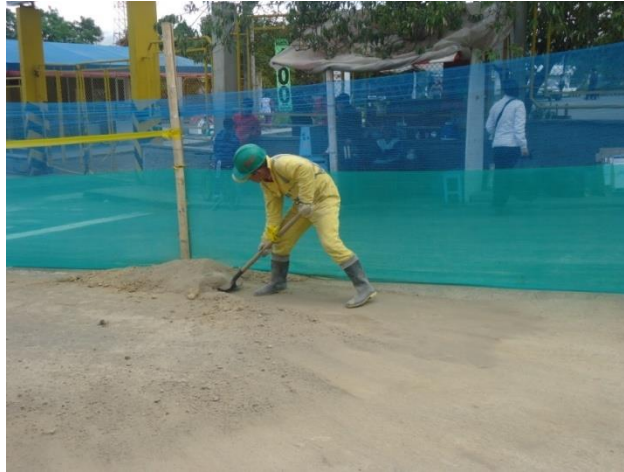
Figura 39. Limpieza de vías de acceso.
