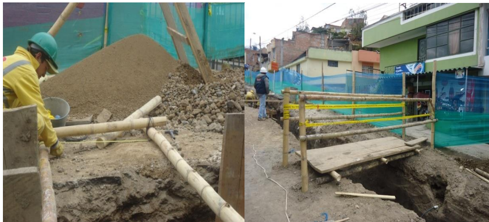
Figura 56. Construcción de puentes peatonales
