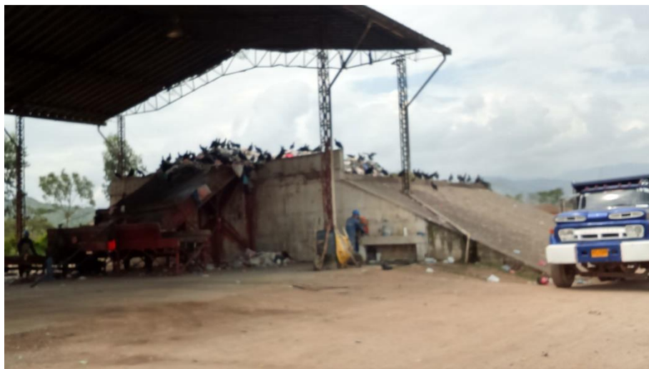
Fotografía 10 Entrada de los residuos Sólidos en las instalaciones de Biorgánicos.
