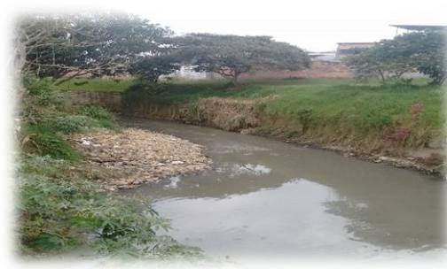
Figura 10.22. Cauce Ejido 3. Descarga del box culvert
