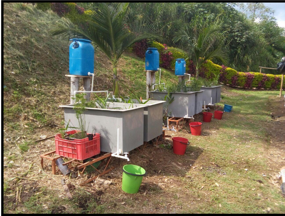
Ilustración 12. Montaje final del sistema de humedales construidos de flujo horizontal subsuperficial a escala piloto.
