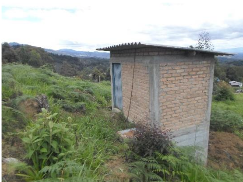
Figura 19. Caseta de desinfección
