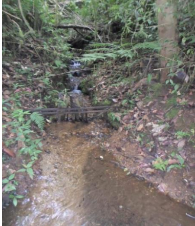
Figura 7. Fuente de captación: Quebrada Lavapiés
