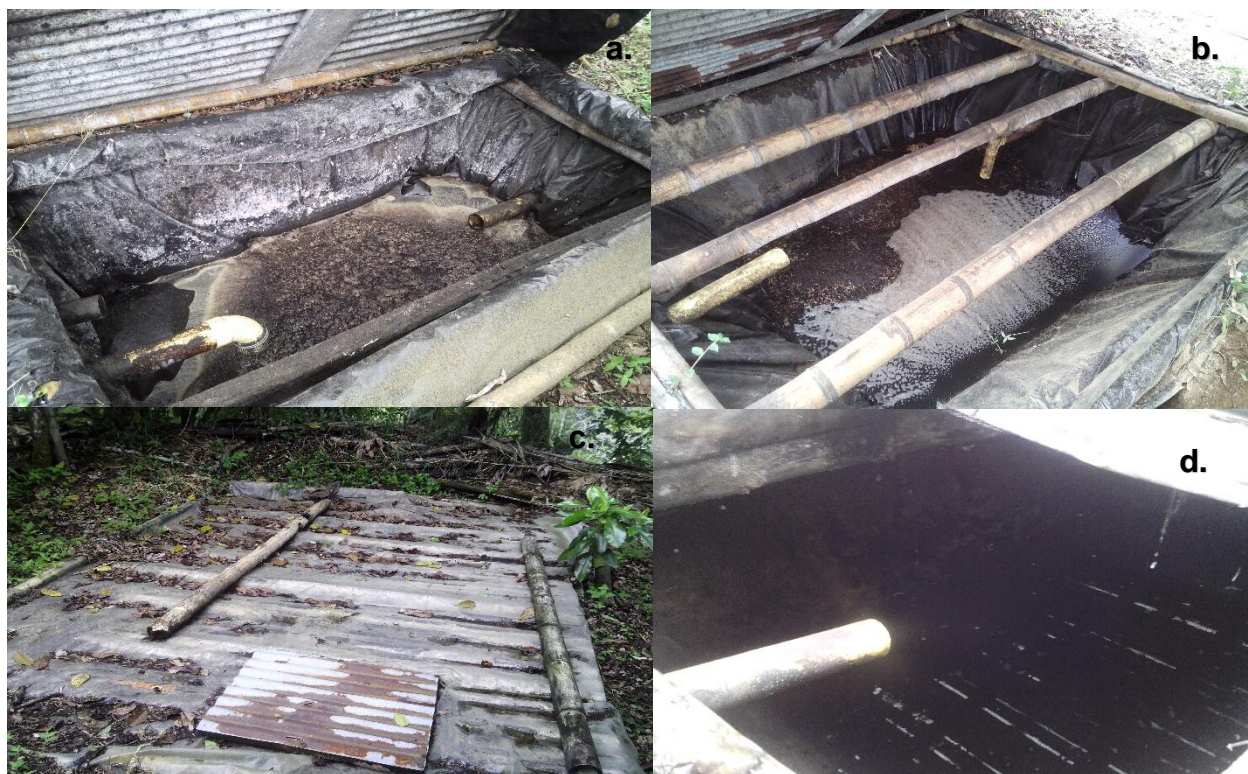
Figura 15. a. Laguna de sedimentación con trampa de pulpas, b. Laguna del proceso Hidrolítico/ Acidogénico, c. Exterior de la laguna de metanogénesis d. Interior laguna de metanogénesis.
