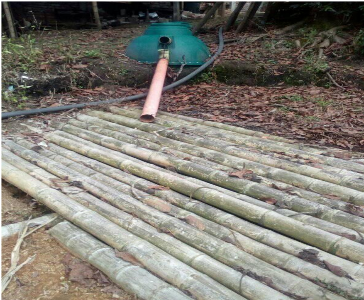
Figura 9. Laguna de infiltración
