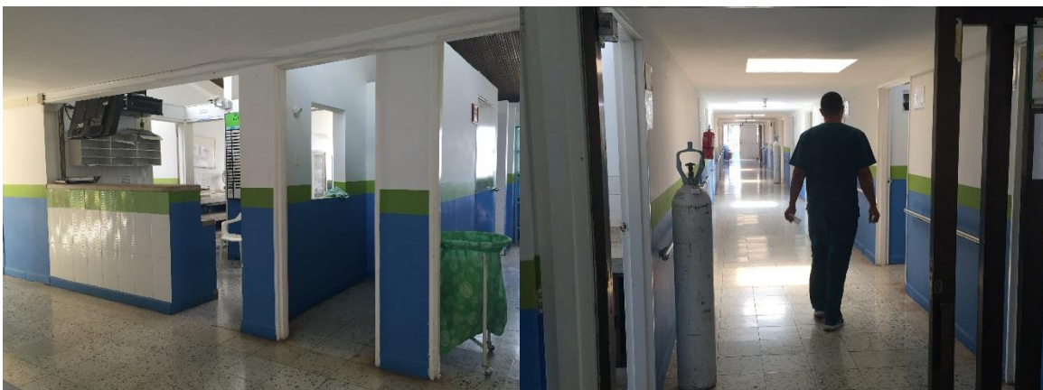
PISOS Y PINTURA DE LOS PASILLOS DEL AREA DE HOSPITALIZACION
