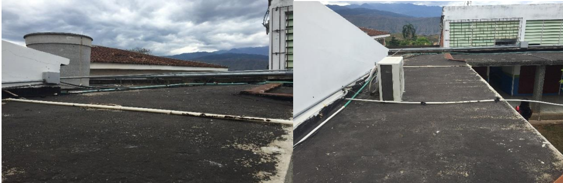
IMPERMEABILIZACION EN CARPETA ASFALTICA EN TECHOS DEL HOSPITAL
