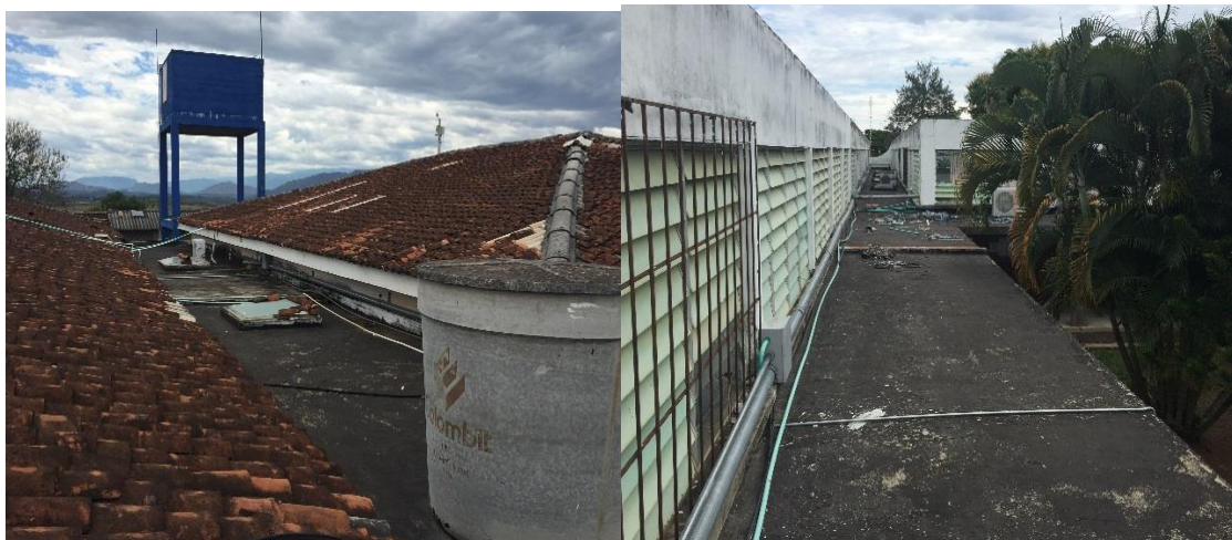
CANALIZACIÓN DE LAS REDES
