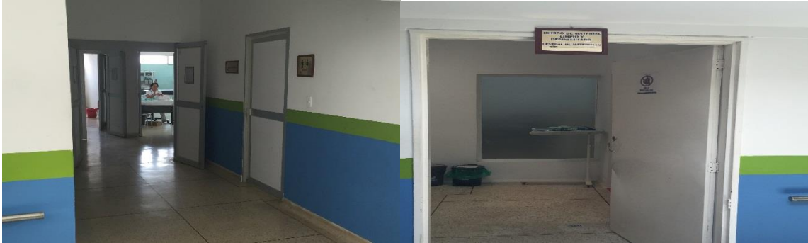
AREA QUE CONDUCE A URGENCIAS Y NO SE OBSERVA TRABAJOS ELECTRICOS A SIMPLE VISTA
