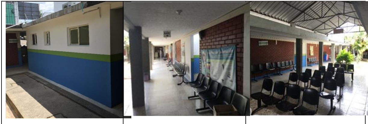
AREA DE CONSULTA EXTERNA Y PINTURA DE MURO
