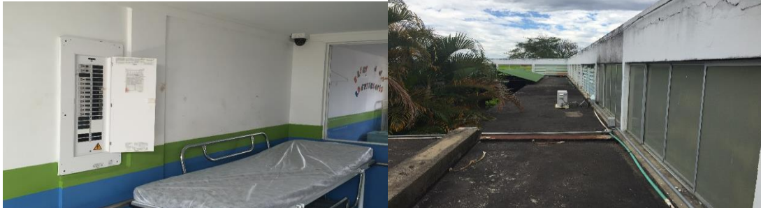
CAMBIO DE BREAKER Y CANALIZACIÓN DE LAS REDES
