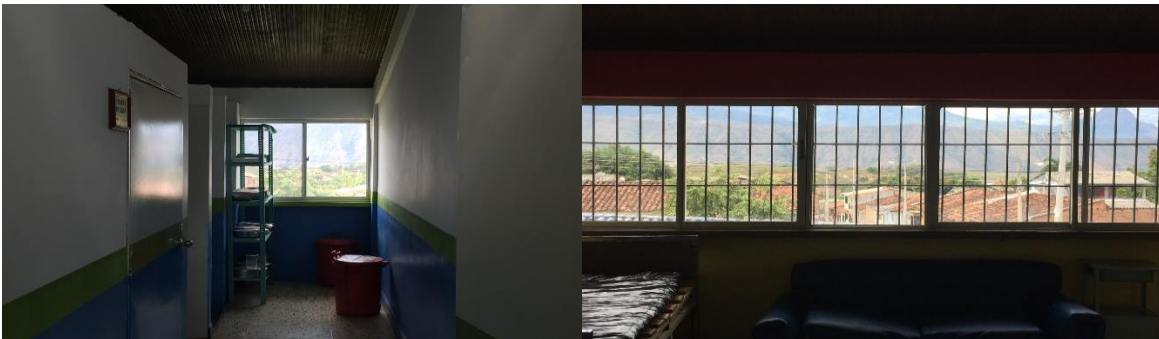
CAMBIO DE VENTANERIA AREA DE RESIDUOS Y HOSPITALIZACION
