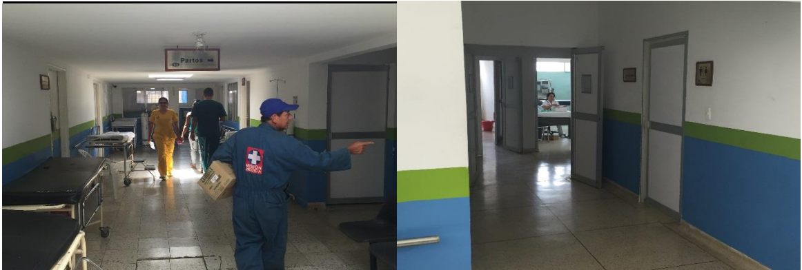
PISOS Y PINTURA DEL AREA DE NEONATOS
