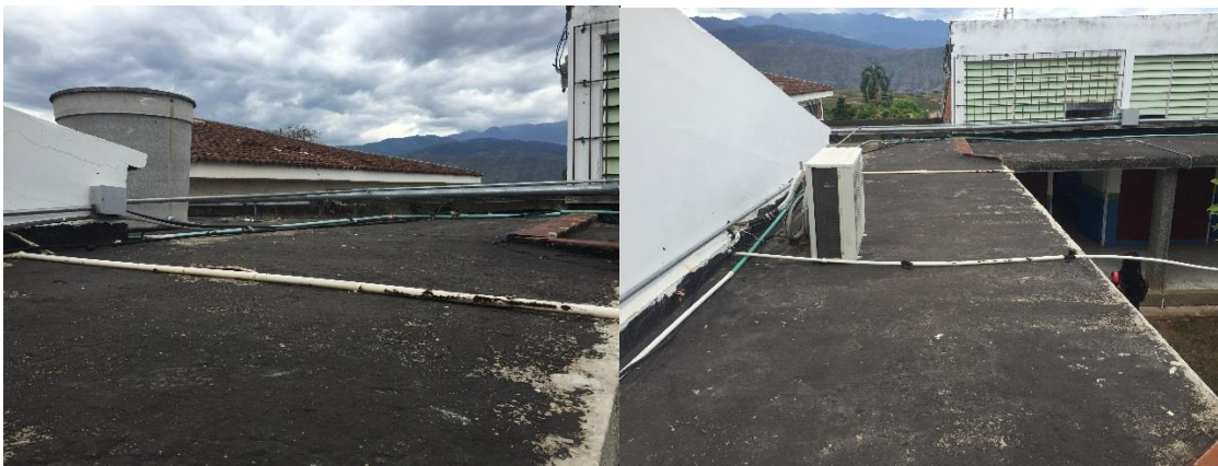
CANALIZACIÓN DE LAS REDES
