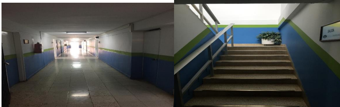
MANTENIMIENTO PREVENTIVO DE AREAS COMUNES DEL HOSPITAL COMO PISOS, PINTURA
