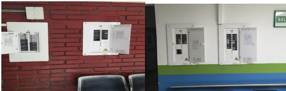
ARREGLO DEL TABLERO DE CIRCUITOS
