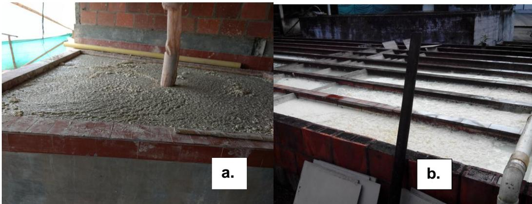
Los tanques de sedimentación de mancha tienen dimensiones aproximadas de 9 a 12m<sup>2</sup> (rallandería El Mestizal), en cambio los canales de sedimentación generalmente son de 8 a 10m de longitud, la profundidad menor a 1m y el ancho de 0,50m aproximadamente (Almidones Camavive). En términos de eficiencia de recuperación de mancha, los canales son los más recomendables por la razón ya mencionada.
