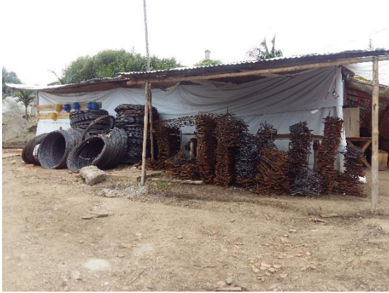
Almacenamiento de alambre y estribos.
