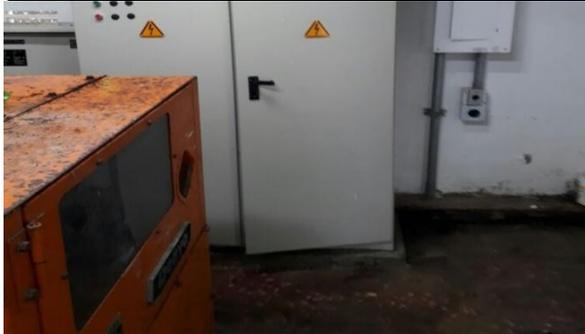
Infiltración de agua cuarto de tablero electrónico del pozo 2.
