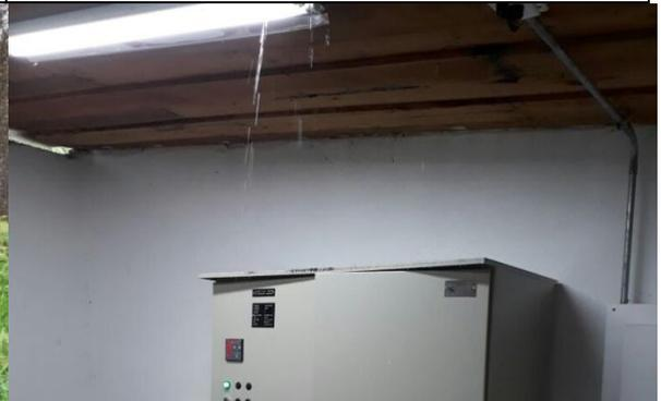
Infiltración de agua cuarto de tablero electrónico del pozo 2.
