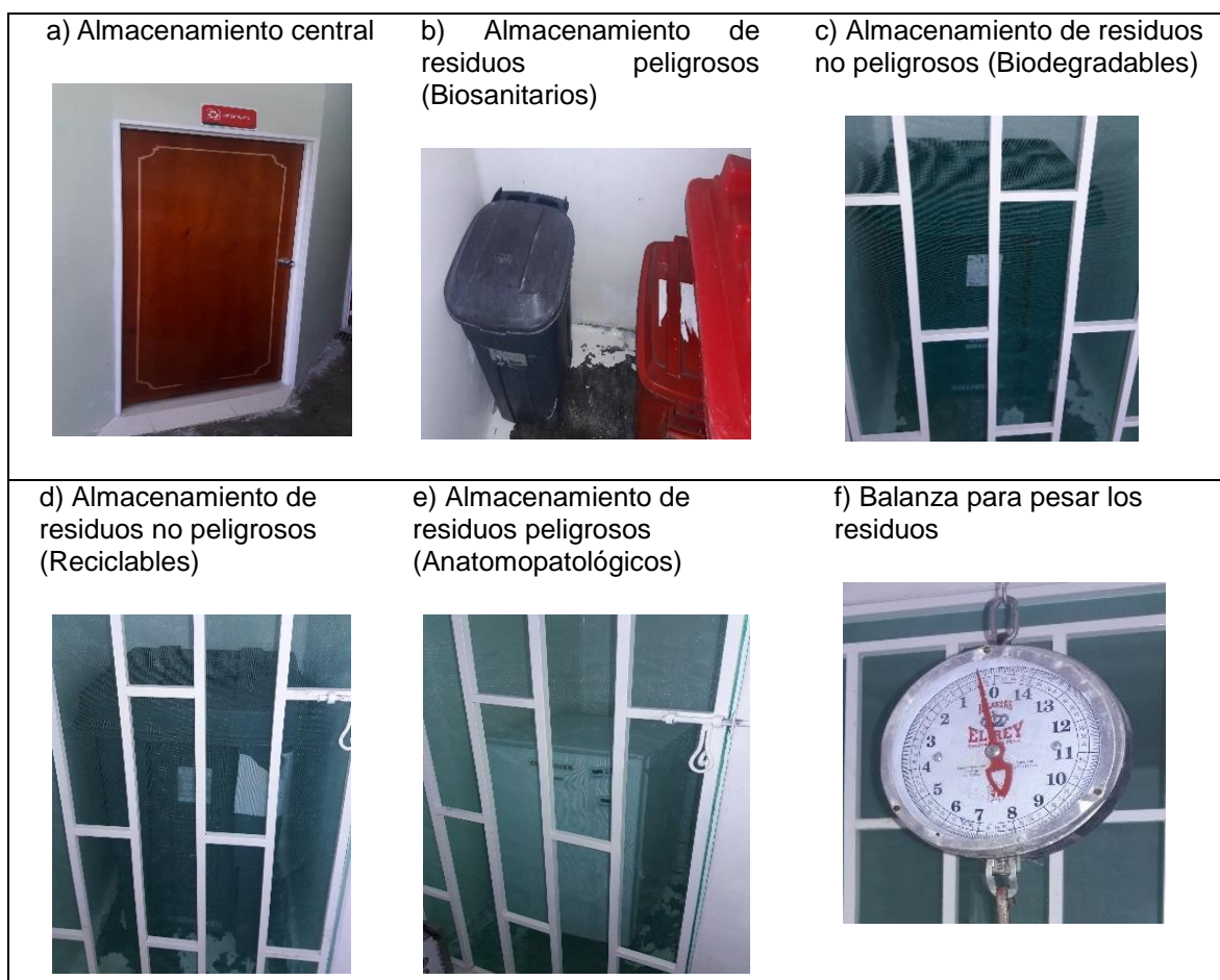
Figura 8. Almacenamiento Central, Punto de Atención Sucre. Figuras a) a f)
