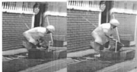
Figura 8. Personal de servicios generales realizando inadecuada utilización de recipientes.
