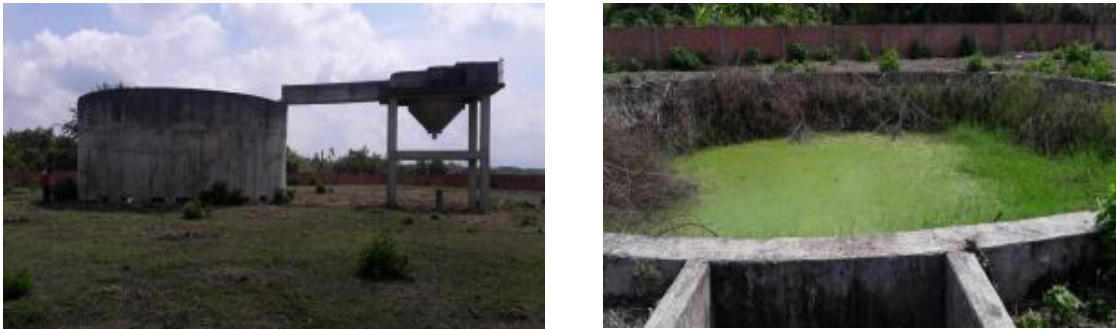
Figura 14. Instalaciones de la PTARD Sur, Municipio de Puerto Tejada
