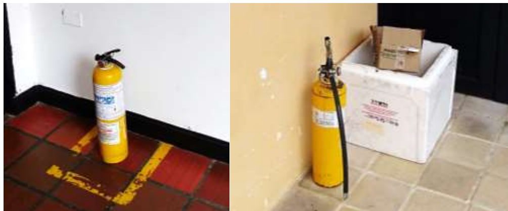
Figura 7. Extintores sin soporte a la pared o base, y sin señalética.
