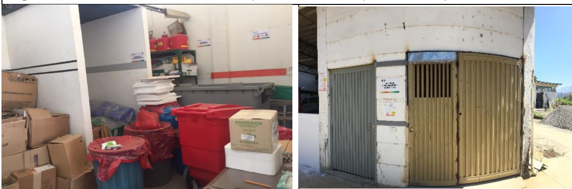
Figura c. Unidad de almacenamiento temporal de residuos aprovechables y ordinarios
