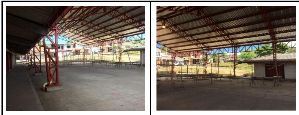
Figura 54 Cubierta Nueva en la Plaza de Mercado
