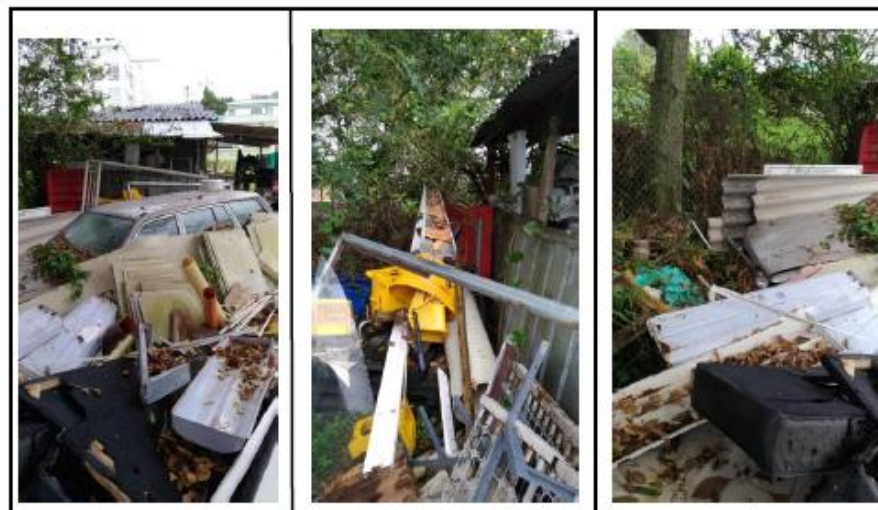
Figura 25 Residuos en la parte trasera del hospital
