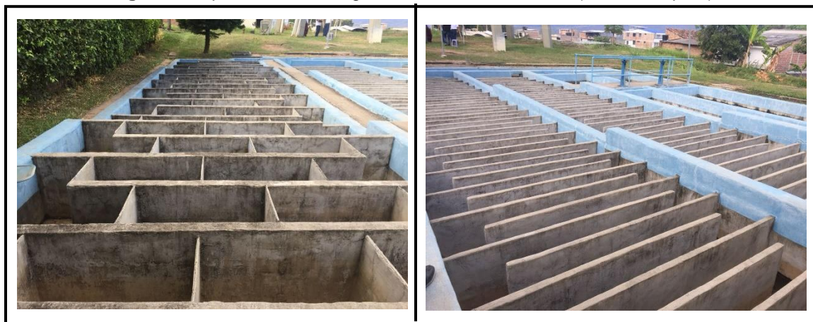
Figura 37 Floculador Horizontal y Floculador Vertical
