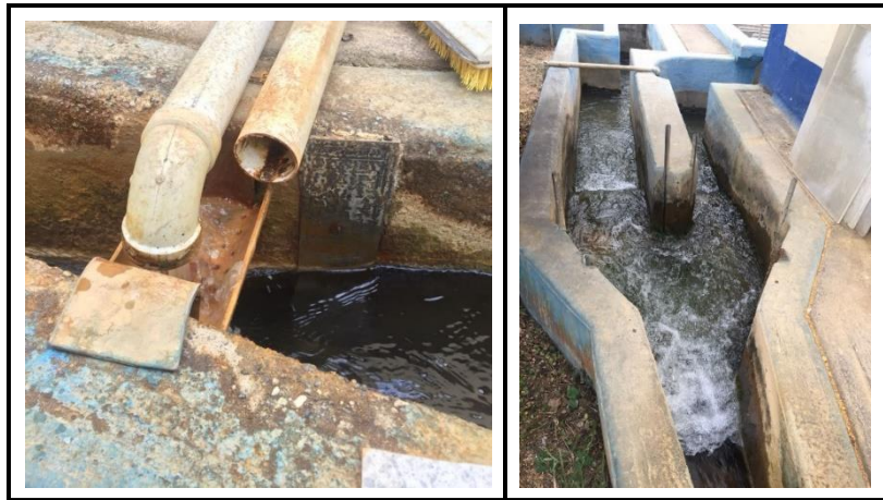
Figura 36 Aplicación del coagulante. Canaleta Parshall (Mezcla Rápida)
