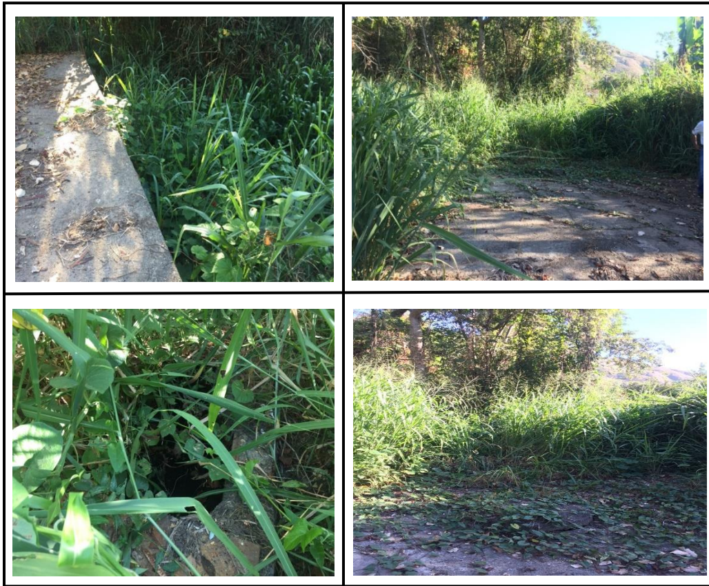
Figura 42 PTAR La Fonda
