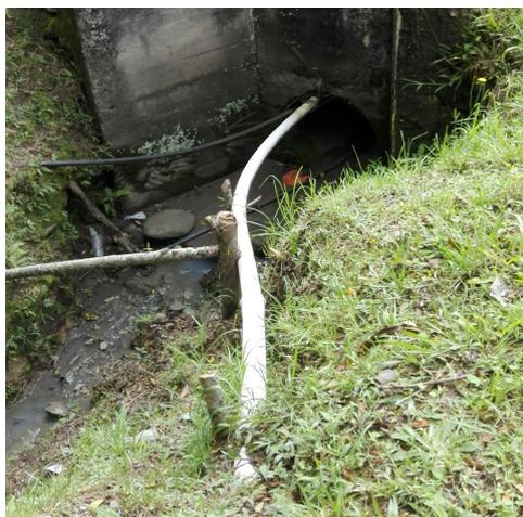
**Figura 50.** Tubería que atraviesa la alcantarilla
