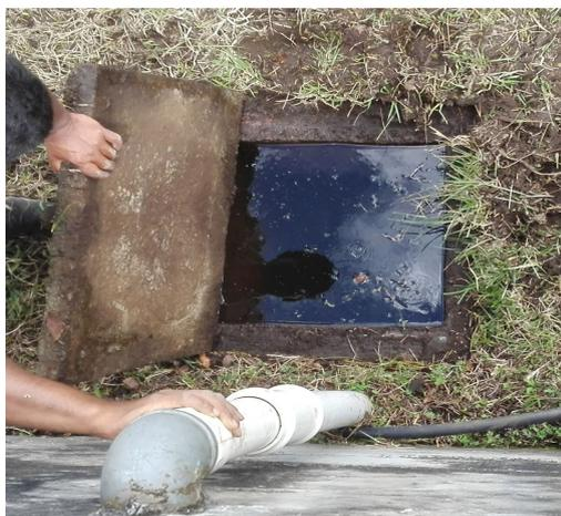
**Figura 53.** Sobrantes del tanque de almacenamiento tubería 3" PVC
