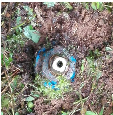
**Figura 47.** Tramo de tubería con simulación de ventosa
