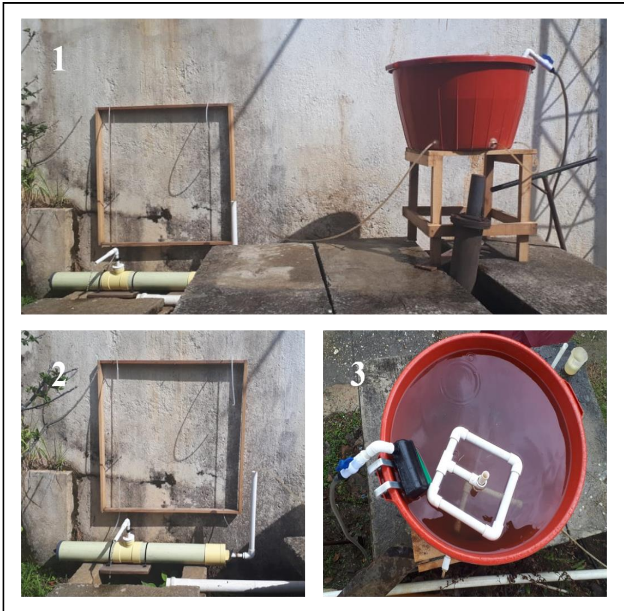
Foto 1. Planta piloto: (1) Montaje en campo, (2) Sistema de filtración y piezómetros, y (3) Tanque de almacenamiento
