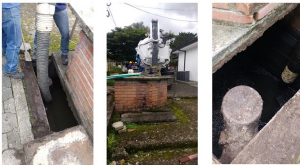
Figura 4. Intervención pozo N°2.
