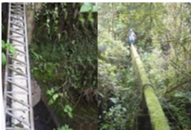
Figura 7. Viaductos en la conducción del agua.
